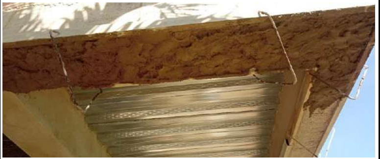
Foto No 10: Pañete liso impermeabilizado para vigas 1:4, incluye filos y dilataciones Ancho Prom (0.40m - 0.50 m)
