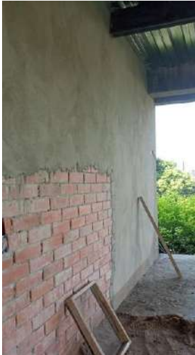
Foto No 7: Pañete liso (allanado) muros 1:3, incluye filos y dilataciones
