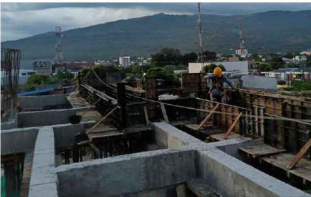
Foto No 7: Fundida de Viga Canal en Concreto De Resistencia 3500 Psi
