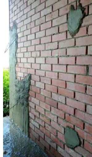
Foto No 6: Pañete liso (allanado) muros 1:3, incluye filos y dilataciones
