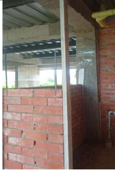
Foto No 10: Instalación de Muro estructural para fachada e interiores en ladrillo de perforación vertical (29x12x9).
