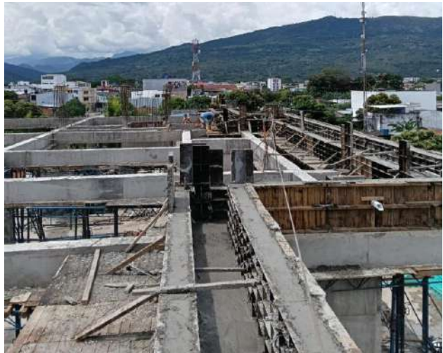
Foto No 8: Fundida de Viga Canal en Concreto De Resistencia 3500 Psi
