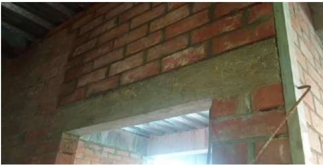
Foto No 9: Dintel en concreto de 3000 psi 15 x 10 reforzado
