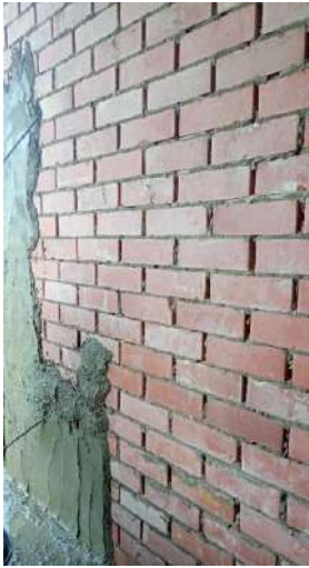
Foto No 5: Pañete liso (allanado) muros 1:3, incluye filos y dilataciones
