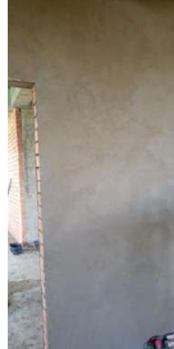
Foto No 8: Pañete liso (allanado) muros 1:3, incluye filos y dilataciones
