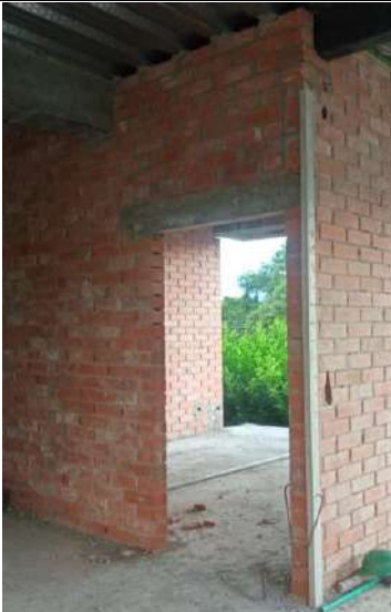
Foto No 9: Instalación de Muro estructural para fachada e interiores en ladrillo de perforación vertical (29x12x9).
