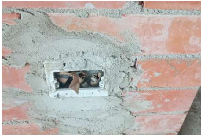
Foto No 10: Instalación de Muro estructural para fachada e interiores en ladrillo de perforación vertical (29x12x9).
