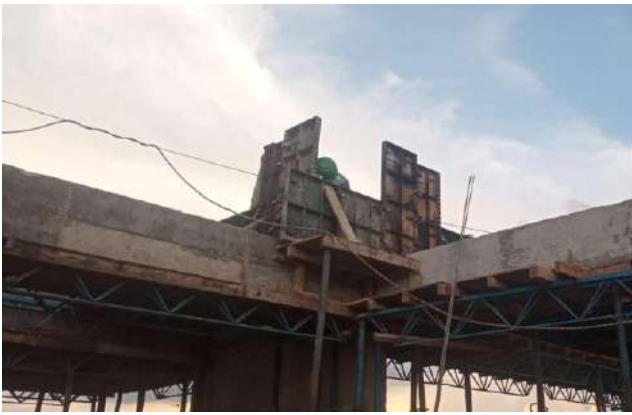
Foto No 5: Armado de formaleta para viga
