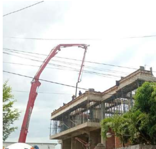
Foto No 6: Fundida de Viga Canal en Concreto De Resistencia 3500 Psi
