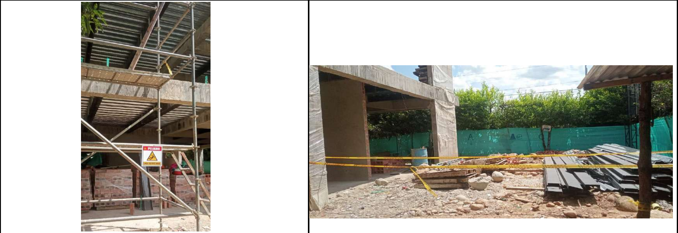
Foto No 9: Señalización de las obras Foto No 10: Señalización de las obras,
