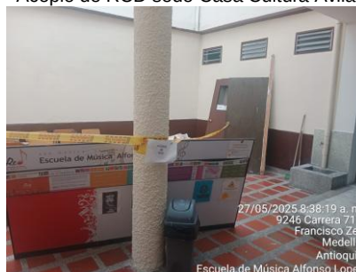
Acopio de RCD sede Escuela Alfonso López
