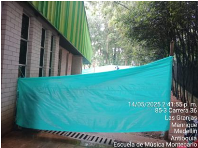
Señalización en frentes de trabajo sede Escuela de Música Montecarlo
