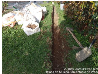
Acopio de materiales sede Escuela de Música San Antonio de Prado
