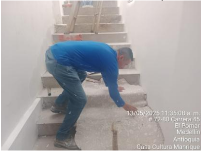
Actividades de pintura con protección del suelo (cartón) Casa Cultura Manrique
