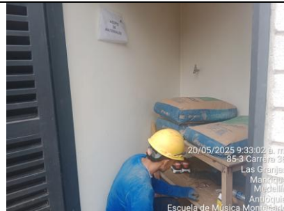
Acopio de Material sede Escuela de Música Montecarlo
