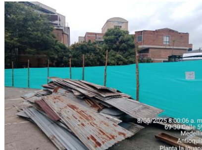
Acopio de Material sede Planta la Iguana
