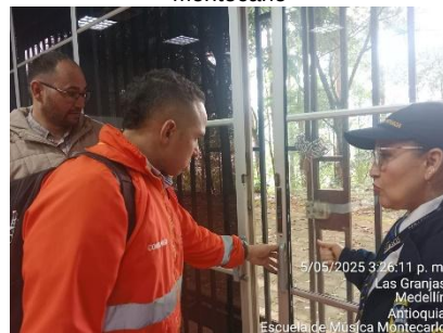
Registro fotográfico Escuela de Música Montecarlo
