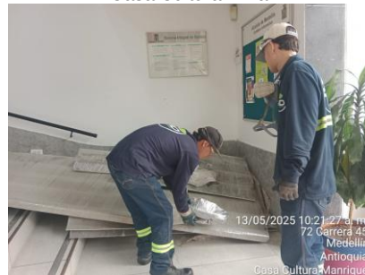
Recolección y disposición final de residuos peligrosos (teja asbesto)
