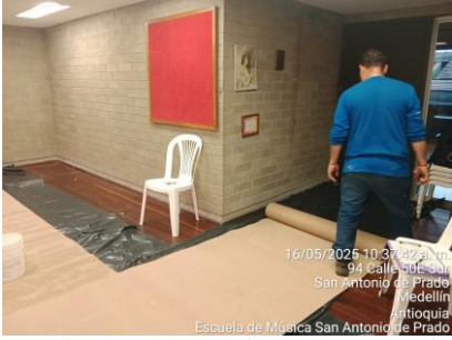
Protección del suelo (cartón) Escuela de Música San Antonio de Prado
