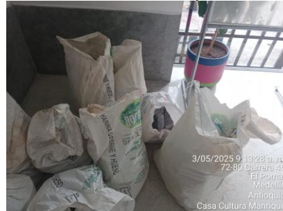
Acopio de RCD sede Casa de Cultura Manrique
