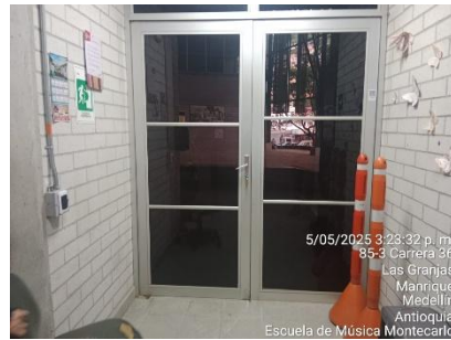
Registro fotográfico Escuela de Música Montecarlo
