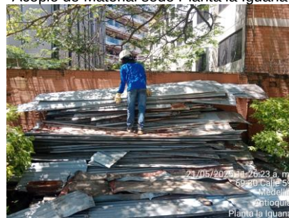
Acopio de Material sede Planta la Iguana
