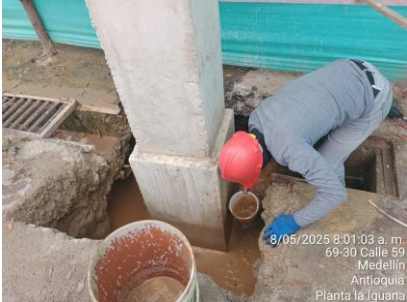
Retiro de aguas estancadas sede Planta la Iguana
