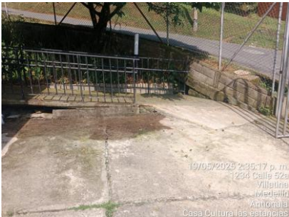
Acopio posterior a la disposición final de RCD en sede Casa Cultura Estancias
