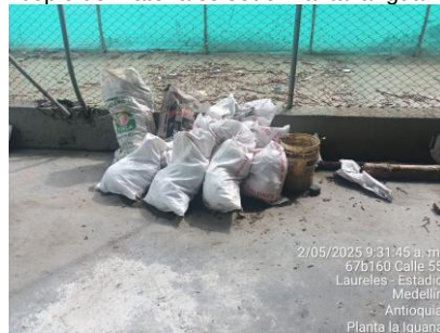
Orden en Acopio de materiales sede Planta la Iguana
