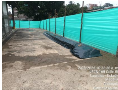
Acopio de materiales sede Planta la Iguana
