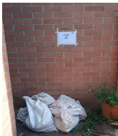
Acopio de RCD sede Casa Cultura Ávila
