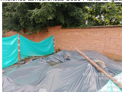
Cubrimiento de Residuos RCD para control de emisiones atmosféricas Sede Planta la Iguana
