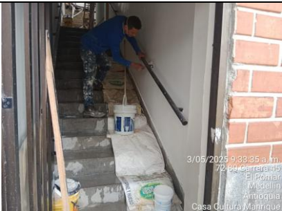
Actividades de pintura con protección del suelo sede Casa de Cultura Manrique
