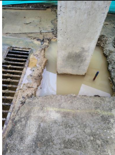
Retiro de aguas estancadas sede Planta la Iguana
