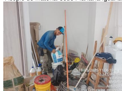
Orden en Acopio de Materiales sede Casa Cultura las Estancias
