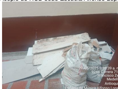
Acopio de RCD sede Escuela Alfonso López
