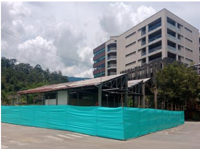
Señalización en frentes de trabajo sede Planta la Iguana
