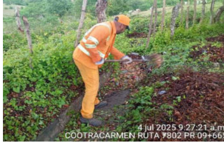
LIMPIEZA DE DESCOLE EN EL PR 09+0665
