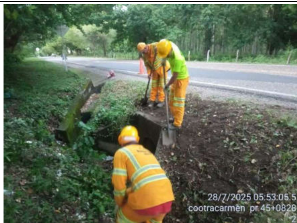
LIMPIEZA DE OBRAS DE ARTE
