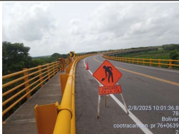
MANTENIMIENTO DE PUENTES
