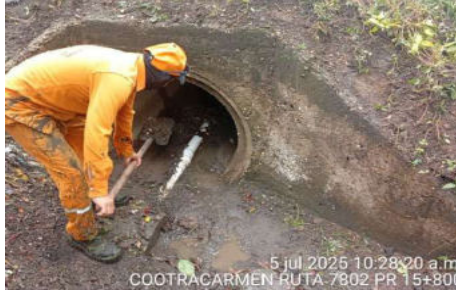
LIMPIEZA DE ALCANTARILLA EN EL PR 15+0800
