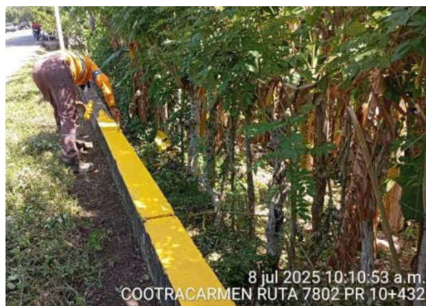
PINTURA DE CABEZOTES Y BORDILLOS
