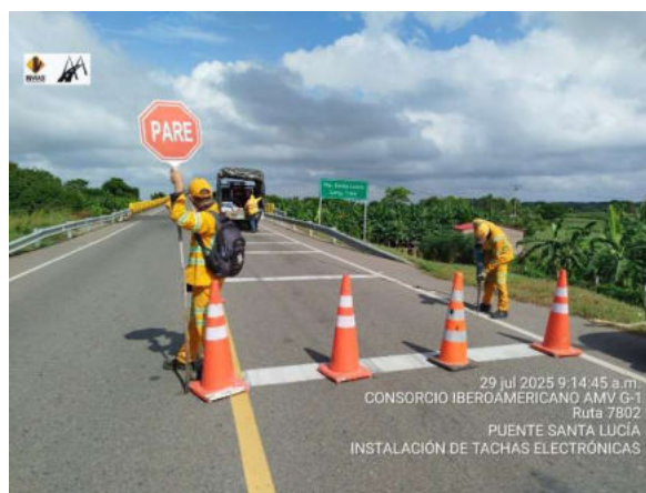
INSTALACIÓN DE TACHAS ELECTRÓICAS EN PUENTE SANTA LUCÍA
