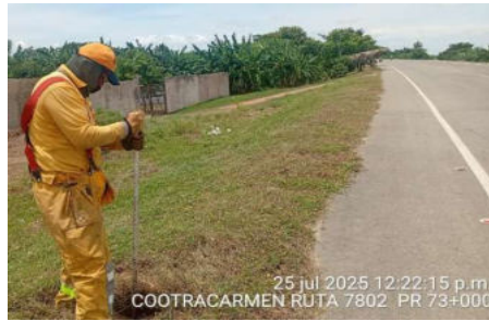
INSTALACIÓN DE SEÑALES VERTICALES SI-04 POSTES DE REFERENCIA
