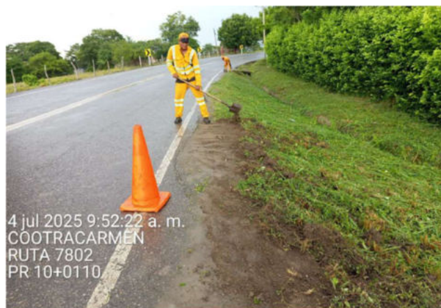
LIMPIEZA DE BERMAS
