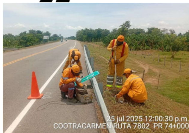
INSTALACIÓN DE SEÑALES SI-04 POSTES DE REFERENCIA
