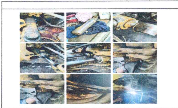
ANEXO 31. Fotografía Servicio de desmontaje y montaje de la botella
