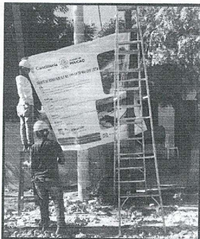
Instalacion de valla informativa
