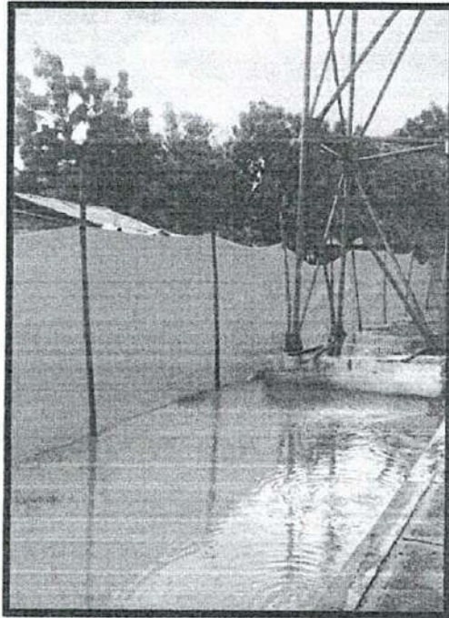
Instalacion lona verde - bionacional
