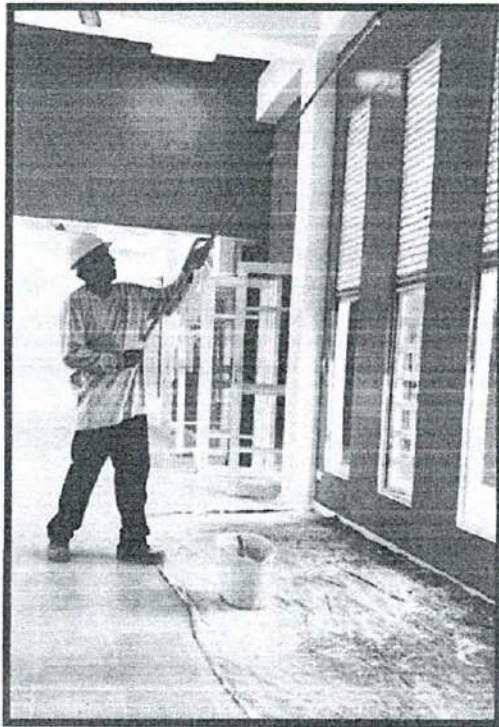
Aplicación de pintura tipo 1 sobre pared
