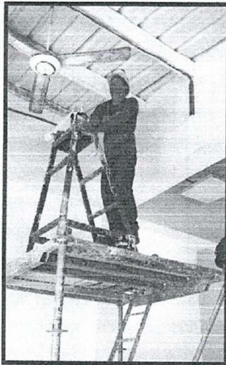
Mantenimiento estructura existente
