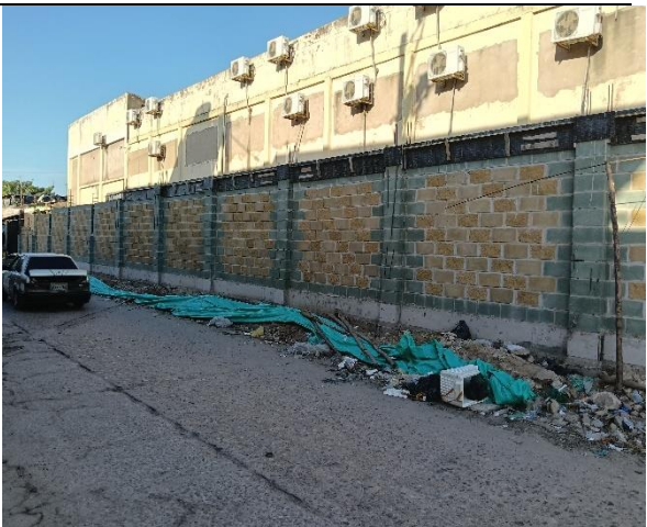
VIGA DE CORONA DE MURO
