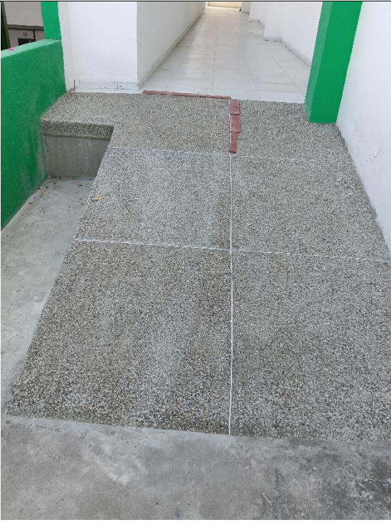
PIEDRA CHINA DE RAMPA
