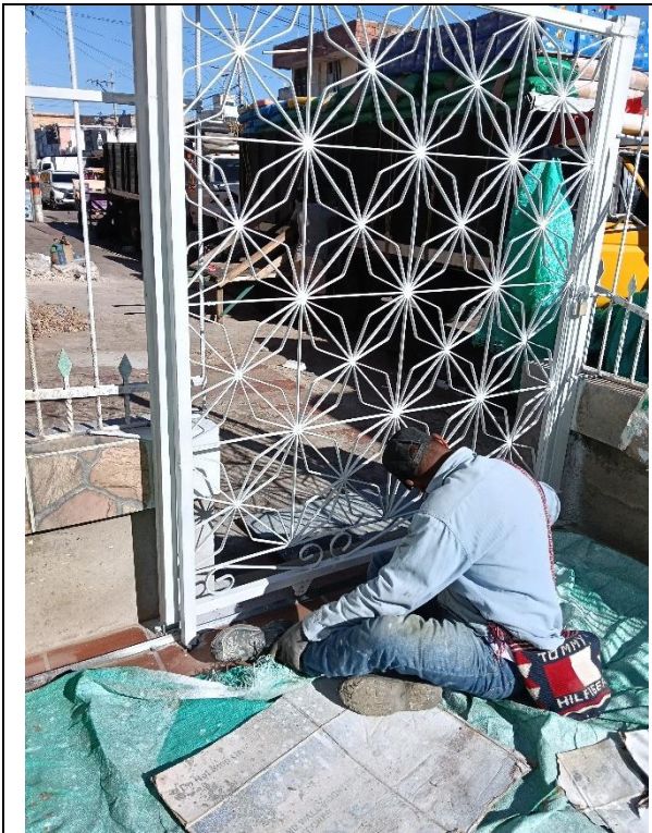
PINTURA EN ESMALTES REJA DE ACCESO
