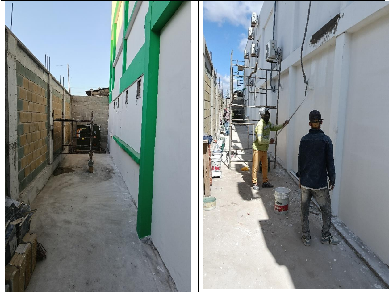
PINTURA EN KORAZA DE PINTUCO
