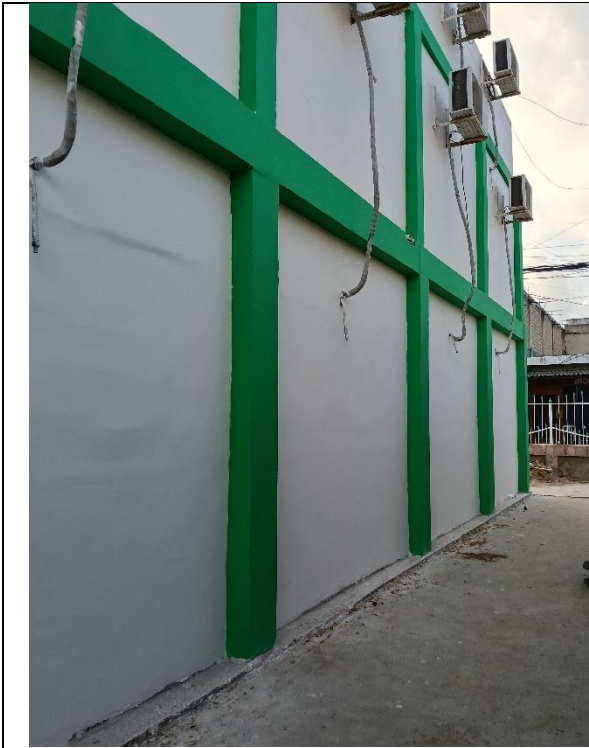
ACABADO EN PINTURA KORAZA
