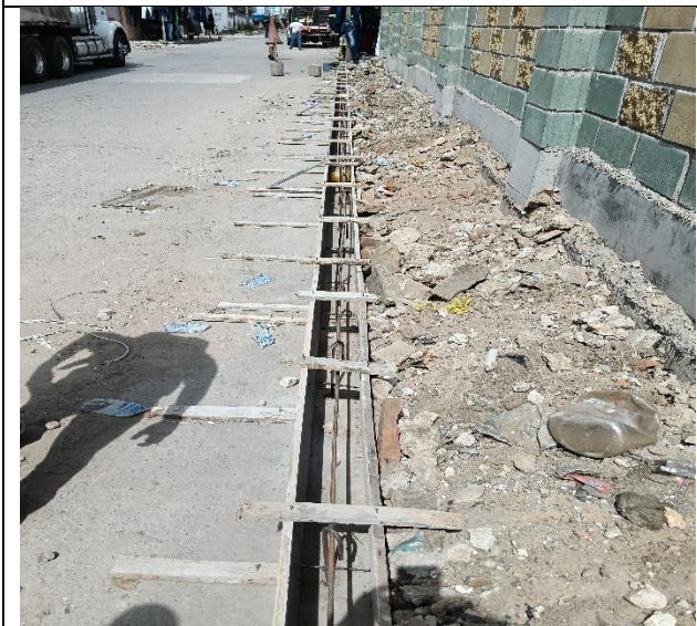
CONSTRUCCION DE BORDILLO DE 30CMS
