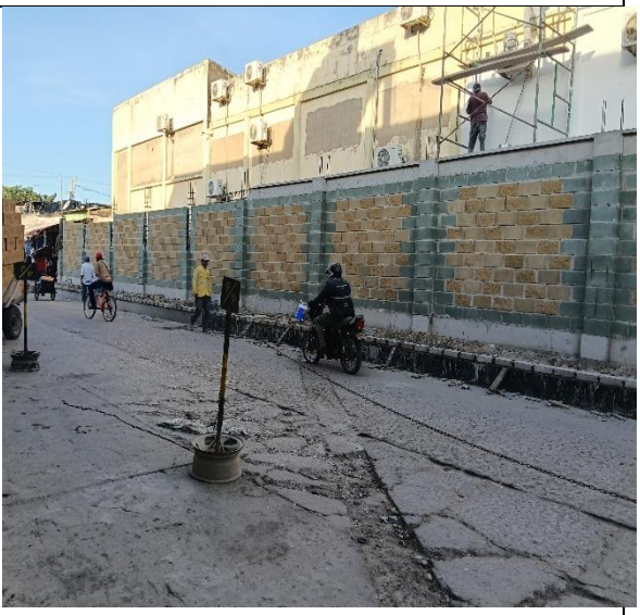
CONSTRUCCION DE BORDILLO DE 30CMS
