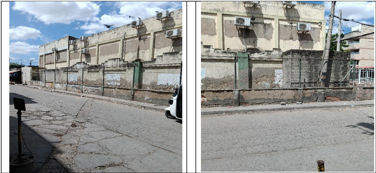
MURO ACTUAL CARRERA 16
