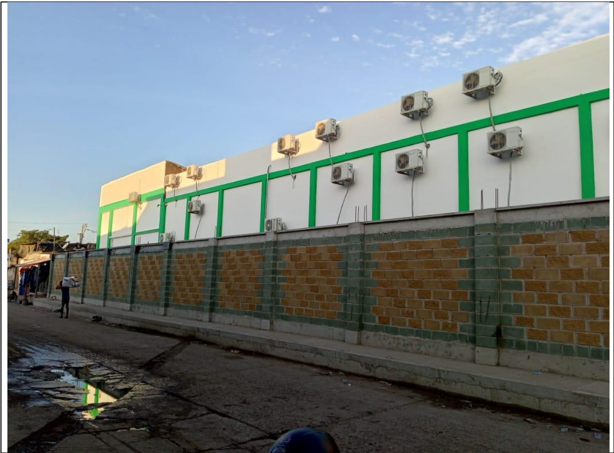
MURO TERMINADO REGISTRO
