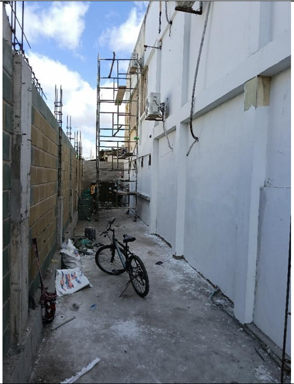
ESTUCO PLASTICO EN MUROS
