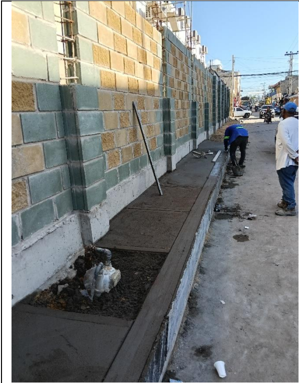
CONSTRUCCION DE ANDEN
