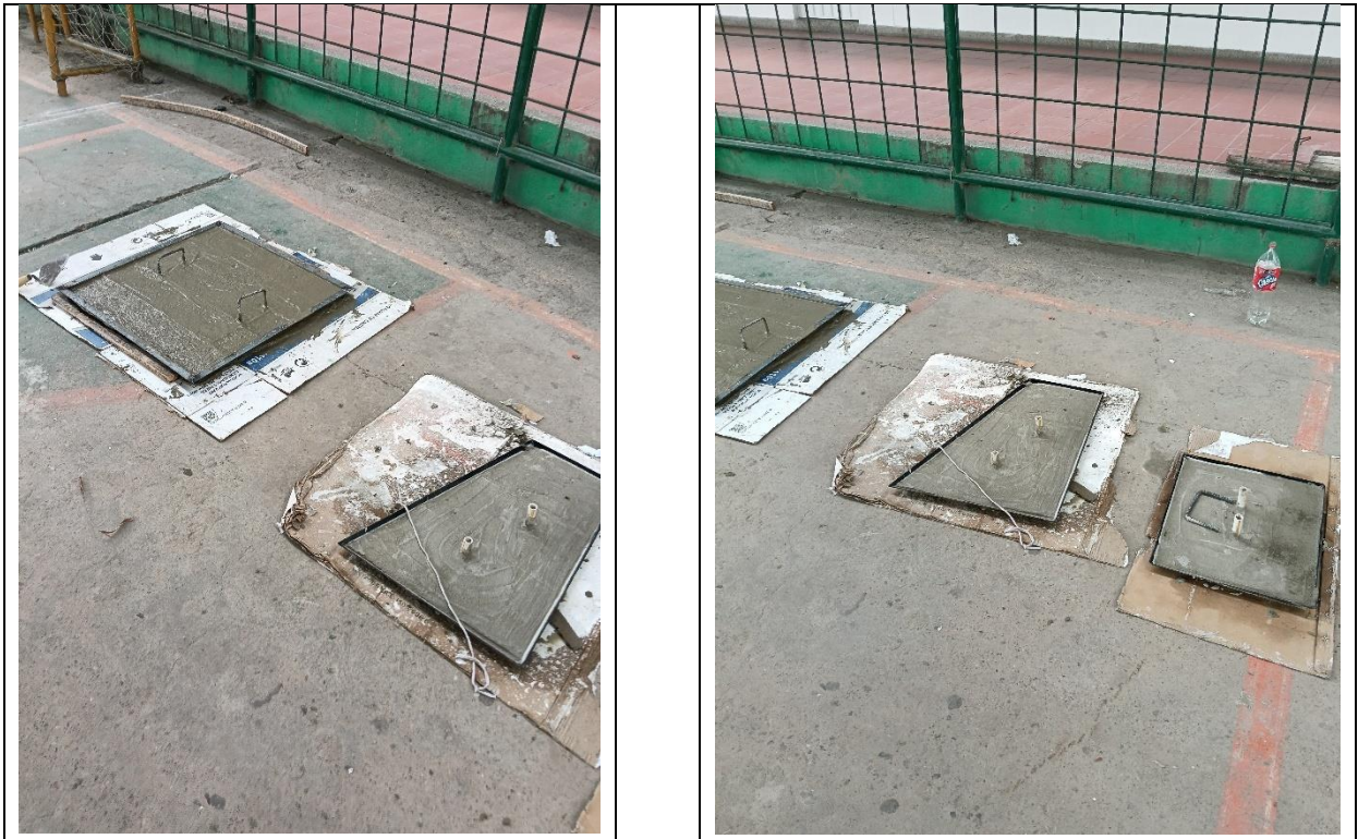
TAPAS REGISTRO EN MARCO DE METAL Y FUNDIDAS EN CONCRETO
