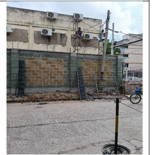
RELLENO DE ANDEN
