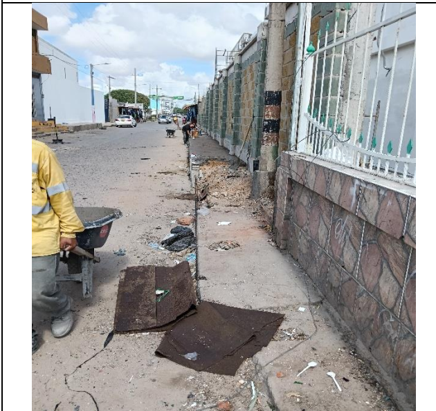
CONSTRUCCION DE ANDEN
