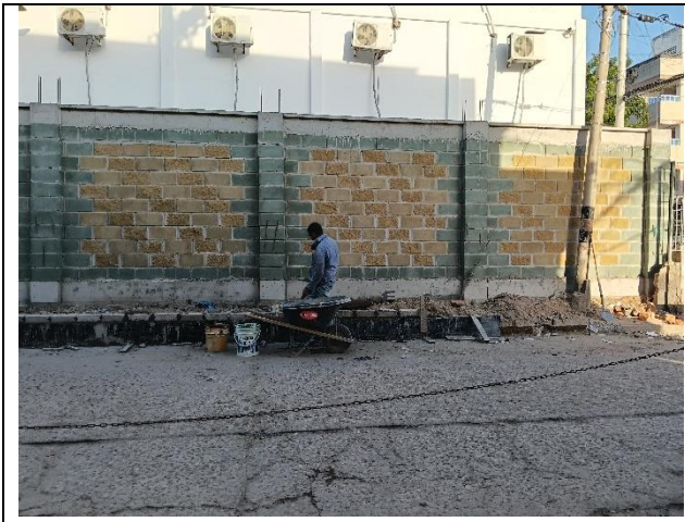
CONSTRUCCION DE BORDILLO DE 30CMS
