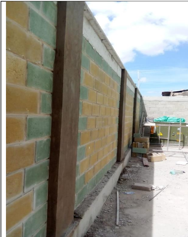
LEVANTE DE MURO ABUJARDADO
