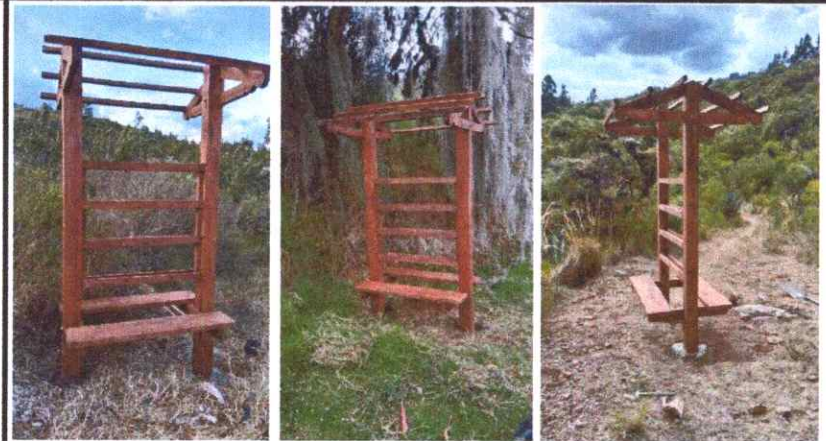
ITEM 17 :Señalización turística informativa en madera dos cercos de tres 3.0 m de altura x 0.10 m x 0.10 dos triángulos laterales de madera y Unidos en la parte superior caballete con seis
