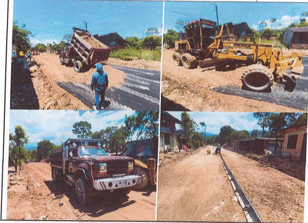
SUMINISTRO, EXTENDIDA Y COMPACTACIÓN DE BASE GRANULAR CLASE B
