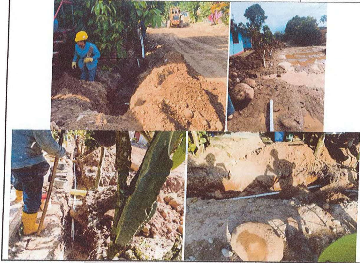
SUMINISTRO E INSTALACIÓN TUBERÍA PVC PRESIÓN D = 2" RDE 21 T.P
