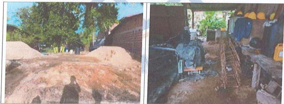
Ilustración 10. Acopio de material y bodega de obra
