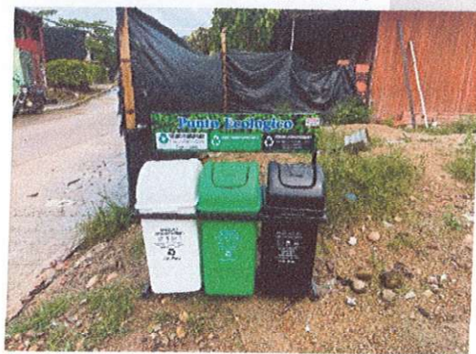
Ilustración 14 Punto de acopio de residuos de la obra
