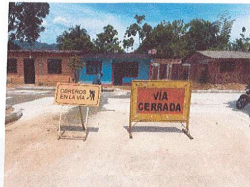
Ilustración 17. Señalizaciones en obra (vía cerrada)
