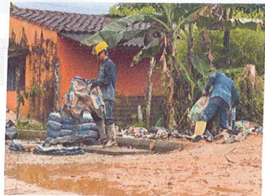
Ilustración 13 limpieza del área de trabajo
