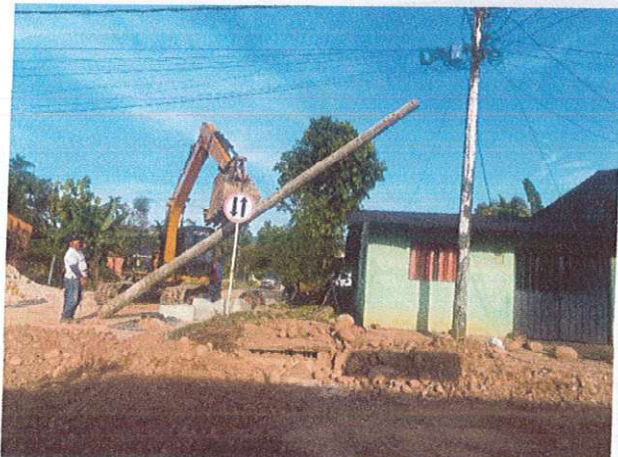
Ilustración 25. Instalación de poste nuevo
