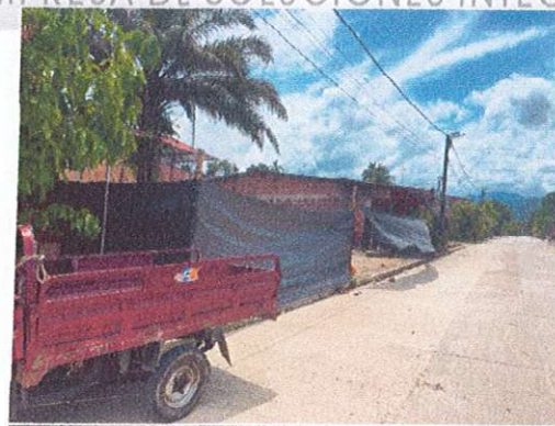
Ilustración 15 campamento de obra
