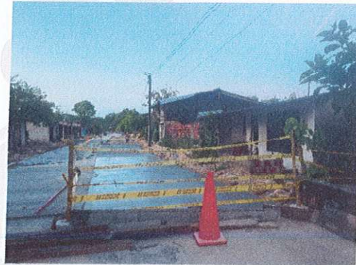
Ilustración 20. Registro fotográfico de delineadores tubulares y cinta reflectiva en obra
