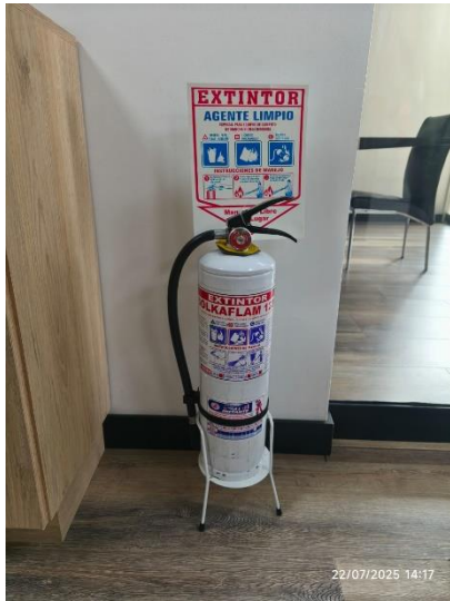
Foto N° 5 – Inspección señalización y extintores
