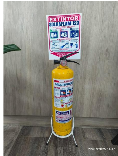
Foto N° 6 – Inspección señalización y extintores
