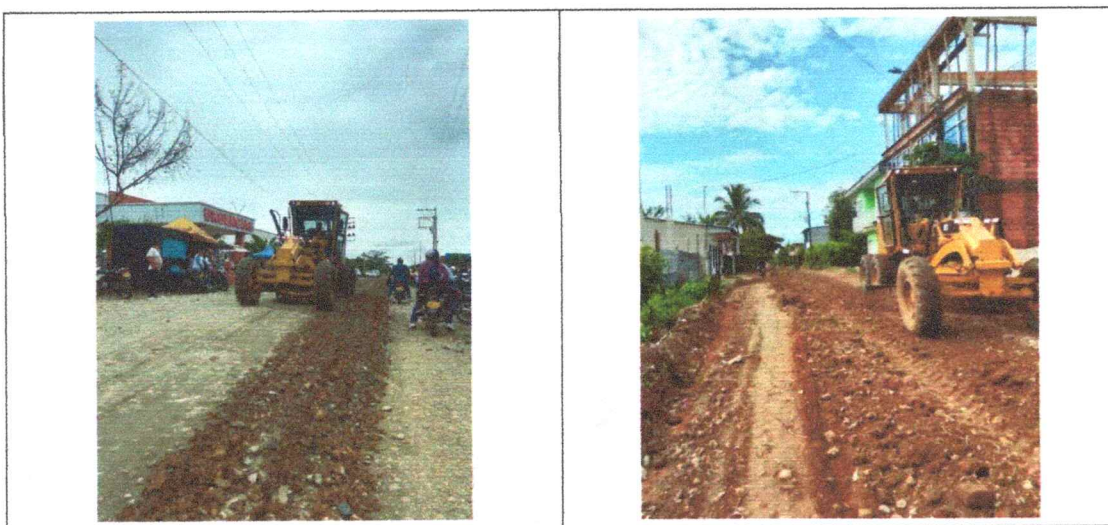
Imagen 1. Registro fotográfico de actividades ejecutadas con motoniveladora
