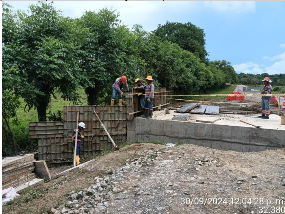
box culvert PR 35+015, construcción de aletas y muro guardarruedas, lado derecho
