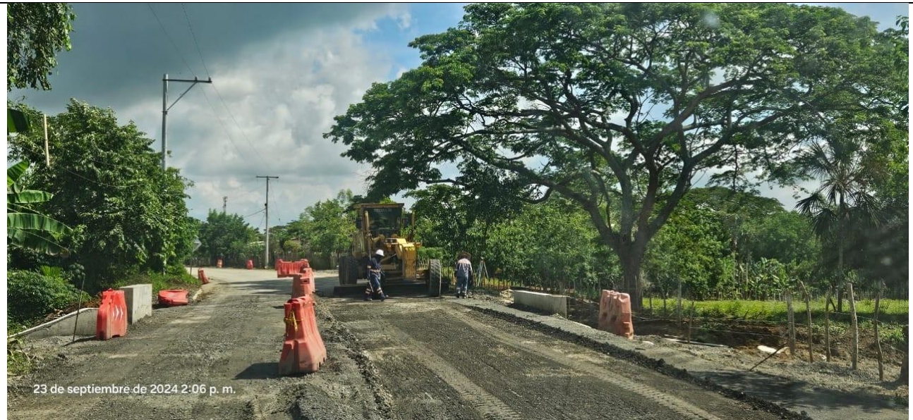
PR23+900 cereo de subbase granular calzada
