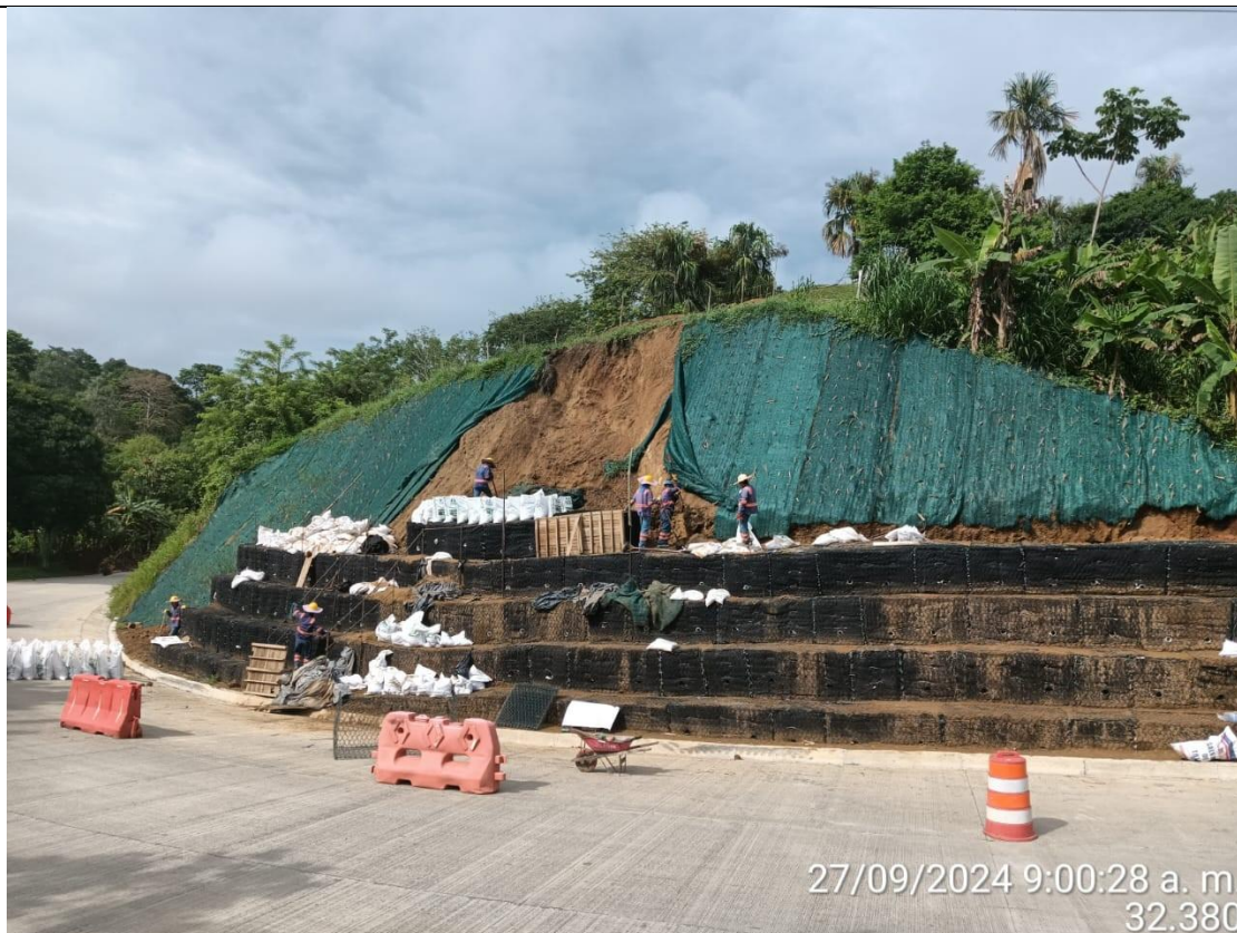
PR 14+400 construcción de gaviones lado izquierdo
