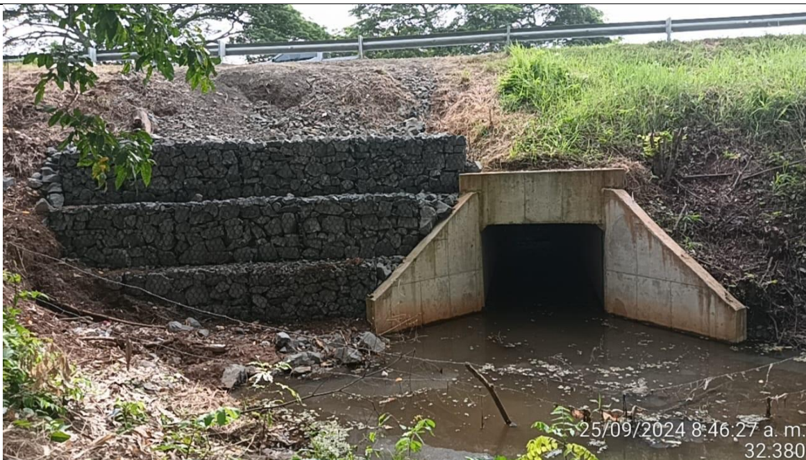
PR2+300 construcción de gaviones lado izquierdo
