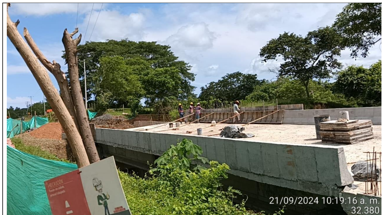
Puente PR 45+300. Construcción de New Jersey
