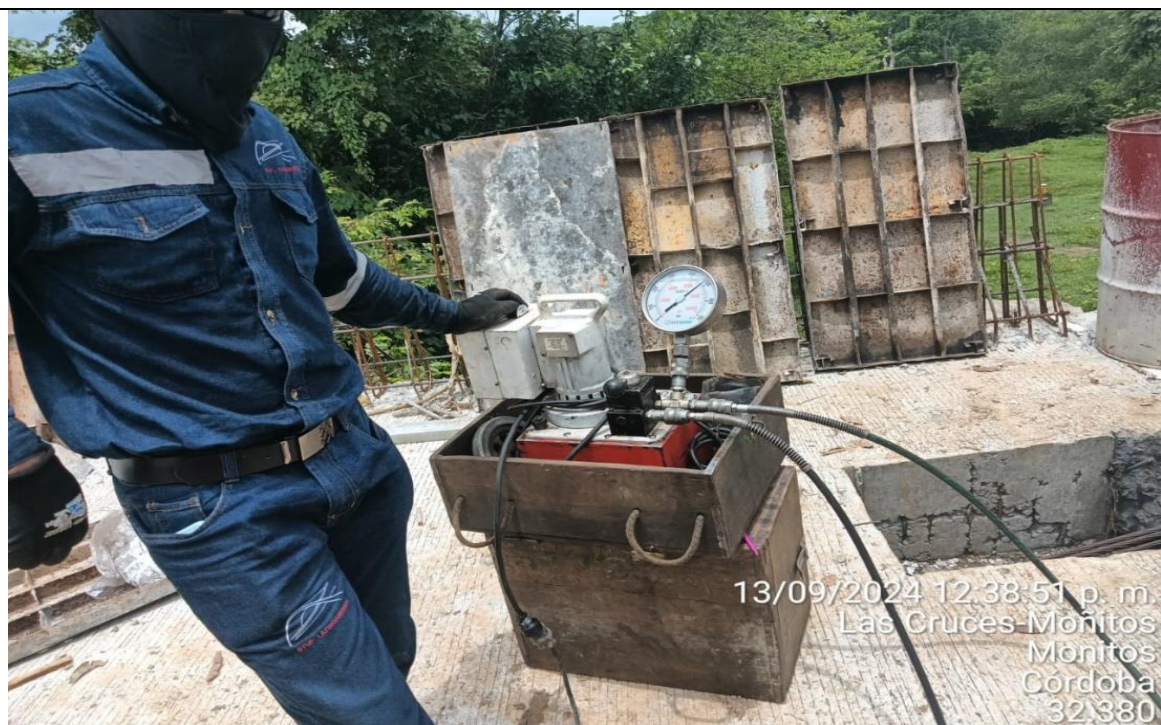
Puente PR45+300 tensionamiento de vigas
