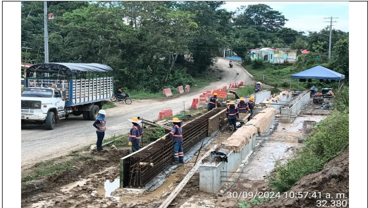
Puente PR45+700 construcción de vigas
