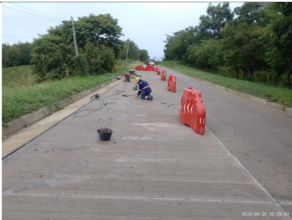
Reparaciones paliativas en losas agrietadas pavimento MR40 – costura cruzada
