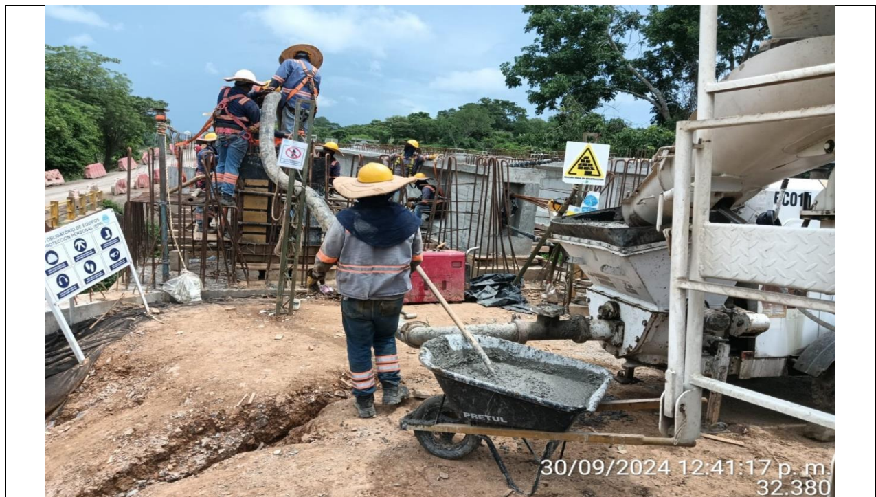
Puente PR34+500 construcción de vigas
