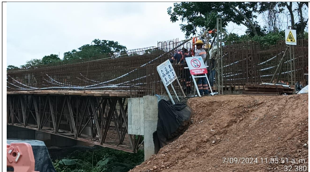
Puente PR34+500 instalación de ductos en vigas
