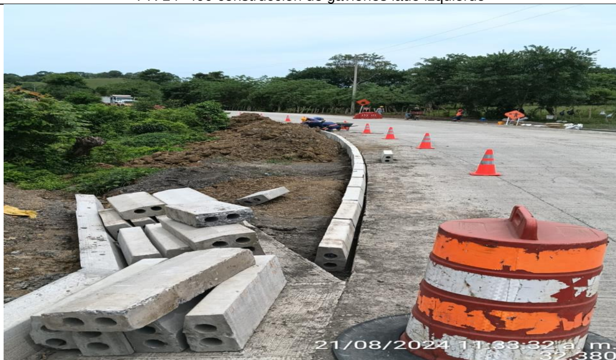
PR 30+110 Lado izquierdo. Instalación de bordillos prefabricados.
