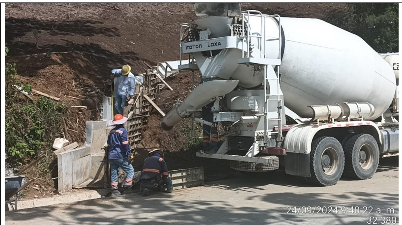
PR12+430 construcción de dissipador lado izquierdo
