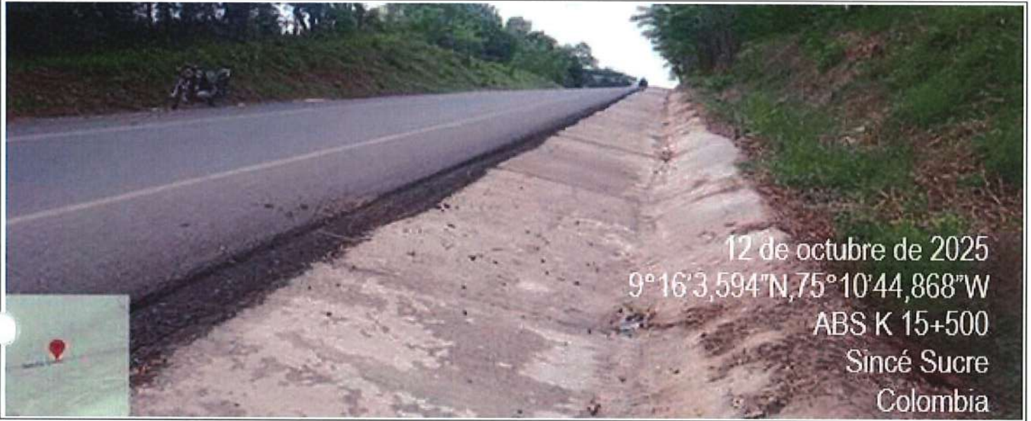
Limpieza de cunetas de arte en tramo 3: Sincé - Betulia - Corozal entre el PR14
