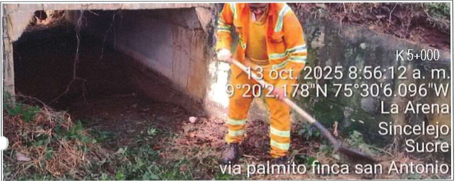
Limpieza de obras de arte y cunetas en tramo 5: San Antonio de Palmito-Finca San Antonio
