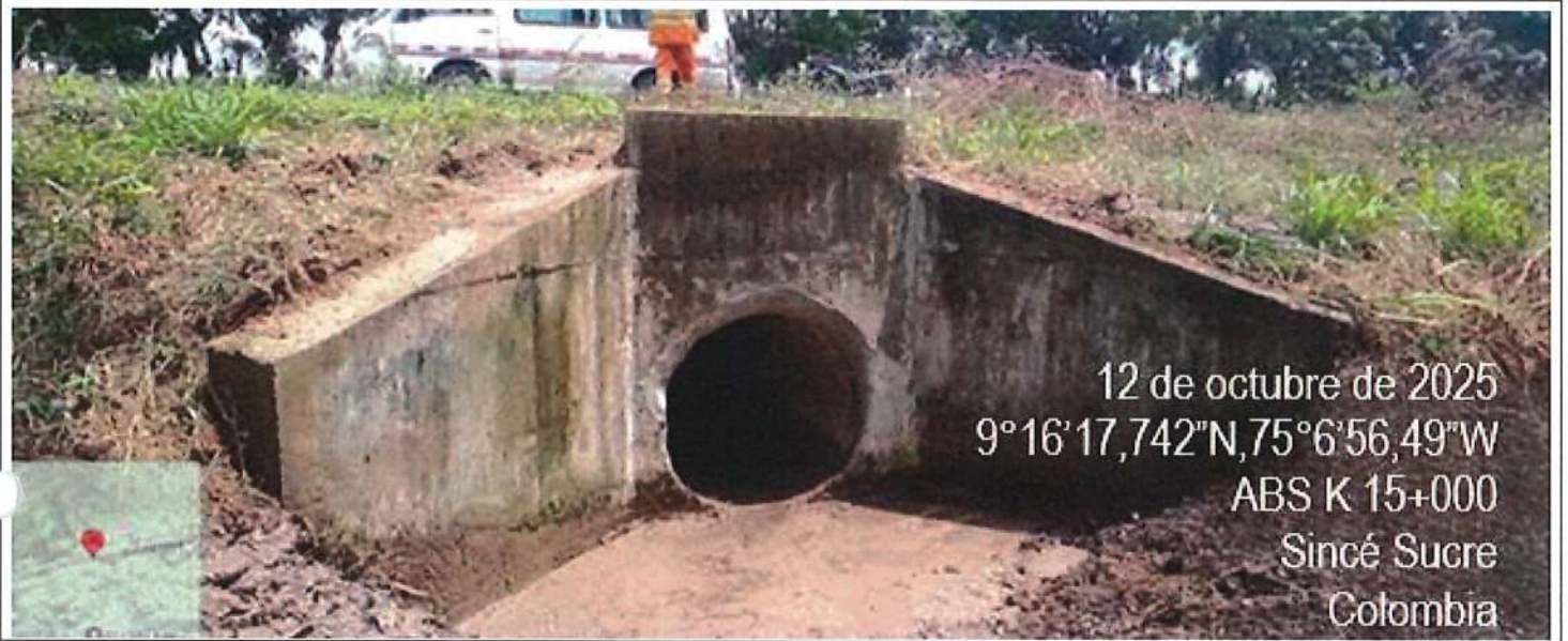
Limpieza de obras de arte en tramo 3: Sincé - Betulia - Corozal entre el PR15
