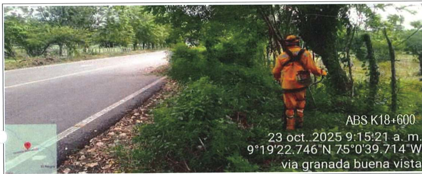
Trabajos de rocería en tramo 8: Sincé-Granada-Buenvista entre el PR18
