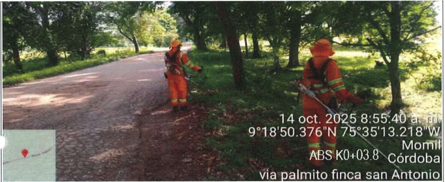
Trabajos de roceria en tramo 5: San Antonio de Palmito-Finca San Antonio PR 03 a PR04
