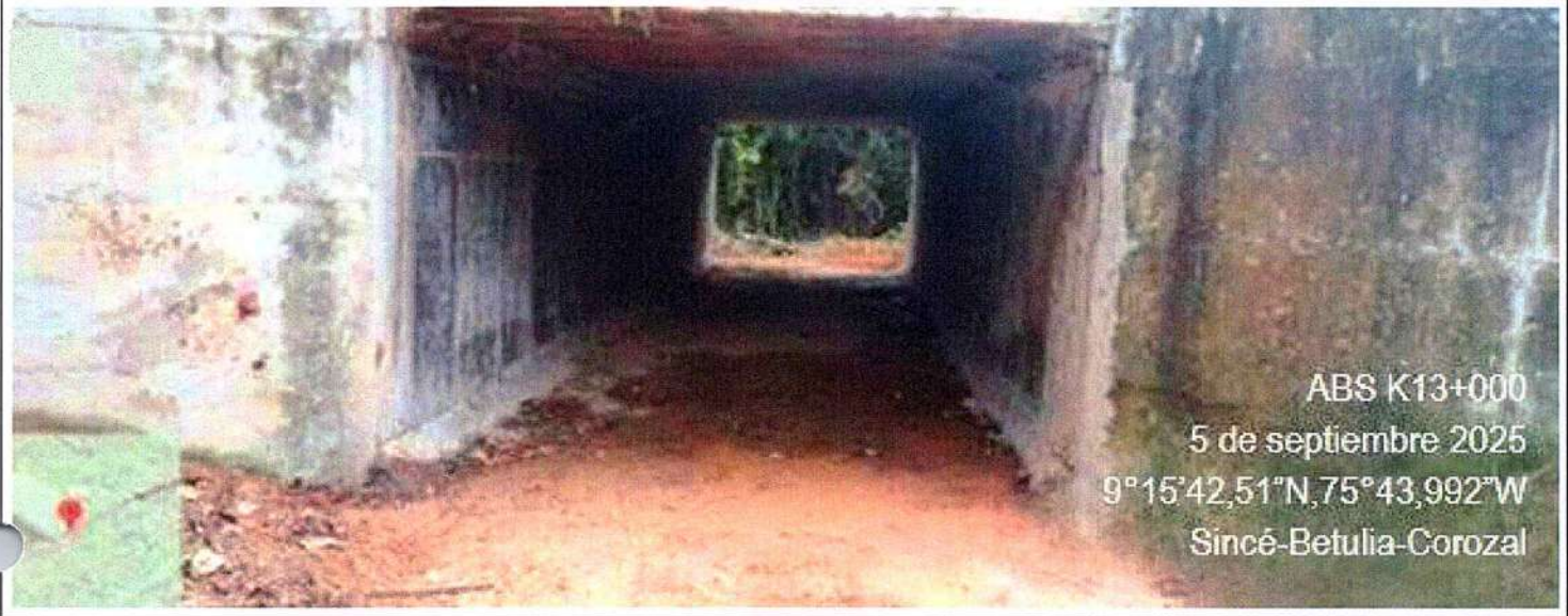
Limpieza de obras de arte en tramo 3: Sincé - Betulia - Corozal entre el PR13 al PR00
