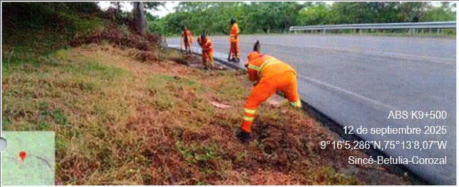
Limpieza de cunetas de arte en tramo 3: Sincé - Betulia - Corozal entre el PR10 al PR00
