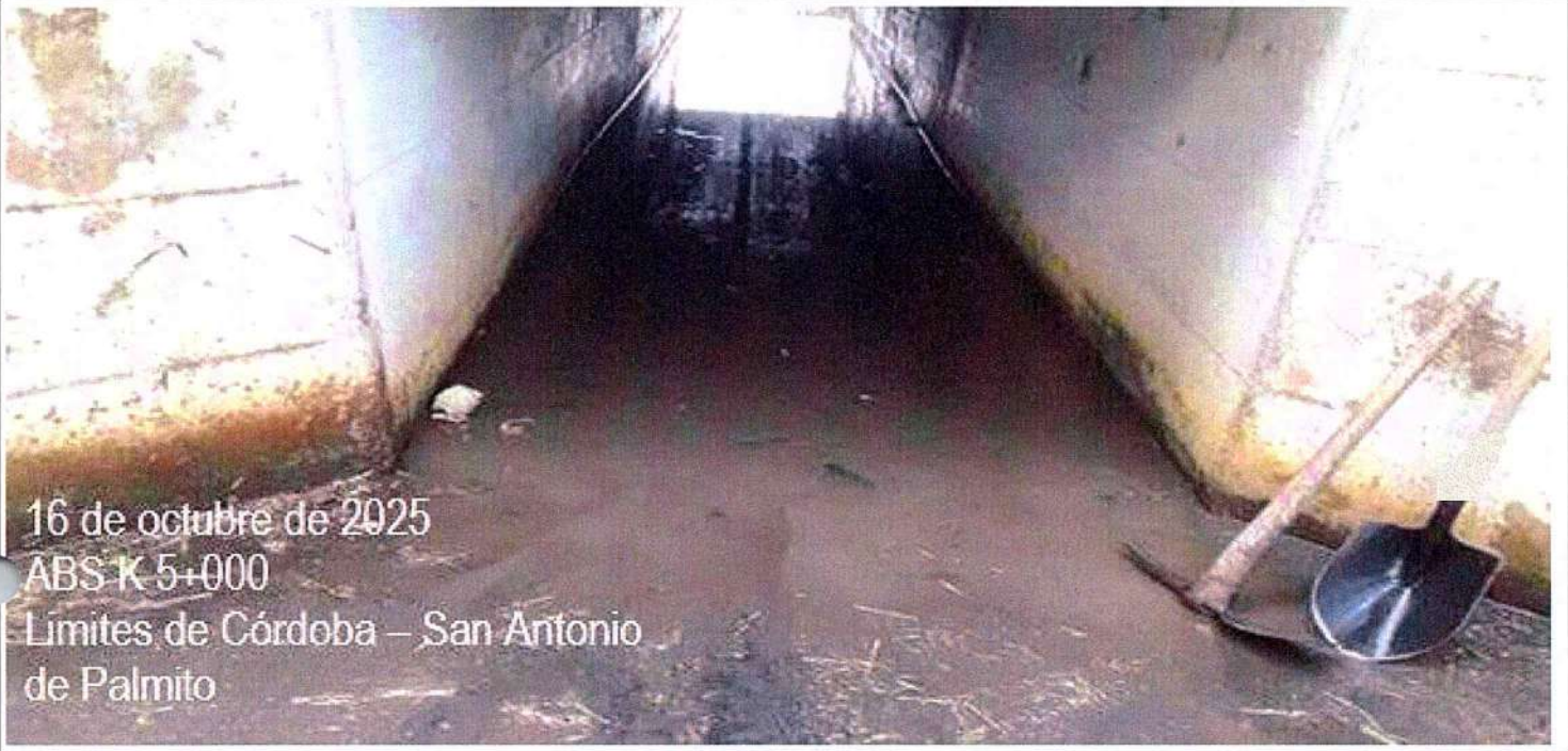
Limpeza de obras de arte en tramo 4: San Antonio de Palmito - Limites de cordoba PR00 al PR05
