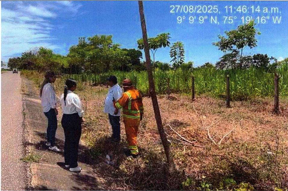
Figure 3. Recorrido de obra por parte de equipo de interventoría
