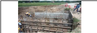
box culvert del PR 28+650 instalación formaletas para fundida de muro sur lado izquierdo
