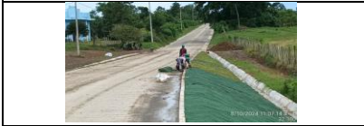
PR 28+550 lado derecho instalación de geomanto.
