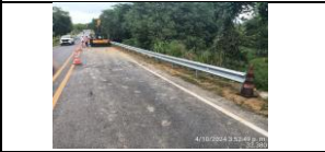
instalación defensas en el PR2+950 margen derecha
