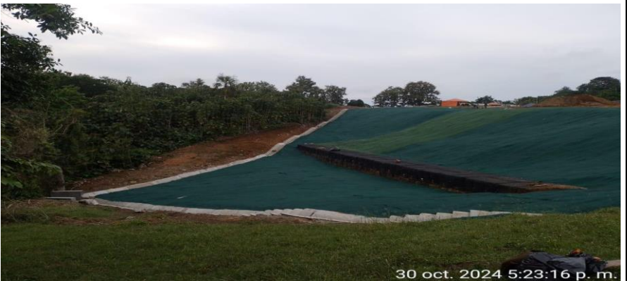
Instalación de manto TRM500 en el PR13+500 (Zodme) margen derecha.
