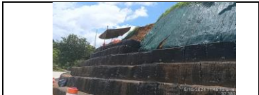
construcción de gaviones en el PR 14+400 margen izquierda
