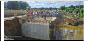
box culvert PR 28+500 instalación de acero de Losa superior del lado izquierdo.
