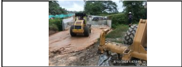
llenos por capas con material de terraplén en estribo 1 del puente del PR 45+300
