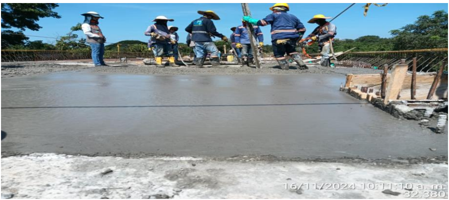
Fundida tablero del Puente Regino PR34+500.
