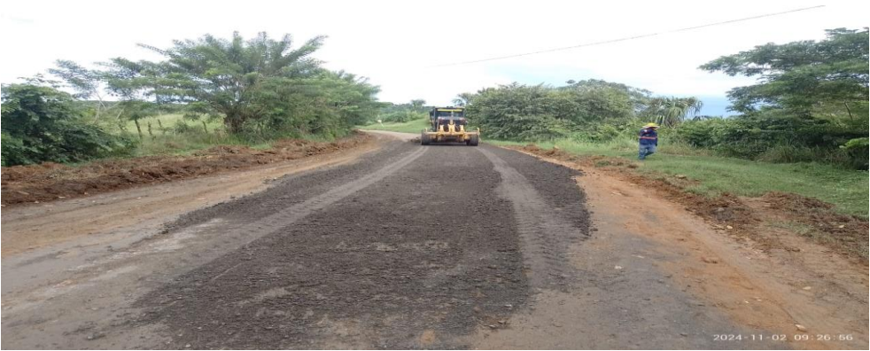
Mantenimiento de vía existente entre el PR39+700 y el PR39+850.
