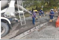
Instalacion de MR40 del PR 26+590 al 26+621.8, carril derecho.
