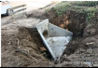
instalación cabezales prefabricados alcantarilla PR41+950
