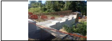
Estribo 1 puente PR 45+700
