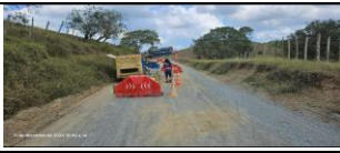
Instalación de drenes horizontales del Pr 31+580 margen izquierda.
