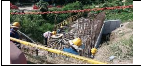
Puente del PR45+700 instalación acero de refuerzo de viga cabezal de estribo 2
