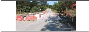
construcción de pavimento - broche PR26+590 al PR26+620 carril izquierdo
