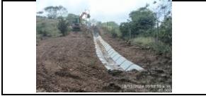
PR 45+150 margen derecha zanjas de coronación.
