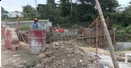
puente del PR 45+700 acero de refuerzo para fundida de pantalla de estribo 2
