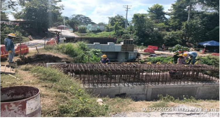
Instalación de acero de refuerzo en viga cabezal del estribo 2, puente PR45+700.
