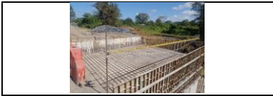
Box PR 28+192 armado de formaletas y acero de refuerzo losa superior
