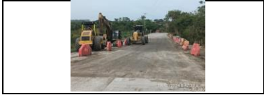
Paso vehicular habilitado carril derecho en el PR 30+220
