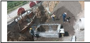
Instalación acero de refuerzo caja intermedia alcantarilla PR 30+200
