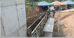
puente PR 34+500 instalacion de formaletas para construccion de muro de acompañamiento estribo 2
