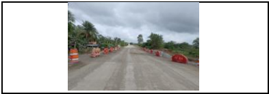
Paso vehicular habilitado sobre ODT PR 28+190
