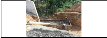
puente Regino PR34+500 fundida de viga cabezal del muro de acompañamiento en el muro 2 margen izquierda
