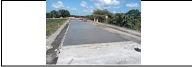
MR 40 del PR 34+485 carril izquierdo aproches puente Regino
