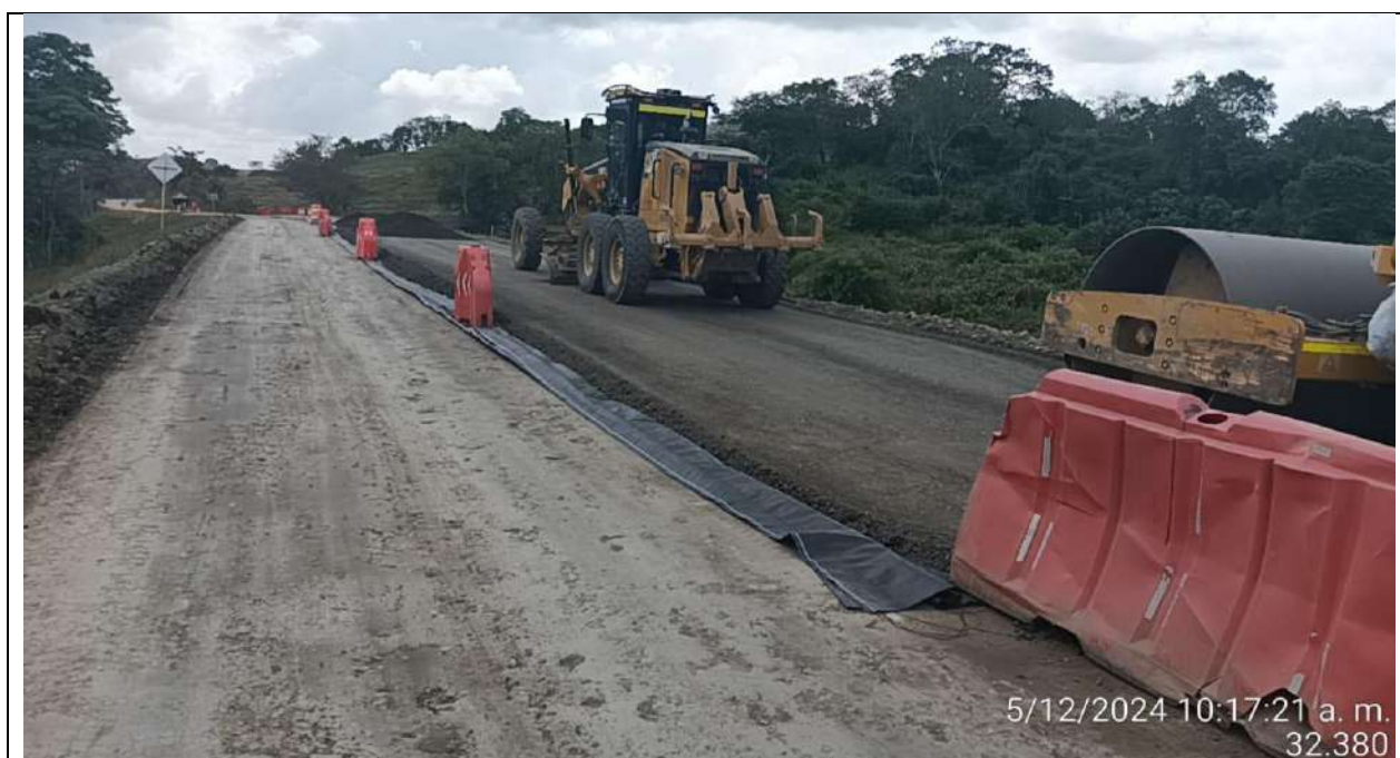
Instalación de subbase granular del PR34+380 a mayores carril izquierdo.
