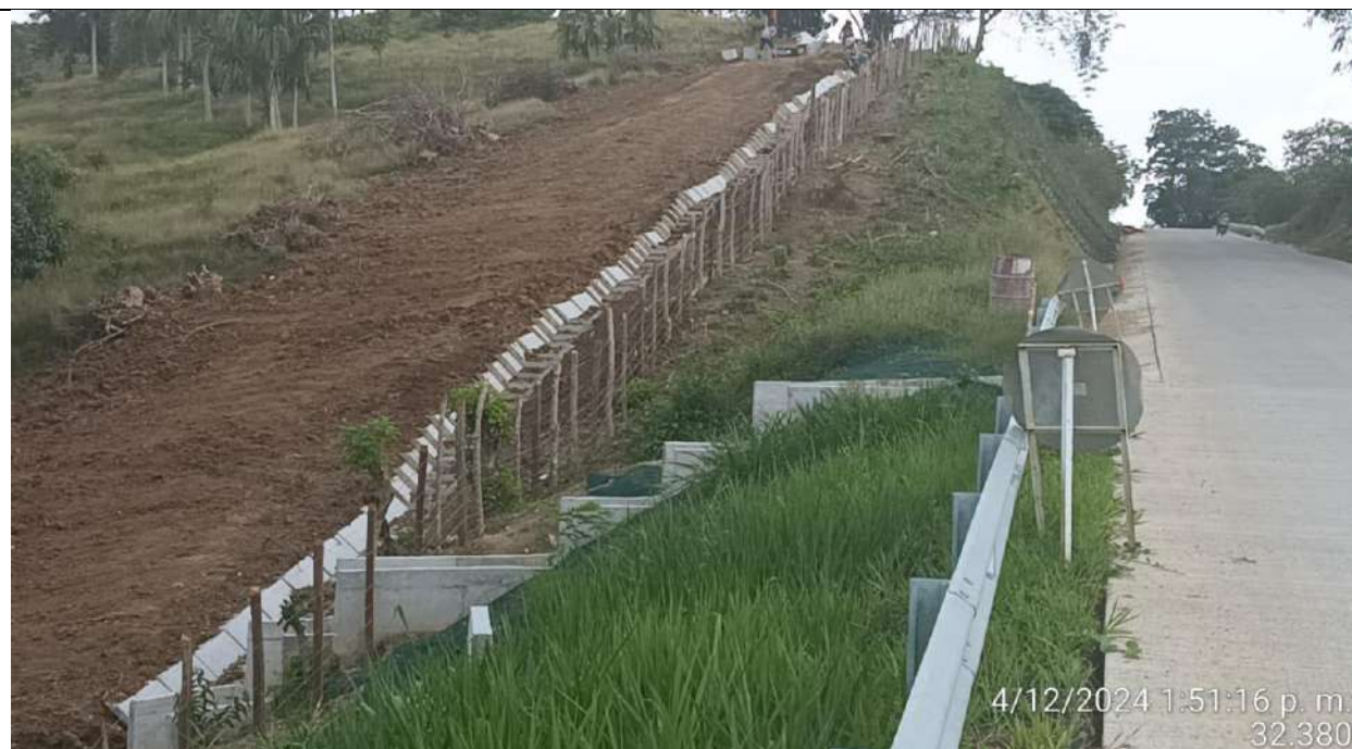
Instalación de zanjas de coronación en el PR26+400 a menores margen derecha.
