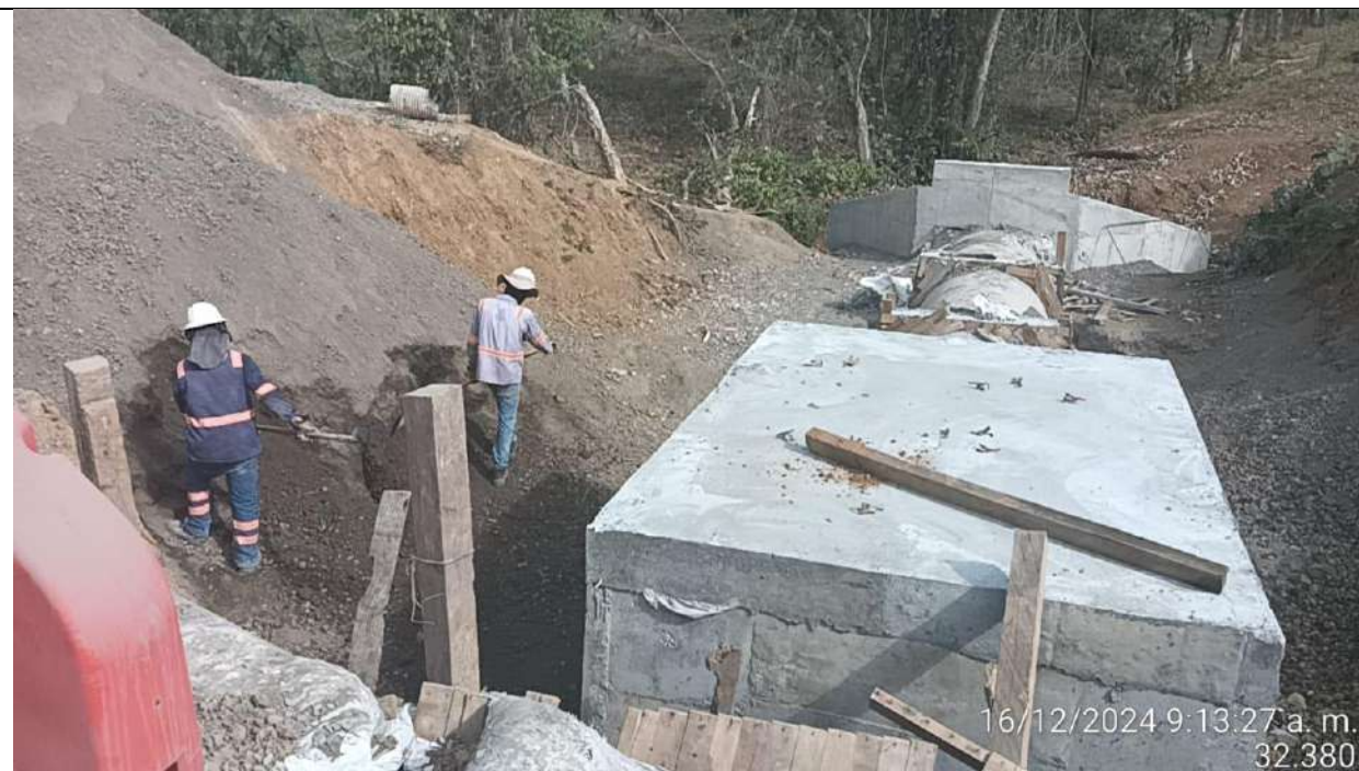
Alcantarilla PR30+220. Leno estructural con material de afirmado.
