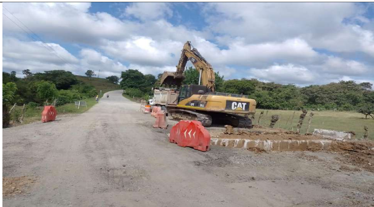
Alcantarilla PR27+075 lado derecho. Remoción de obra existente.
