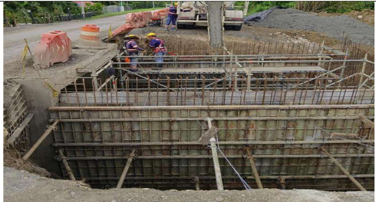
Box Culvert PR28+200 lado derecho. Fundida de muro sentido sur
