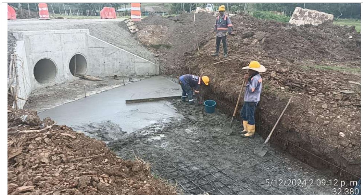
Fundida de canal en descole de alcantarilla PR27+075 margen izquierda.
