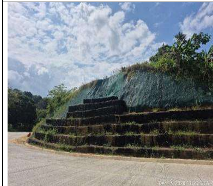
Foto 3. Instalación de geomanto PR 14+400 LI
