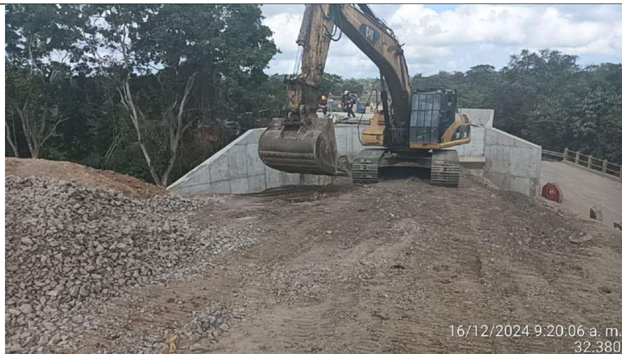
Puente PR34+500. Lleno en estribo 1.
