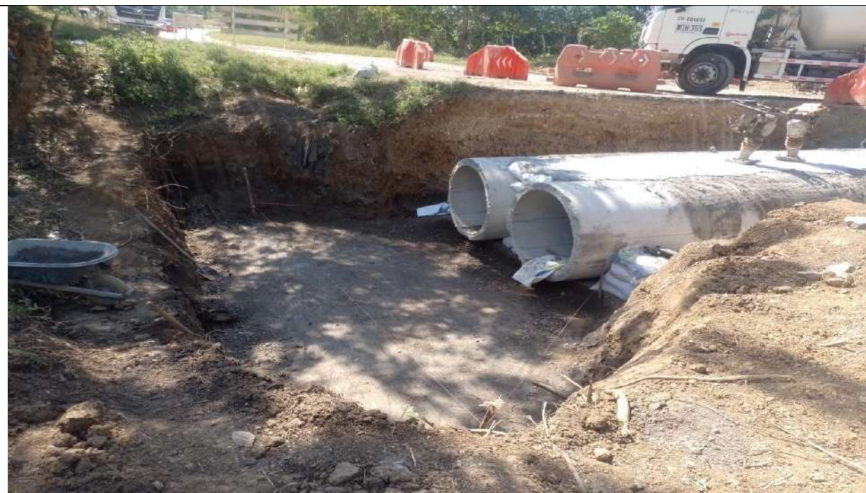
Alcantarilla PR26+200 lado derecho. Instalación de tubería y conformación con material de afirmado.
