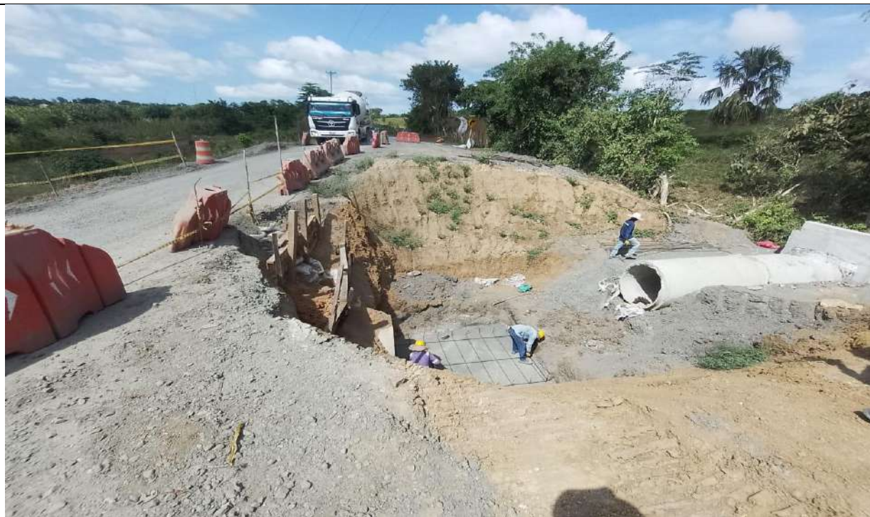
Alcantarilla PR30+220. Armado acero de refuerzo para construcción de caja intermedia.
