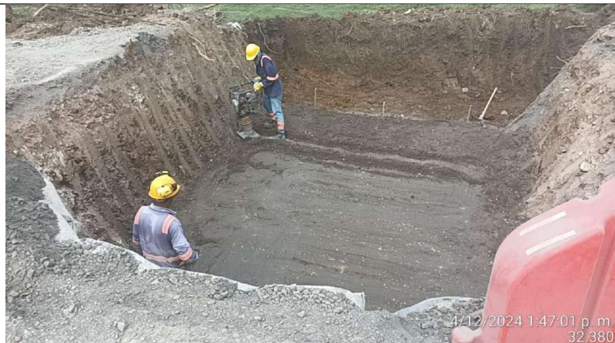
Alcantarilla PR27+075 lado derecho. Instalación de afirmado para soporte de tubería.
