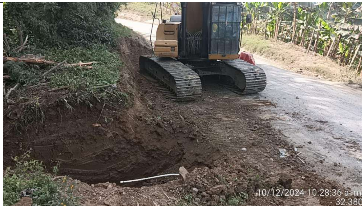
Alcantarilla PR41+950 lado derecho. Excavación para construcción de alcantarilla T2.
