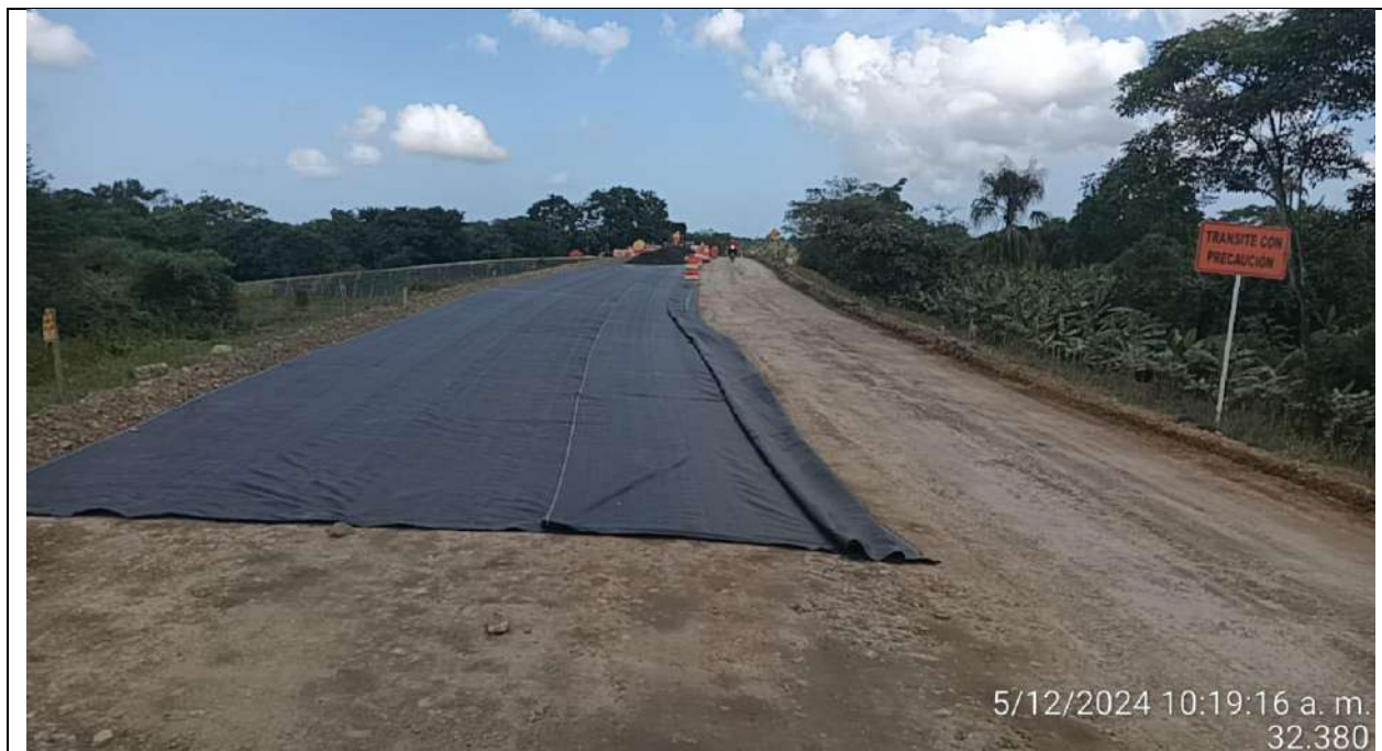
Instalación de geotextil T2400 del PR34+380 a mayores carril izquierdo.
