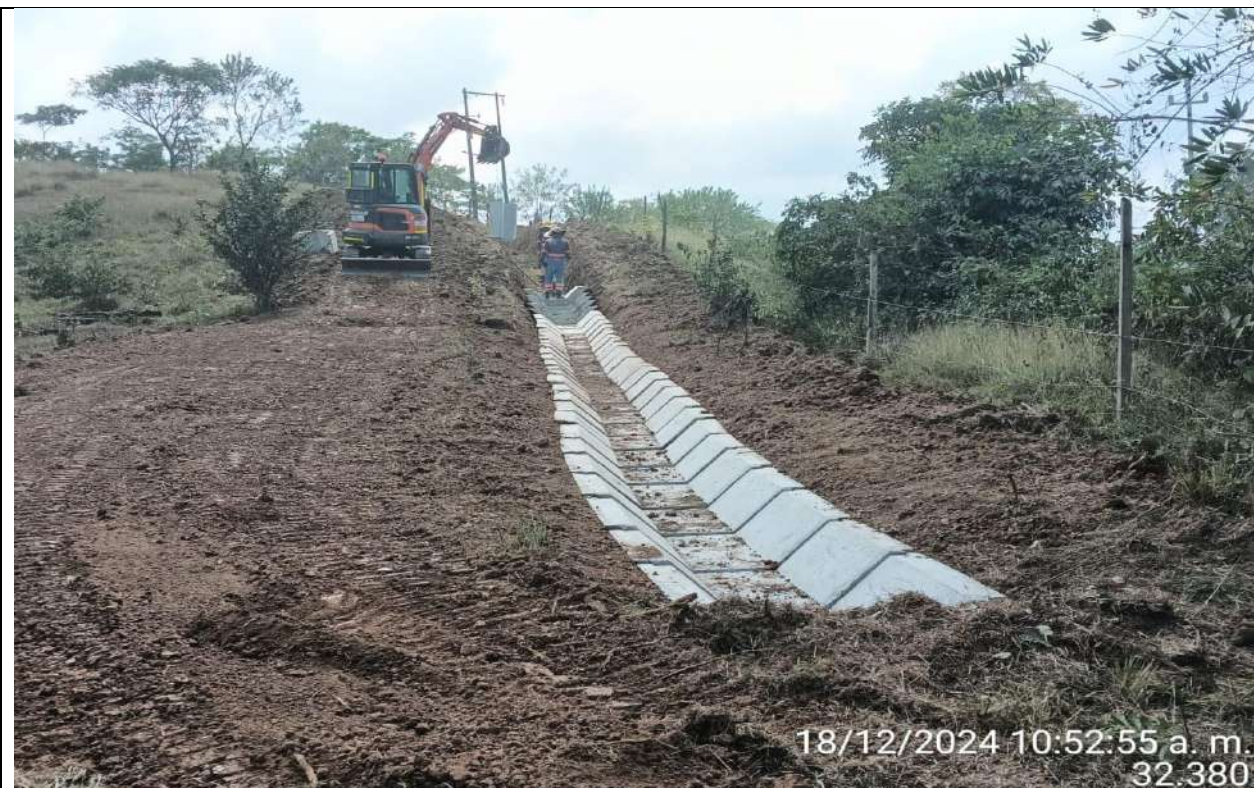
Excavación e instalación de zanjas de coronación en el PR45+150 margen derecha.
