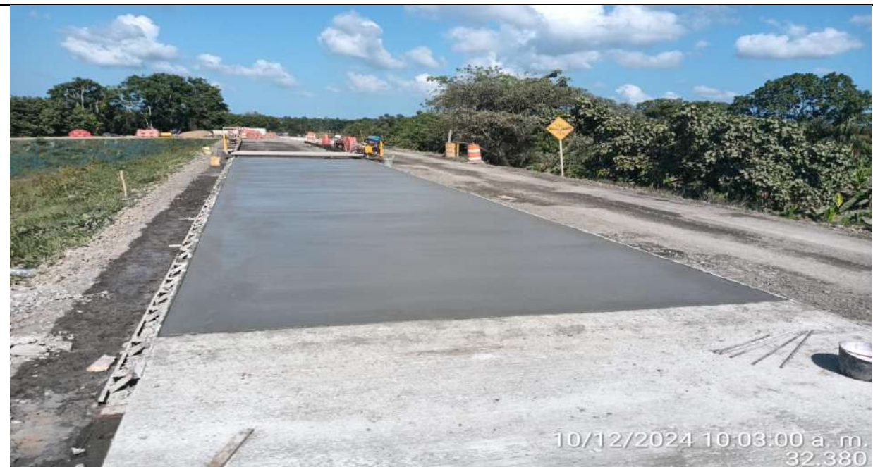
Fundida de pavimento MR-40 PR34+485 a menores.
