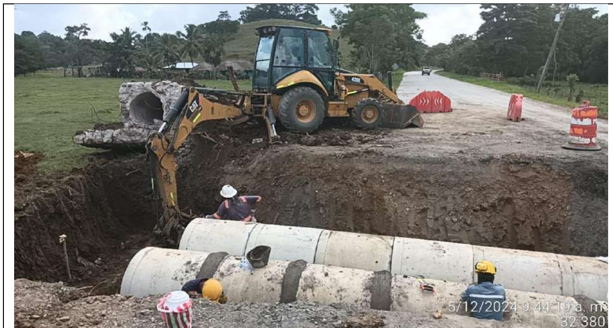
Alcantarilla PR27+075 lado derecho. Instalación de tubería Ø90cm y excavación de cabezal.
