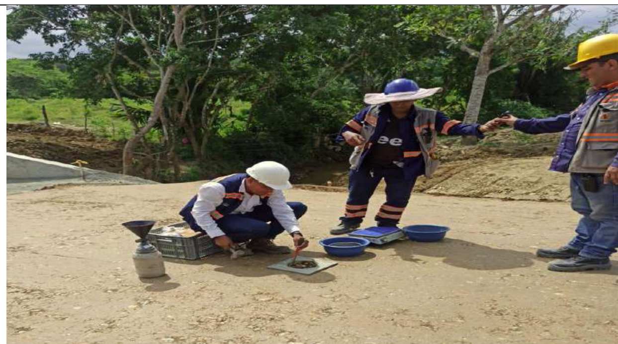
Ensayos de densidad a terraplén instalado del PR34+658 al PR34+668 carril izquierdo.
