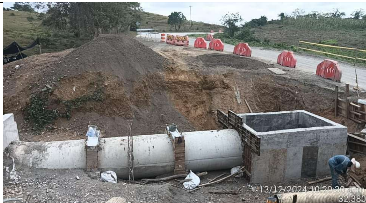
Alcantarilla PR30+220. Fundida caja intermedia.
