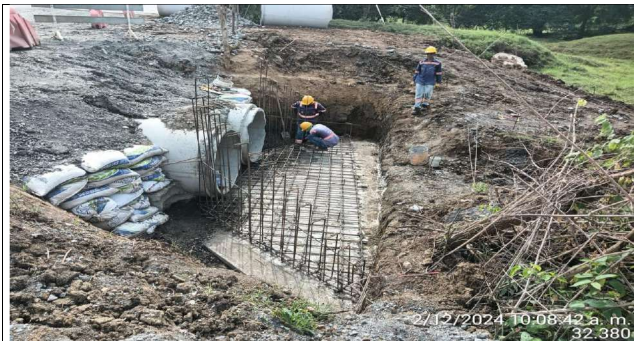
Alcantarilla PR27+075 lado izquierdo. Instalación acero de refuerzo de aletas y losa inferior entre aletas.
