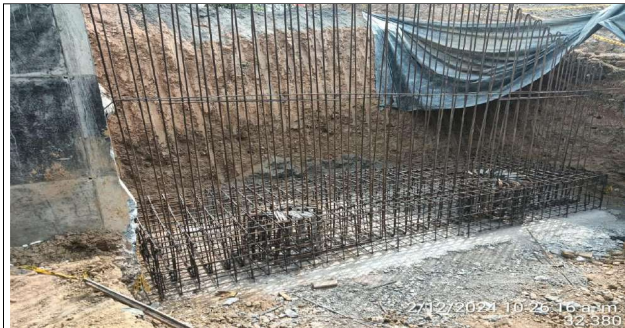
Puente PR34+500. Acero de refuerzo para zarpa de muro de acompañamiento en estribo 1 lado izquierdo.
