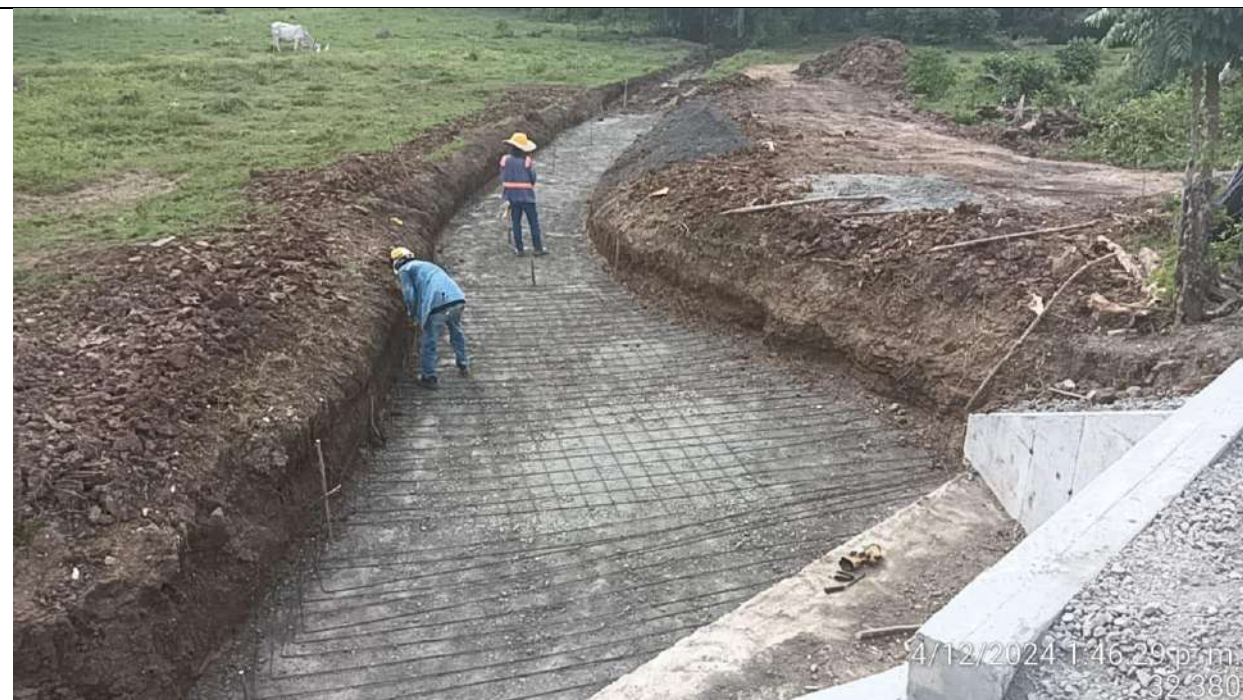
Instalación acero de refuerzo para construcción de canal en descole de alcantarilla PR27+075 margen izquierdo.
