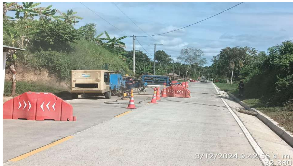
Instalación de drenes horizontales en talud del PR16+500 margen izquierda.
