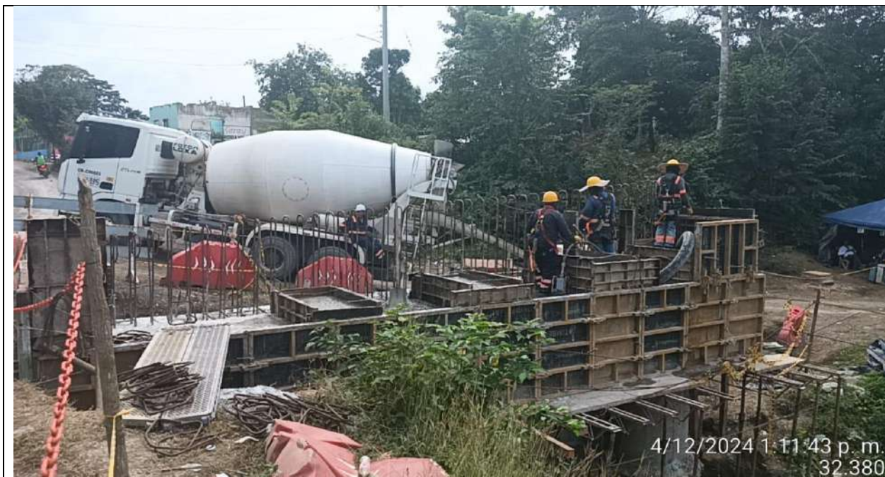
Puente PR45+700. Fundida de pedestales sobre viga cabezal estribo 1.
