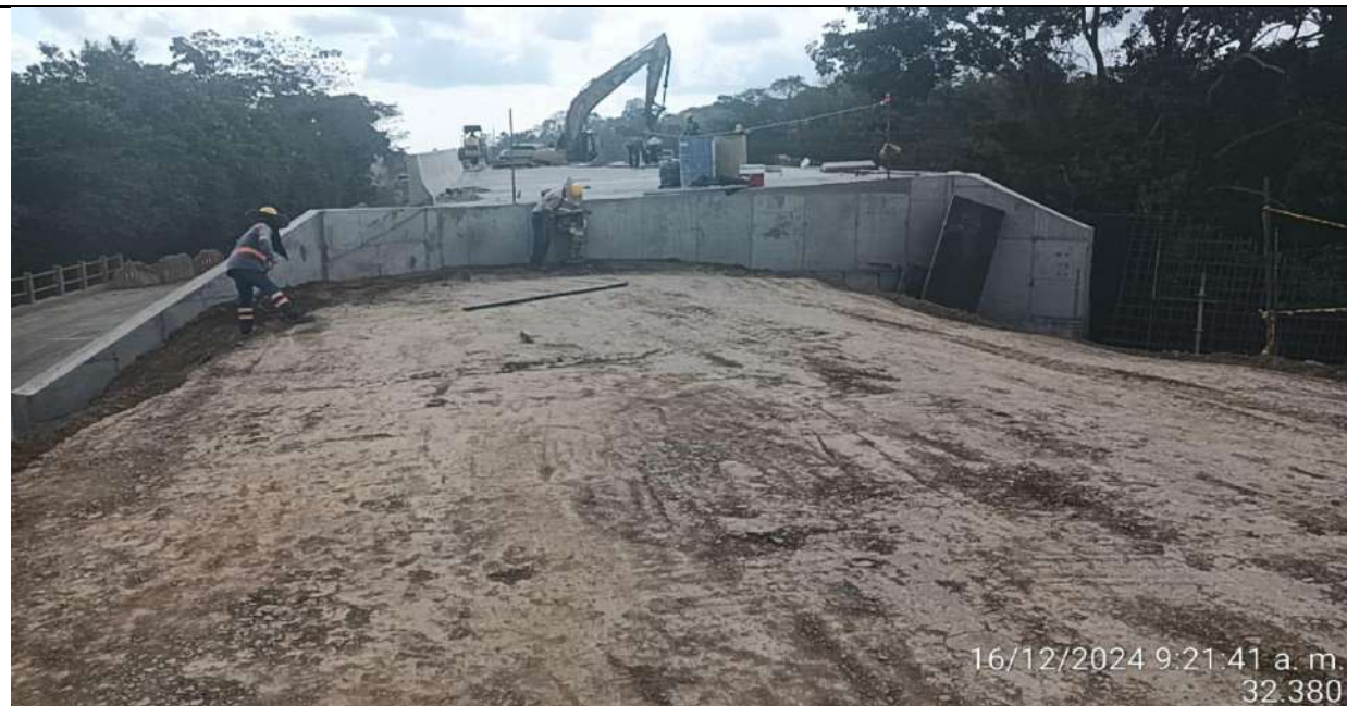
Puente PR34+500. Lleno en estribo 2.
