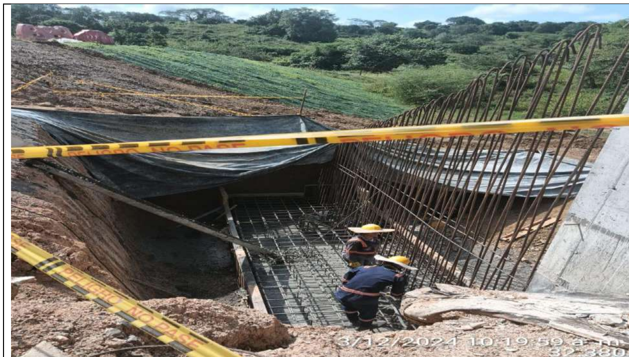
Puente PR34+500. Fundida de zarpa para muro de acompañamiento del estribo 1 lado izquierdo.
