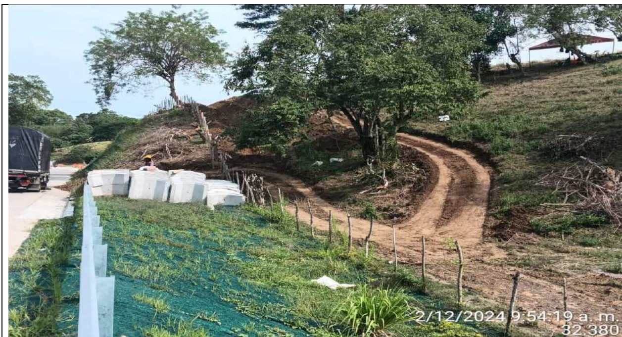
Excavación para instalación de zanjas de coronación en el PR26+320 margen derecha.
