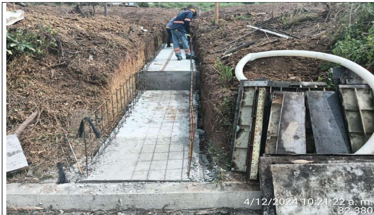
Instalación de acero muros dissipador PR30+340 margen derecha.
