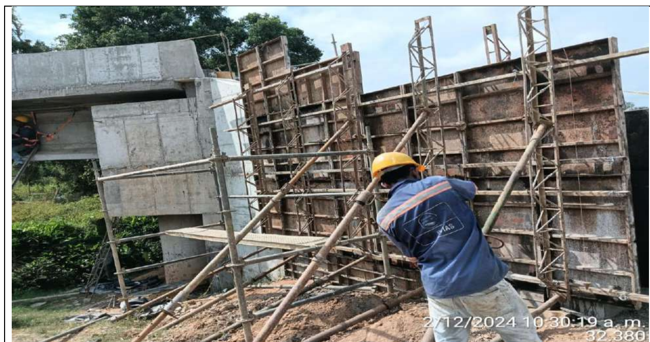
Puente PR34+500. Instalación de formaletas en muros de acompañamiento del estribo 2 lado derecho.
