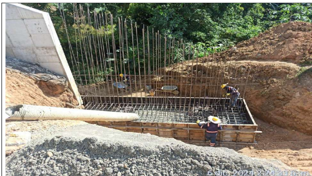
Puente PR34+500. Fundida viga cabezal muro de acompañamiento 2.
