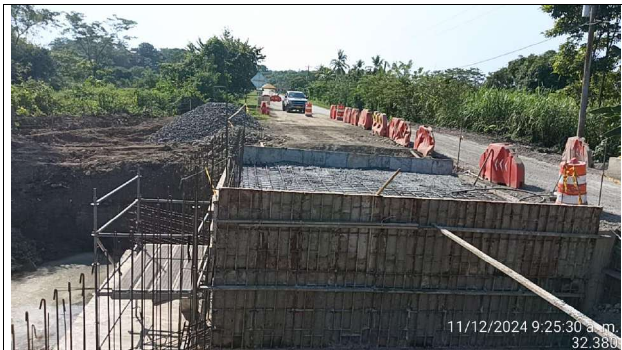
Box Culvert PR28+192 lado derecho. Fundida de losa superior.
