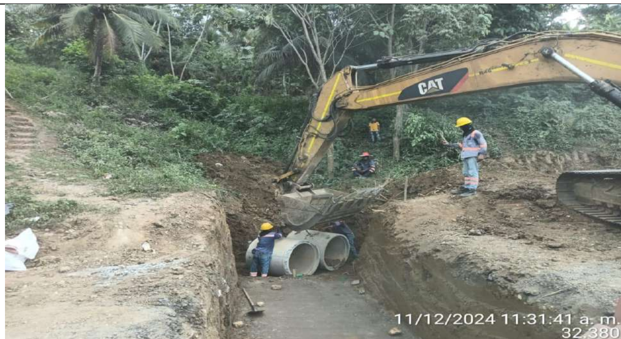
Alcantarilla PR41+950 lado derecho. Instalación de tubería.
