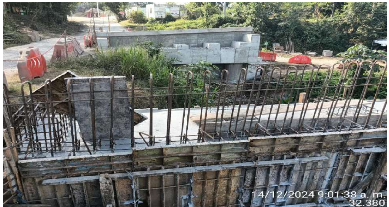
Puente PR45+700. Se funde viga cabzal de estribo 2.
