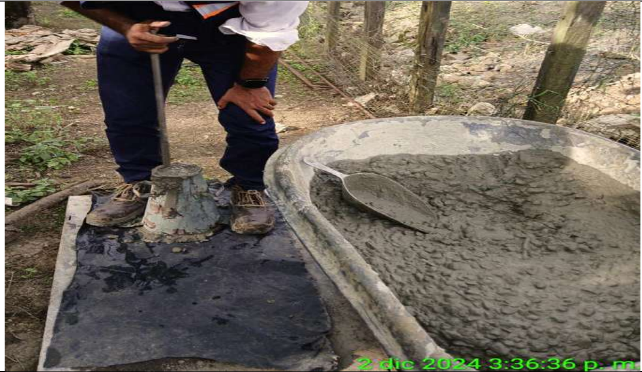
Box Culvert PR28+200 lado derecho. Ensayo de asentamiento concreto de muro sentido norte
