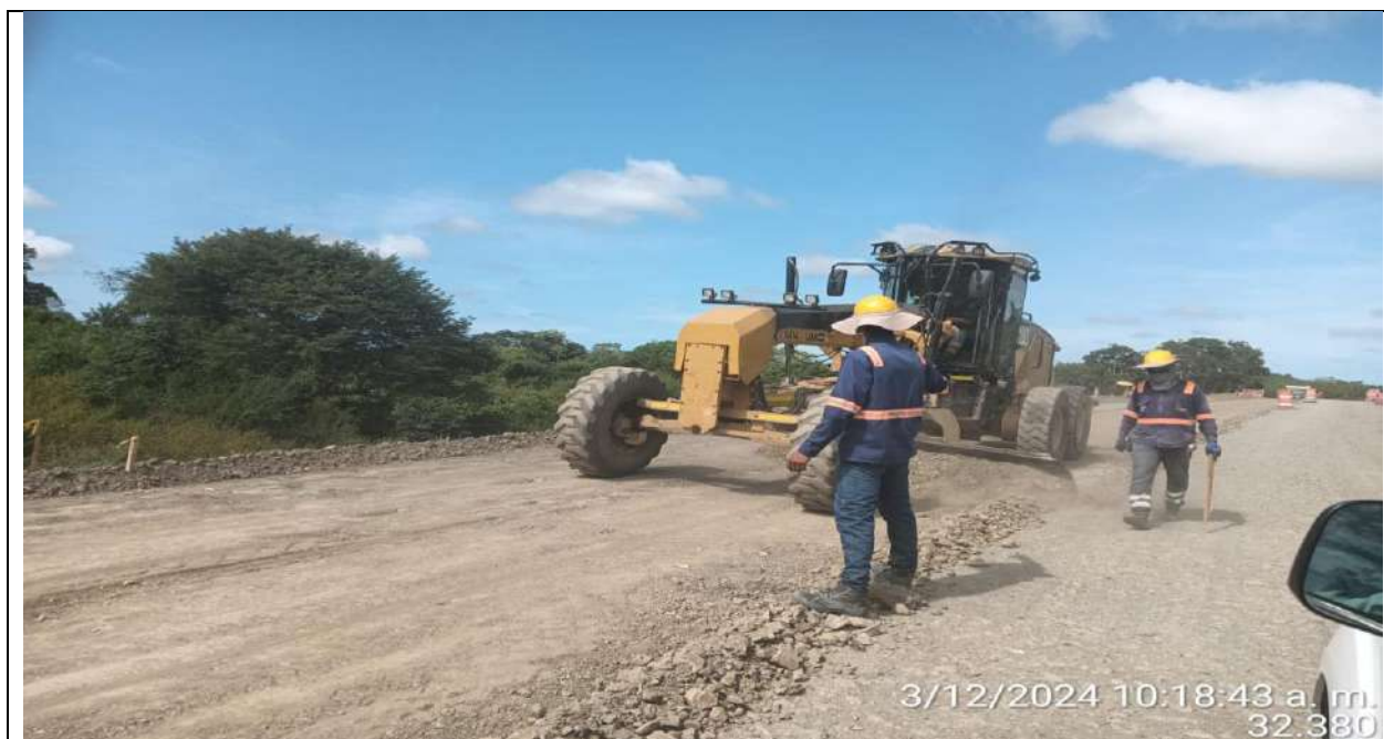
Puente PR34+500. céreo de subrasante en terraplén sentido sur del PR34+470 a mayores.
