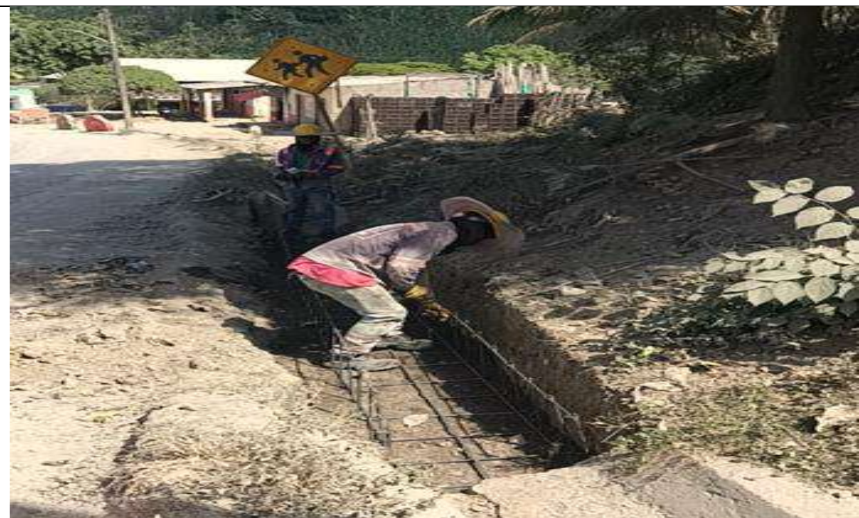
Acero de refuerzo para cuneta trapezoidal en el PR42+020 lado derecho.
