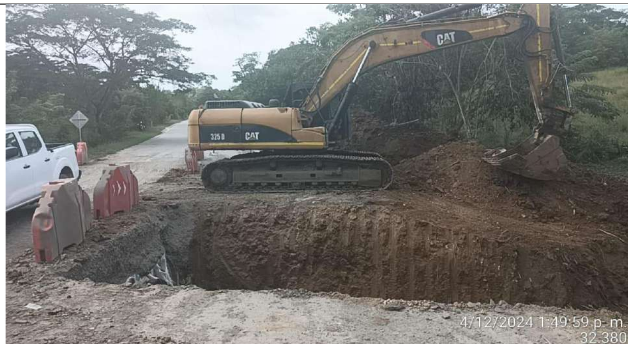
Alcantarilla PR26+600 lado derecho. Excavación para construcción de alcantarilla.
