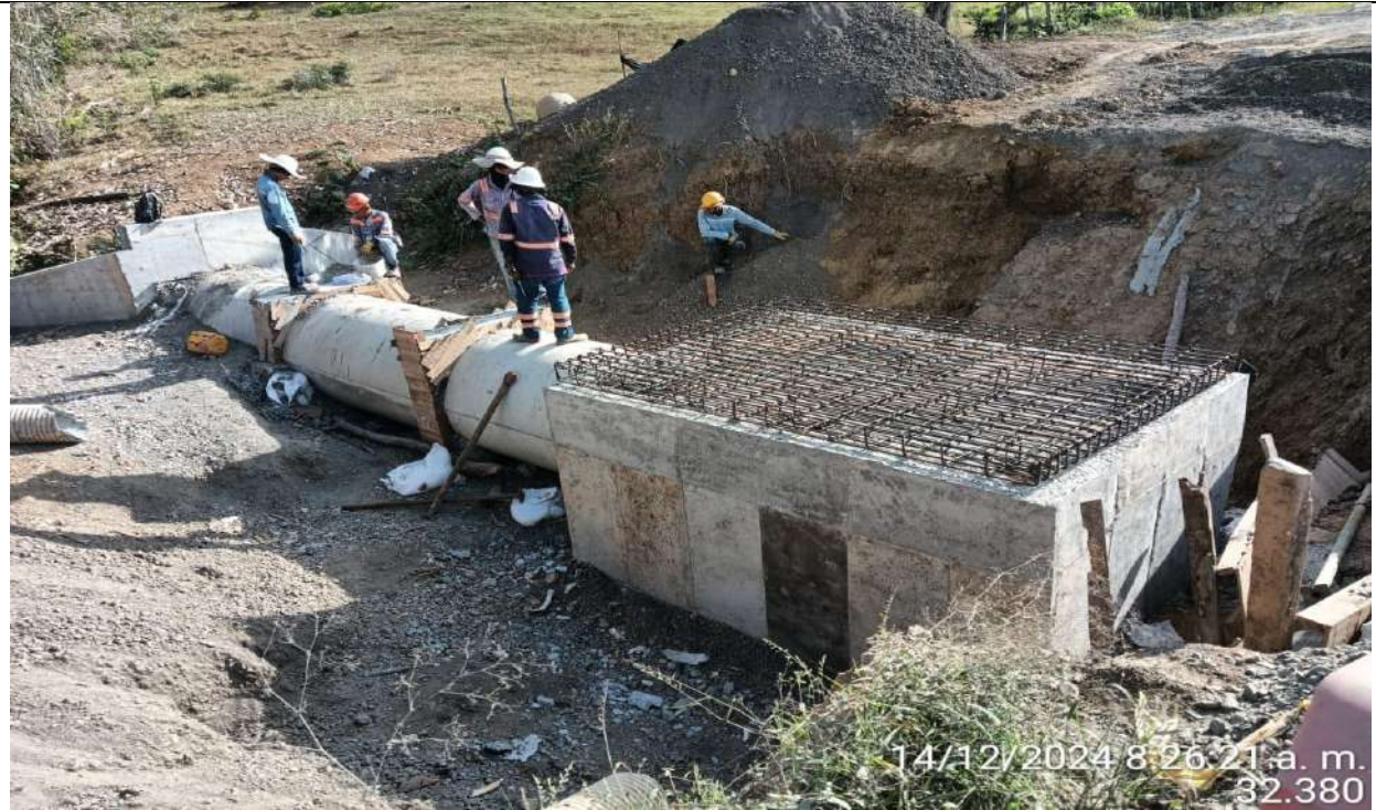
Alcantarilla PR30+220. Instalación acero de refuerzo tapa caja intermedia.
