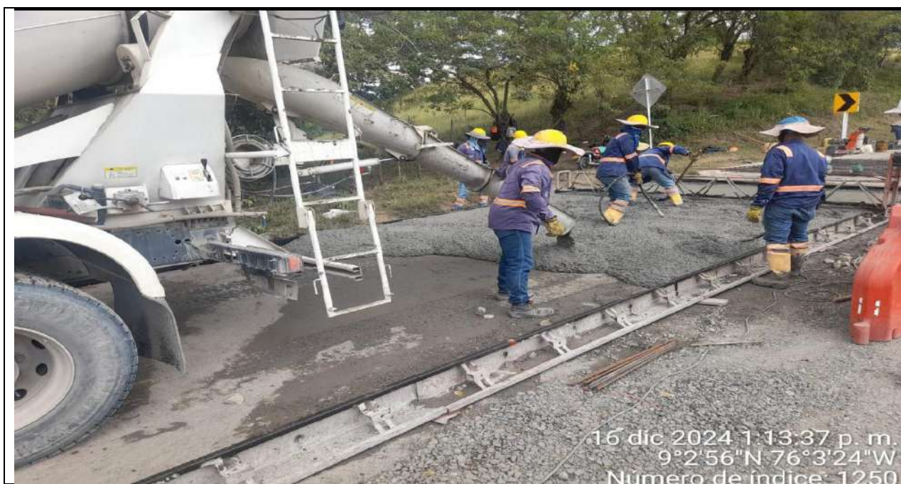
Fundida de pavimento MR-40 para cierre de broche del PR26+590 al PR26+621.8 carril derecho.
