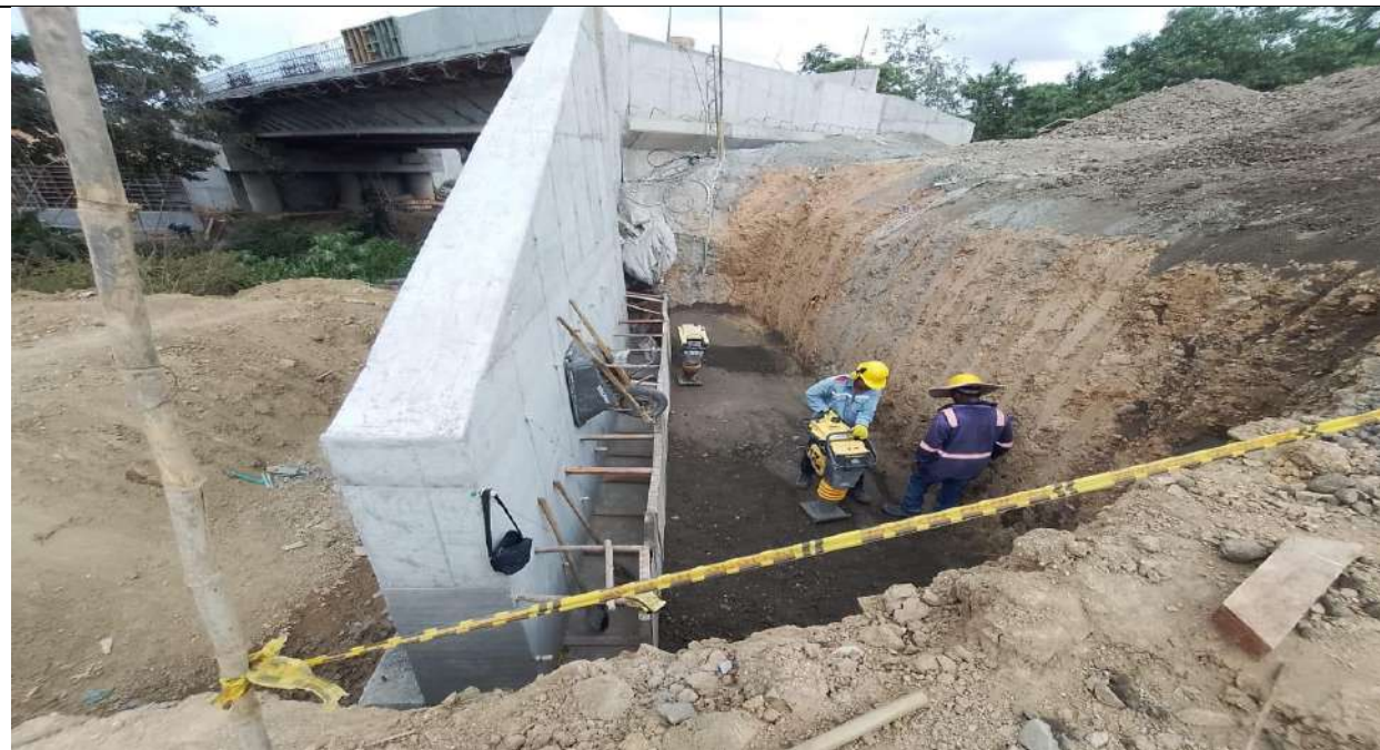
Puente PR34+500. Lleno con material de afirmado en muro de acompañamiento estribo 1 margen izquierda.
