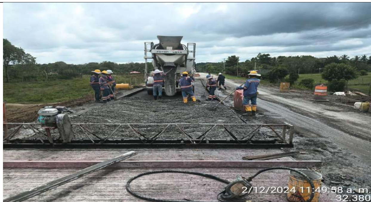
Fundida de pavimento MR-40 para cierre de broche del PR28+500 a menores carril derecho.
