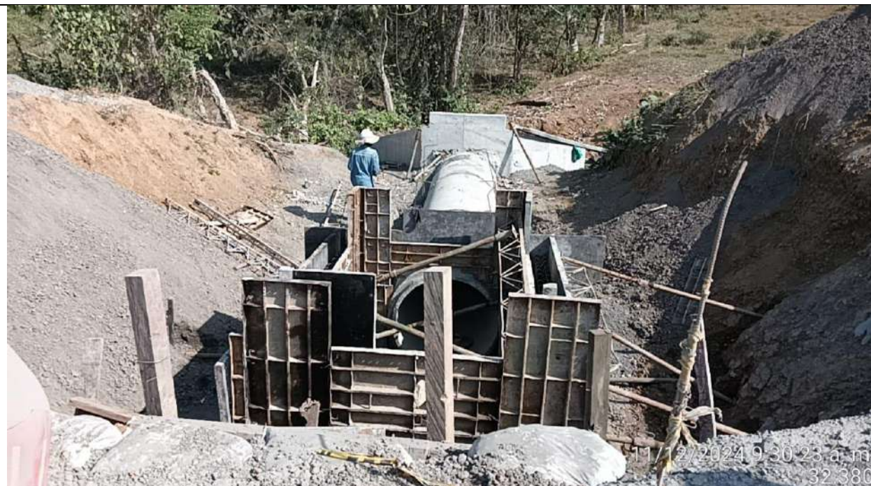
Alcantarilla PR30+220. Encofrado complemento caja intermedia.
