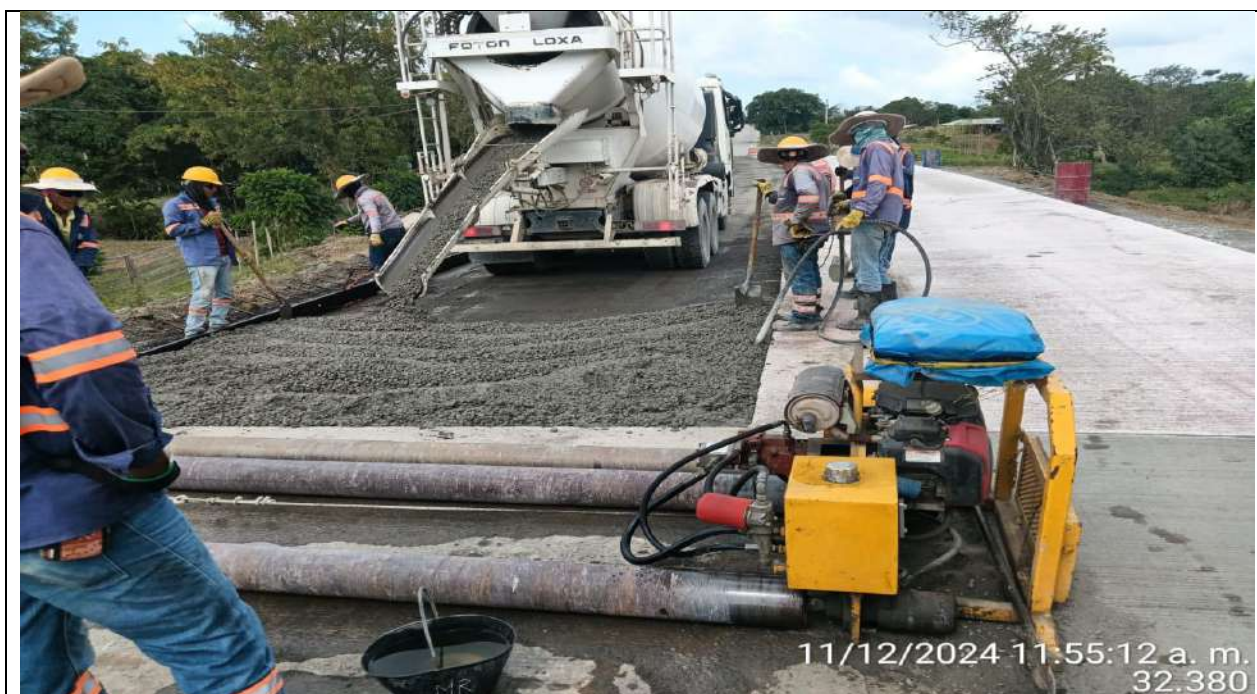
Fundida de pavimento MR-40 para cierre de broche del PR28+500 a menores carril izquierdo.
