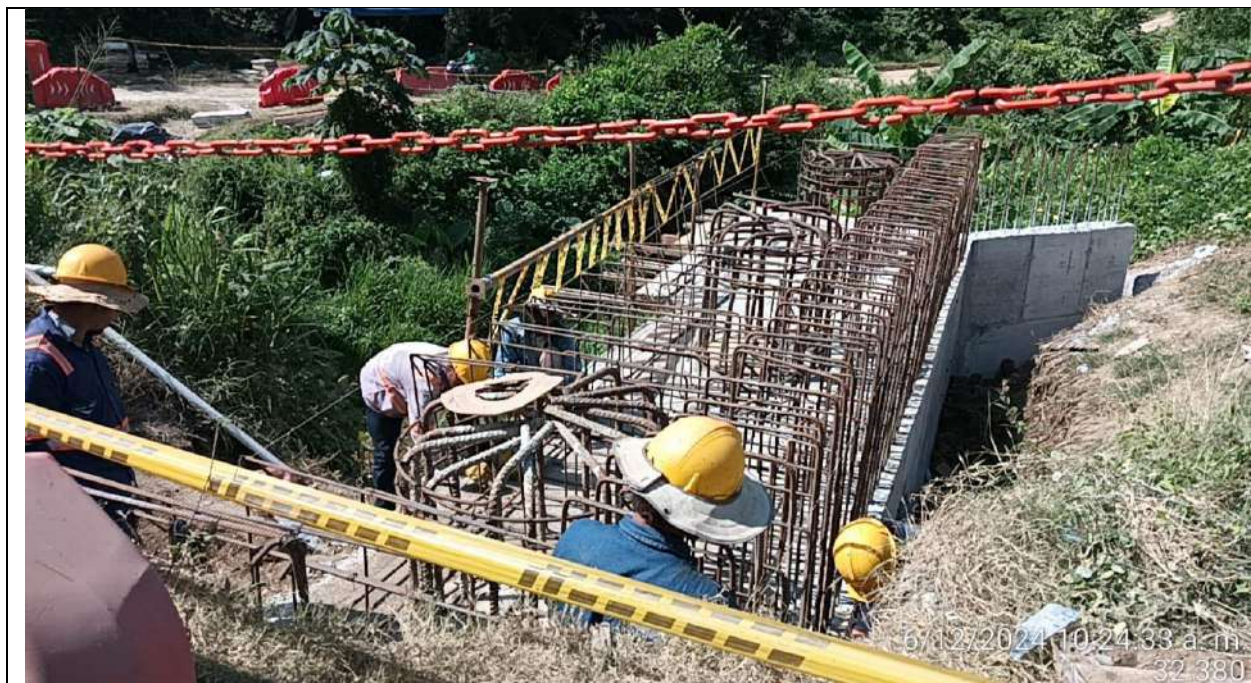
Puente PR45+700. Instalación acero de refuerzo viga cabezal estribo 2.
