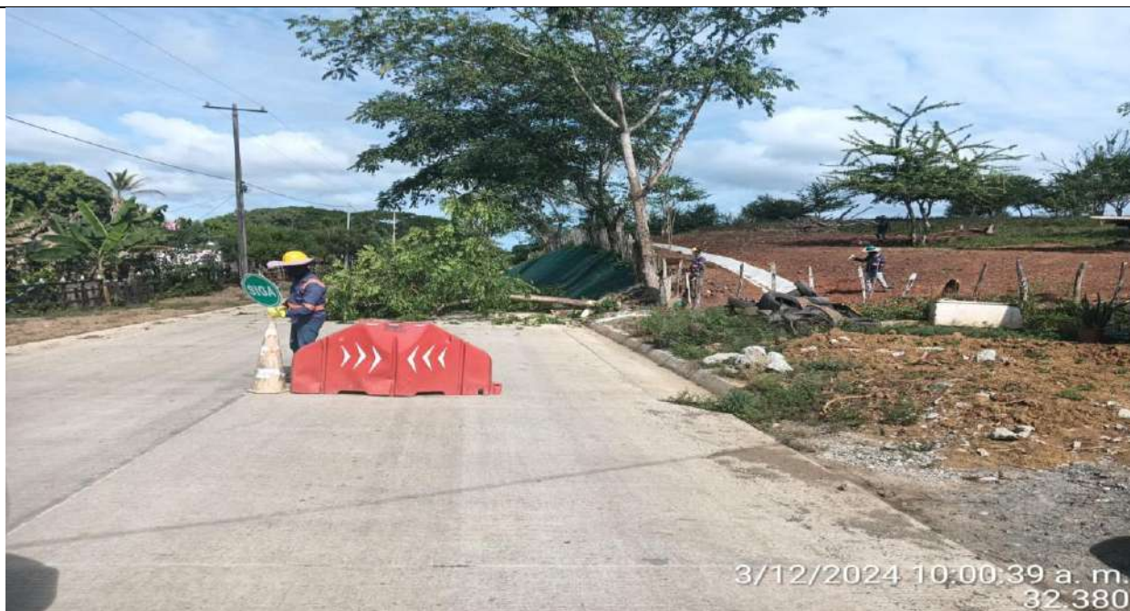
Tala de arboles en el PR23+750 margen derecha.
