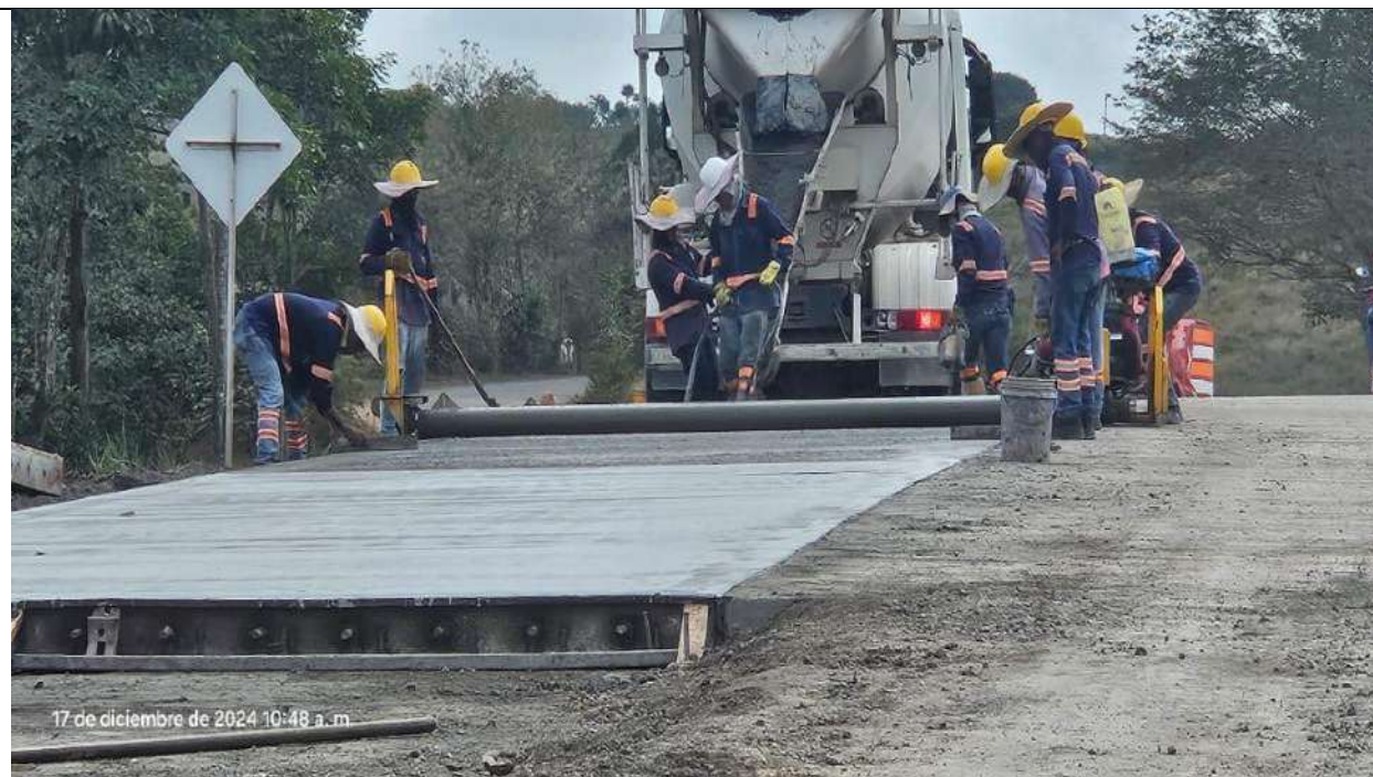
Fundida de pavimento MR-40 PR34+490 a menores.
