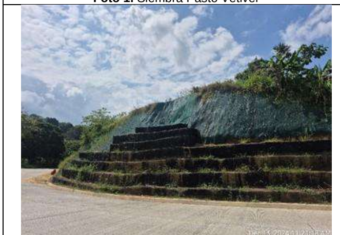
Foto 5. Instalación de geomanto PR 14+400 LI
