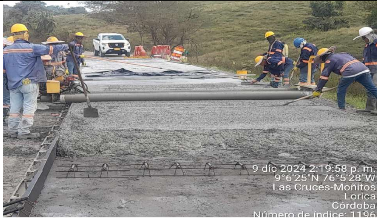
Fundida de pavimento MR-40 PR34+470 a menores.
