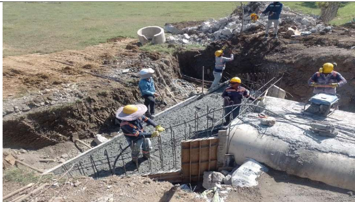
Alcantarilla PR27+075 lado derecho. Se realiza fundida de losa cabezal.
