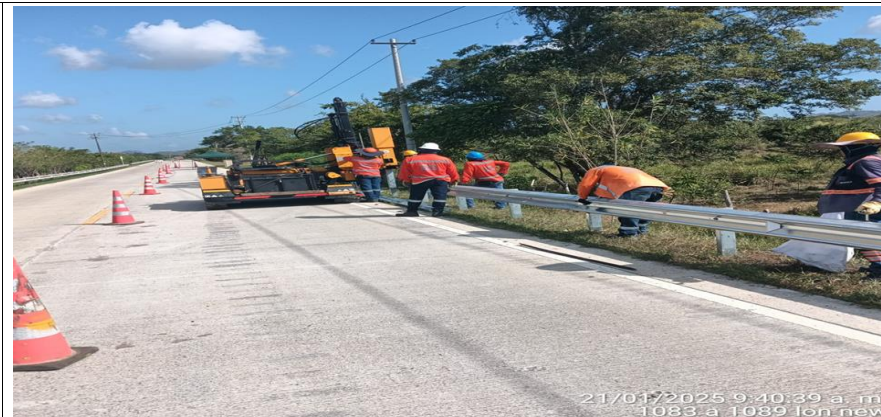
Instalación de defensas metálicas del PR20+250 a mayores, margen derecha.
