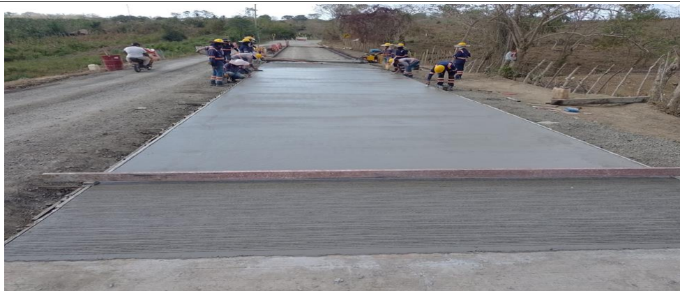
Fundida de pavimento MR-40 para cierre de broche del PR30+180 al PR30+234 carril derecho.
