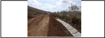
Instalación de zanjas de coronación margen derecha PR 31+700 a mayores
