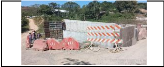
puente del PR 45+700 encofrado aleta izquierda del estribo 1
