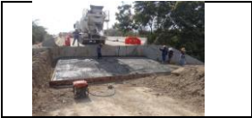
construcción losa de aproximación en estribo 2 de puente regino calzada completa PR 34+500
