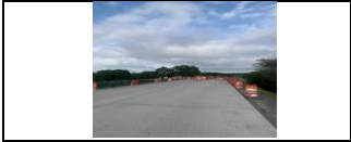
Acceso al puente PR34+500
