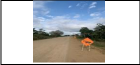
Accesos al puente PR34+500
