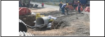
PR 35+340 Instalación tubería alcantarilla sencilla y llenos
