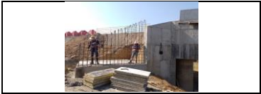
puente Regino PR 34+500 lado derecho, armado de acero de refuerzo para encofrado de aleta (Muro de acompañamiento lateral) estribo 1
