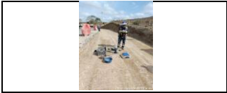
subrasante estabilizada con cal PR30+030 al PR30+105 carril derecho (tramo de prueba)
