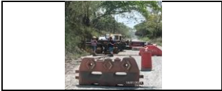
PR45+150 se instala drenes horizontales, lado derecho
