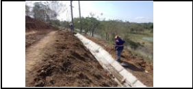
construcción de zanjas de coronación PR 45+000 a mayores
