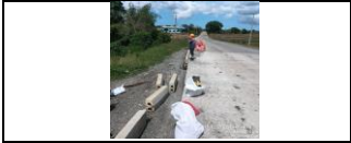
instalación de bordillos PR28+520 a mayores, lado izquierdo
