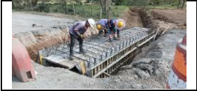
Instalación de acero de refuerzo de losa superior box culvert PR 32+730 lado derecho.
