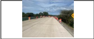
Acceso al puente PR34+500
