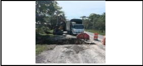
excavación para construcción de box culvert PR 32+730, lado derecho.
