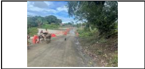
PR45+700 acceso sur puente en construcción
