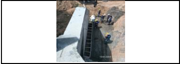
llenos con material de afirmado en lado izquierdo del estribo 2 del puente del PR 34+500.
