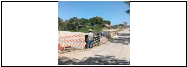
puente del PR 45+700 instalación de formaleta para fundida de aleta derecha en estribo 1.
