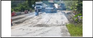
cerezo de subbase granular en broche sobre el lleno de box culvert del PR 28+192, carril izquierdo.
