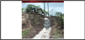
PR 45+130 lado derecho excavaciones para instalación de zanjas de coronación.
