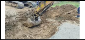
PR 35+433 el contratista realiza excavación construcción de un box culvert lado izquierdo.
