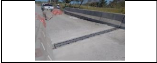
Instalación de junta de neopreno en puente PR 45+300 estribo 1 y 2 carriil derecho
