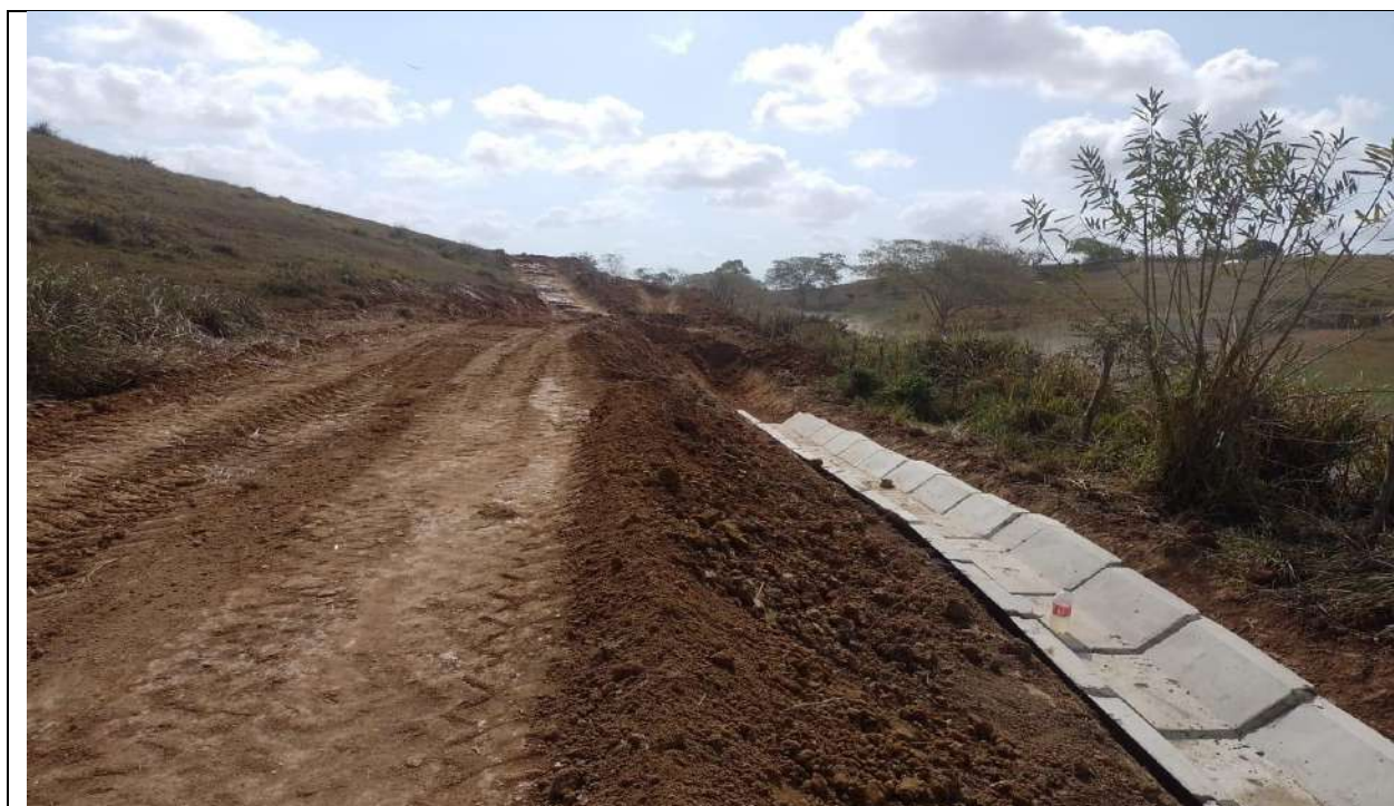
Excavación e instalación de zanja de coronación en el PR31+700 a mayores, margen derecha.
