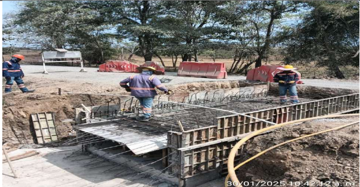
Box Culvert PR35+432. Instalación acero de refuerzo losa superior.
