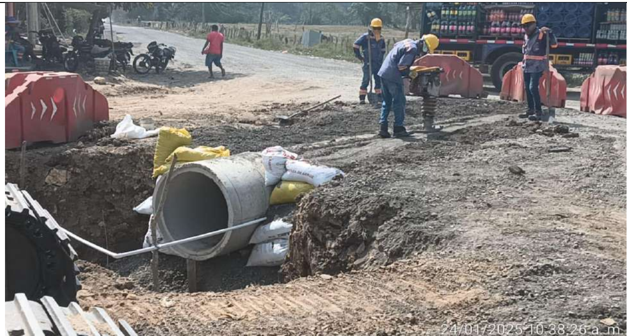
Alcantarilla PR35+346 lado derecho. Instalación de tubería y relleno con material de afirmado.
