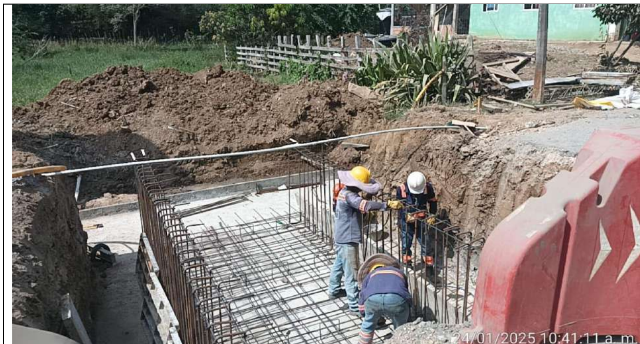
Box Culvert PR35+432 lado izquierdo. Instalación acero losa inferior y muros.
