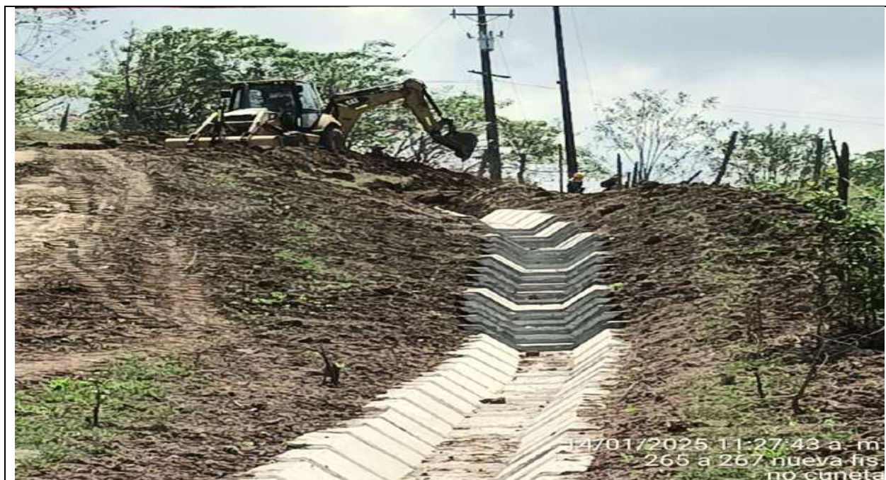
Excavación para instalación de zanjas de coronación en el PR45+130 margen derecha.
