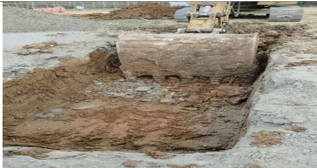
Alcantarilla PR35+346. Excavación para construcción de alcantarilla.
