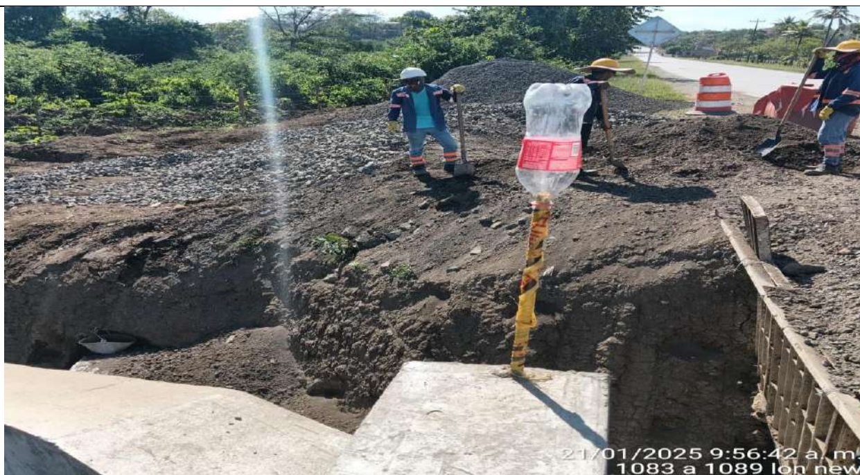
Box Culvert PR28+192 lado izquierdo. Lleno con material de afirmado en sentido sur.
