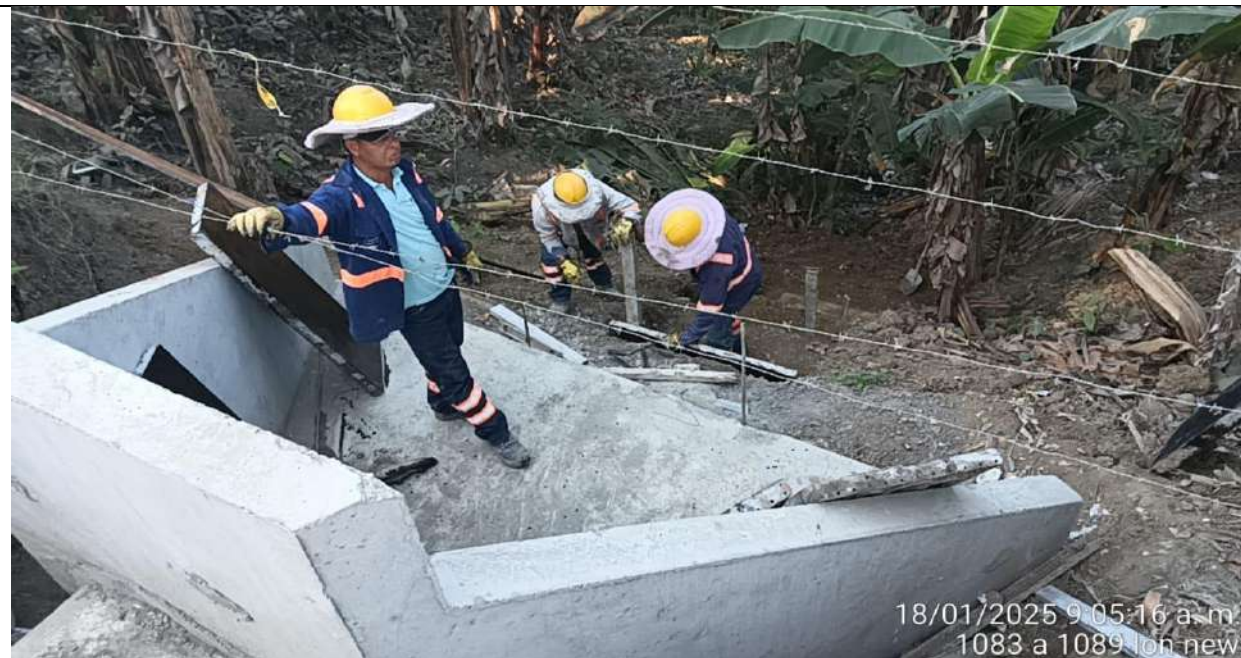
Alcantarilla PR41+950 lado izquierdo. Construcción de disipador en descole de obra.
