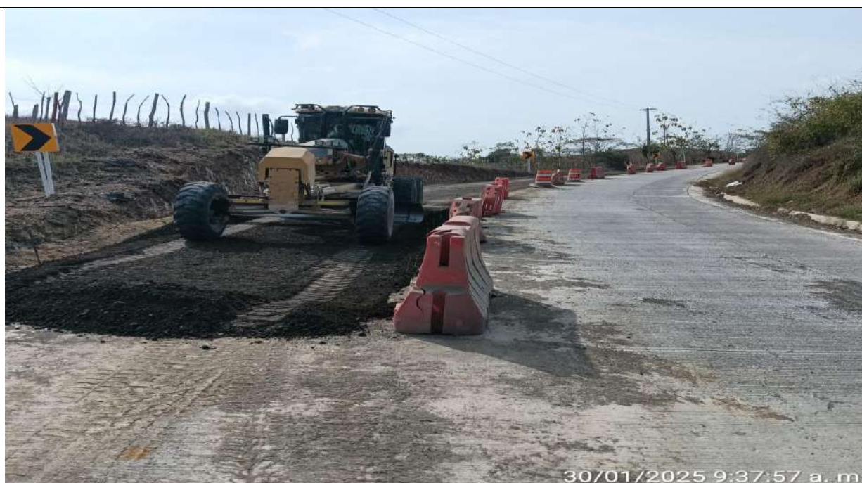
Subbase granular en tramo de prueba del PR30+075 al PR30+100 carril derecho.
