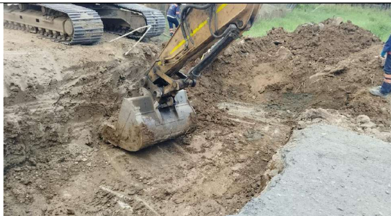
Box Culvert PR35+432 lado izquierdo. Excavación, remoción y demolición de obra existente.
