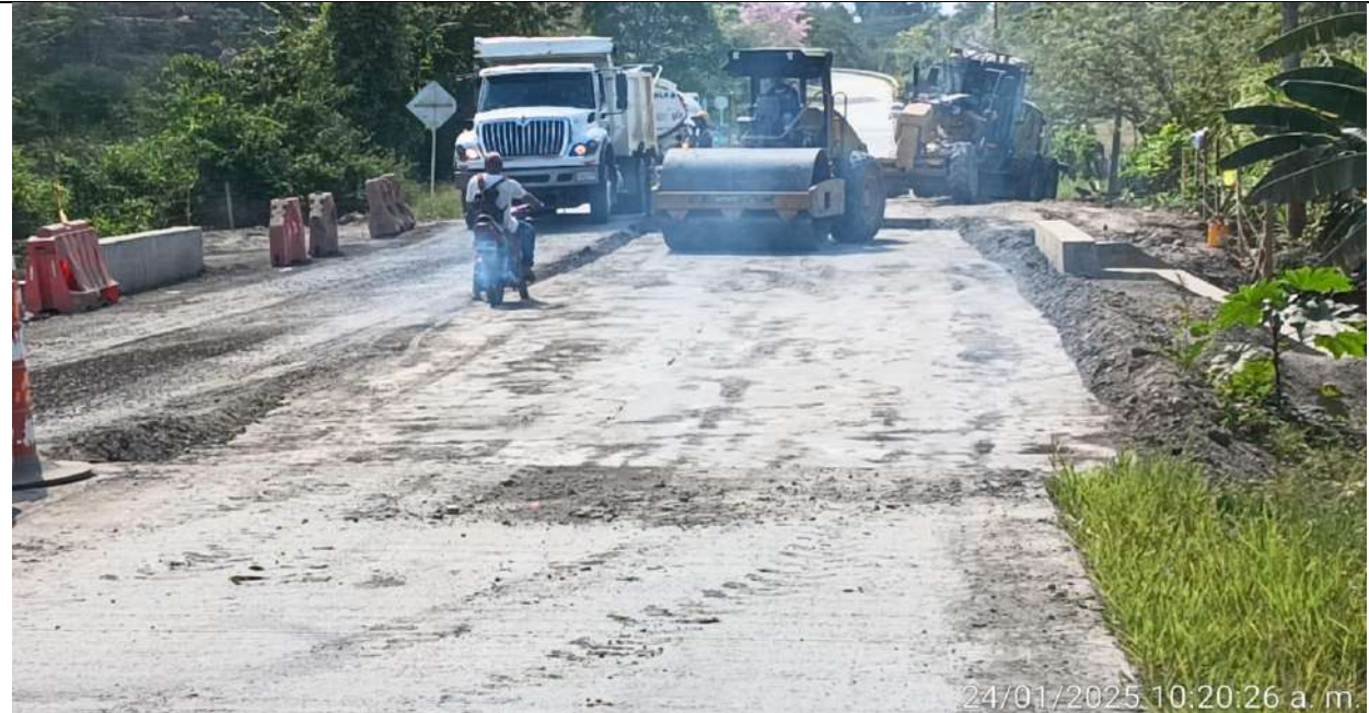
Cerezo de subbase granular en broche del PR28+192 carril izquierdo.
