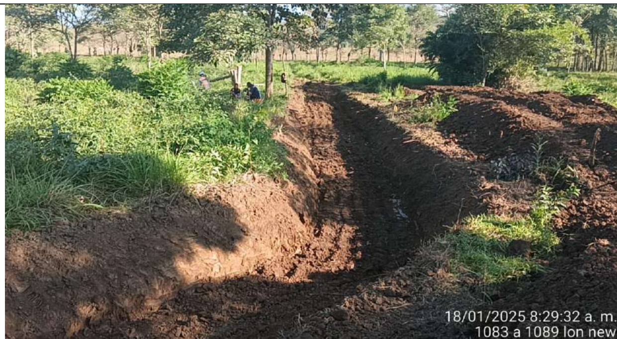
Box Culvert PR32+730 lado derecho. Excavación de 80m para descole de obra.
