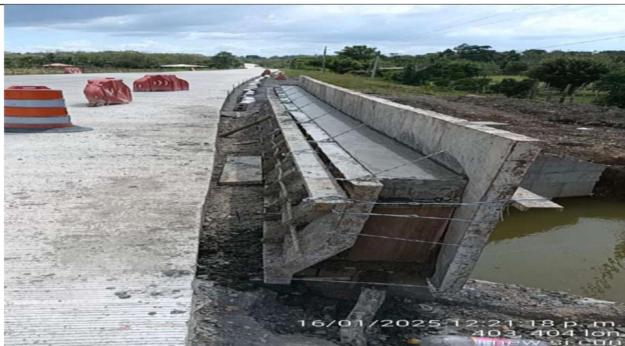
Box Culvert PR28+500 lado izquierdo. Fundida de New Jersey.
