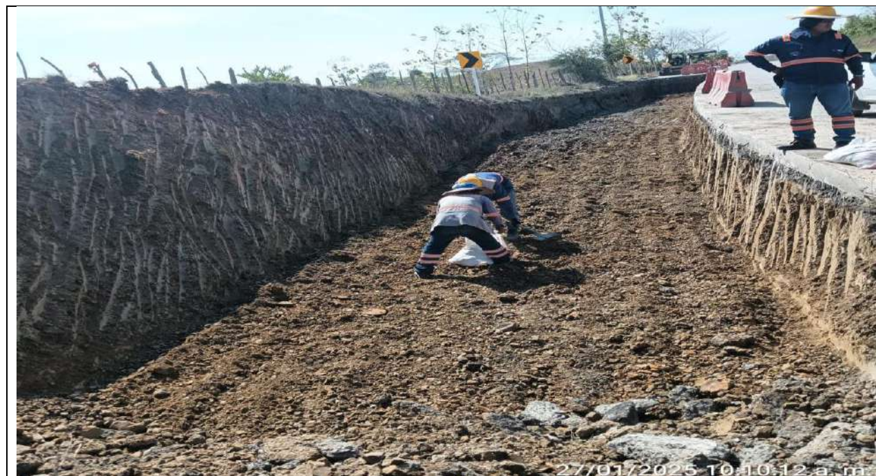
Excavación tramo de prueba PR30+075 al PR30+100 carril derecho.
