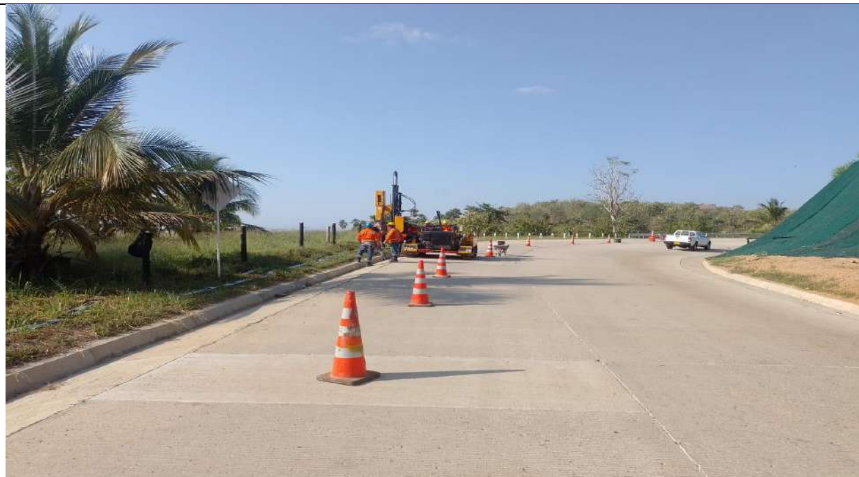
Instalación de defensas metálicas del PR10+600 a menores, margen izquierda.
