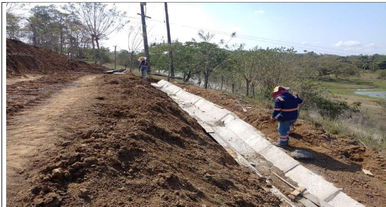
Instalación de zanjas de coronación en el PR45+000 margen derecha.
