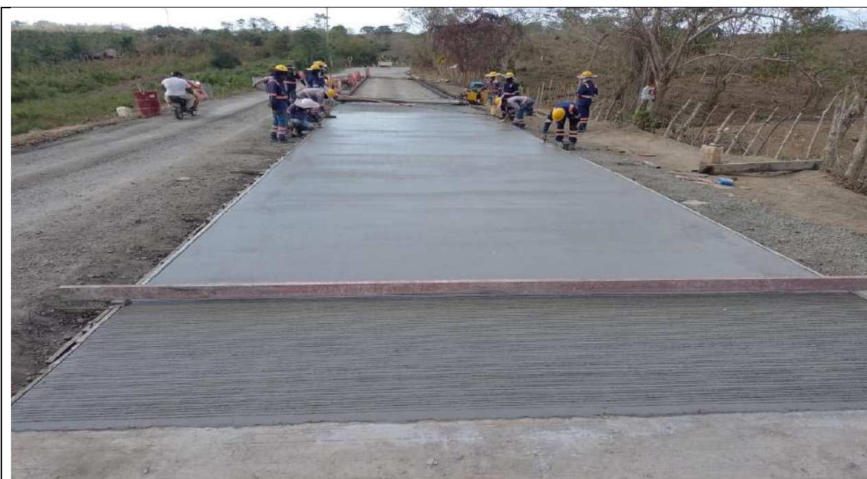
Fundida de pavimento MR-40 para cierre de broche del PR30+180 al PR30+234 carril derecho.
