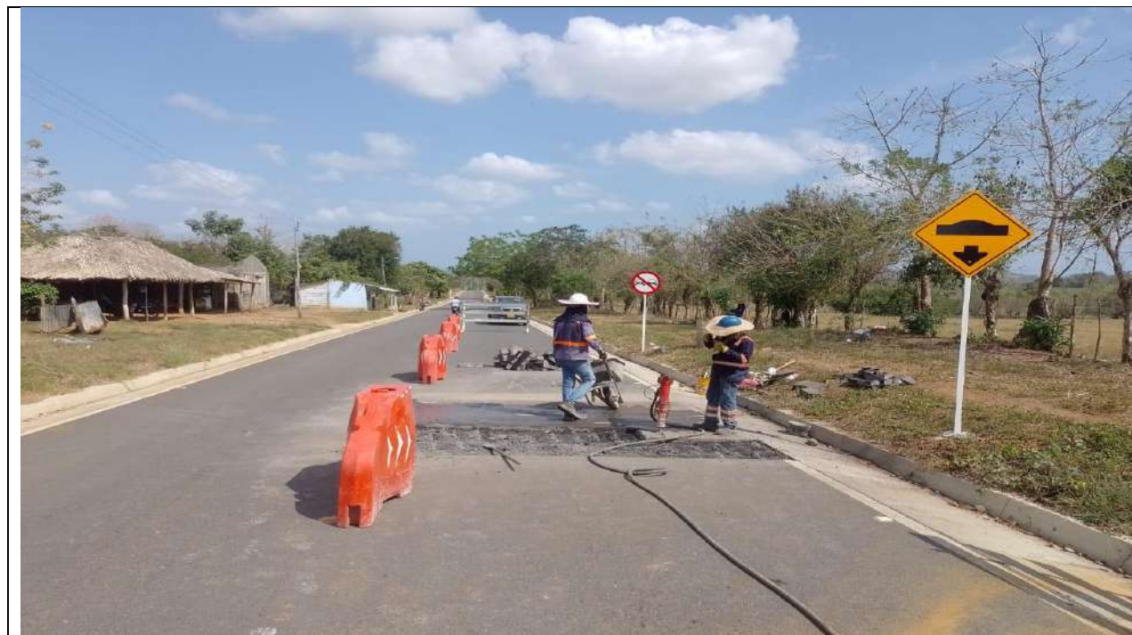
Construcción de resalto pompeyano en el PR16+690 carril derecho.
