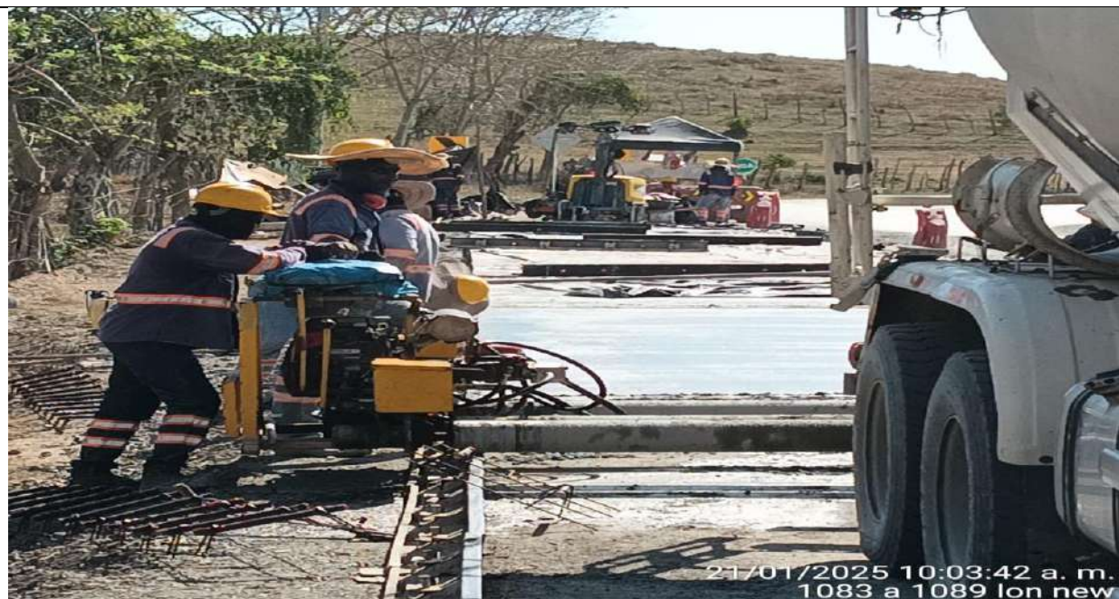
Fundida de pavimento MR-40 para cierre de broche del PR30+234 a mayores carril derecho.
