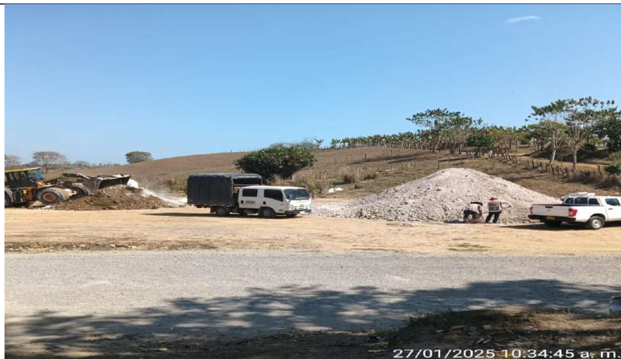
Mezcla de suelo estabilizado con cal tramo de prueba PR30+075 al PR30+100 carril derecho.
