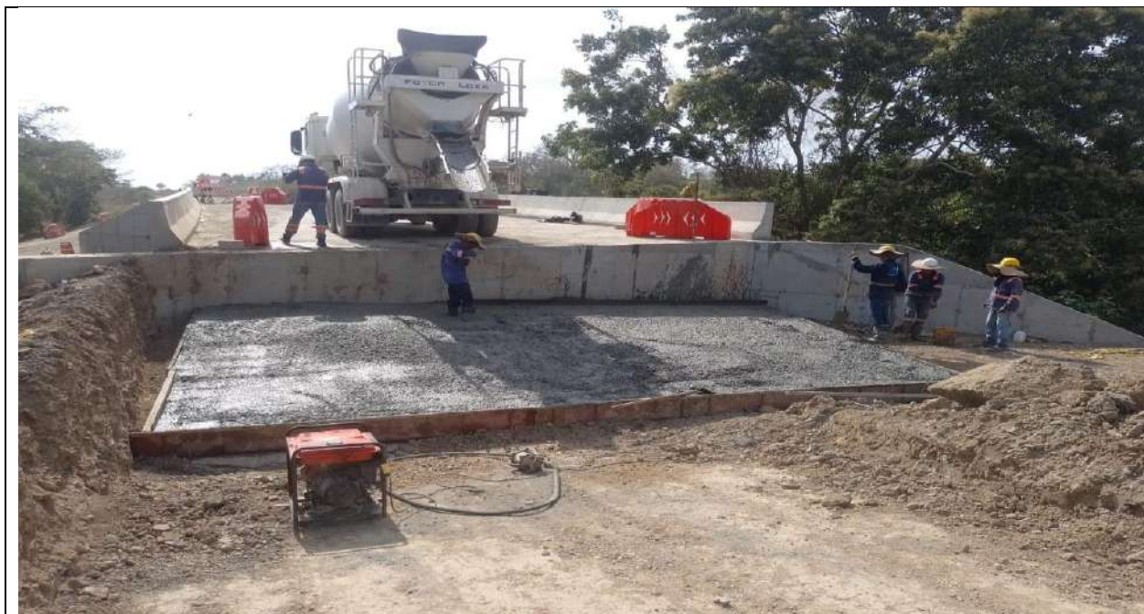
Puente PR34+500. Se funde losa de aproximación en estribo 2.
