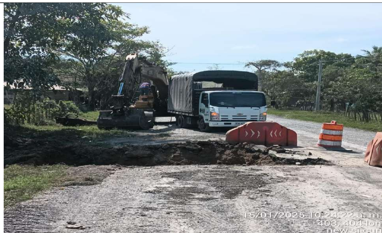
Box Culvert PR32+730 lado derecho. Remoción, demolición y excavación.
