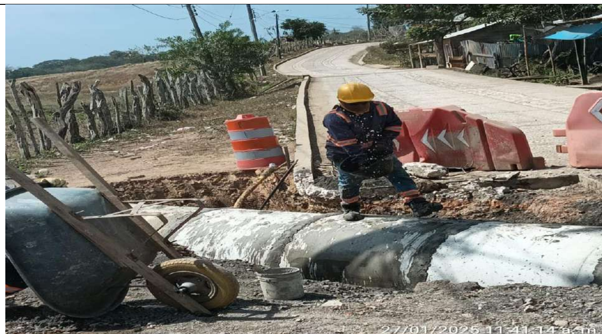
Alcantarilla PR35+346 lado izquierdo. Instalación de tubería y relleno con material de afirmado.
