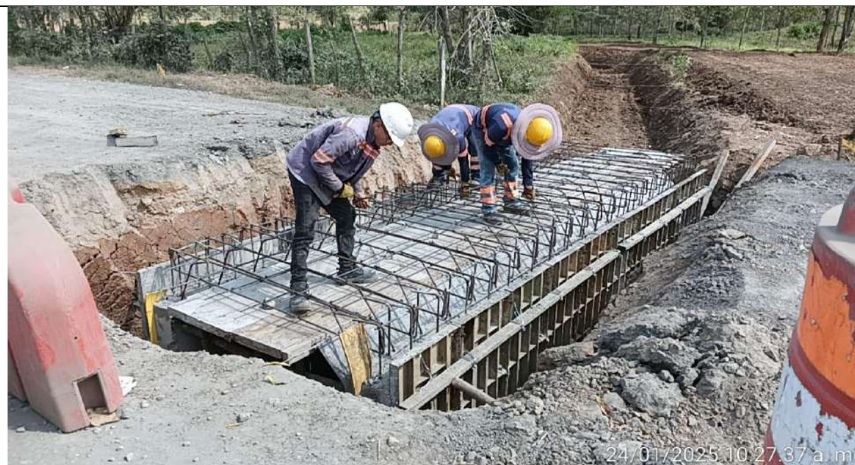
Box Culvert PR32+730 lado derecho. Instalación de acero losa superior y patines.
