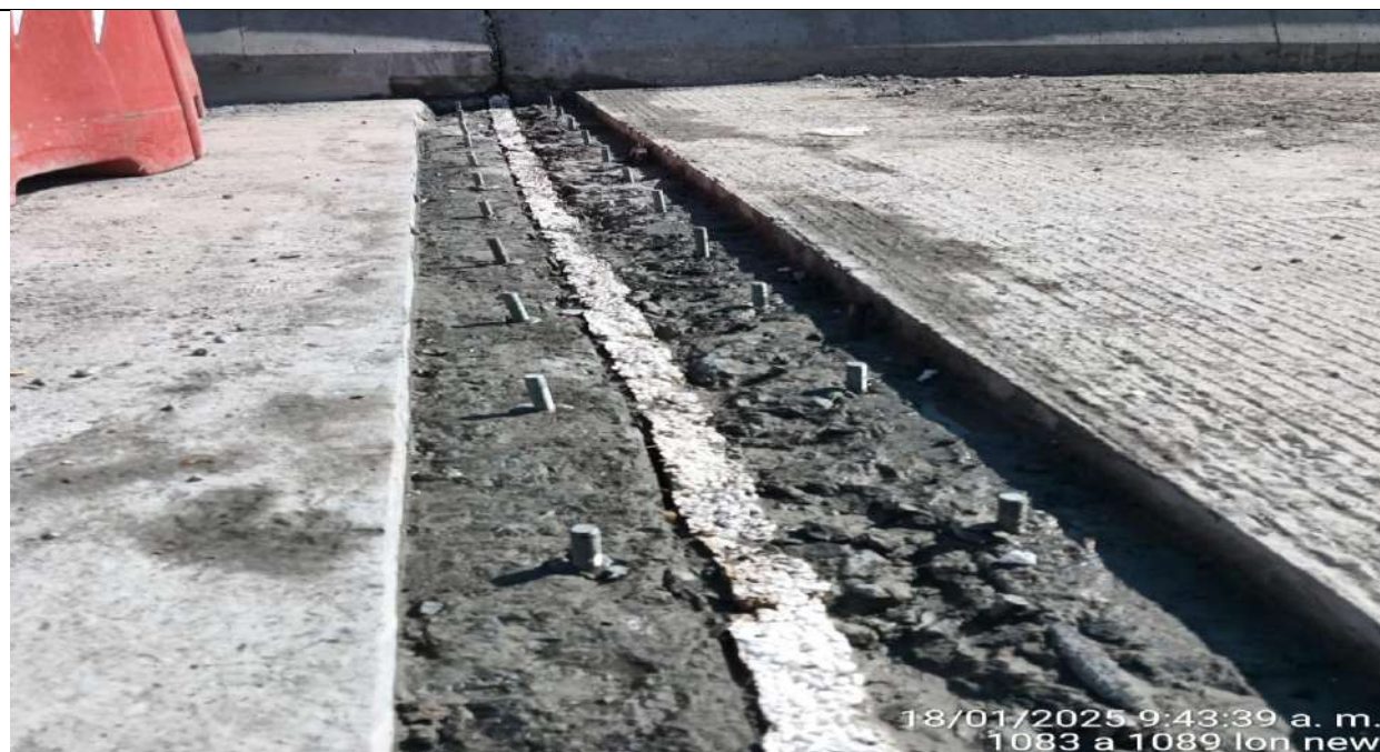
Puente PR45+300. Corte para junta de dilatación en estribo 1 y 2.
