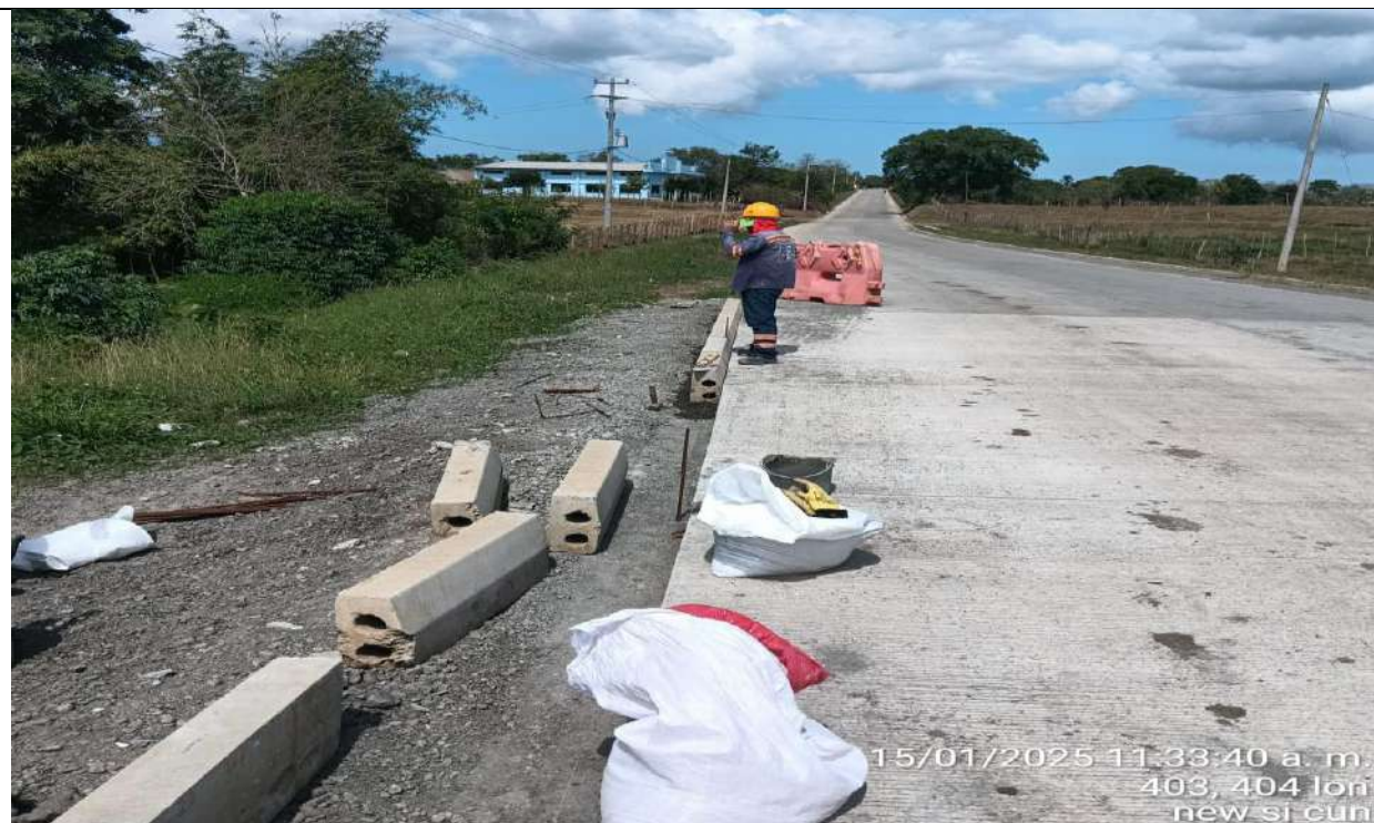
Instalación de bordillos del PR28+520 a mayores, lado izquierdo.
