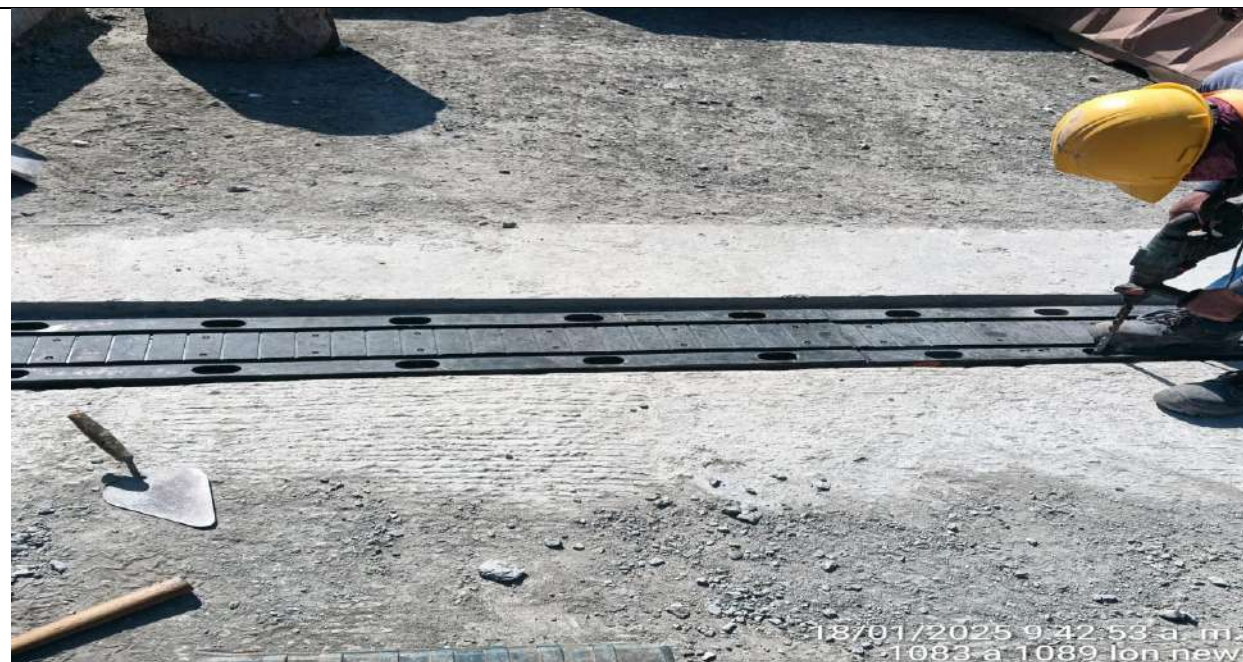
Puente PR45+300. Instalación junta de dilatación
