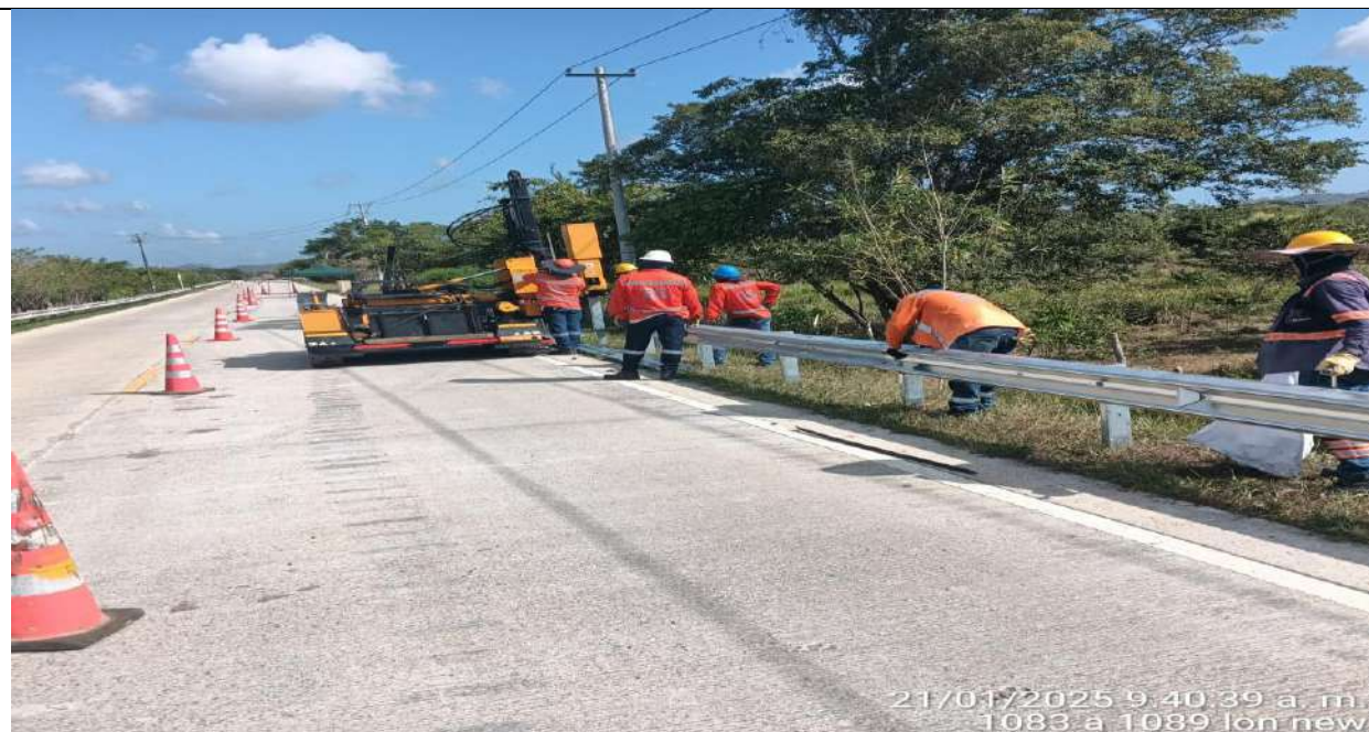
Instalación de defensas metálicas del PR20+250 a mayores, margen derecha.
