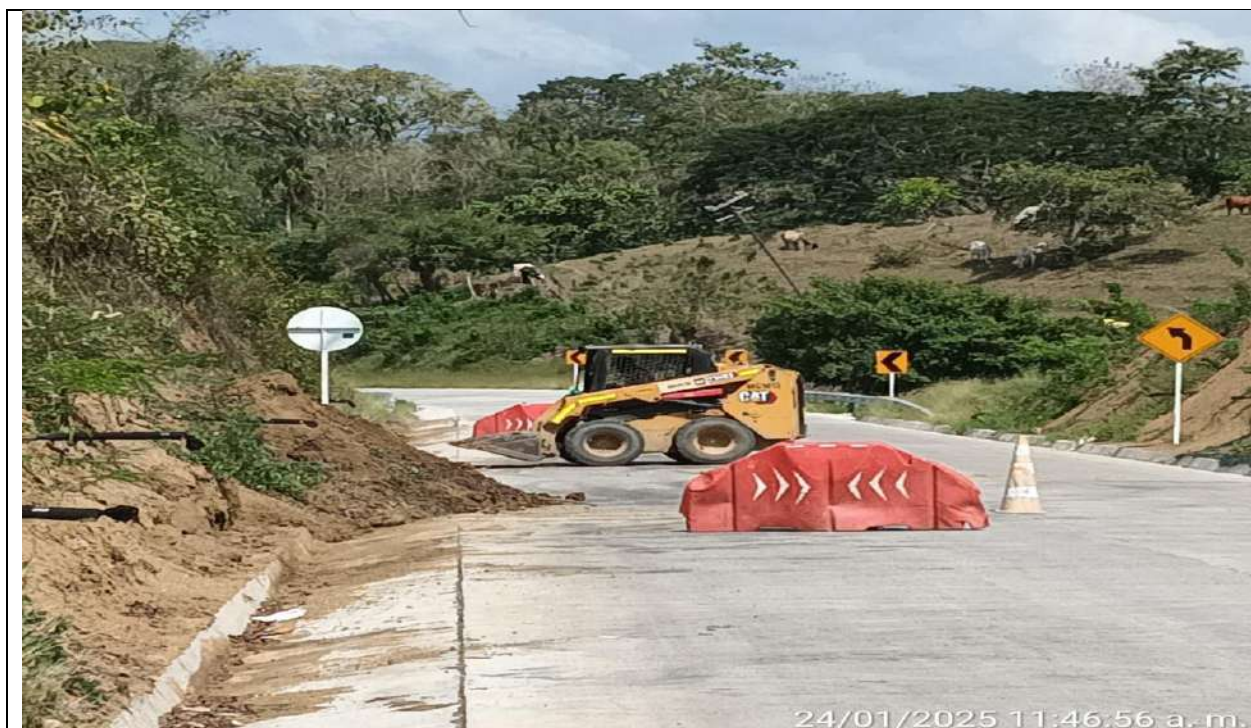
Limpieza de cuneta en el PR26+400 lado izquierdo.
