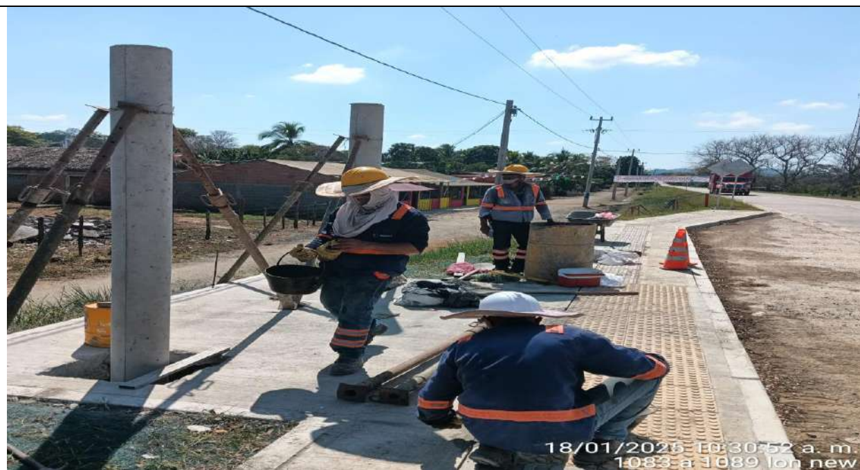
Instalación de columnas prefabricadas para soporte de cubierta en paradero de buses del PR23+220 lado derecho.
