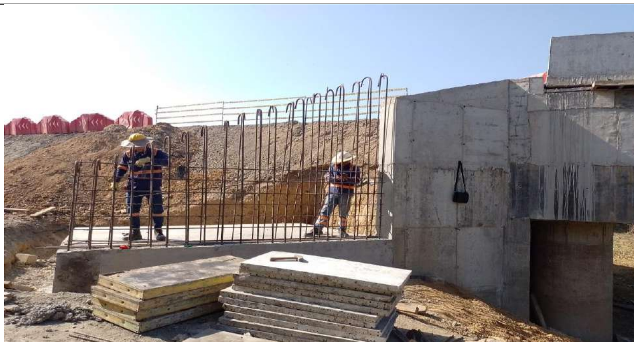
Puente PR34+500. Armado de acero para aleta muro de acompañamiento estribo 1 margen derecha.
