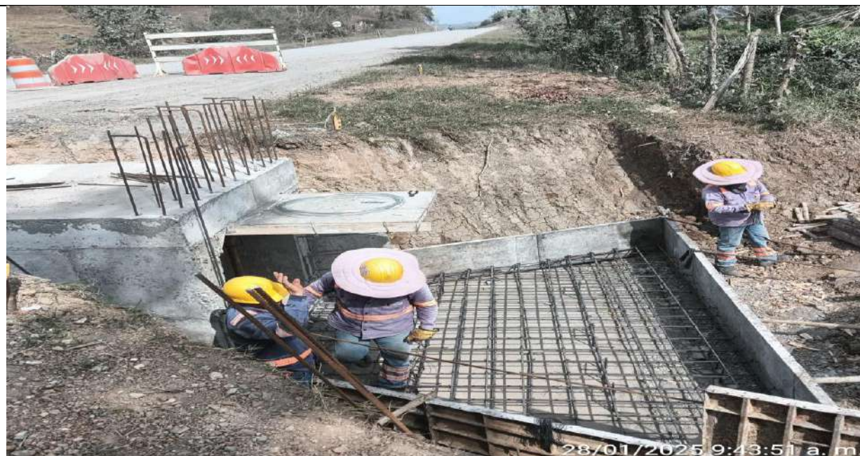
Box Culvert PR32+730 lado derecho. Instalación de acero losa entre aletas.
