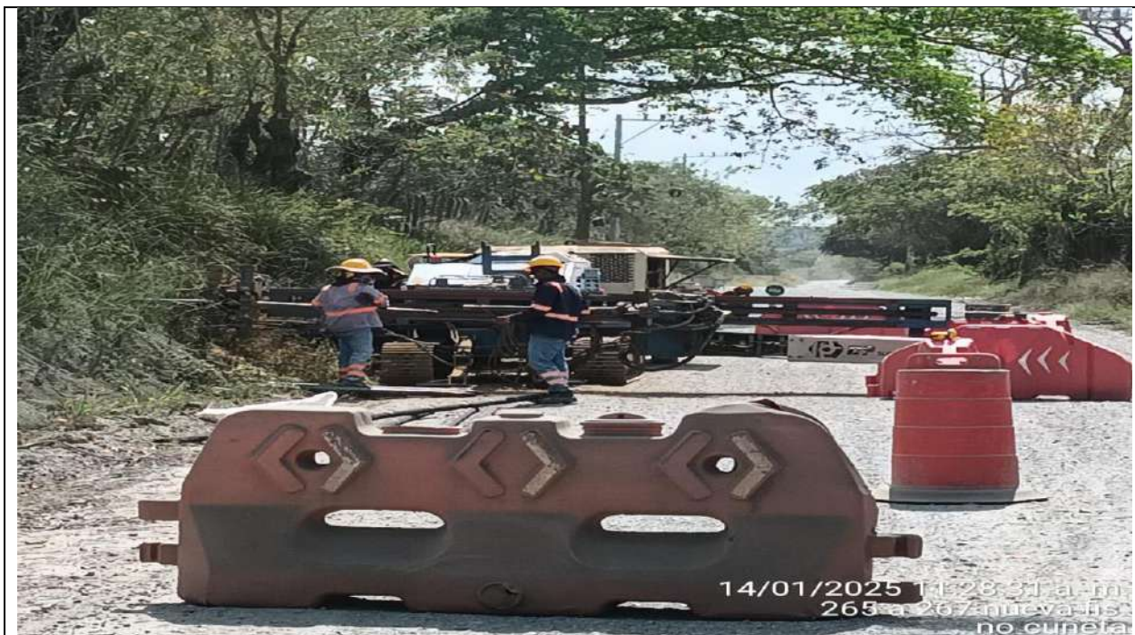
Instalación de drenes horizontales en talud del PR45+150 lado derecho.
