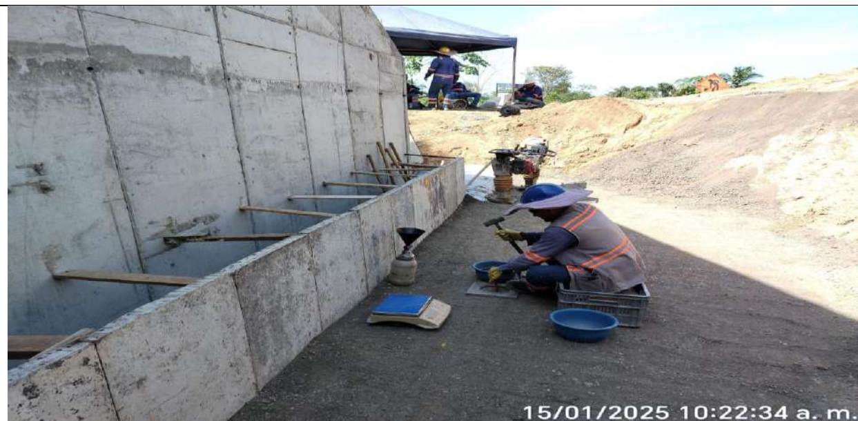
Puente PR34+500. Toma de densidades a material de afirmado.
