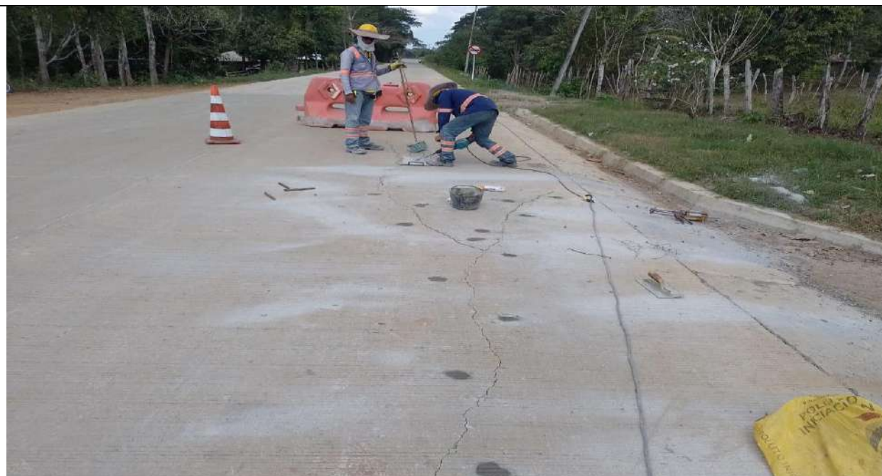
Reparación preventiva mediante método de costura cruzada entre el PR24+435 y el PR24+420 carril derecho.
