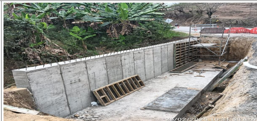
Fundida de módulos en el muro ubicado en el PR46+500 carril izquierdo.
