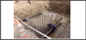
Instalación de acero de refuerzo en muro y losa inferior de box Culvert PR 42+400 carril derecho
