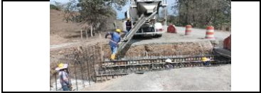
construcción de muros del box culvert del PR 32+700, lado izquierdo.
