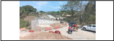
puente del PR 45+700 llenos con material de terraplén para construcción de losa de aproximación en los dos estribos.
