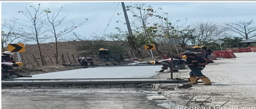
Fundida de pavimento MR-40 del PR30+030 a mayores carril derecho.
