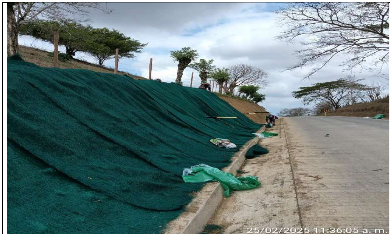
Instalación de manto TRM 500 del PR26+130 a mayores margen izquierda.
