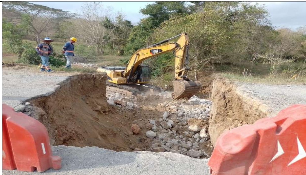
Box Culvert PR27+138 margen izquierda. Excavación para la construcción de ODT.
