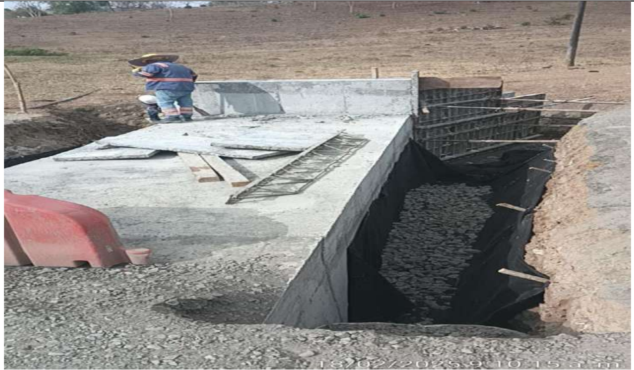
Box Culvert PR32+730 margen izquierdo. Construcción de filtros laterales.
