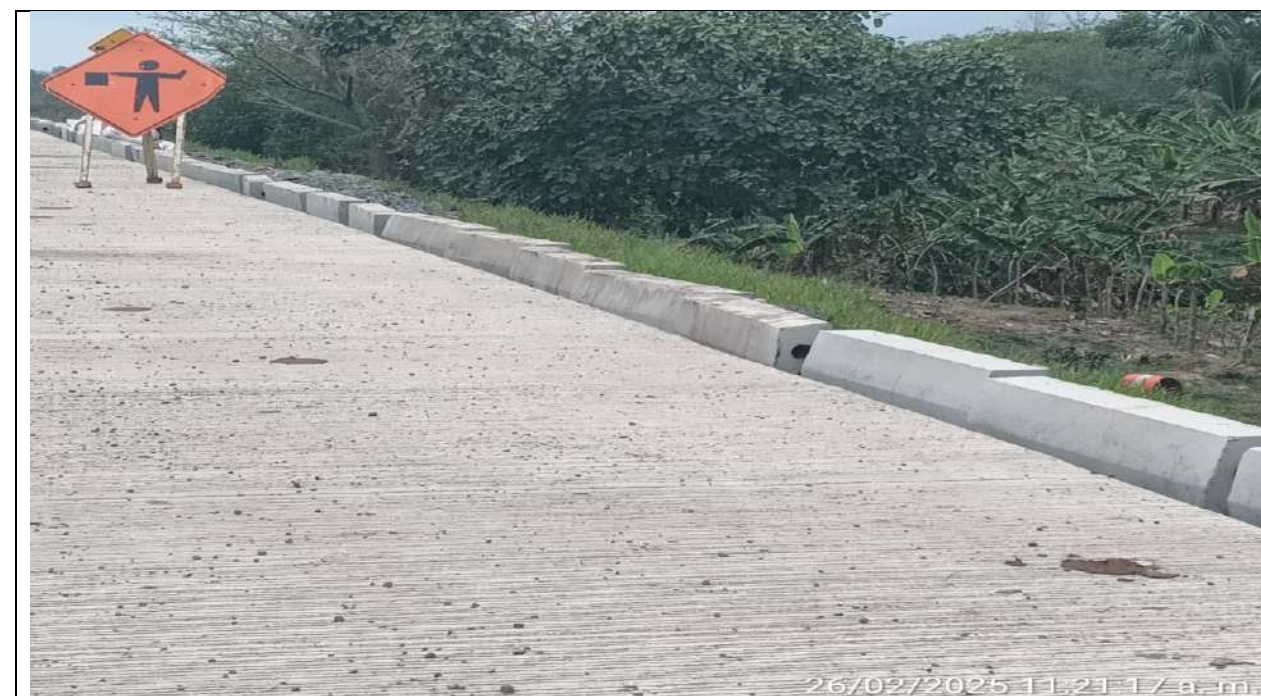
Instalación de bordillos del PR 34+480 a menores lado izquierdo.
