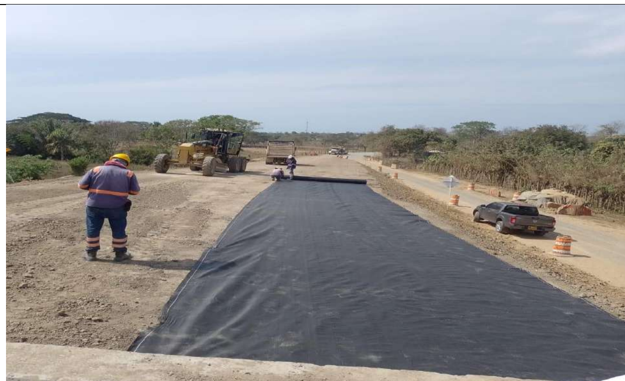
Instalación de geotextil T2400 y SBG en el PR34+555.
