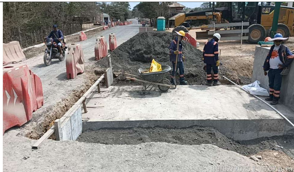
Box Culvert PR35+430 margen izquierdo. Lleno estructural con material de afirmado.
