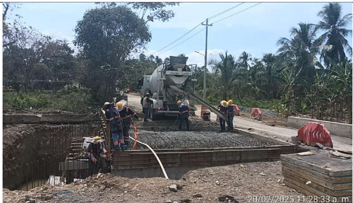
Box Culvert PR42+400 margen derecha. Fundida de losa superior.
