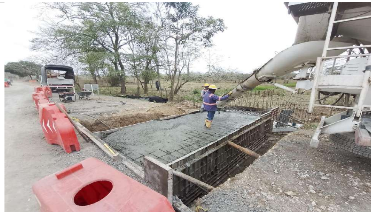
Box Culvert PR35+430 margen derecho. Fundida losa superior.
