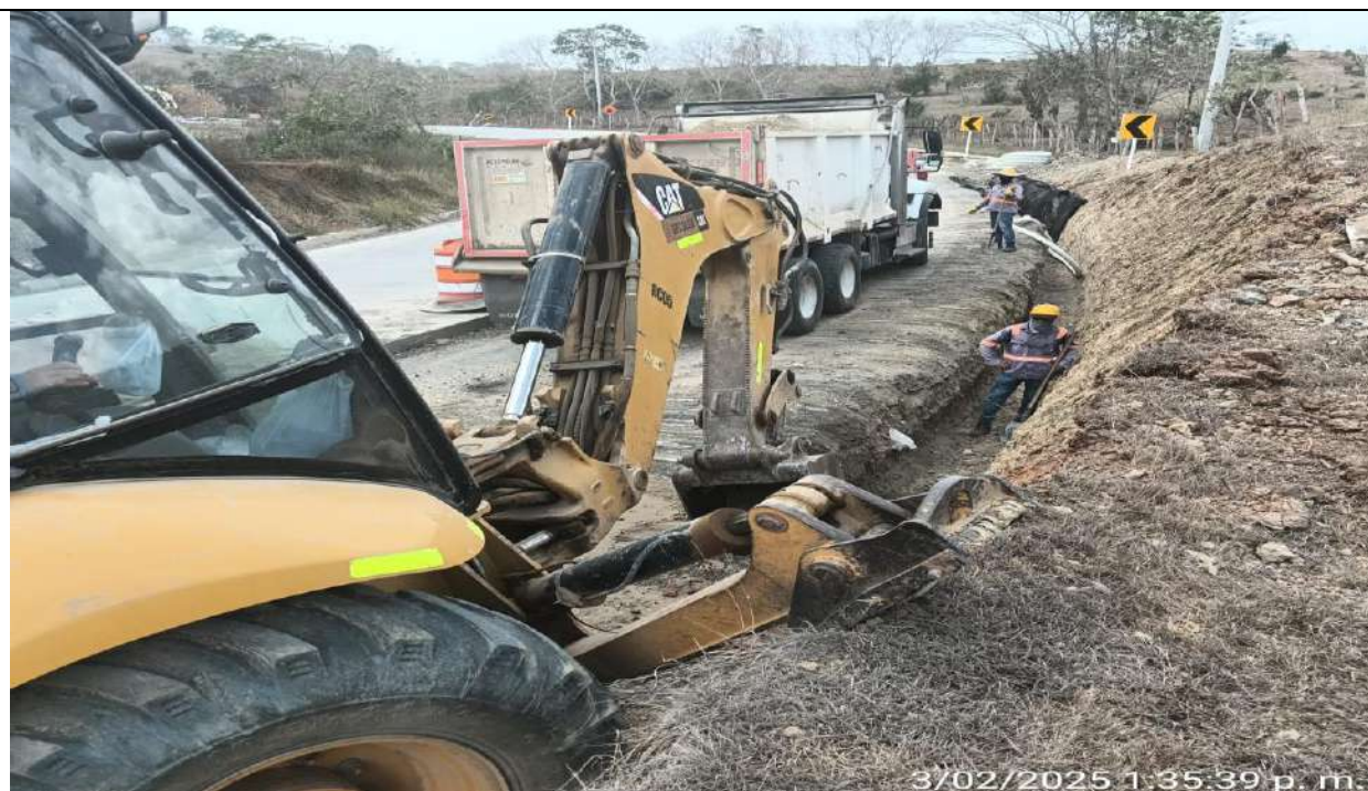
Construcción de filtro lateral en el PR30+070 lado derecho.
