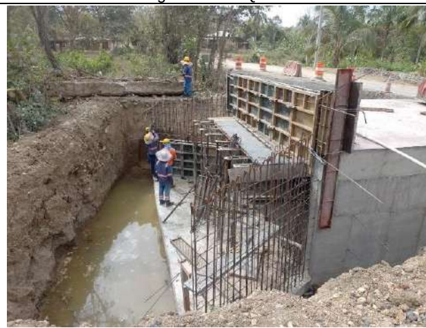
Foto 6. Construcción encofe ODT PR 42+400 LD
