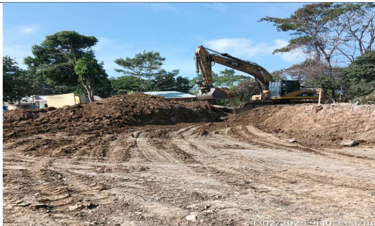
Puente PR45+700. Corte y conformación de terreno para adecuar acceso a vereda Membrillal.
