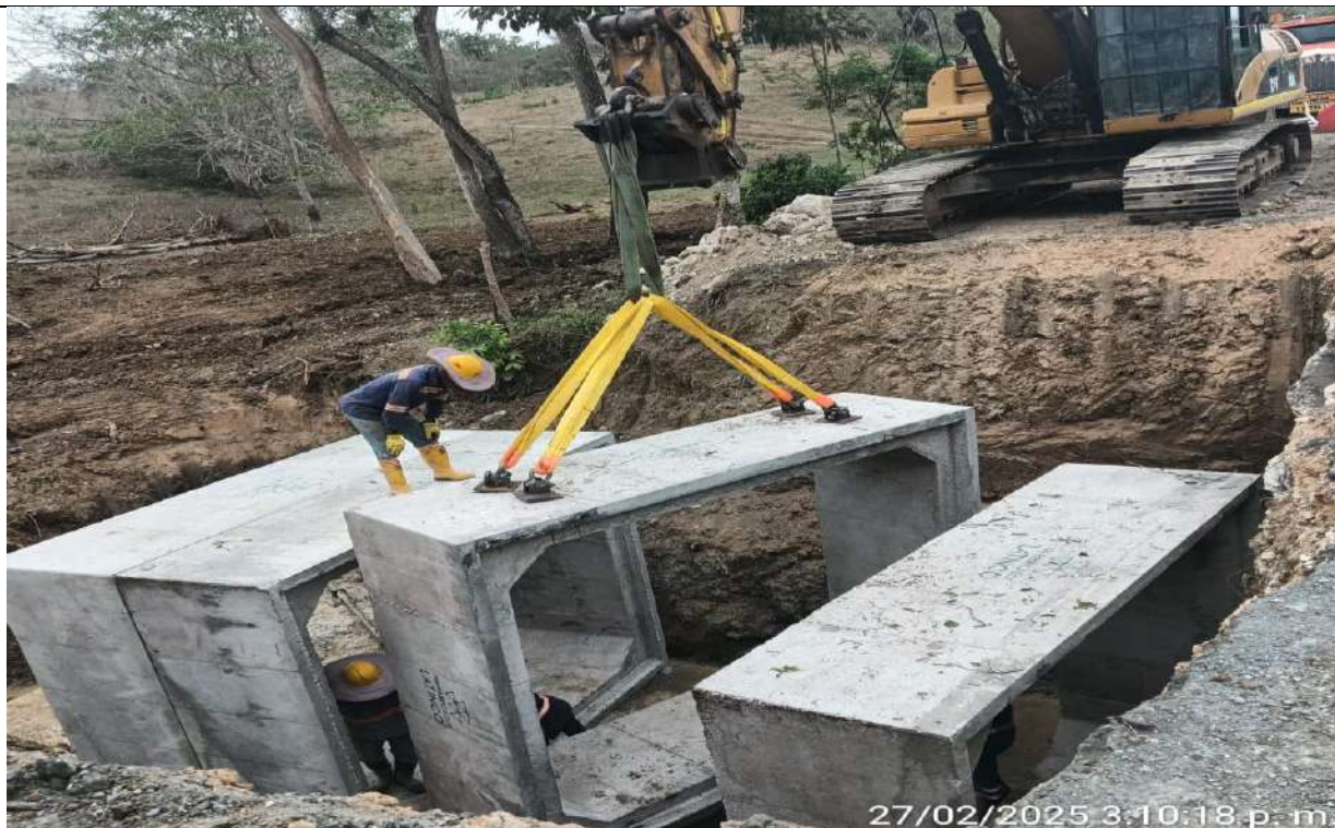
Box Culvert PR25+730 margen izquierda. Instalación de módulos de box Culvert prefabricado.
