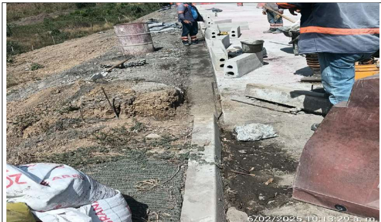
Instalación de bordillos del PR30+180 a mayores lado izquierdo.
