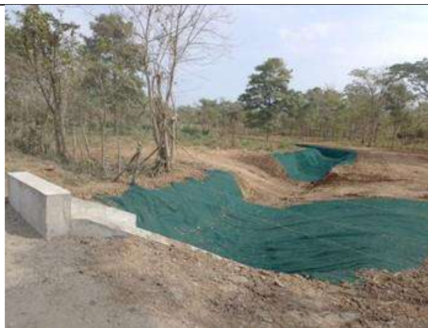
Foto 1. Instalacion geomanto canal en descole ODT PR 32+730
