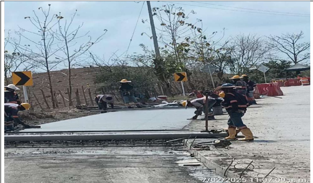
Fundida de pavimento MR-40 del PR30+030 a mayores carril derecho.
