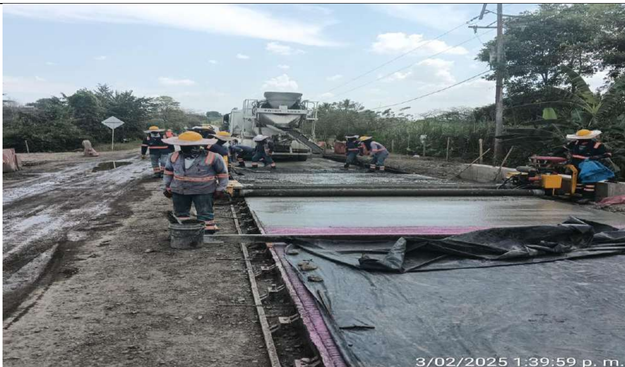
Fundida de pavimento MR-40 del PR28+212.3 a menores, carril izquierdo.
