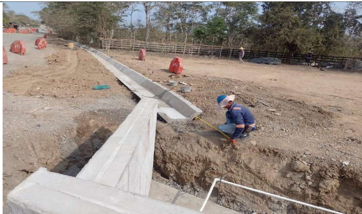
Alcantarilla PR35+340 margen derecha. Descole cuneta trapezoidal.
