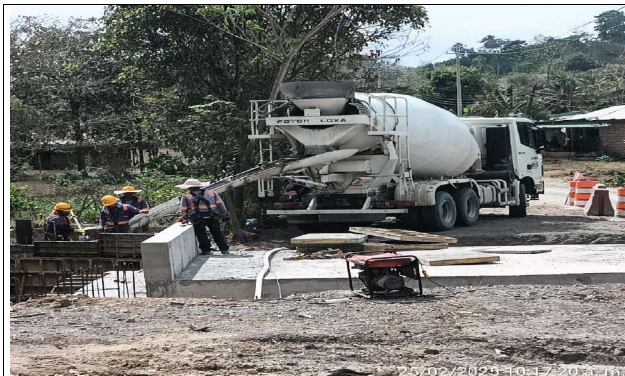
Box Culvert PR42+400 margen derecha. Fundida de aletas.
