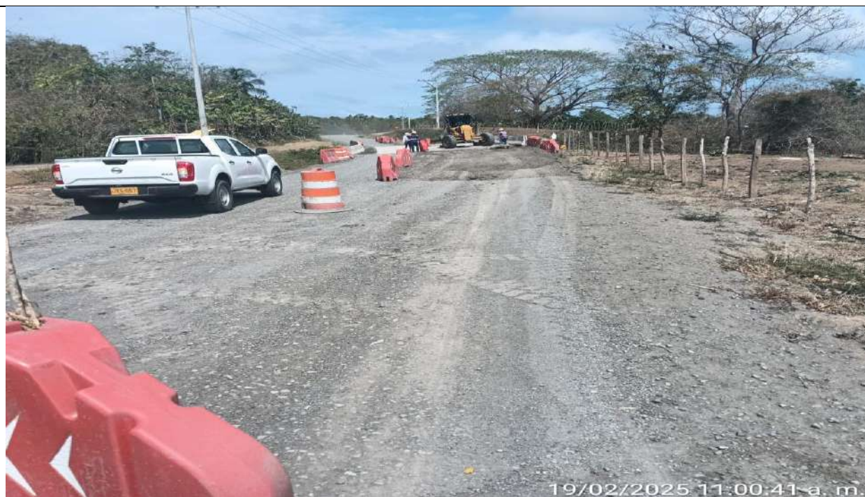
Cereo de subbase del PR45+285 al PR45+305 calzada- sur puente.
