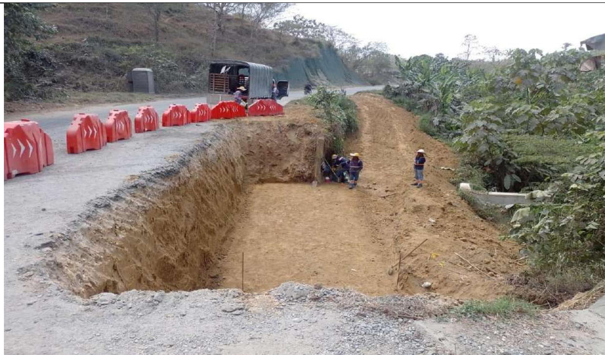
Muro PR46+500 carril izquierdo. Excavación lateral.
