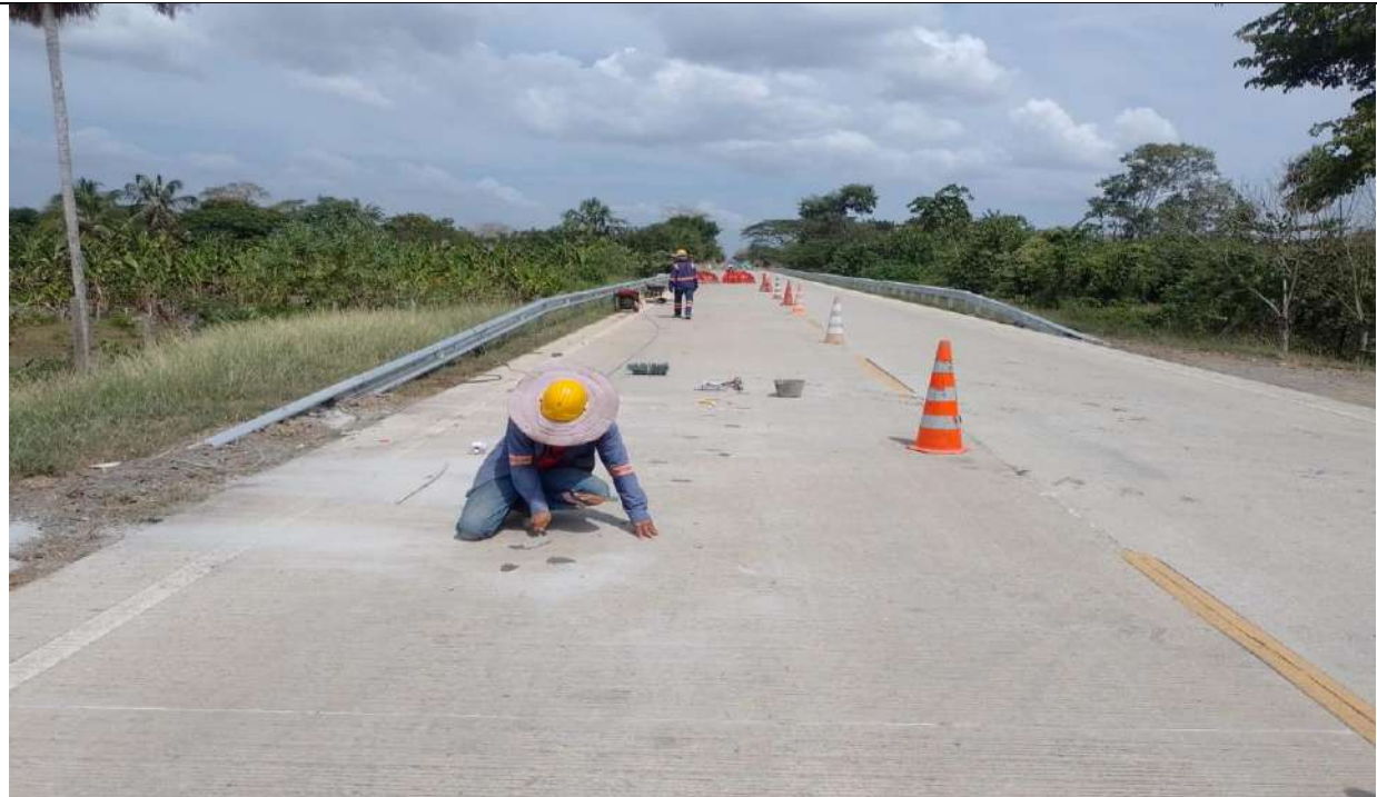
Reparación módulos de pavimento MR-40 por método de costura cruzada en el PR17+500 carril izquierdo.
