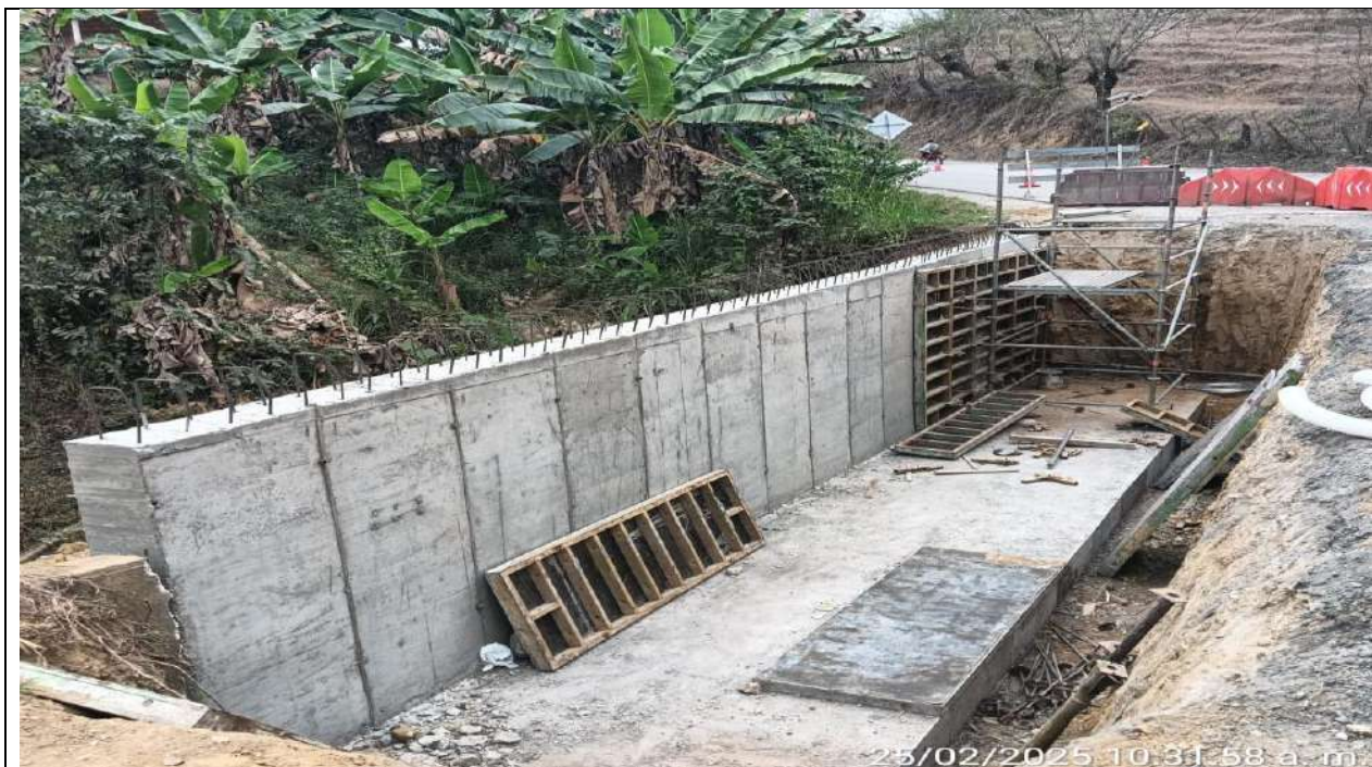
Muro PR46+500 carril izquierdo. Fundida de modulo 2.
