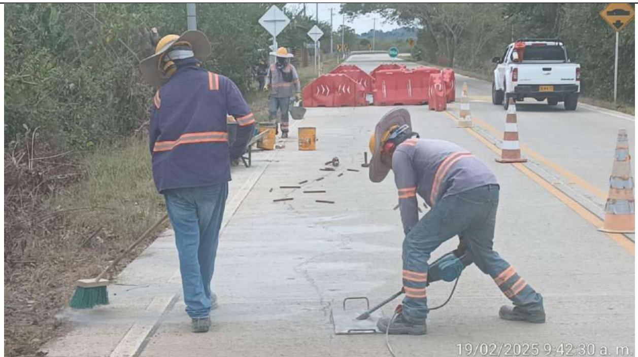
Reparación módulos de pavimento MR-40 por método de costura cruzada del PR22+714 al PR22+750 carril derecho.
