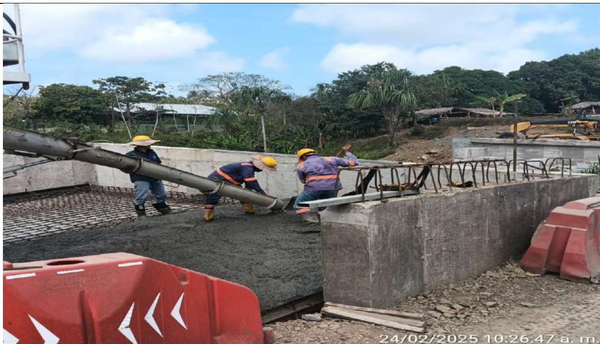
Losa de aproximación estribo 1 puente PR45+700.
