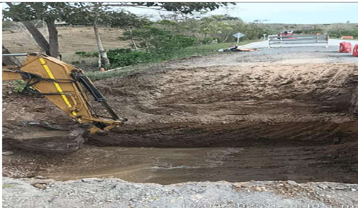
Box Culvert PR25+730 margen izquierda. Se realizan actividades de excavación.
