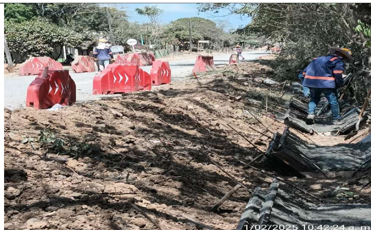
Construcción de cuneta trapezoidal del PR35+428 a menores lado derecho.
