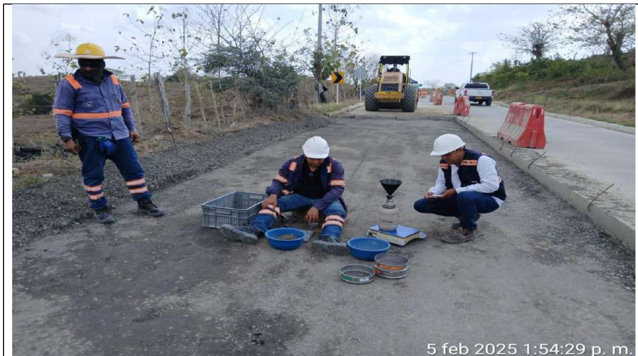
Toma de densidades y verificación de espesores en tramo de SBG PR30+030 al PR30+104 carril derecho.
