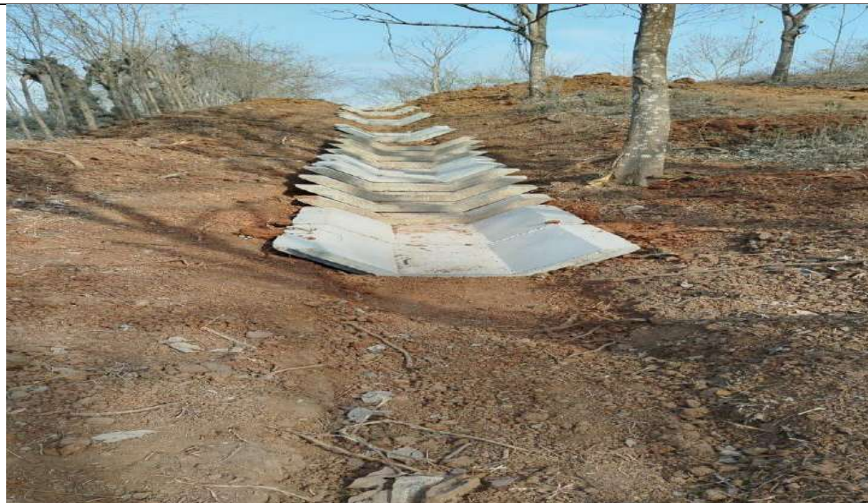
Instalación de zanja de coronación en el PR32+020 a mayores margen derecha.
