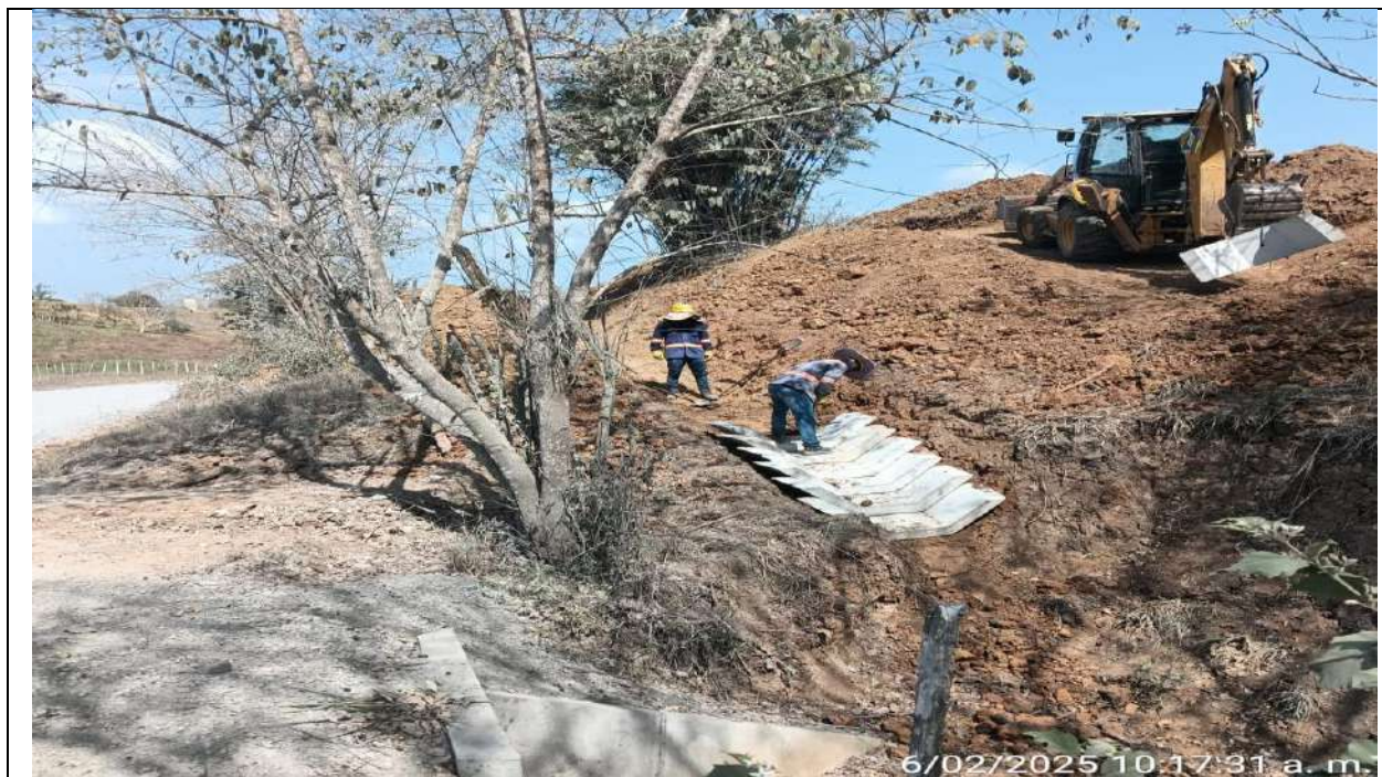
Instalación de zanja de coronación en el PR31+800 a mayores margen derecha.
