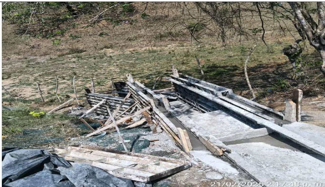
Fundida de muros disipador del PR26+280 lado derecho.
