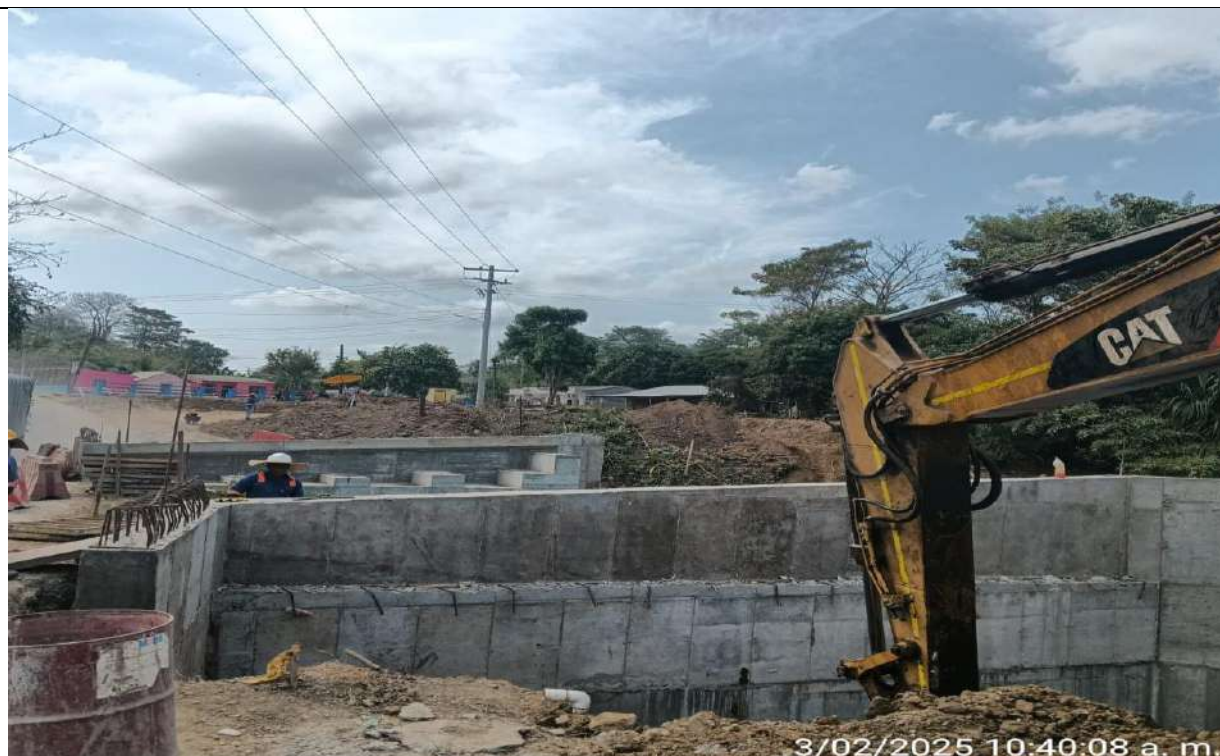
Puente PR45+700. Se adecua terreno en el estribo 2 para construcción de filtro lateral.
