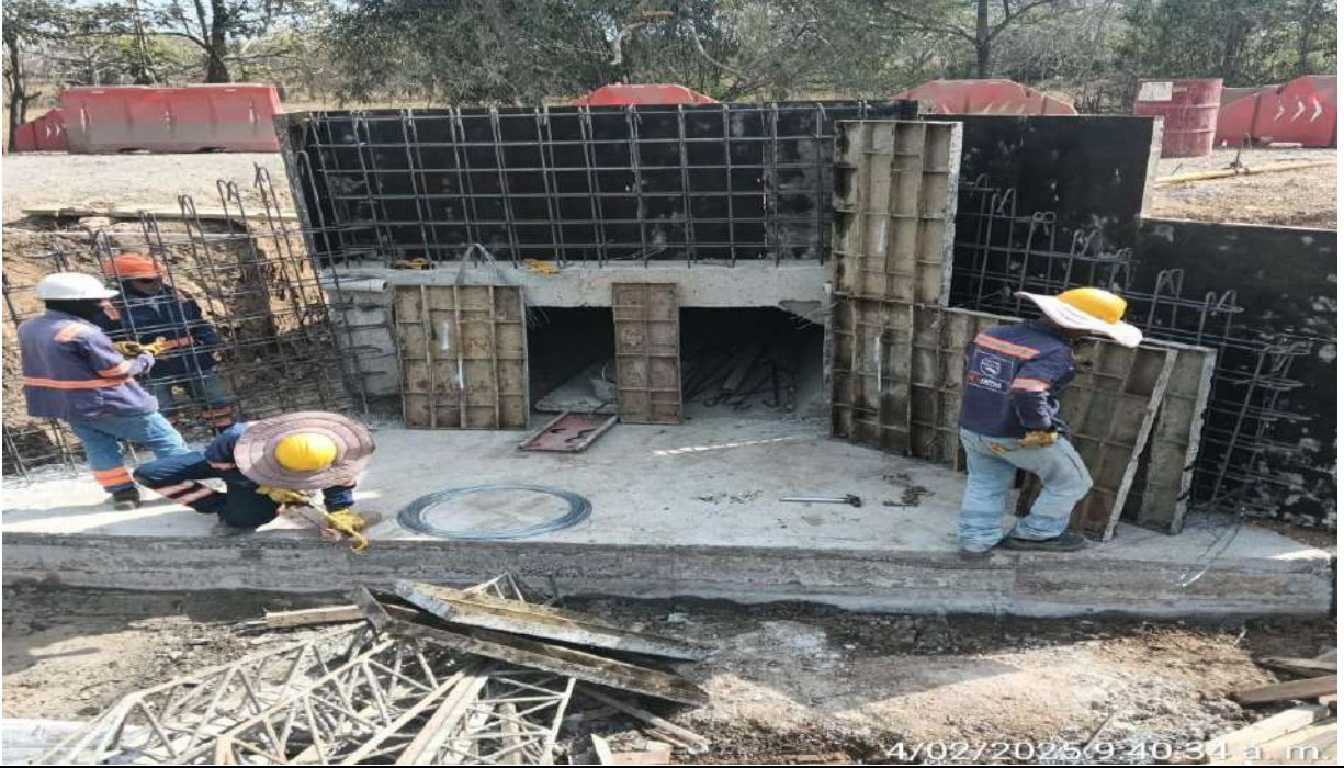
Box Culvert PR35+430 margen izquierdo. Instalación de formaleta para fundida de aletas y muro guarda ruedas.
