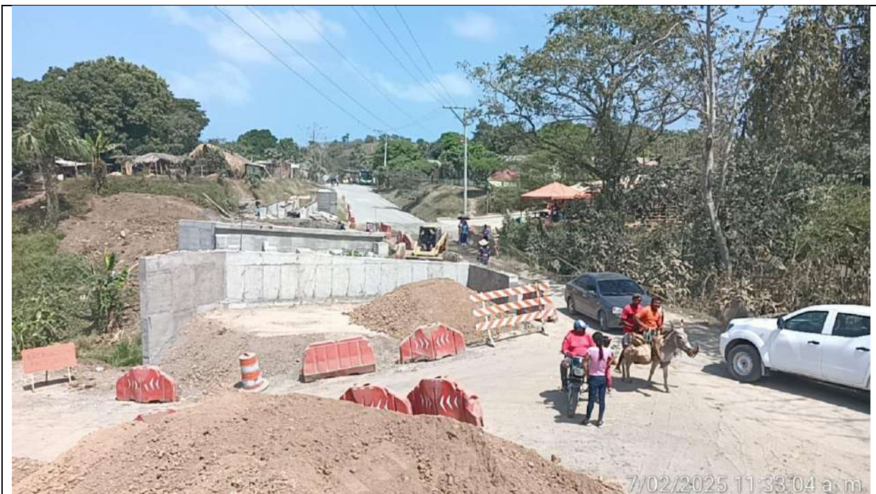
Puente PR45+700. Llenos con material de terraplén para construcción de losa de aproximación en estribo 1 y 2.
