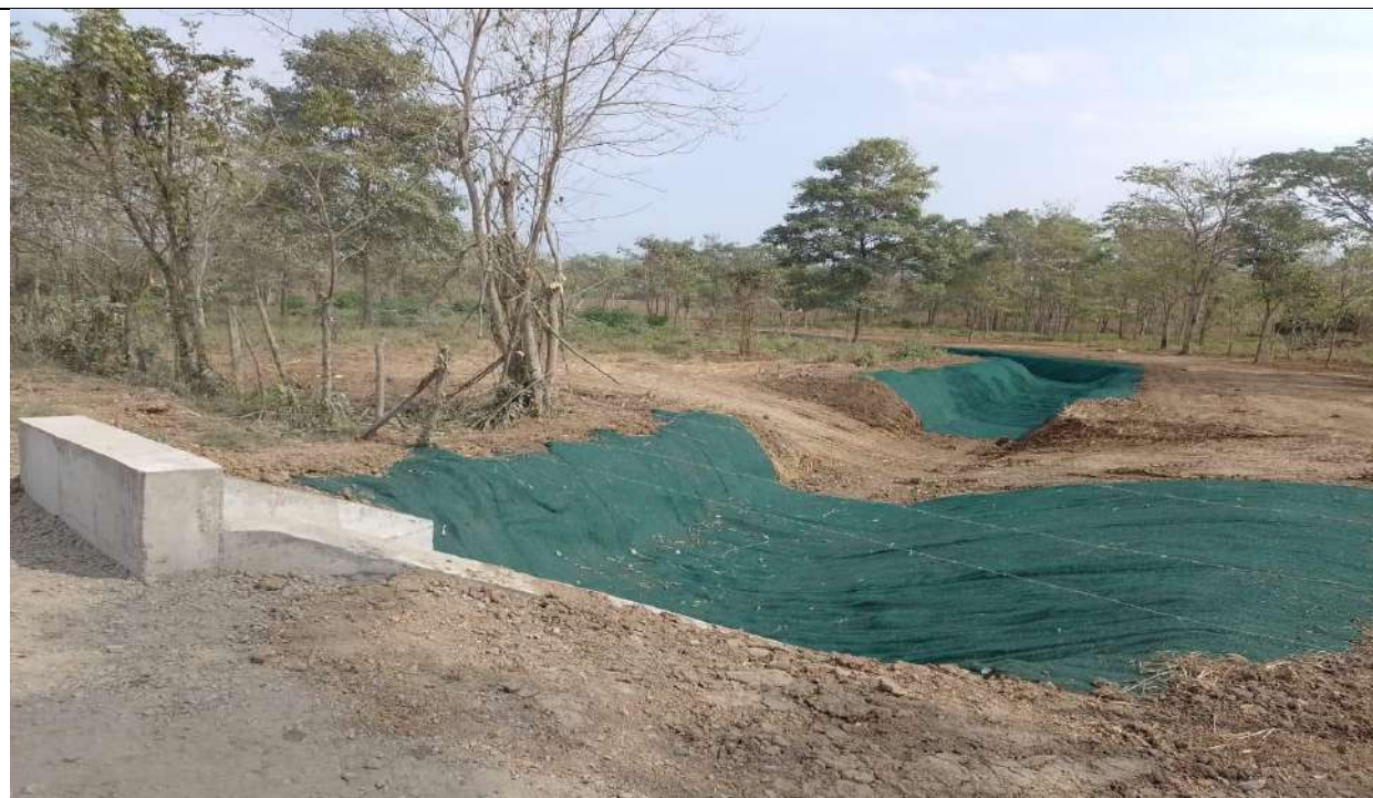
Box Culvert PR32+730 margen derecha. Protección de descole con manto TRM 500.
