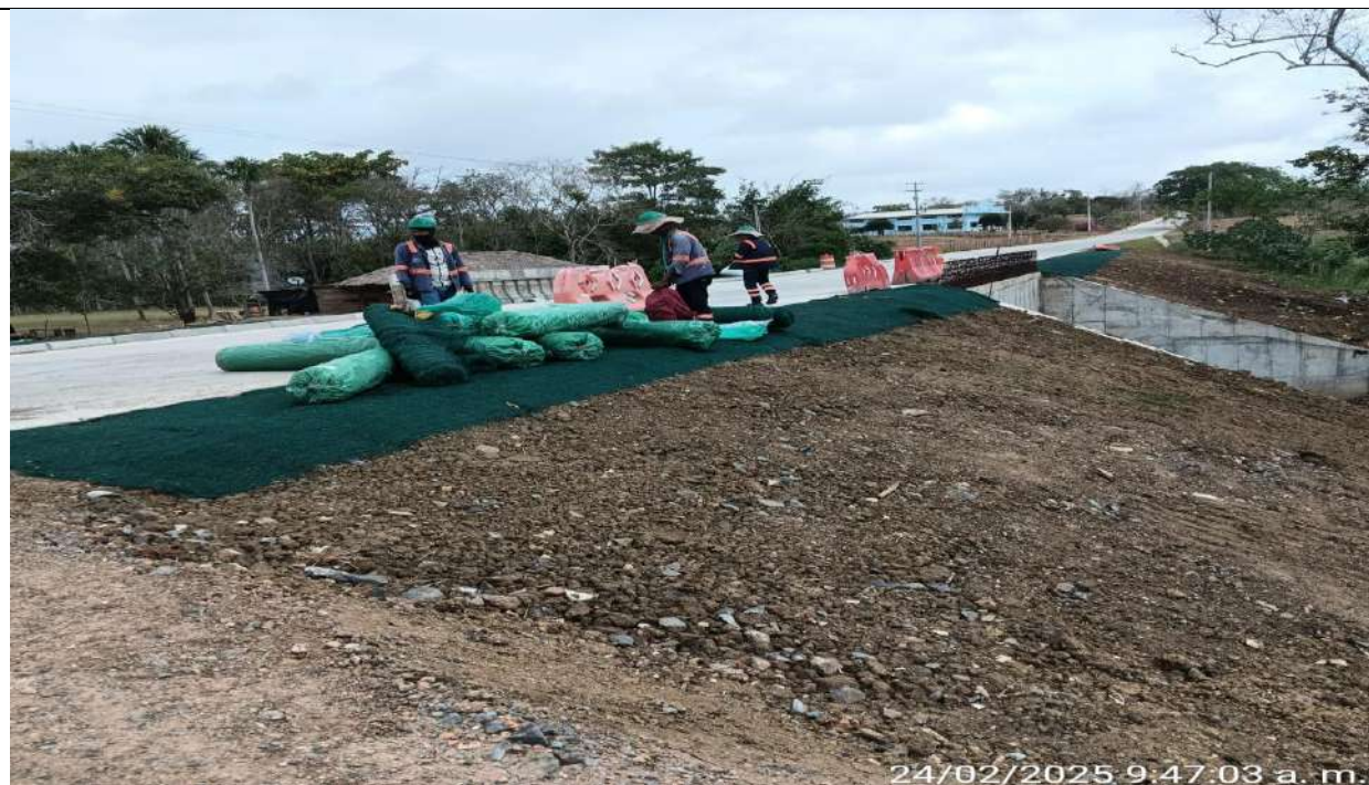
Instalación de manto TRM 500 del PR28+500 a menores margen derecha.
