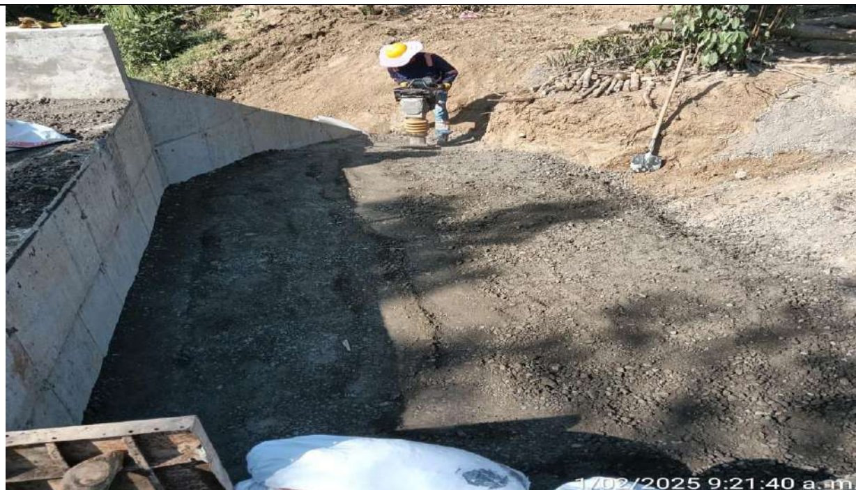
Box Culvert PR42+400 margen izquierdo. Lleno estructural sentido norte.
