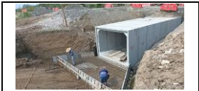
Box prefabricado PR 25+730 Instalación de para construcción de losa entre aletas lado derecho
