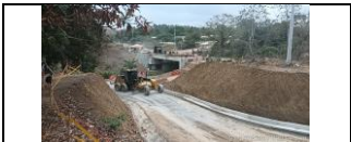
Acceso a vereda Membrilal del PR 45+630 lado izquierdo - instalación de afirmado mezclado con cal
