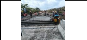
PR 34+530 Construcción módulos en concreto MR40 en el carril izquierdo aproches Regino
