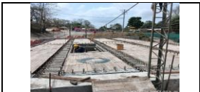
Instalación de obra falsa para construcción de losa del puente PR 45+700
