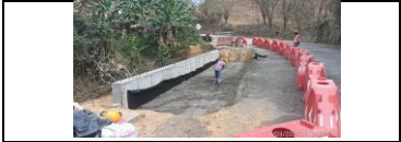
rellenos en afirmado muro PR46+500 lado izquierdo
