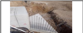
Box prefabricado PR 27+138 carril derecho, construcción de losa entre aletas
