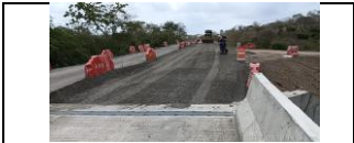
cereo de subbase del PR 34+490 carril izquierdo
