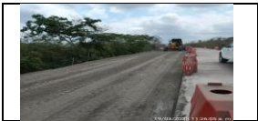
Cereo subbase PR33+530 al PR34+460 carril derecho
