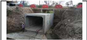
Instalación de módulos prefabricados para construcción de Box culvert lado izquierdo del PR 25+730
