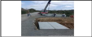
instalación de módulos prefabricados box PR 27+138, lado izquierdo.
