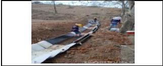
PR31+200 lado derecho construcción de zanjas de coronación
