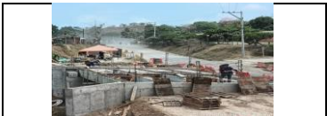
Puente del PR 45+700 desencofrado riostras de estribo 1
