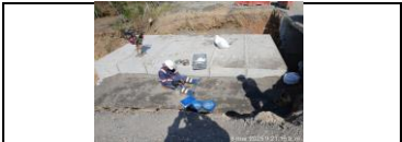
lleno estructural con material de afirmado box culvert PR27+138 carril izquierdo
