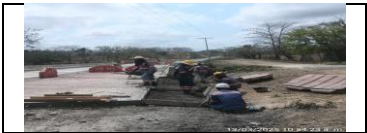
Instalación de formaletas para cuentas PR45+315 lado izquierdo
