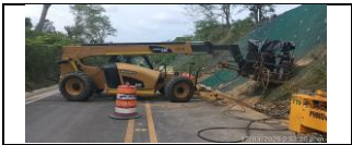
Instalación de pernos (control erosión) en el PR4+570 lado derecho
