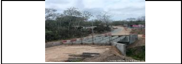
puente PR45+700 izaje de vigas
