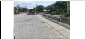
Instalación de defensas metálicas en el PR 16+270 lado izquierdo
