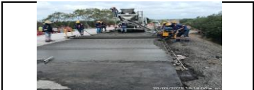
Construcción módulos MR40 PR 34+485 a mayores carril derecho.
