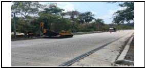
Instalación de defensas metálicas en el PR24+466 lado derecho
