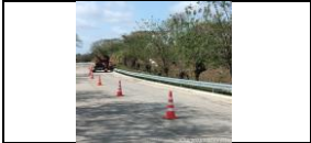
instalación de defensas metálicas PR11+700
