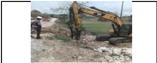
demolición de box culvert lado derecho PR25+730
