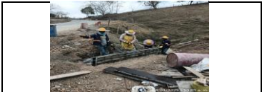
construcción de dissipador en el PR 31+555, lado izquierdo
