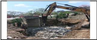
Demolición de box coulvert existente PR27+138 lado derecho
