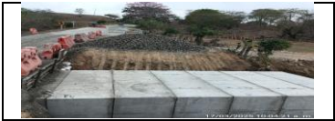
Instalación de módulos prefabricados Box Culvert PR27+138 lado derecho
