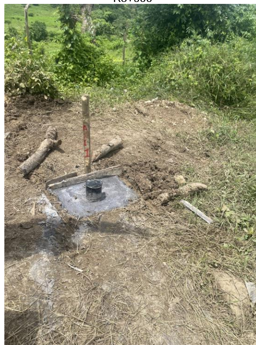
Fotografía 2. Localización Inclinómetro 1 en ladera, K8+500
