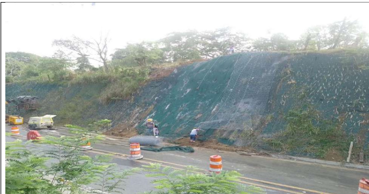
Instalación de malla triple torsión para la protección y estabilización de taludes PR4+580 al PR4+592 margen derecha.
