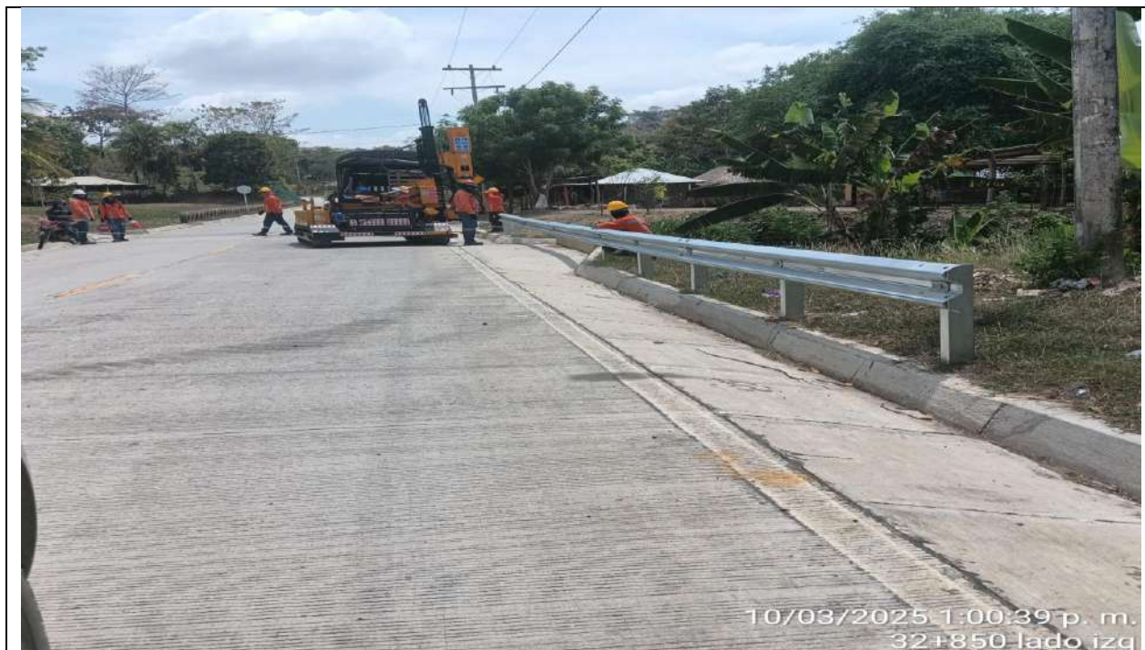
Instalación de defensas metálicas del PR16+270 a mayores lado izquierdo.
