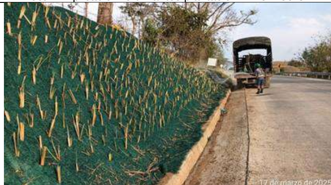
Foto 3. Riego Pasto Vetiver PR 27+700 CD
