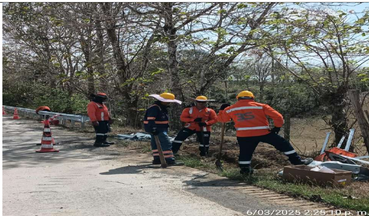
Instalación de defensas metálicas del PR13+450 lado izquierdo.
