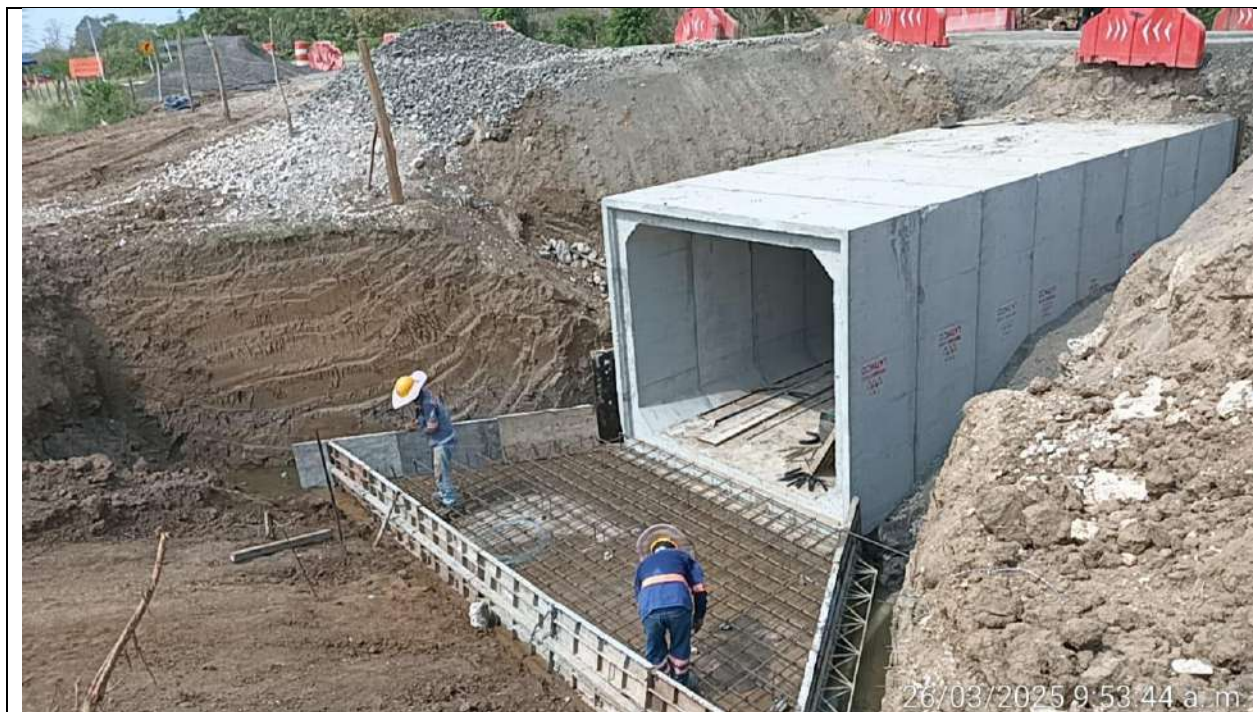
Box Culvert PR25+730 carril derecho. Instalación acero de losa entre aletas.
