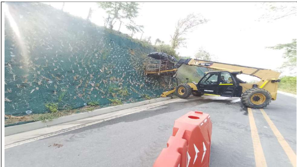
Perforación e instalación de anclaje en zona de protección de taludes PR 4+604 al PR 4+624 margen derecha.
