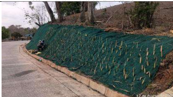
Foto 6. Instalación Pasto Vetiver PR 27+700 CD
