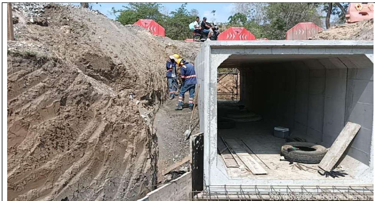
Box Culvert PR25+730 carril derecho. Llenos con material de afirmado en muro sur.
