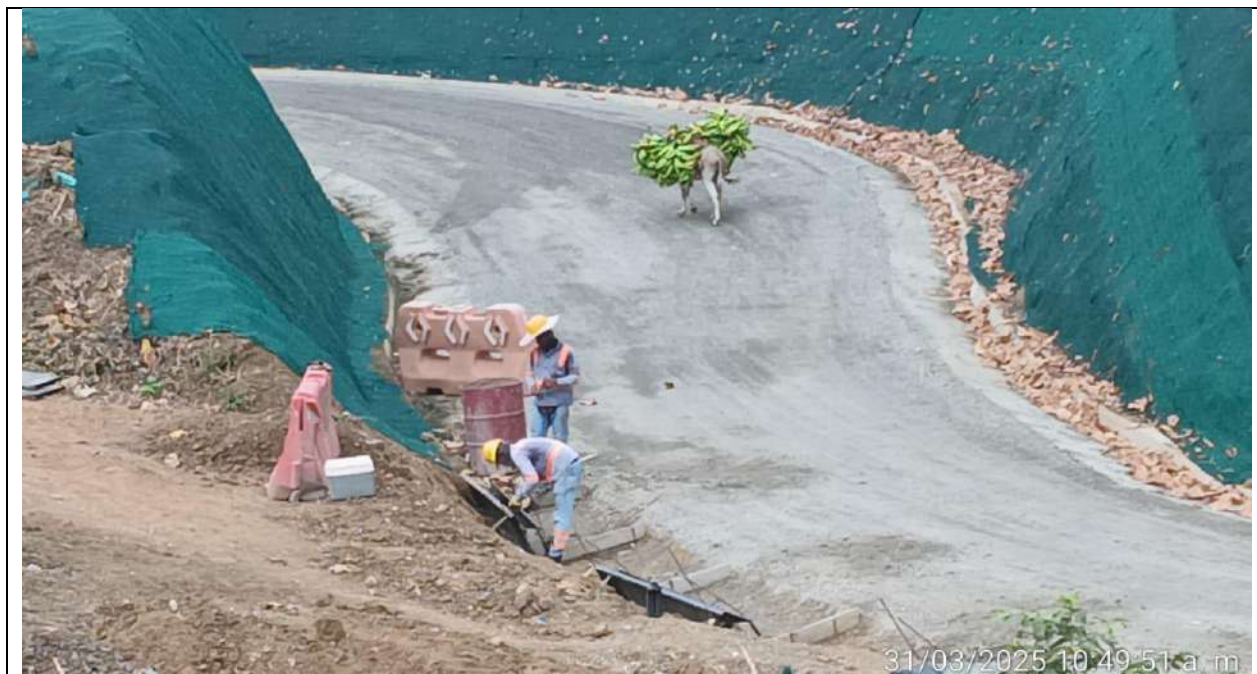
Instalación de formaletas para cunetas en acceso a vereda Membrillal, PR 45+650 Marge izquierda.
