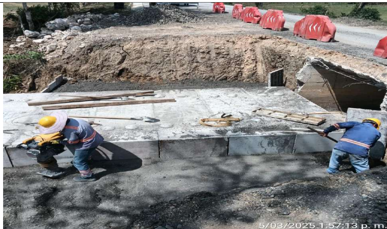
Box Culvert PR25+730 carril izquierdo. Lleno estructural con material de afirmado.
