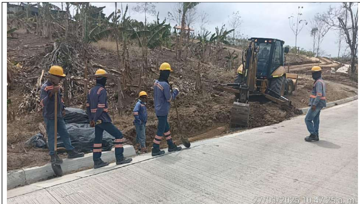
Conformación de terreno para acceso a predio en el PR 31+050 lado derecho.
