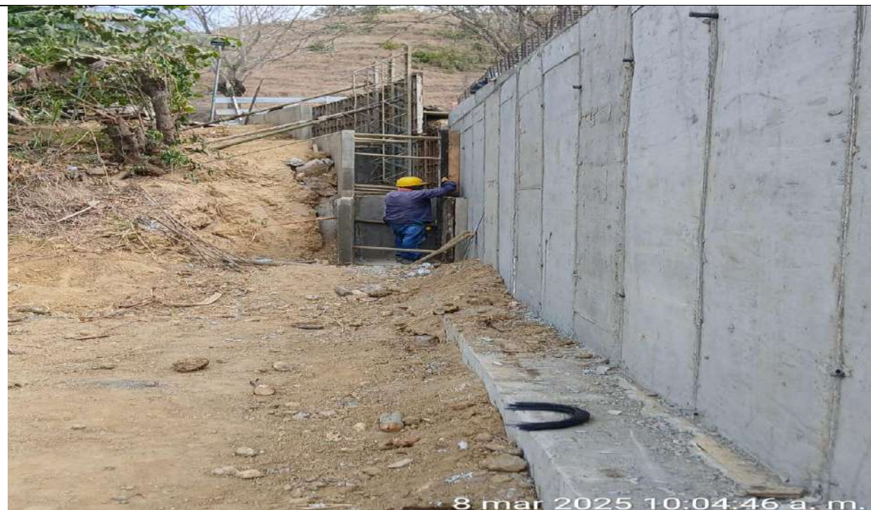
Instalación de formaletas para muro dissipador en el PR46+506 lado izquierdo.
