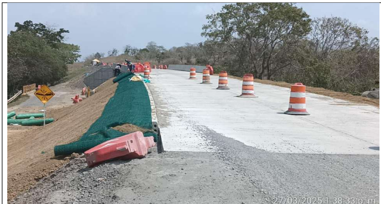
Protección de taludes con manto TRM500 en norte puente Regino, PR 34+560 lado derecho.
