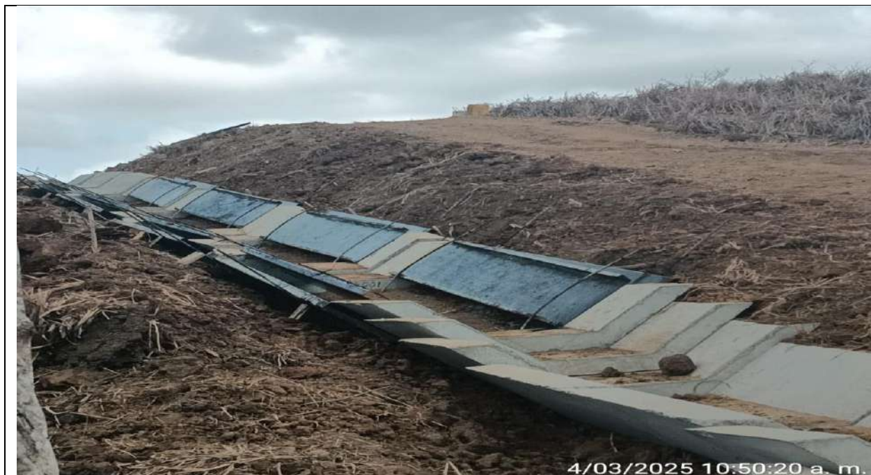
Instalación de zanja de coronación en el PR32+260 lado derecho.
