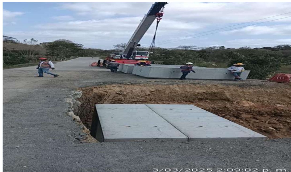
Box Culvert PR27+138 carril izquierdo. Izaje de módulos prefabricados.
