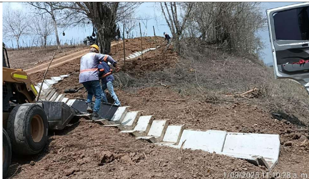
Instalación de zanja de coronación en el PR32+900 lado izquierda.
