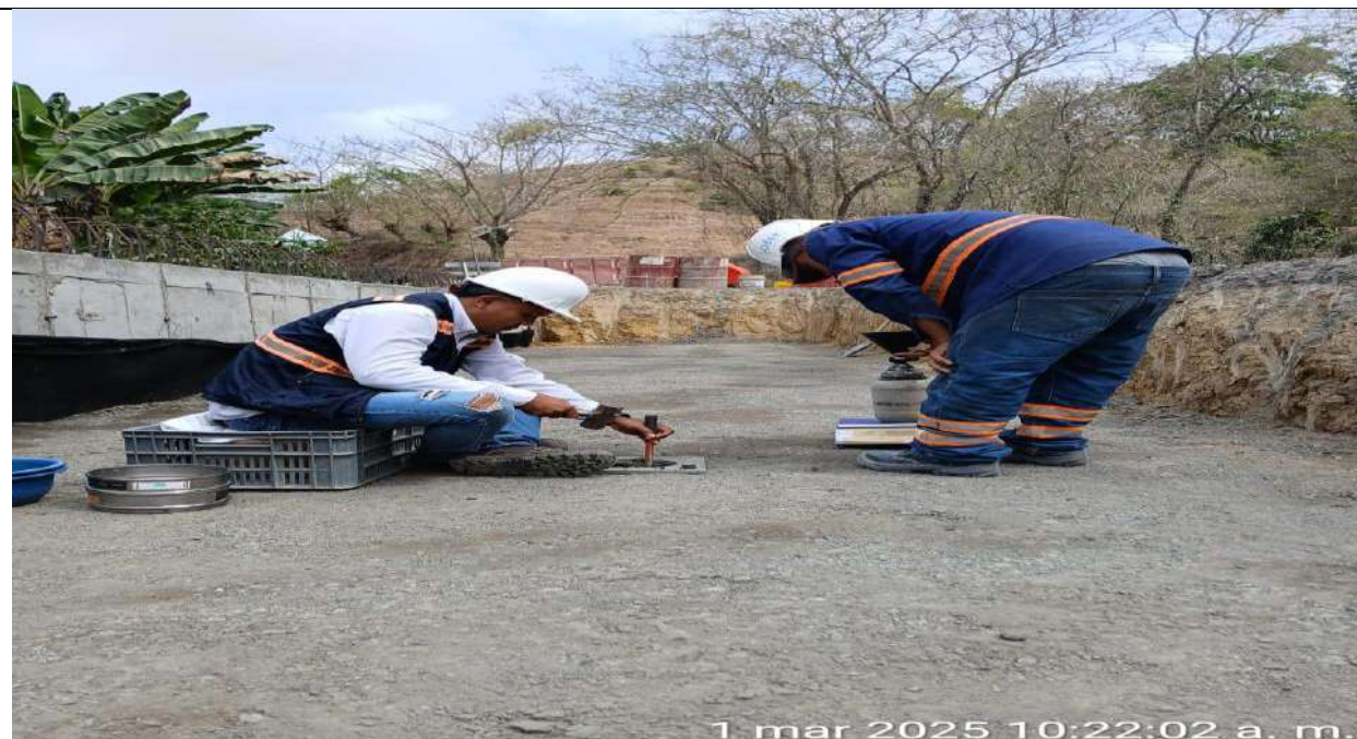
Muro PR46+506 lado izquierdo. Toma de densidades material de afirmado.
