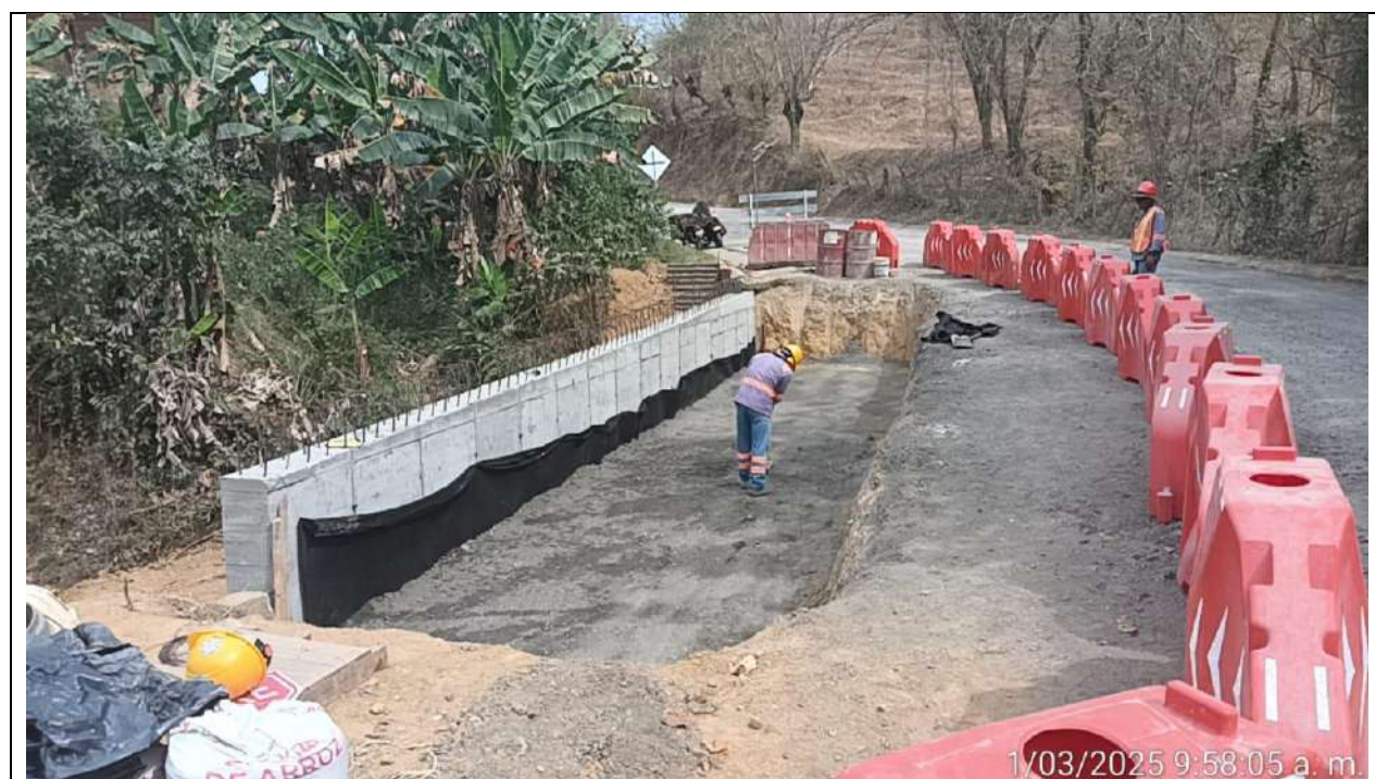
Muro PR46+506 lado izquierdo. Lleno con material de afirmado.
