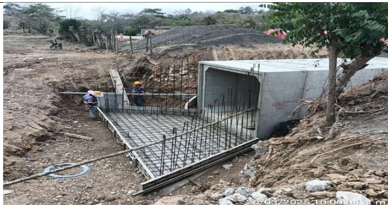
Box Culvert PR27+138 carril derecho. Instalación acero losa entre aletas y formaletas para aletas.
