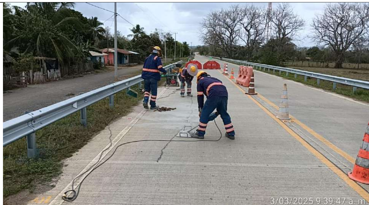
Reparación provisional de losas afectadas mediante método de costura cruzada en el PR23+165 carril derecho.
