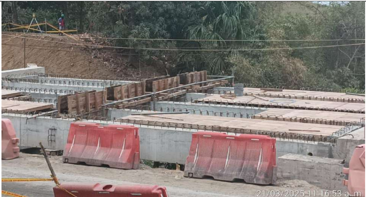
Puente PR45+700. Instalación de formaletas para fundida de riostra intermedia.
