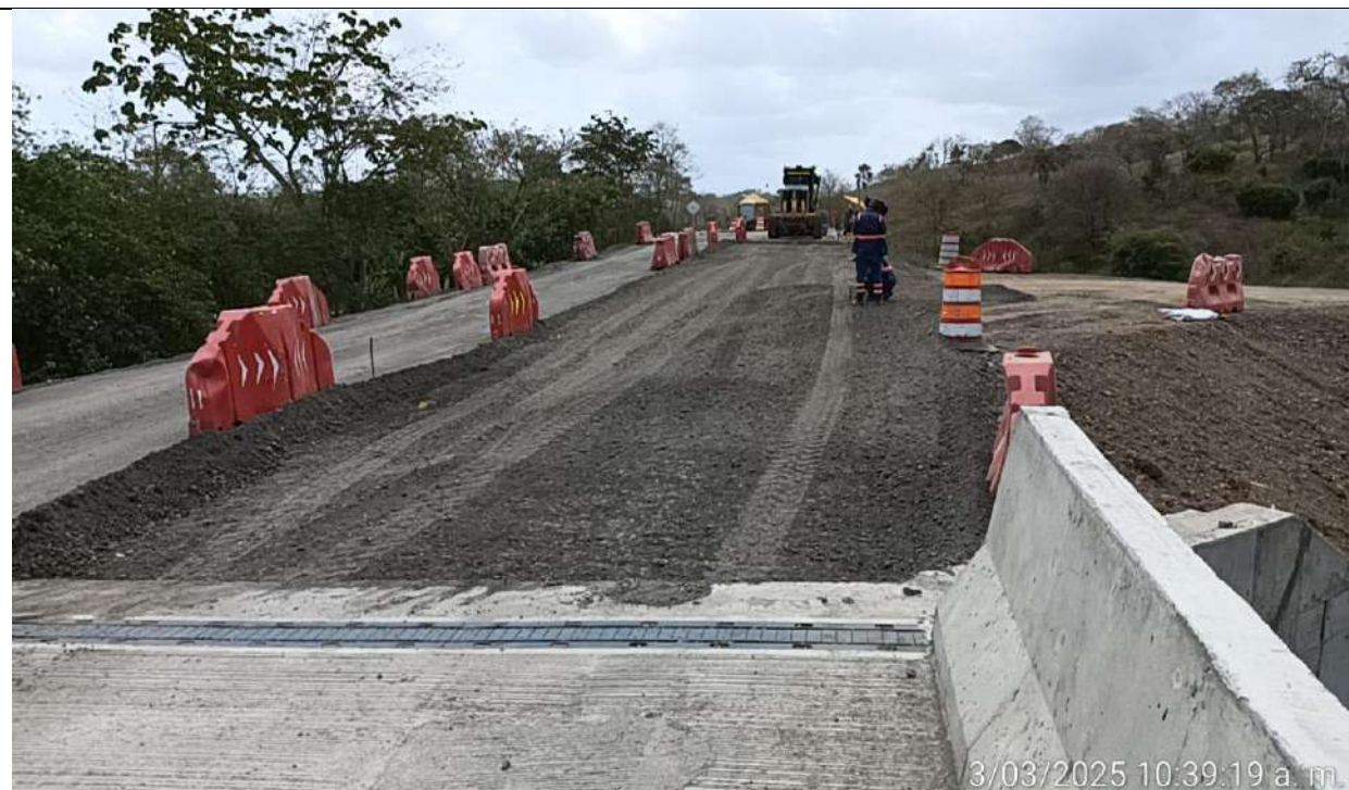
Cereo de subbase granular del PR 34+490 al PR34+530 carril izquierdo.
