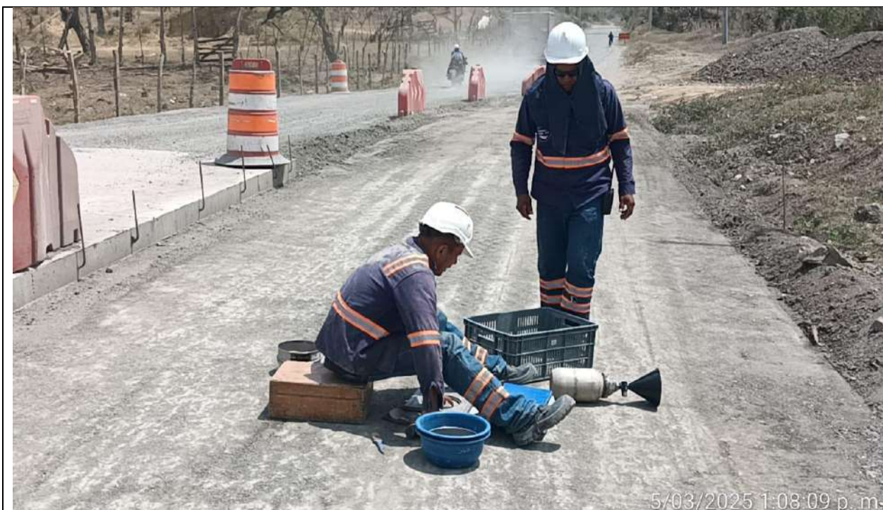
Toma de densidades subbase granular en el PR45+315 carril izquierdo.
