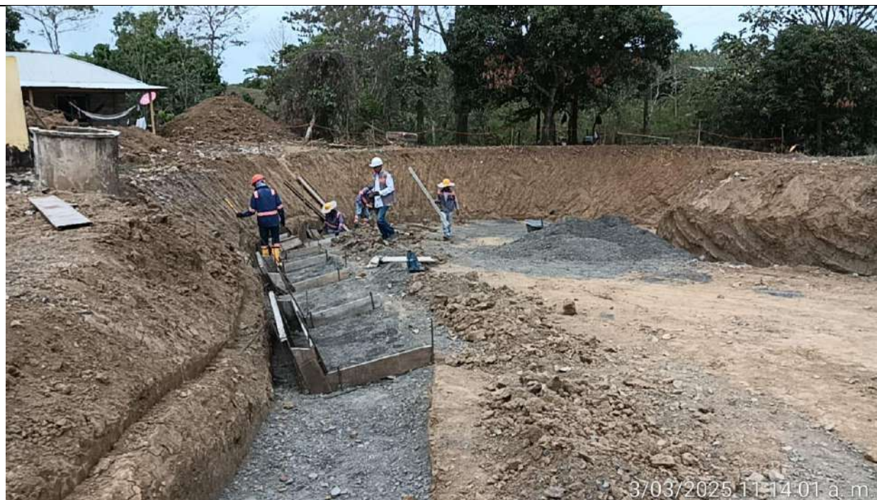
Subbase granular y formaletas para construcción de cunetas en el acceso a vereda Membrillal PR45+620 lado izquierdo.
