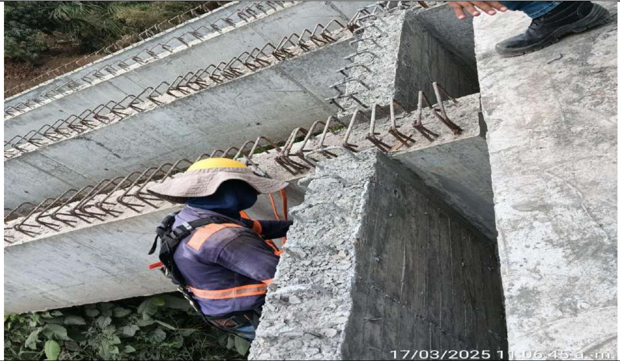
Puente PR45+700. Fundida de riostras en estribo 2.
