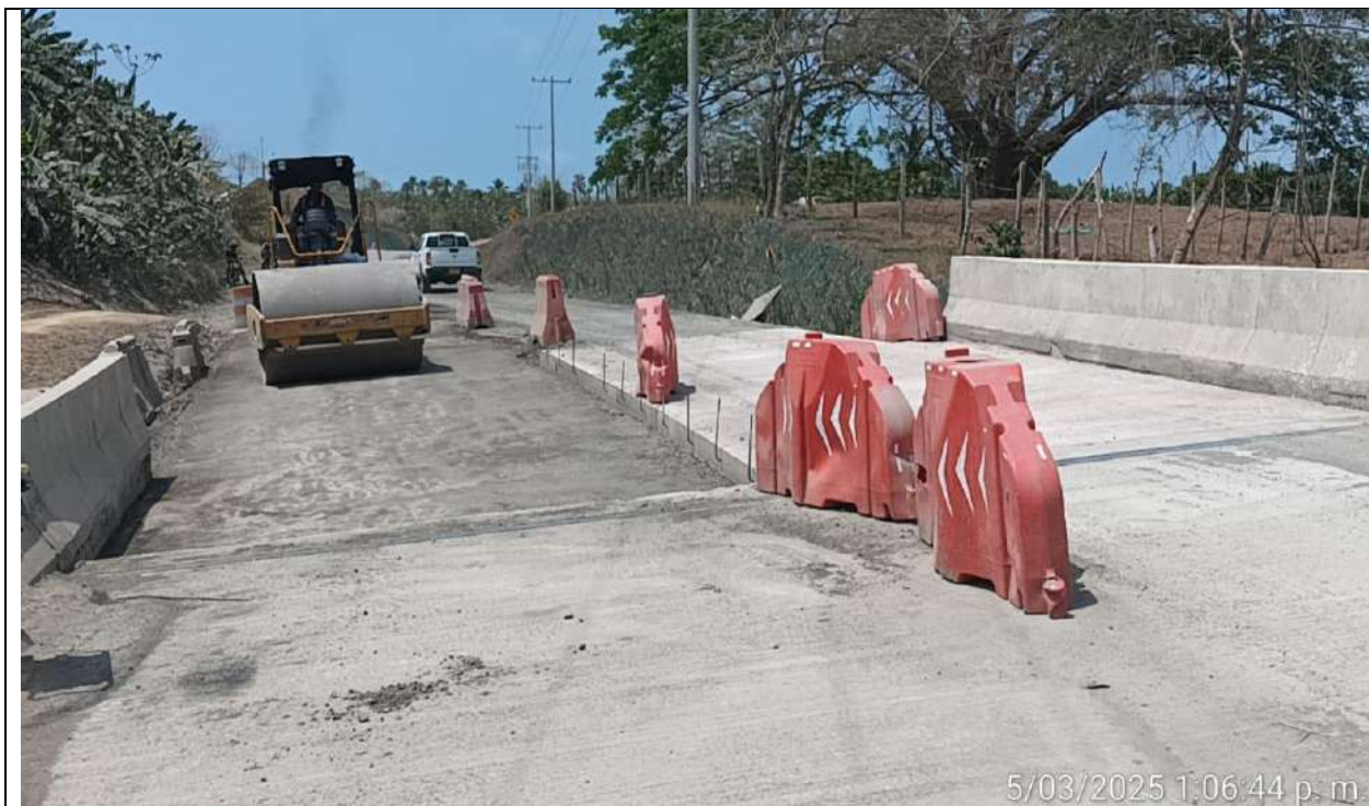
Cereo de subbase granular en el PR45+315 carril izquierdo.
