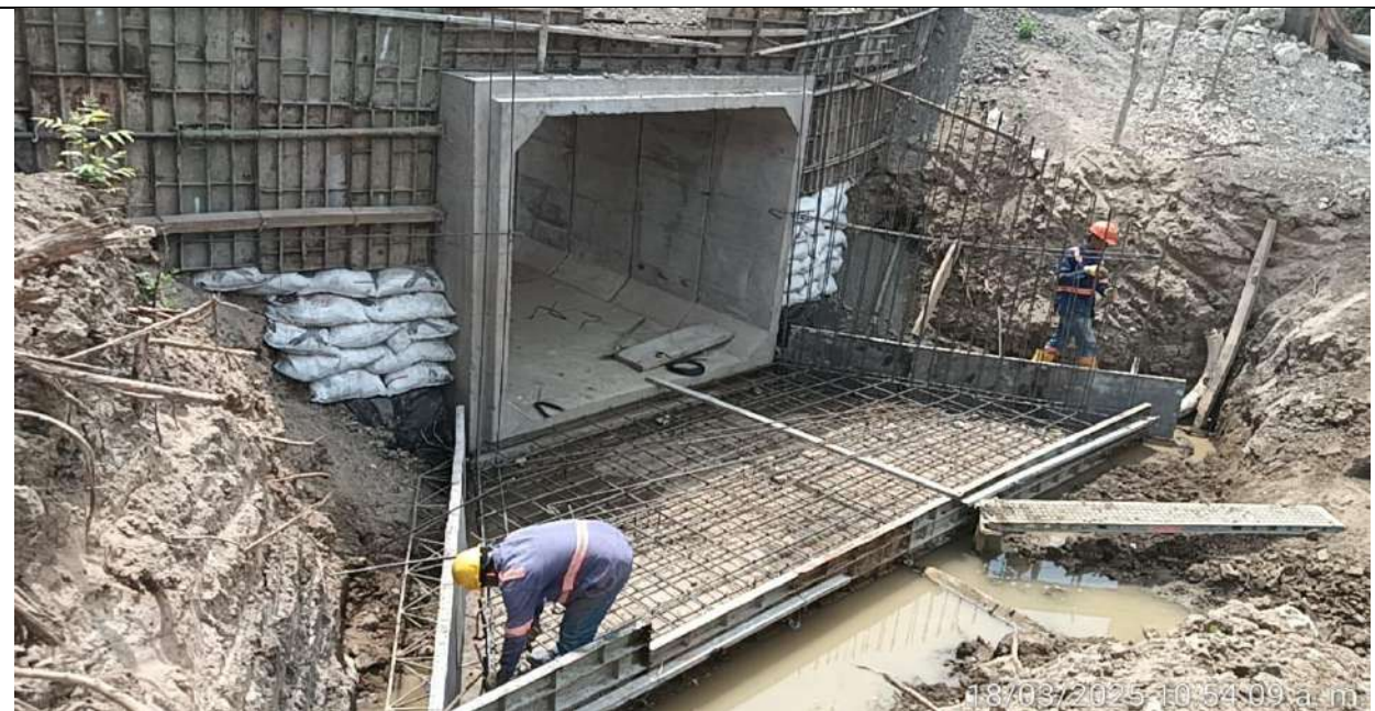
Box Culvert PR25+730 carril izquierdo. Instalación acero losa entre aletas.
