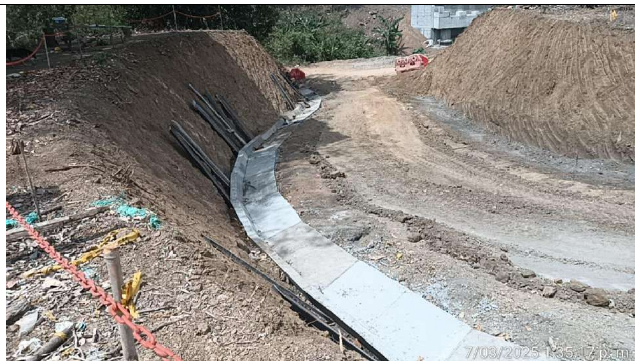
Construcción de cunetas en el acceso a vereda Membrillal PR45+620 lado izquierdo.
