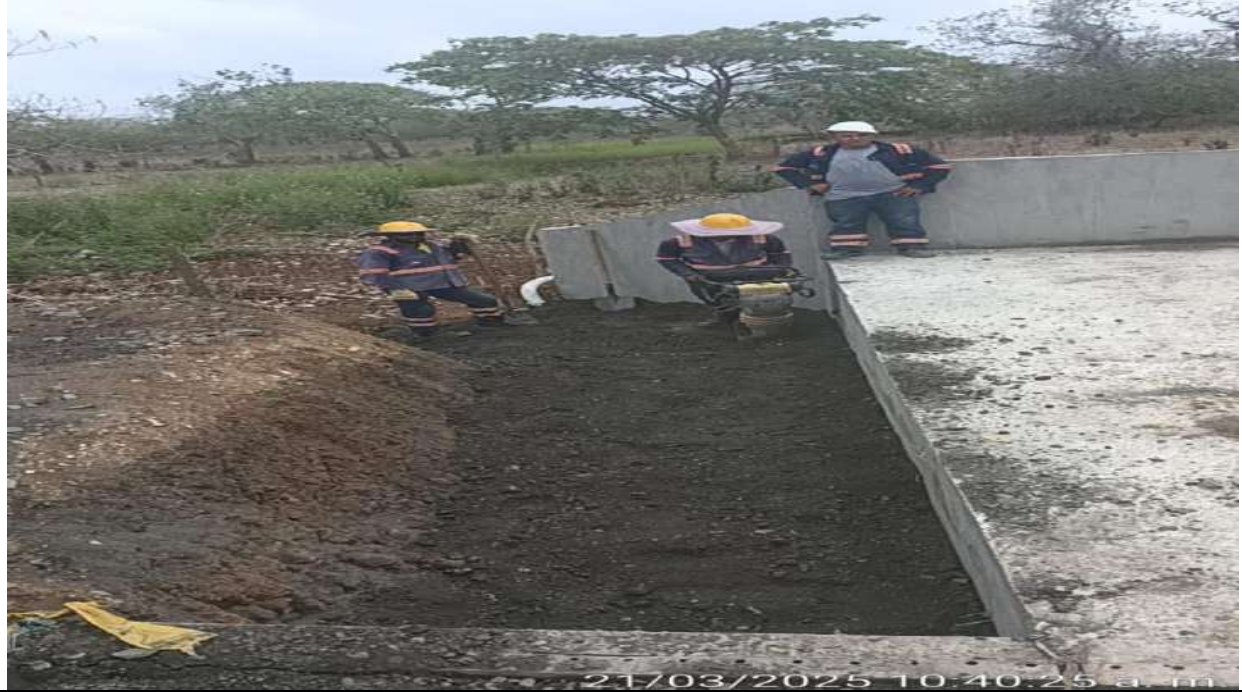
Box Culvert PR35+430. Lleno con material de afirmado – filtro.
