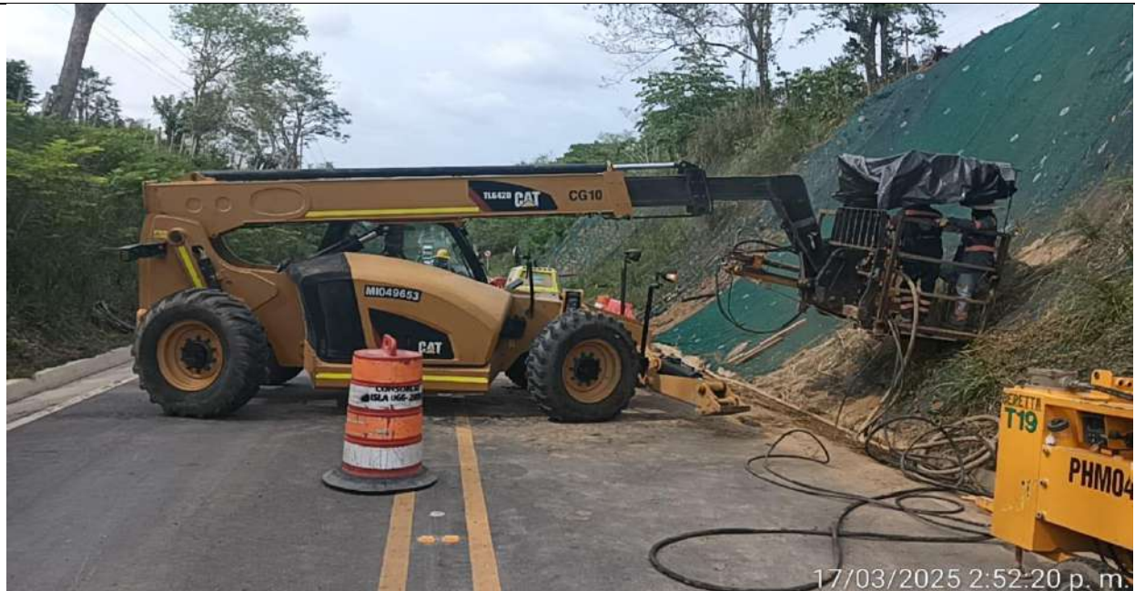
Instalación de pernos para control de erosión en el PR4+570 lado derecho.
