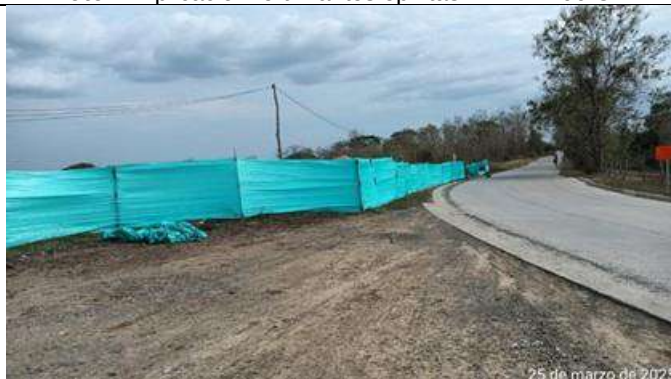
Foto 4. Mantenimiento cerramiento ZODME
