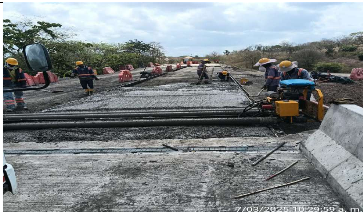
Fundida de módulos en concreto MR40 del PR34+530 a menores carril izquierdo.
