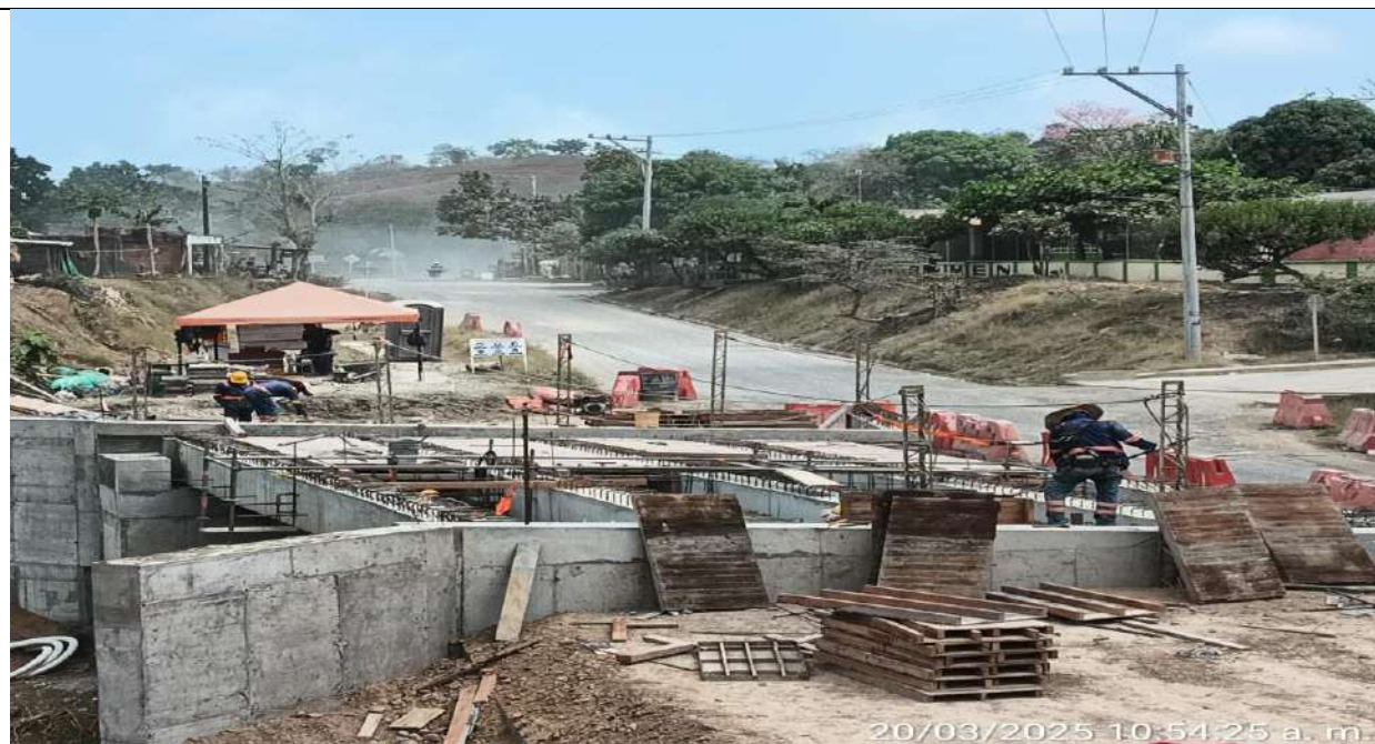
Puente PR45+700. Desencofrado de riostra estribo 1 e instalación de formaletas tablero.
