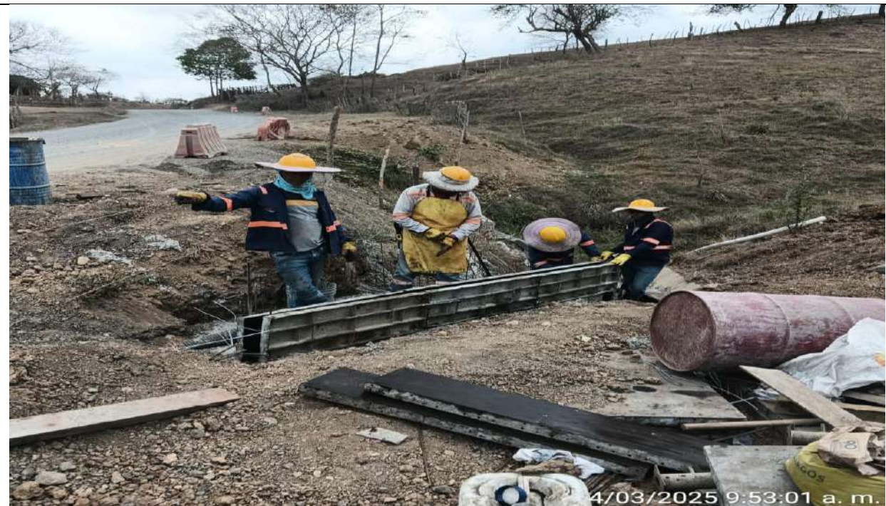
Instalación de formaletas muro dissipador en el PR31+55 lado derecho.
