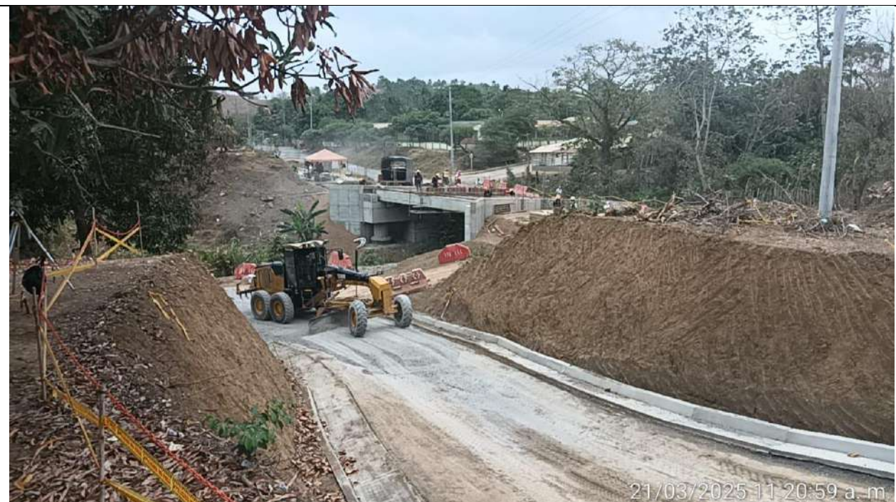
Instalación material de afirmado mezclado con cal en el acceso a vereda Membrillal PR45+630.
