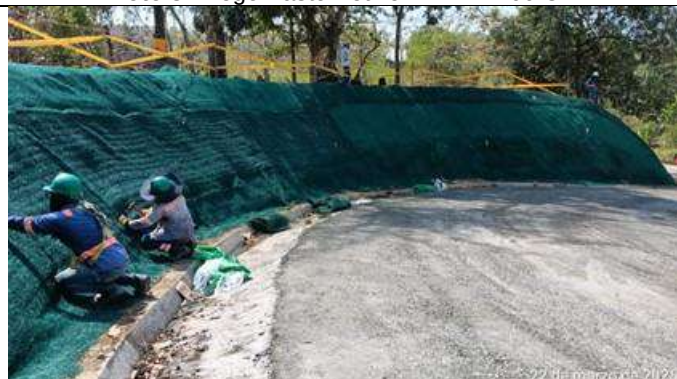
Foto 5. Instalación geomanto acceso vda. Membrillal PR 45+700
