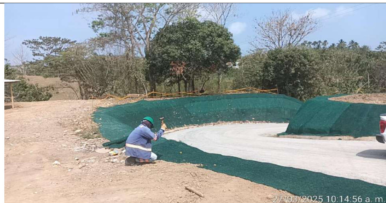
Protección de taludes con manto TRM500 en acceso vereda Membrillal, PR 45+650 Marge izquierda.
