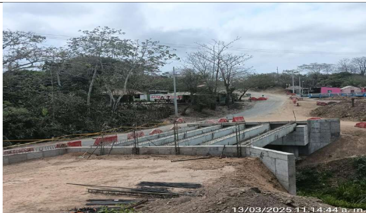
Puente PR45+700. Izaje de vigas.
