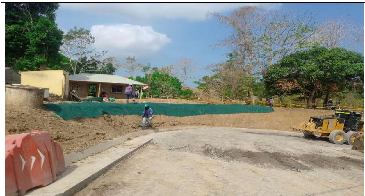
Protección de taludes con manto TRM500 en acceso vereda Membrillal, PR 45+650 Marge izquierda.
