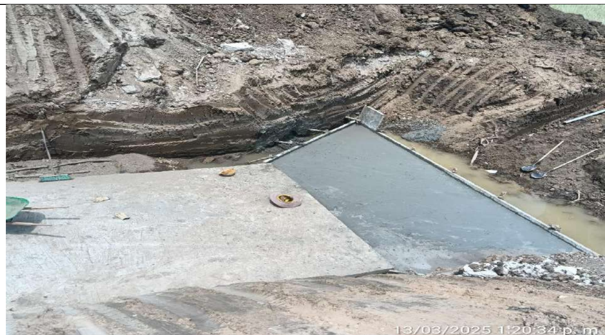
Box Culvert PR25+730 carril derecho. Solado para soporte de losa entre aletas.
