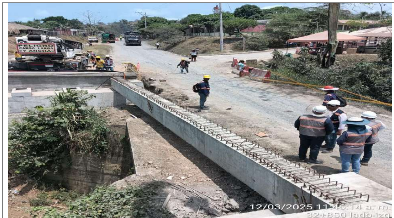
Puente PR45+700. Izaje de vigas.
