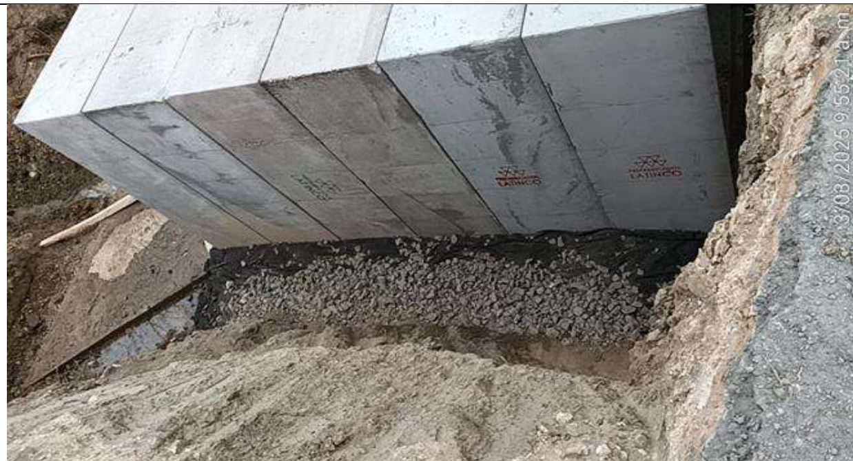
Box Culvert PR25+730 carril izquierdo. Construcción de filtro lateral.
