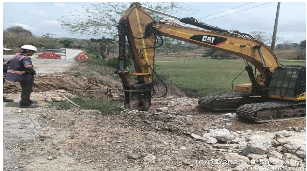
Demolición de ODT existente en el PR25+730 carril derecho.
