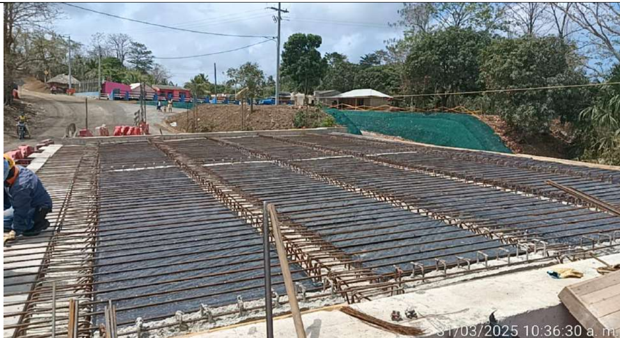
Puente PR45+700. Instalación acero de refuerzo para tablero de puente.
