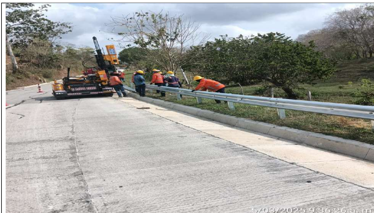
Instalación de defensas metálicas del PR12+340 lado derecho.
