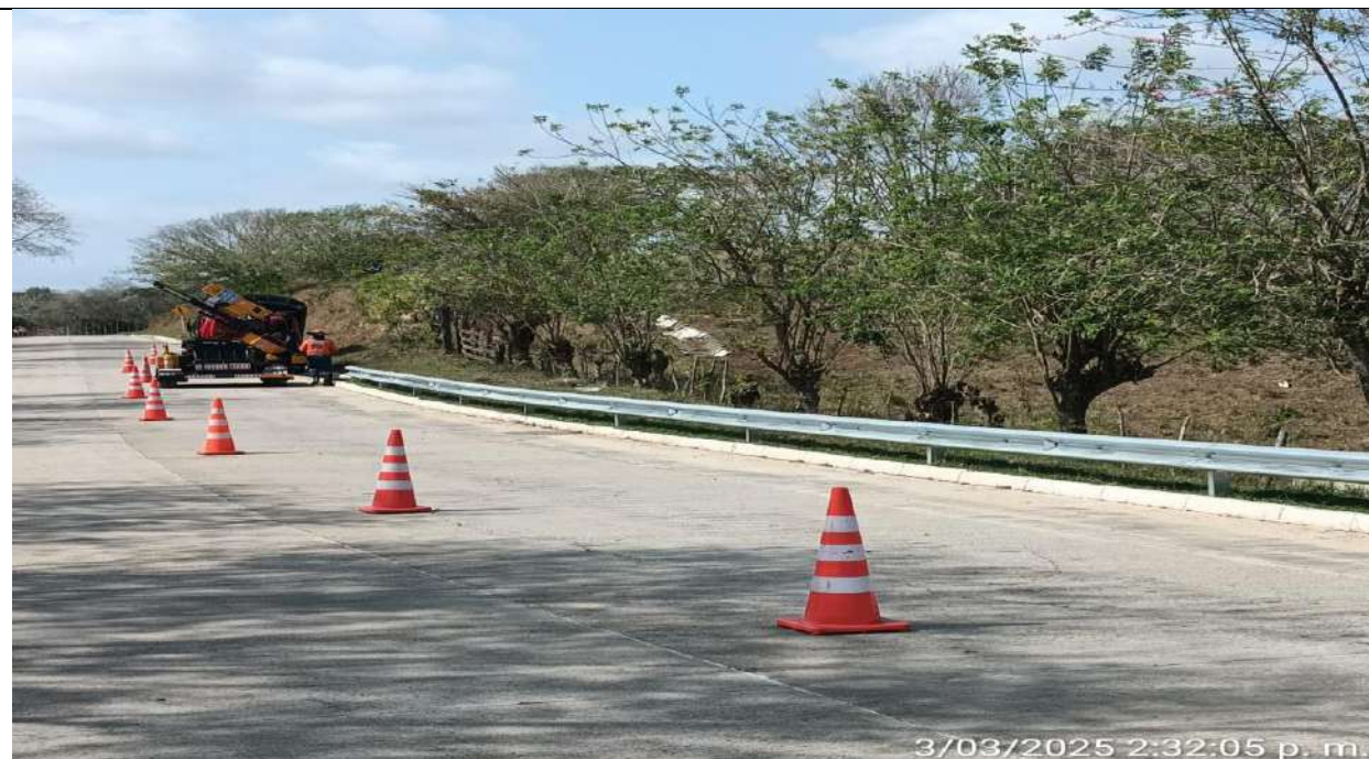
Instalación de defensas metálicas del PR11+700 a mayores lado derecho.
