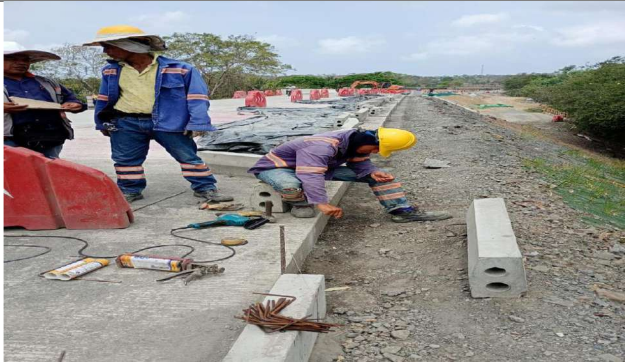
Instalación de bordillos prefabricados en el PR 34+500 lado derecho ( menores puente Regino).
