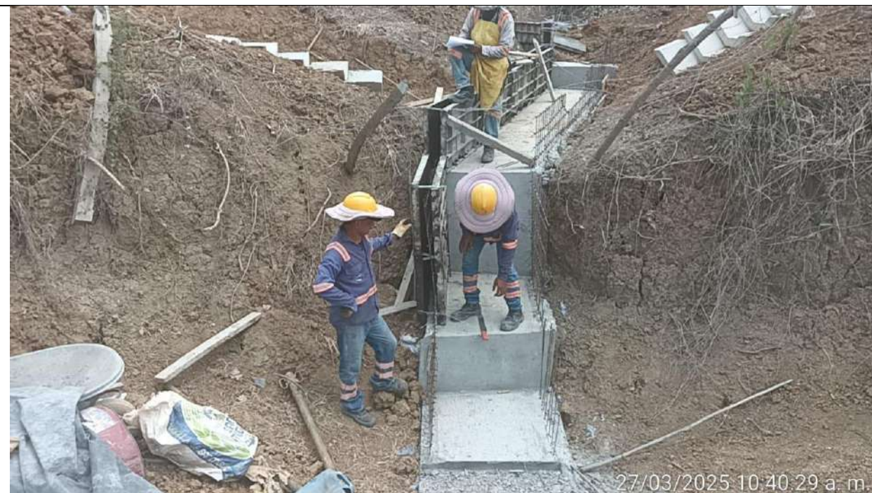
Se instalan formaletas para fundida de muros disipador en el PR 32+060 Lado derecho.
