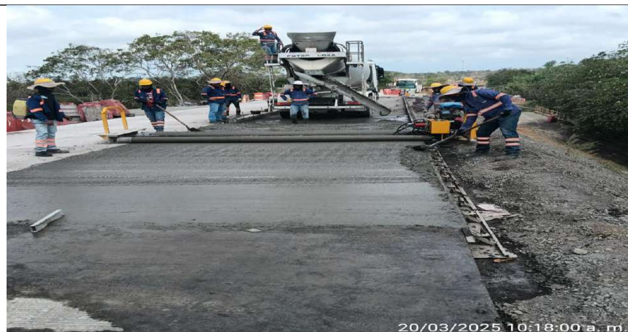
Fundida de módulos en concreto MR40 del PR34+485.6 a mayores carril derecho.
