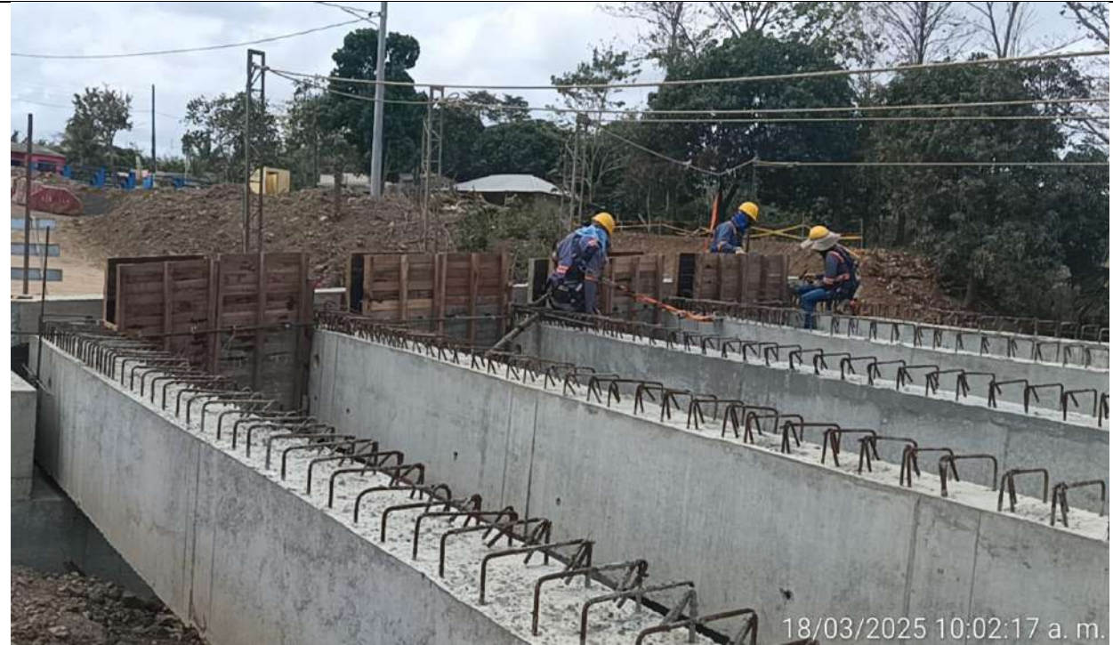
Puente PR45+700. Formaletas para fundida de riostras en estribo 1.
