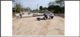
Primera capa de relleno en material de terraplén - aproches del puente PR45+00
