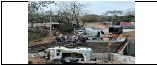
Construcción del tablero - losa del puente del PR 45+700
