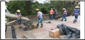
Construcción de módulos de new Jersey del lado derecho del puente del PR 45+700
