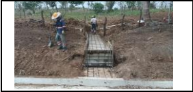
PR 30+900 instalación de acero para construcción de losa de dissipador del lado derecho
