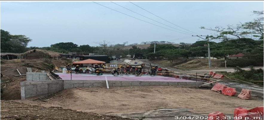
Puente PR45+700. Fundida tablero puente.
