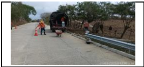
PR 11+800 carril derecho instalación de defensas metálicas
