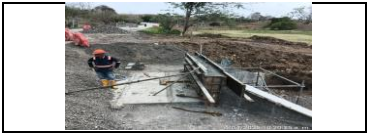
PR 25+230 construcción de muro guardarrueda
