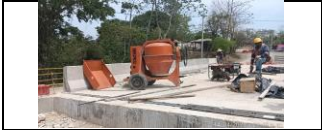
New jersey del lado derecho de puente del PR 45+700.
