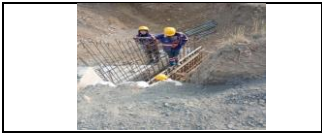
Instalación de acero alas box culvert del PR 27+138 lado izquierdo
