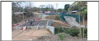
Instalación de acero de refuerzo para construcción de losa del puente del PR 45+700
