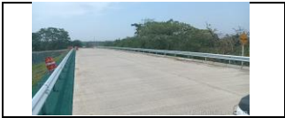
Instalación de defensas metálicas en el PR 34+500 ambos lados
