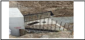
box culvert del PR 25+730 encofrado de alas lado derecho
