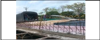
puente PR45+700 instalación de acero de new Jersey
