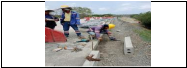
instalación de bordillos prefabricados en el PR 34+500 lado derecho
