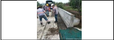
Construcción de New Jersey en el PR28+500 Lado derecho
