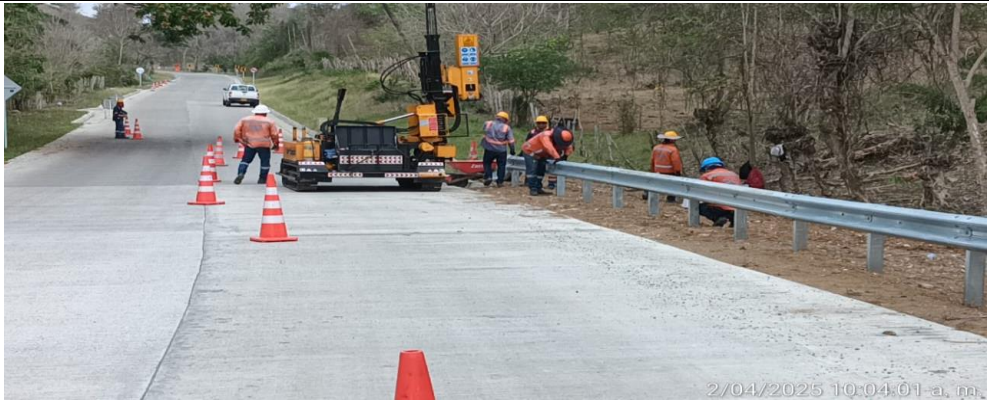
Instalación de defensas en el PR26+800 lado derecho.
