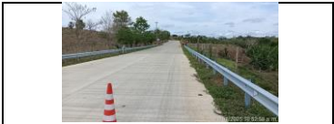
PR 30+550 instalación de defensas metálicas
