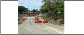
Puente del PR 45+700 habilitado
