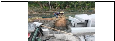
PR 34+440 lado derecho adecuación de terreno para instalación de bajantes prefabricados
