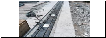
Instalación de junta elastoamerica en estribo 2 del puente del PR 45+700.
