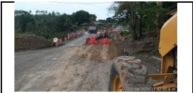
ampliación y conformación lado derecho en aproche sur del puente del PR 45+700.
