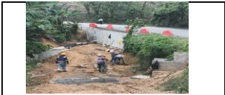
excavación manual para construcción de cunetas trapezoidal en el PR 46+506 lado izquierdo.
