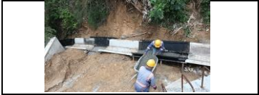
construcción de cuneta trapezoidal en el lado izquierdo del PR 46+506
