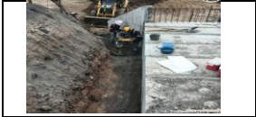
relleno estructural con material de afirmado box PR27+138
