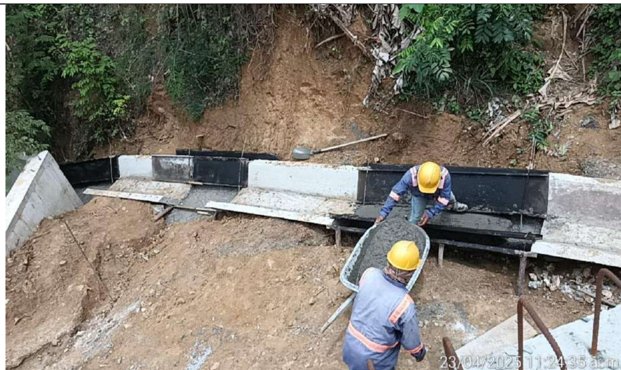
Fundida de cuneta trapezoidal en el PR46+506 lado izquierdo.
