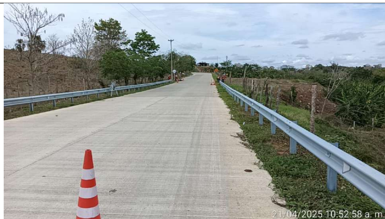
Instalación de defensas en el PR30+550 lado izquierdo.
