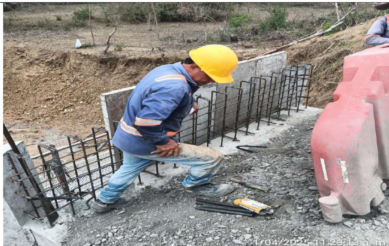
Box Culvert PR27+138 lado izquierdo. Acero de refuerzo muro guarda ruedas.
