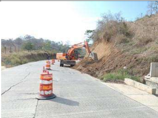
Foto 3. Riego Pasto Vetiver PR 27+700 CD
