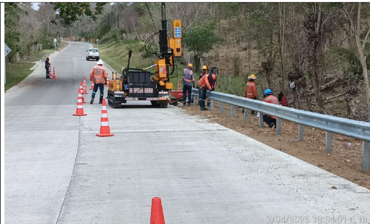
Instalación de defensas en el PR26+800 lado derecho.
