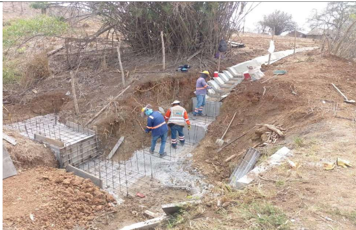
Instalación acero de refuerzo descole ODT PR30+950 margen derecha.
