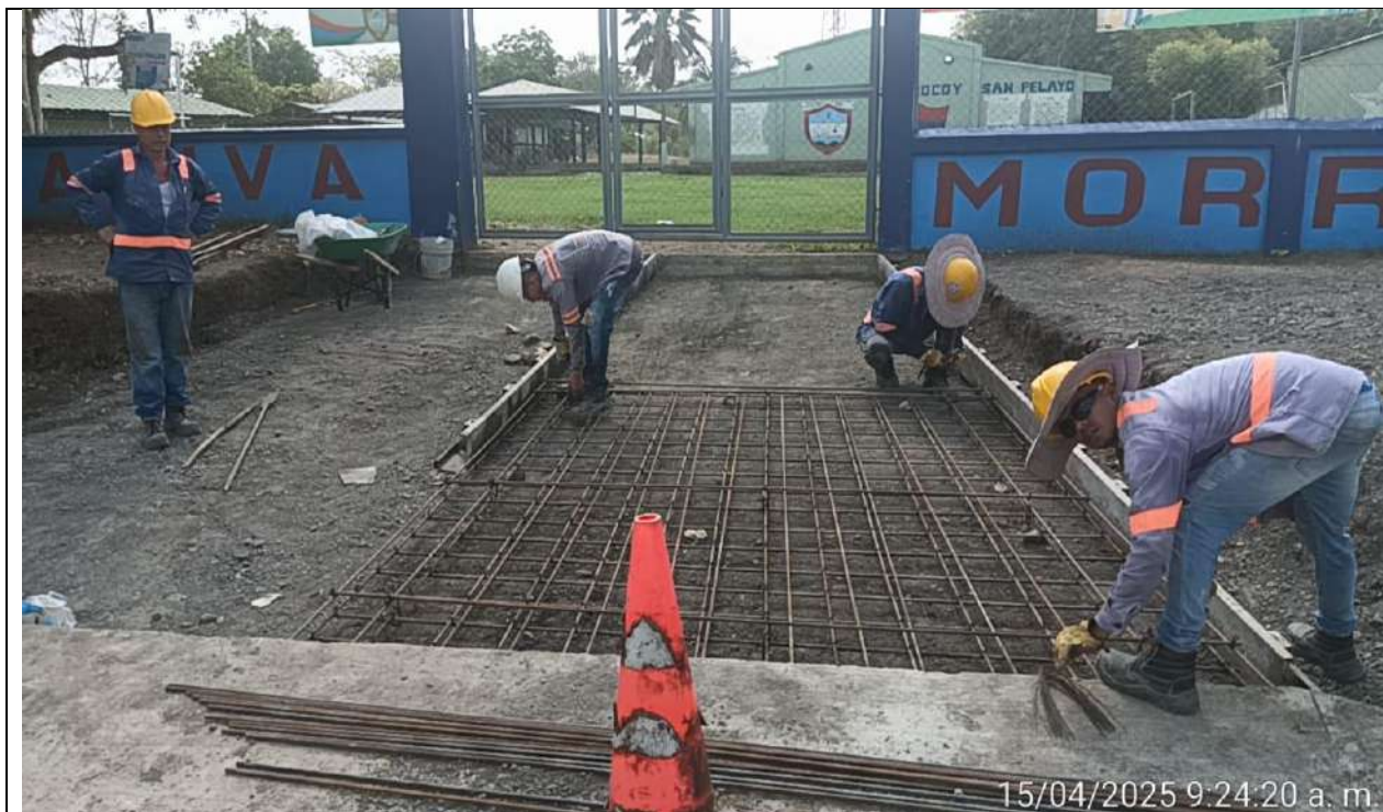
Acero de refuerzo losa de acceso a Institución Educativa Morrocoy PR17+000 lado derecho.
