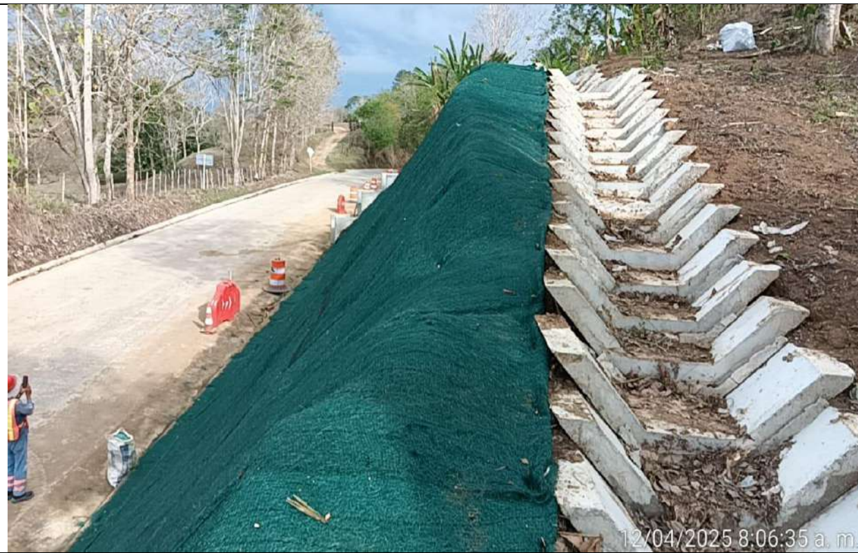
Instalación de manto TRM500 en el talud del PR13+820 margen derecha.
