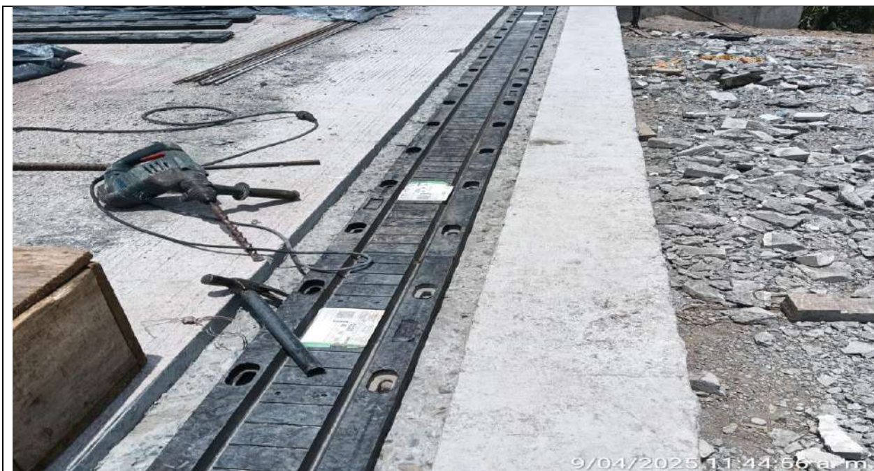
Puente PR45+700. Instala junta elastomerica en estribo 2.
