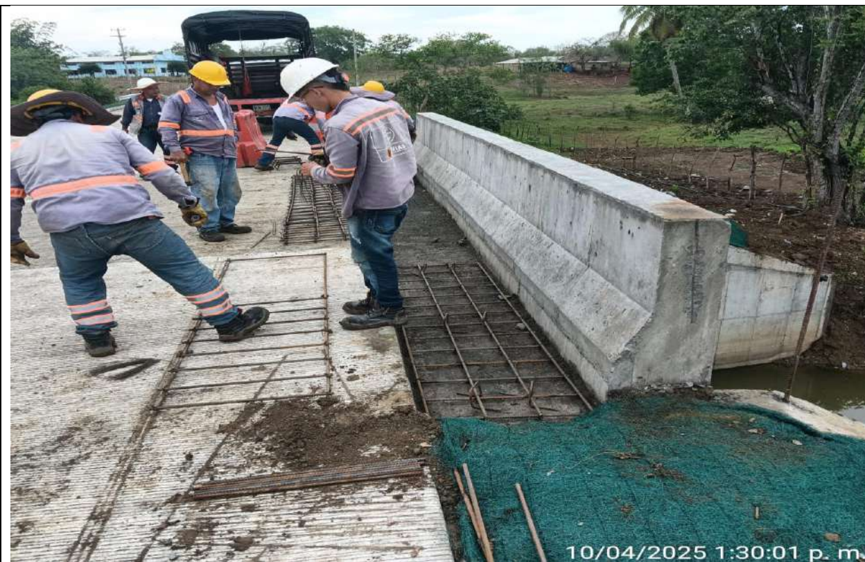
Instalación de acero para fundida de sobre anchos New Jersey PR25+500 lado derecho.
