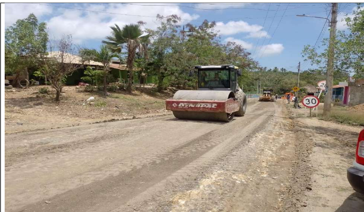
Mantenimiento de calzada vía existente del PR45+500 al PR45+640.
