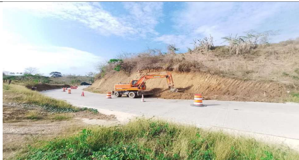
Perfilamiento de talud en el PR12+850 a menores margen izquierda.
