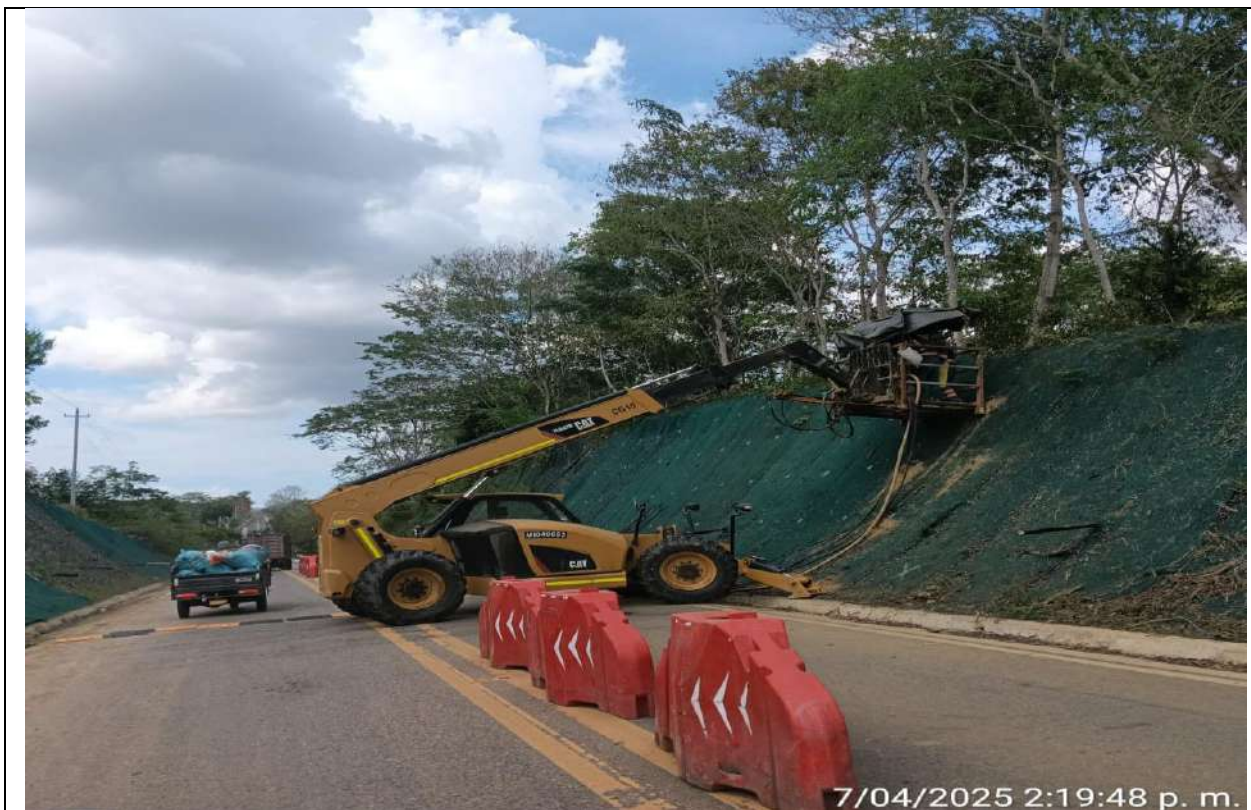
Perforación para instalación de pernos en talud del PR5+875 lado derecho.
