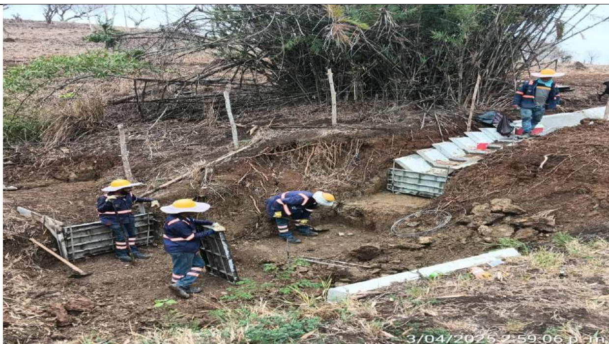
Excavación para construcción de dissipador en el PR30+940.
