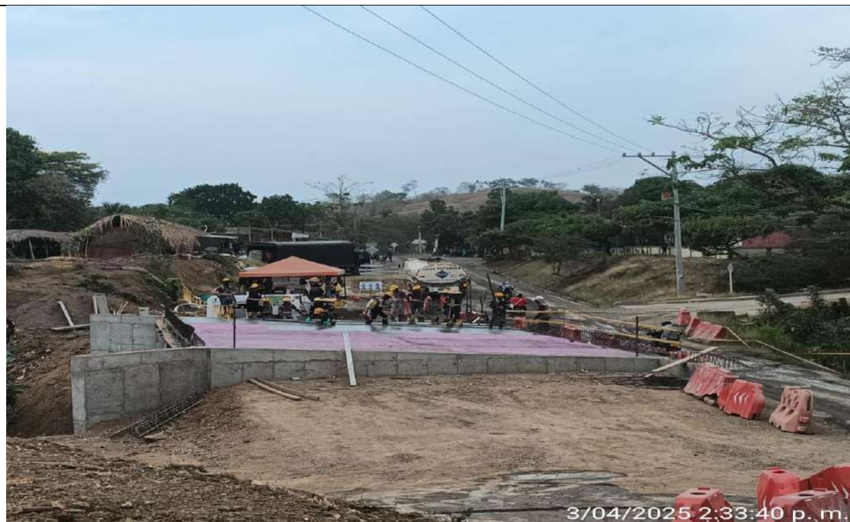
Puente PR45+700. Fundida tablero puente.
