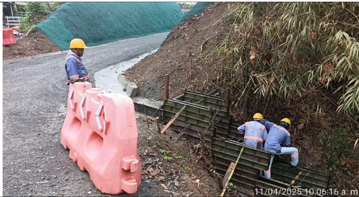
Instalación de formaletas para fundida de muros disipador en el PR 45+620 lado izquierdo.
