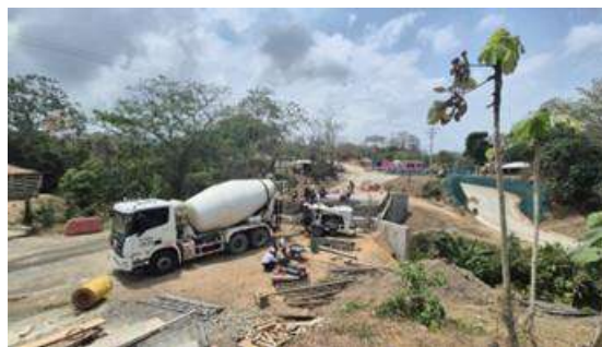
Foto 4. Mantenimiento cerramiento ZODME
