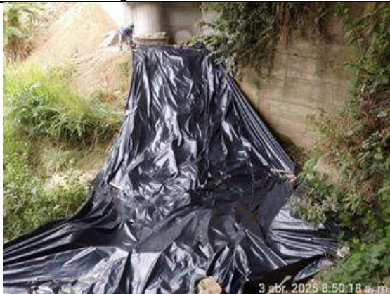
Foto 5. Instalación geomanto acceso vda. Membrillal PR 45+700
