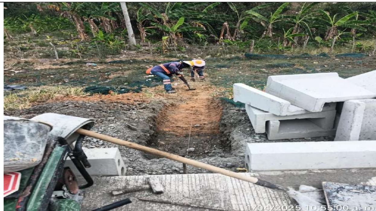
Adecuación de terreno para instalación de bajantes en el PR34+440 lado derecho.
