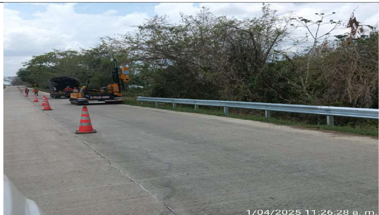
Instalación de defensas en el PR25+400 lado izquierdo.
