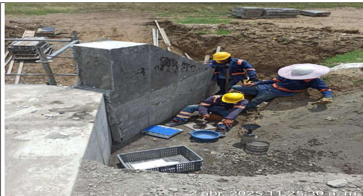
Box Culvert PR25+730 carril derecho. Densidades material de afirmado para lleno de aletas.
