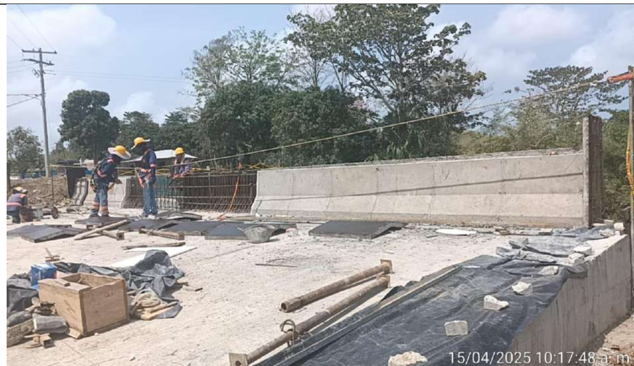
Puente PR45+700. Modulo New Jersey lado izquierdo.
