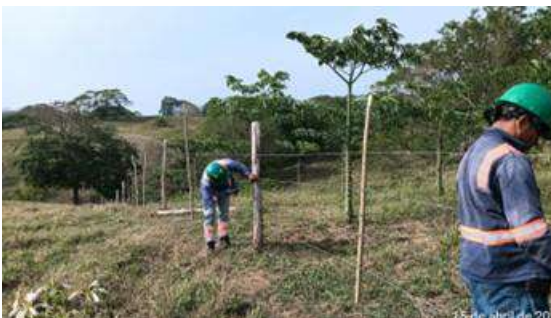
Foto 6. Instalación Pasto Vetiver PR 27+700 CD
