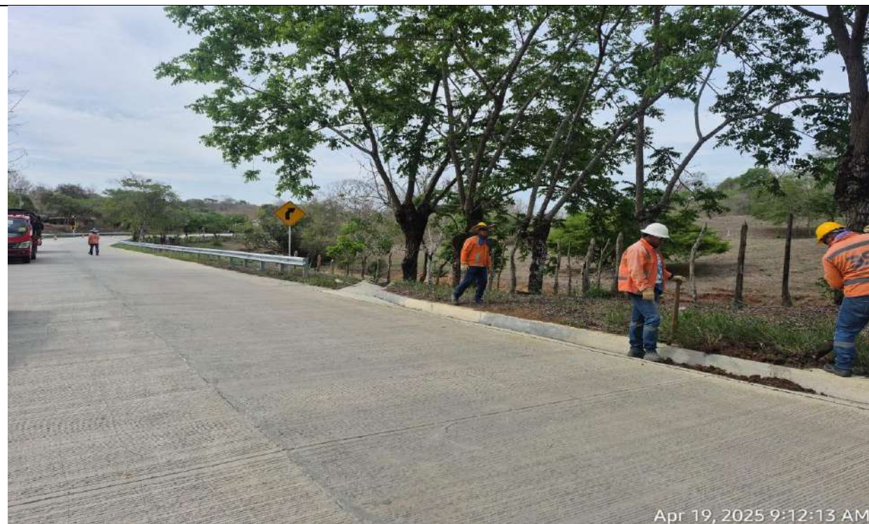
Instalación de abatimiento en el PR30+860 lado izquierdo.
