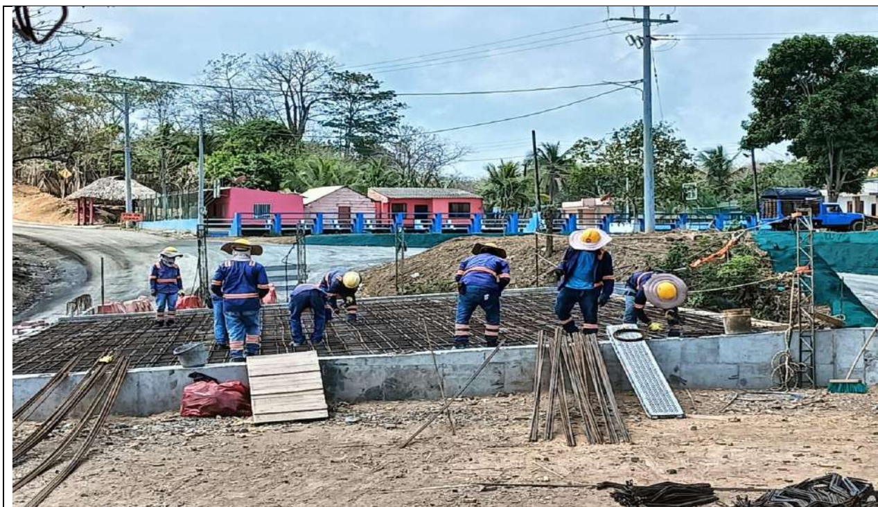
Puente PR45+700. Instalación acero de refuerzo tablero.
