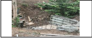
PR 30+620 lado derecho instalación de formaletas para fundida de muros de dissipador.
