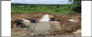
PR 8+920 lado derecho, solado de limpieza para construcción de dissipador
