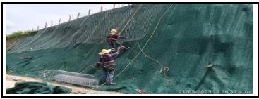
Instalación de malla triple torsión PR11+580 al PR11+630 D
