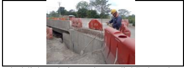
instalación de acero de refuerzo para la construcción de New Jersey sobre aletas del puente, PR 45+700 margen derecha
