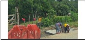
Construcción de losa acceso a predio del PR 25+540 lado izquierdo
