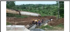
construcción de losa del dissipador del PRB+920, lado derecho
