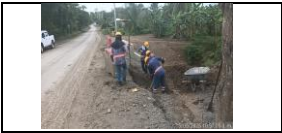
box culvert del PR 42+400 el contratista realiza excavación para construcción de cuneta trapezoidal
