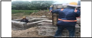
Construcción de guarda ganado PR34+500 margen izquierda
