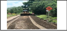
Mantenimiento de via del PR 40+300 a menores.
