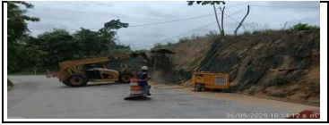
Perforación para instalación de pernos en talud del PR15+420 D
