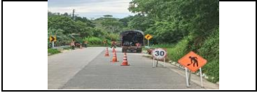
PR14+500 lado izquierdo instalación de señalización vertical DCH
