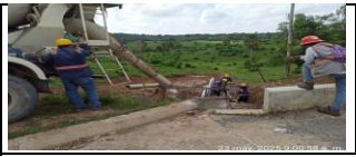
Fundida de muro dissipador en el PR8+920 D
