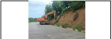
perfilación de talud del PR 26+200 margen derecha.
