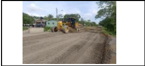
Mantenimiento en vía existente PR35+430 al PR 35+700
