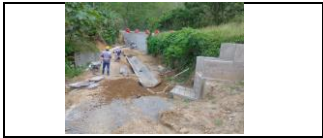
construcción de disipadores margen izquierda PR 46+502
