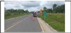
PR 19+000 instalación de señalización vertical
