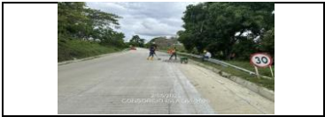
Instalación defensas metálicas del PR 16+980 a menores ambos lados
