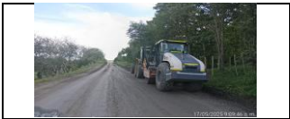
PR32+000 mantenimiento de vía
