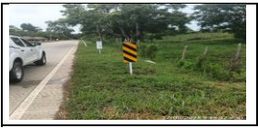
Instalación de marcador de obstáculos sencillos
