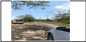
conformación de calzada - mantenimiento PR 44+800 a 44+900
