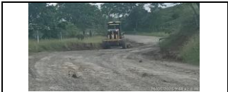
mantenimiento de vía PR 31+600 a mayores.
