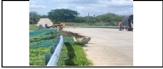
PR 28+450 instalación de defensas metálicas de ambos lados.
