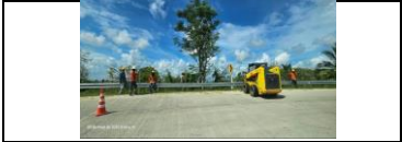
PR 11+000 lado izquierdo instalación de defensas
