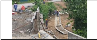
Construcción de new Jersey sobre muro patero del PR 46+506 al 46+515
