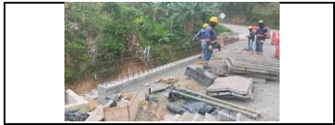
Instalación de acero de refuerzo para fundida de new Jersey sobre el muro del Pr 45+506 al 46+520, lado izquierdo
