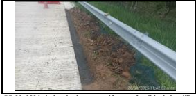
PR 26+030 lado izquierdo excavación para fundida de bordillo en sitio.
