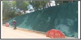
Instalación de manto TRM-500 del PR26+160 al PR26+180
