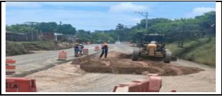
Instalación de terraplén en aproche norte puente PR45+700
