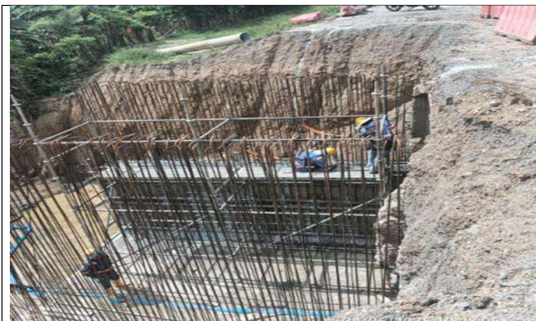
Box Culvert PR 34+658, lado izquierdo. Encofrado de muro sur.
