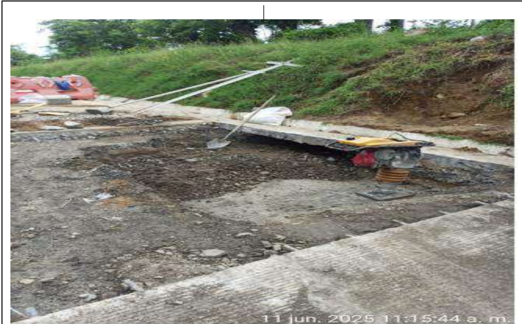
PR 8+925 lado derecho. Lleno con material de terraplén tipo corona en el apique realizado para el ensayo de infiltración con anilina.
