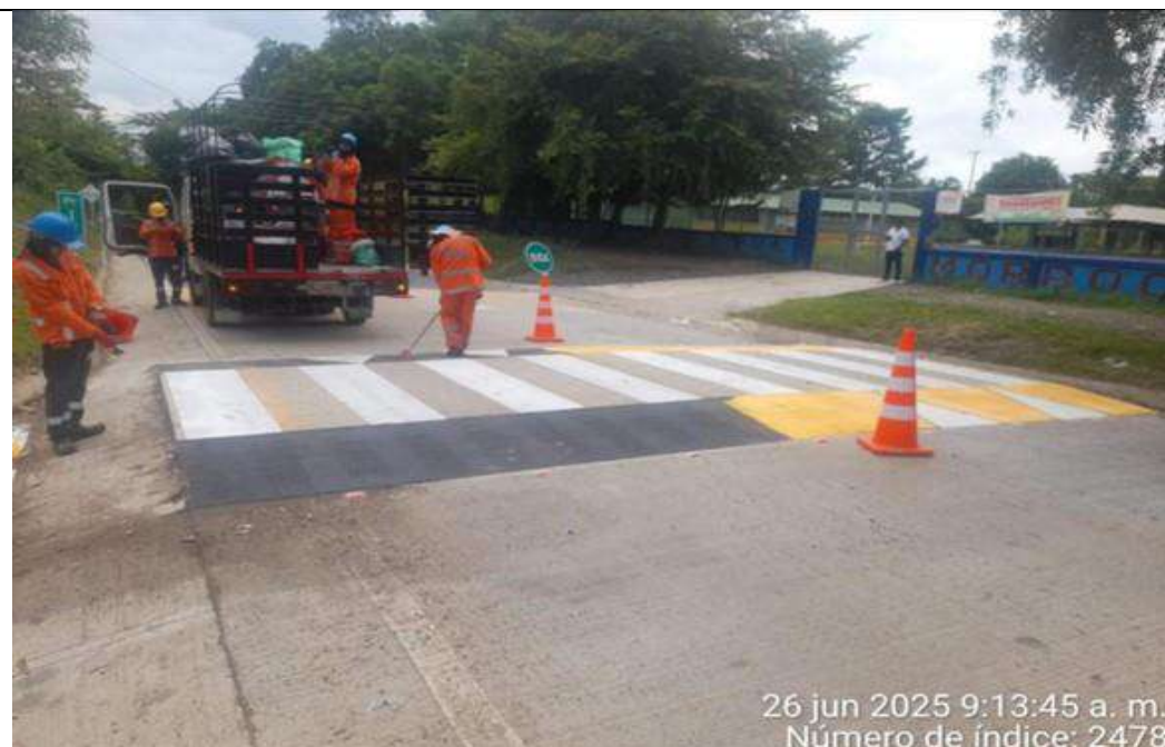
PR16+990. Imprimación en resaltos tipo pompeyanos.
