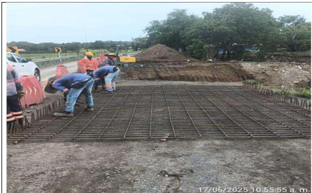
Box Culvert PR 34+658 lado derecho. Amarre acero de refuerzo para parrilla losa inferior.
