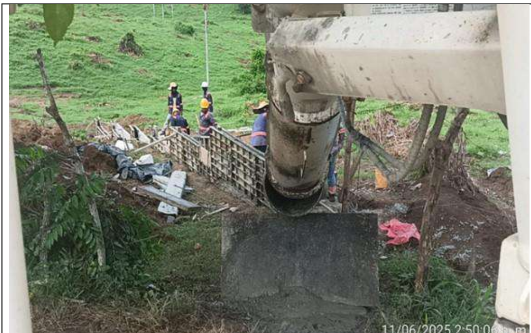
Disipador PR8+856 lado derecho. Fundida de muros.
