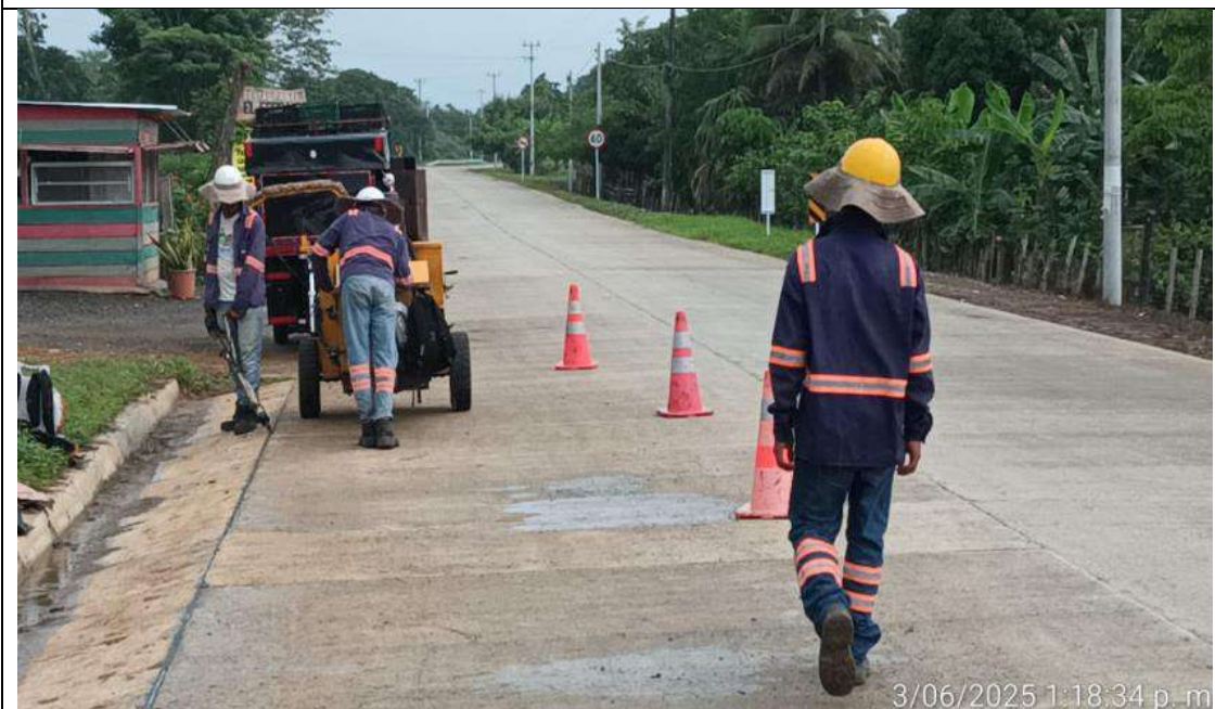
PR 23+650 a menor del lado derecho. Limpieza y sello de juntas entre pavimento y cunetas.
