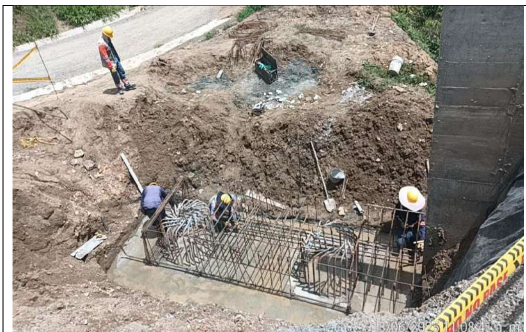
Puente PR 45+700 lado izquierdo. Instalación de acero de refuerzo de zarpa muro de acompañamiento estribo 1.
