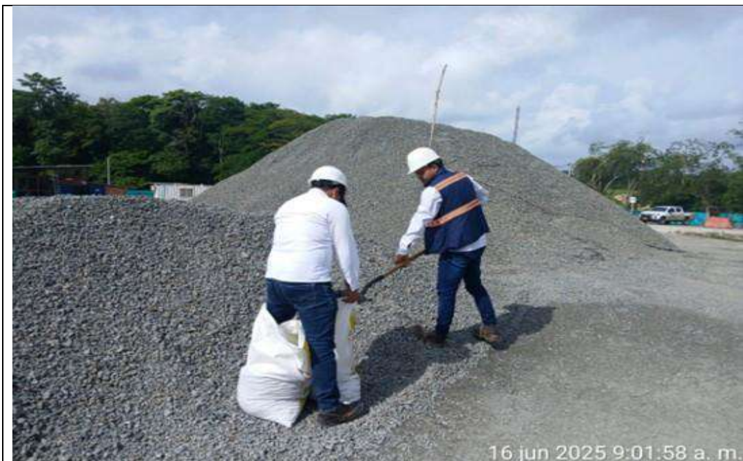
PR 4+400 lado derecho (acopio). Toma de muestras de los agregados del concreto para ensayos de laboratorio.
