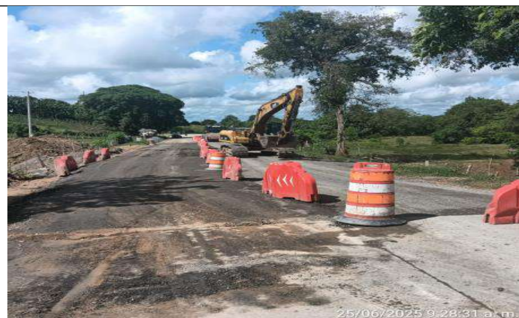
Broche PR 25+700-PR25+750 carril derecho. Instalación de subbase.
