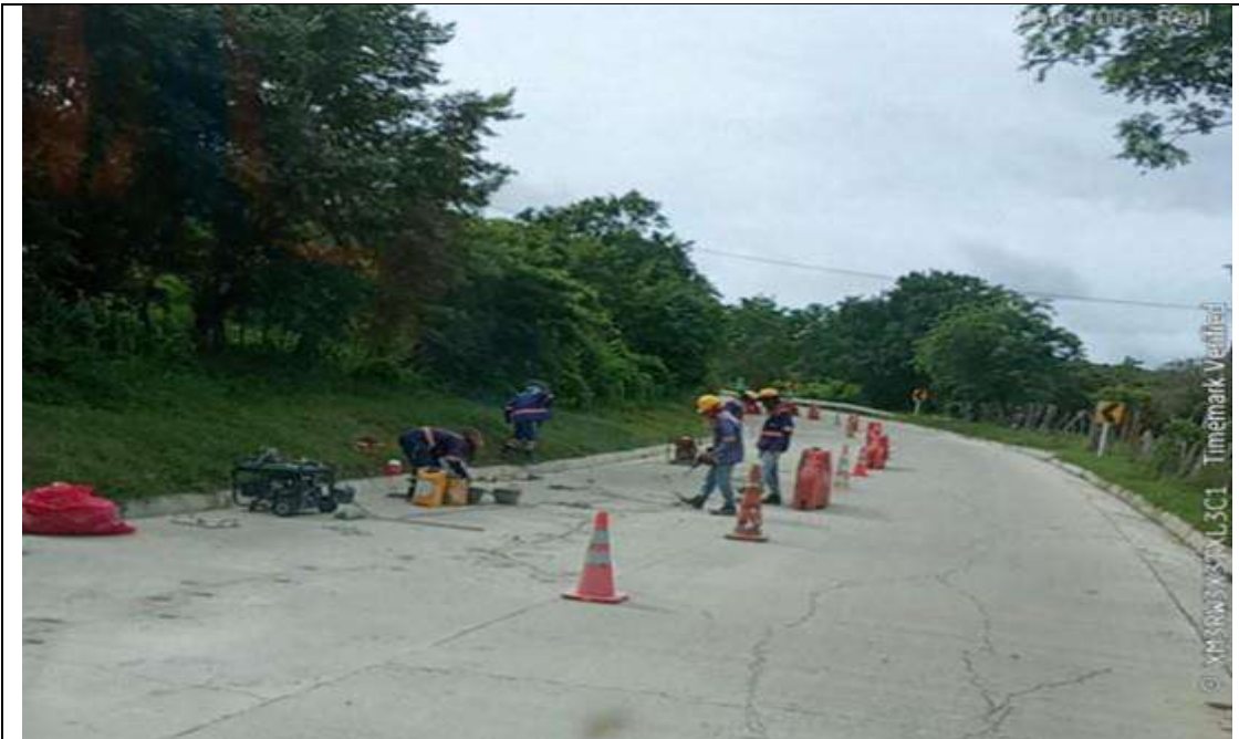
PR 25+950 a mayor carril derecho. Costuras a losas en Concreto MR40.
