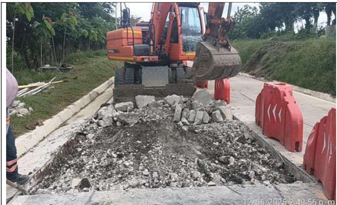
PR 8+225 Lado izquierdo. Demolición del módulo en concreto MR 40 #115.
