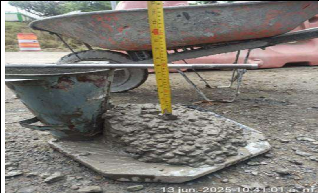
PR45+700 lado izquierdo. Asentamiento y toma de muestras de concreto en la fundida de caisson 3 y 4 del muro de acompañamiento.
