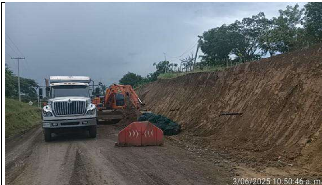
PR 45+480 a mayor lado izquierdo. Perfilación de talud.
