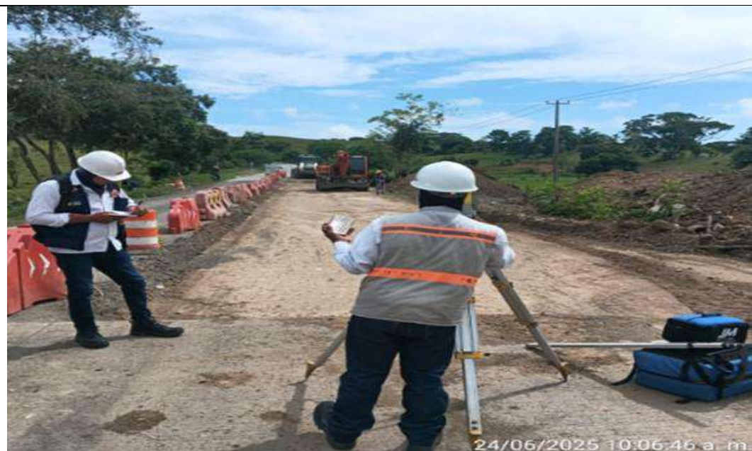
Broche PR 25+700-25+750 carril derecho. Chequeo de niveles a material de terraplén instalado.
