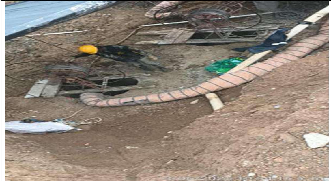
Puente PR 45+700 lado izquierdo. Excavacion caisson muro de acompañamiento.
