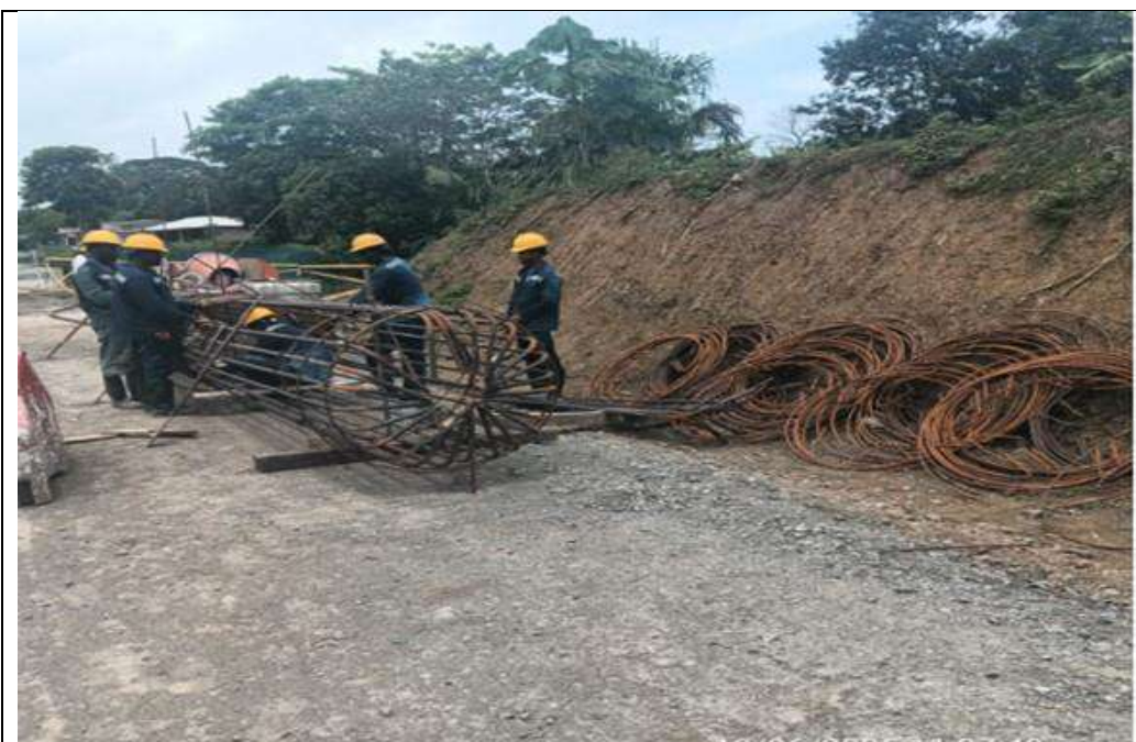
Puente PR 45+700. Acero de canastas caisson muro de acompañamiento.
