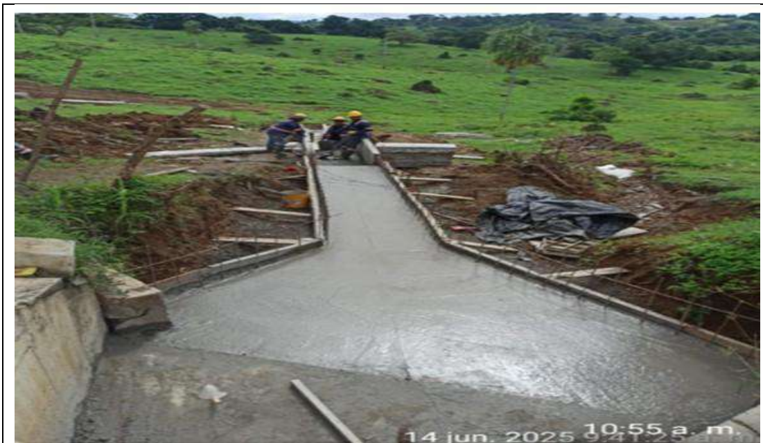
Disipador PR 8+856 lado derecho. Fundida de losa de empalme.
