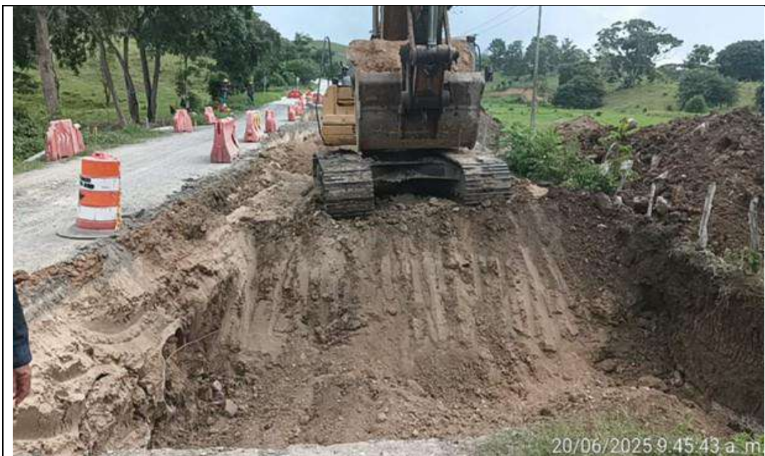
Alcantarilla PR 25+700 lado derecho. Demolición de ODT existente.
