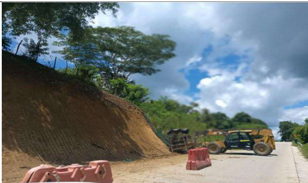
PR 26+352 lado derecho. Perforación para instalación de pernos en talud.
