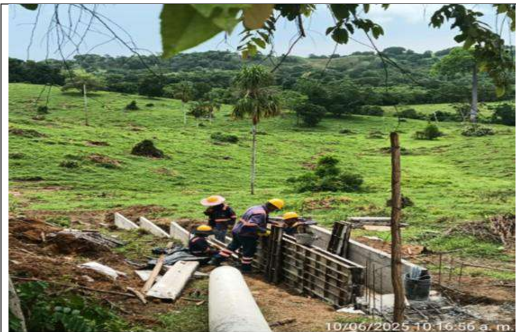
Disipador PR 8+856, lado derecho. Instalación de formaletas para fundida de muros.
