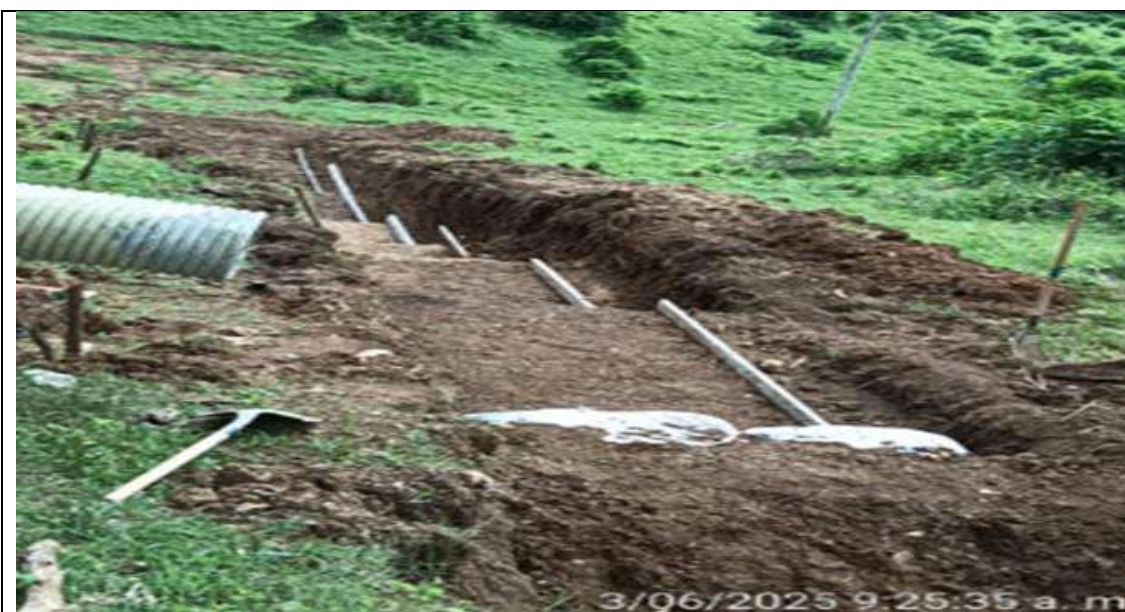
Disipador PR 8+856 lado derecho. Instalación de formaletas para fundida de solado.
