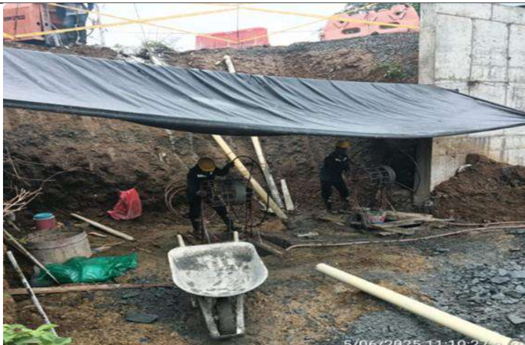
Puente PR 45+700 lado izquierdo. Excavaciones de caisson.
