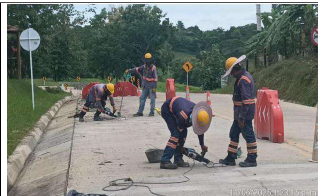
PR 9+800 a mayores, carril izquierdo. Costuras de módulos en concreto MR 40.
