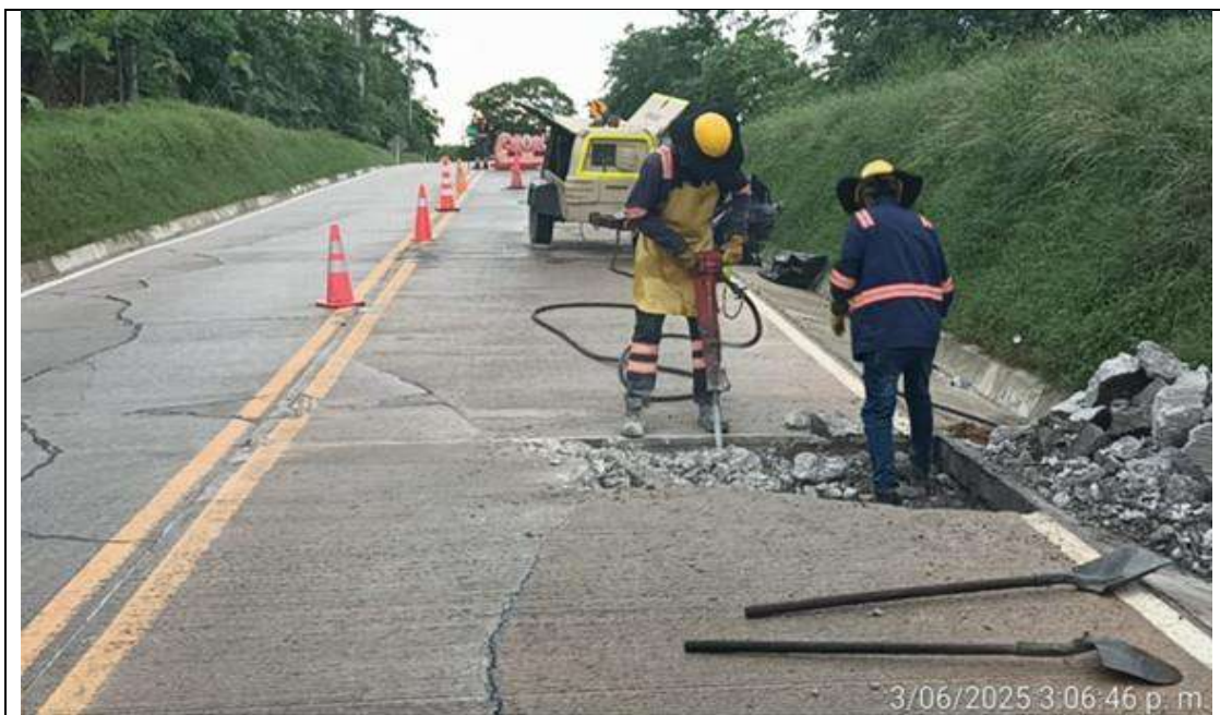
PR 8+530 carril derecho. Demolición de losa #118 y 119.
