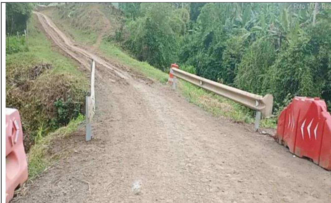
PR 45+700 margen izquierda. Instalación de defensas en laterales sobre box culvert acceso a vereda Membrillal.
