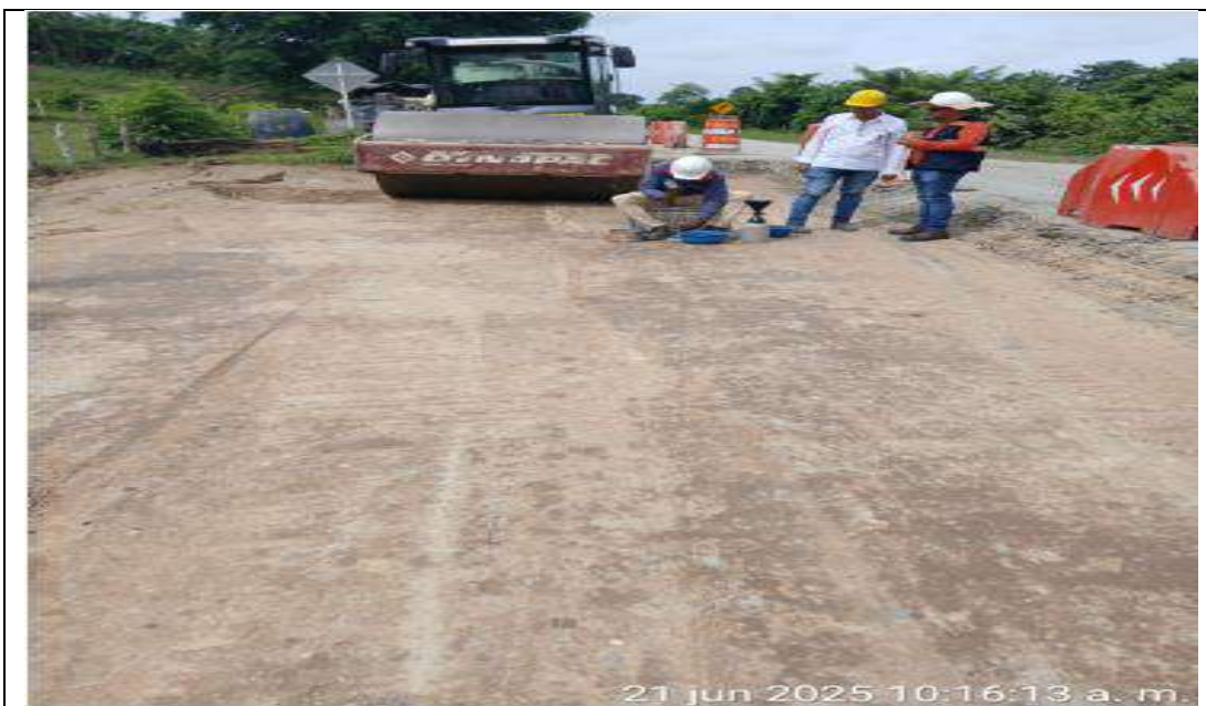
Broche PR25+700 al PR25+725 lado derecho. Toma de densidades en el mejoramiento con material de terraplén.
