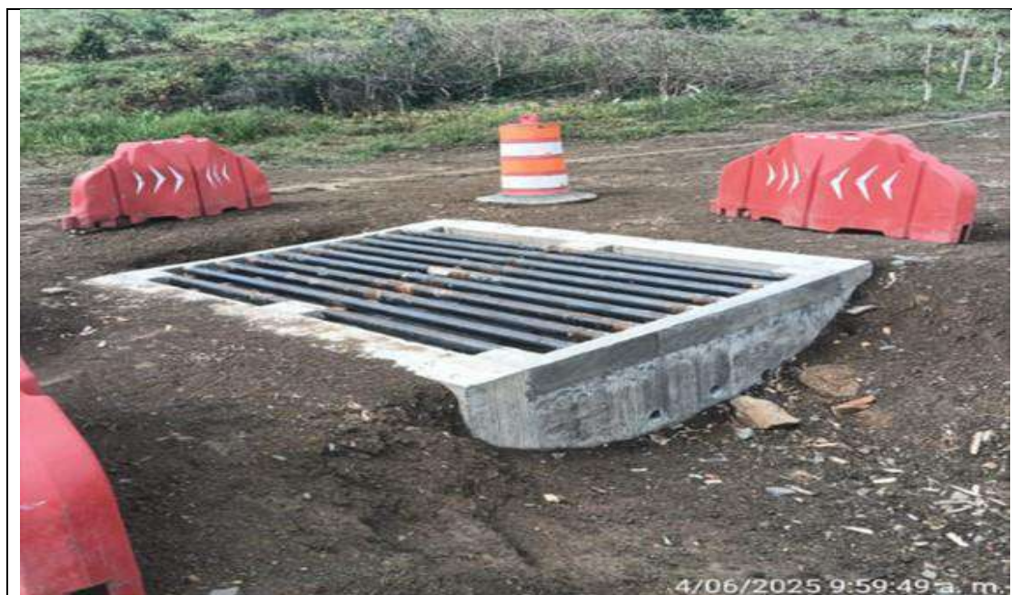
PR 34+500 lado izquierdo. Instalación de parrilla guarda ganado.
