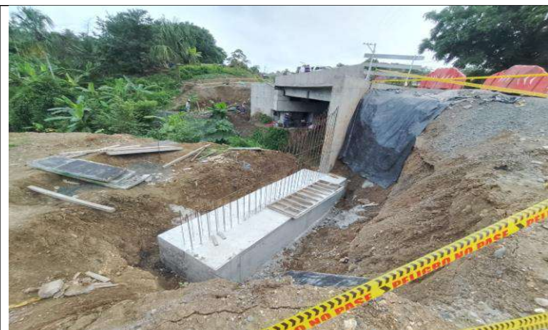
Puente PR 45+700 lado izquierdo. Desencofrado de zarpa, muro de acompañamiento estribo #1.
