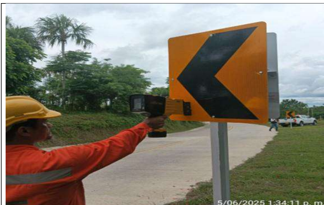
PR 9+200 a mayores. Toma de reflectividad a señalización vertical.
