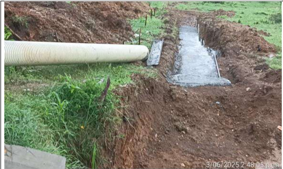
Disipador PR8+856 lado derecho. Instalación de solado.
