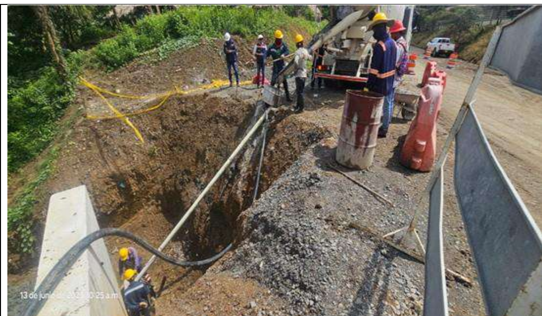
Puente PR 45+700 lado izquierdo. Fundida de caisson muro de acompañamiento.
