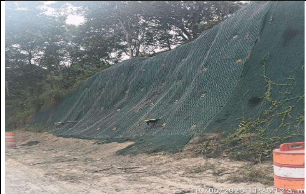
PR 46+420-46+430 lado derecho. Instalación de malla triple torsión para protección de talud.
