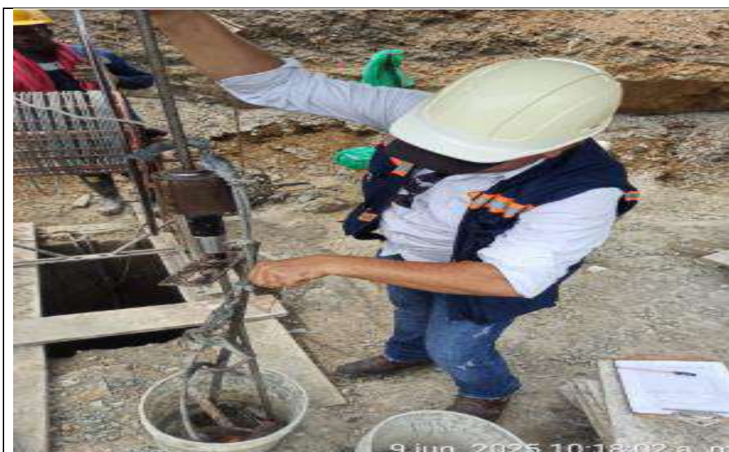
Puente PR 45+700 lado izquierdo. Ensayo PDC en caisson 2 - estribo 1, muro de acompañamiento.
