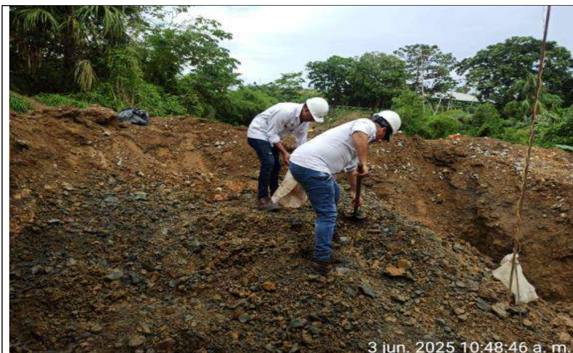
Puente PR 45+700. Toma de muestras para ensayos de laboratorio a material de excavación en Caisson muro de acompañamiento.
