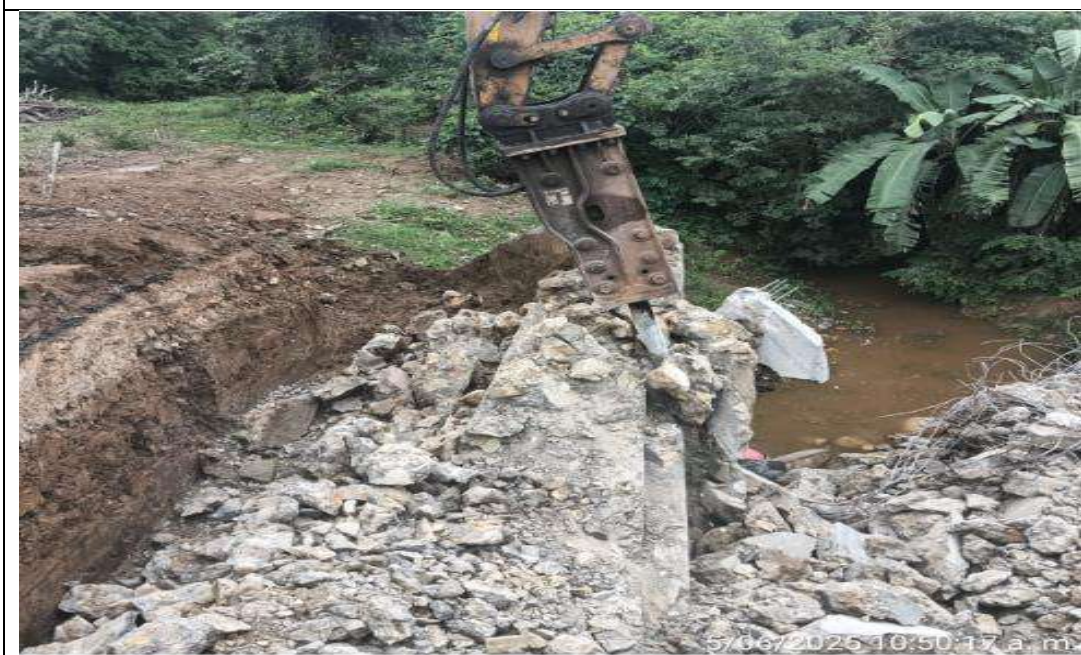
Box Culvert PR 34+658 lado derecho. Demolición de ODT existente.
