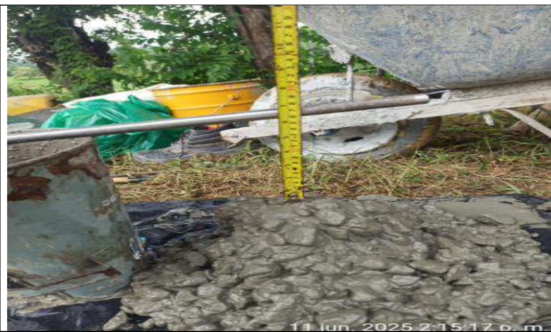
Disipador PR 8+856 lado derecho. Ensayo de asentamiento y toma de muestras al concreto utilizado en la fundida de los muros.
