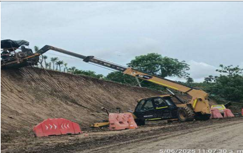
PR 45+480 a mayores, lado izquierdo. Perforaciones para instalación de pernos en talud.
