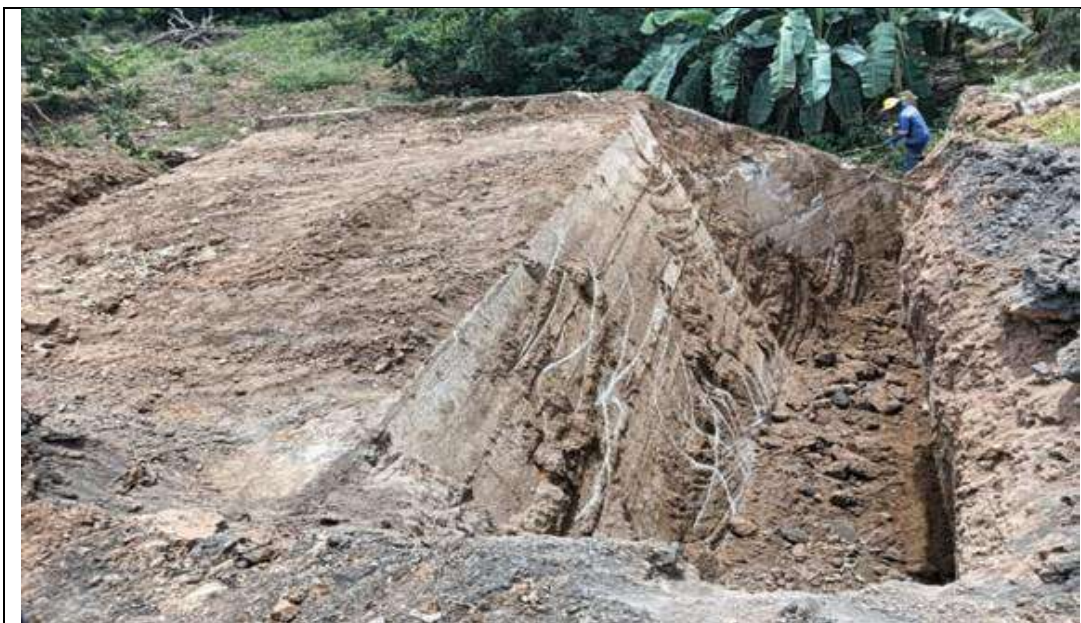
Box culvert PR 34+658 lado derecho. Se realizan actividades de excavación.
