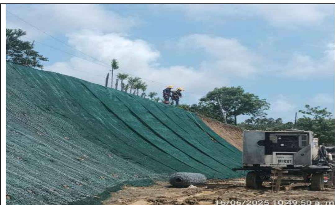
PR 45+480 a mayores, lado izquierdo. Instalación de malla triple torsión y geomanto para protección de talud.
