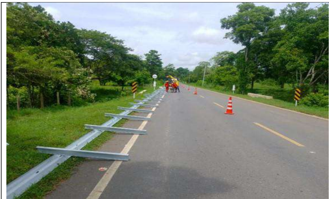
PR 5+420-PR 5+470 lado derecho. Instalación de defensas metálicas.
