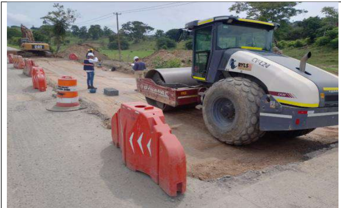
Broche PR 25+700-PR 25+725 lado derecho. Mejoramiento sobre carril.
