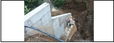
Muro de acompañamiento sentido norte del puente PR45+700 lado izquierdo.
