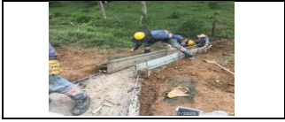
Instalación de formaletas para construcción de bajante PR34+450
