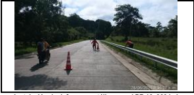
Instalación de defensas metálicas en el PR 10+900 lado izquierdo.
