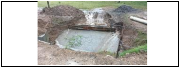
Instalación de concreto ciclópeo encole PR25+730 lado derecho
