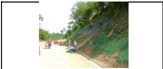
protección y estabilización de taludes con malla triple torsión, margen derecha PR 14+720
