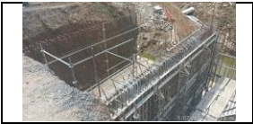
construcción de muro sur del box culvert del PR 34+658 lado derecho
