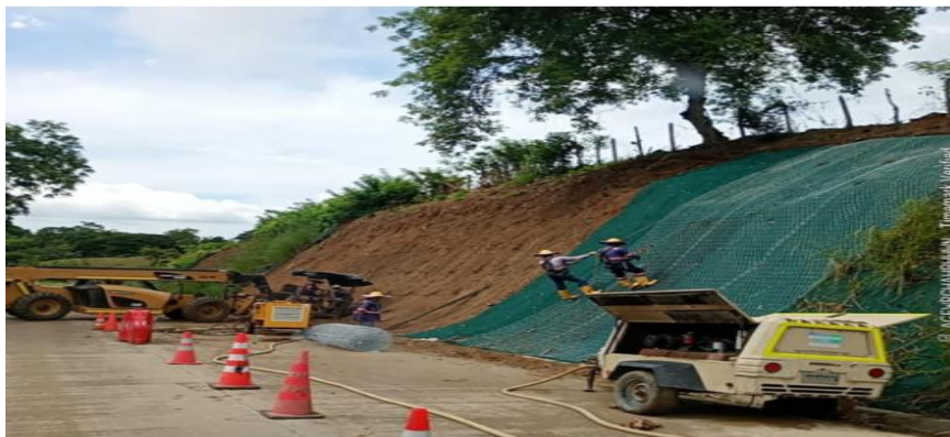
PR 26+360 lado derecho. Instalación de manto TRM 500 y malla triple torsión en talud.
