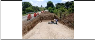
Mejoramiento con material de terraplén capa#2 sentido sur PR27+138 al PR27+150 carril derecho
