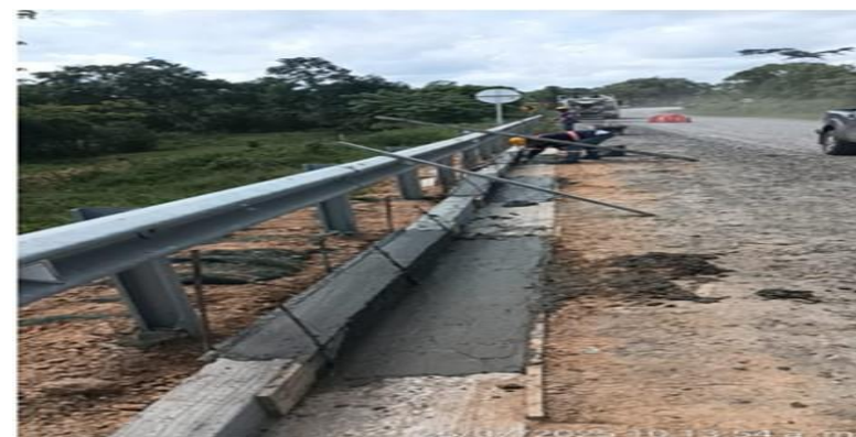
Fundida de cunetas en el PR 34+480 aproche puente.
