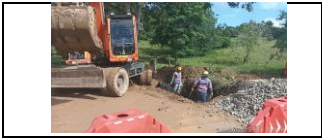
excavación para construcción de filtro lateral en el PR 25+730 lado izquierdo.
