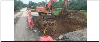
Excavaciones en el broche PR 27+130 lado izquierdo
