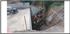
construcción aleta sur del box culvert del PR 34+658, lado derecho
