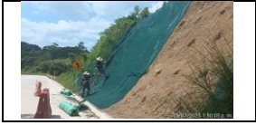
Instalación geomanto en el PR 26+410, lado derecho.
