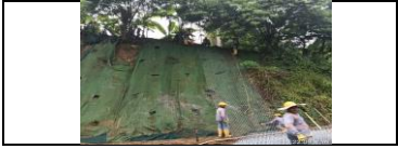
PR 13+950 lado derecho instalación de malla triple torsión.
