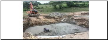
Construcción de losa en concreto ciclópeo en el encole de box culvert del PR 25+730, lado derecho.
