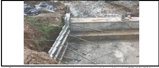
Construcción de muro norte de obra de mitigación del PR 25+730, encole de box culvert.
