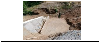
Construcción del filtro lateral del muro de acompañamiento del puente PR45+700 carril izquierdo estribo#2 sentido norte
