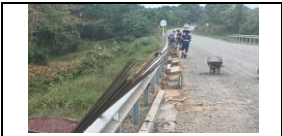
Adequación de terreno e instalación de formaleas para construcción de cunetas del lado derecho puente PR34+500 a menores lado derecho
