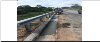
Construcción de cunetas - bordillo en el lado derecho del PR34+480
