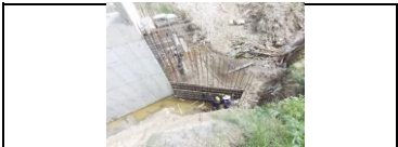
instalación de formaleas en aletas de cabezal ODT tipo box Culver, sentido sur margen derecha PR 34+658
