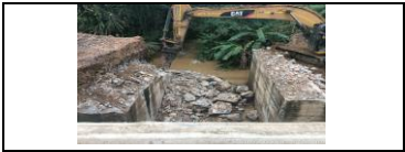
demolición de muros del box culvert del PR 44+300, lado izquierdo.
