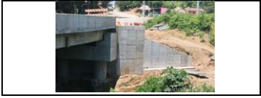
Muro de acompañamiento del puente del PR 45+700, lado izquierdo.
