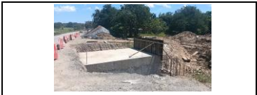
construcción de muro guardarruedas del box culvert del PR 34+658, lado derecho
