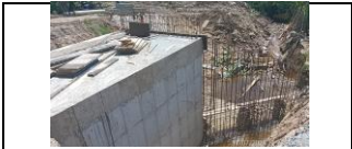
box culvert del PR 34+658 lado derecho construcción de losa superior e instalación acero de refuerzo muro guardarruedas
