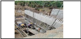
Construcción de muro norte box culvert del PR34+658 lado derecho
