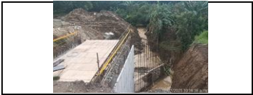
Instalación de tablero para construcción de losa superior del box culvert del PR 34+658 lado derecho
