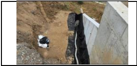
Construcción de filtro lateral en muro de acompañamiento puente 45+700
