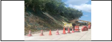
Perforaciones para instalación de pernos en el PR 14+700 lado derecho
