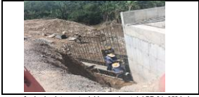
encofrado de aleta norte del box culvert del PR 34+658 lado derecho.
