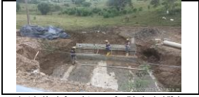
Instalación de formaletas para fundida de nivel #2 de disipador del PR 25+730 lado derecho
