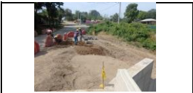
Relleno estructural sobre muro de acompañamiento en margen izquierda estribo 1 puente PR 45+700
