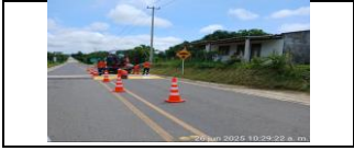
Instalación de pintura en resalto pompeyano PR18+950
