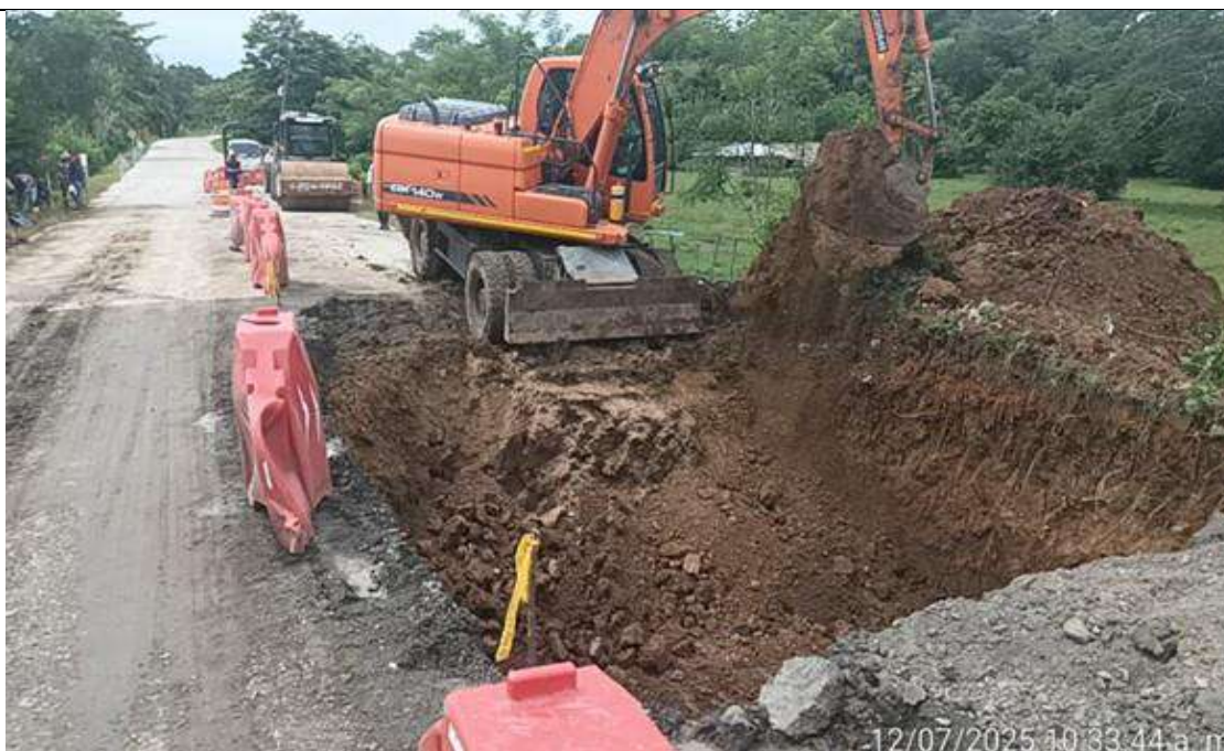
Broche PR 27+130 lado izquierdo. Excavaciones.
