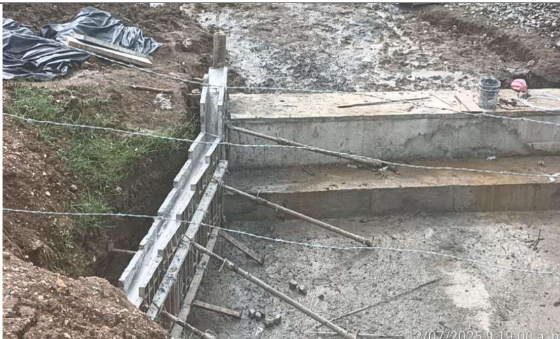
PR 25+730. Fundida de muro norte obra de mitigación.
