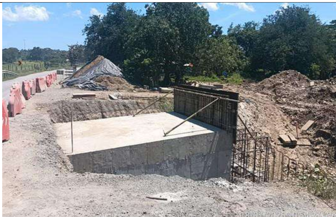
Box Culver PR 34+658, lado derecho. Instalación de formaletas muro guarda ruedas.
