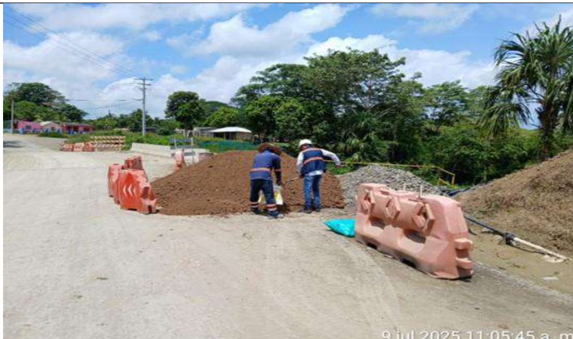
Puente PR45+700 lado izquierdo. Toma de muestras al material de terraplen utilizado para los llenos del muro de acompañamiento.
