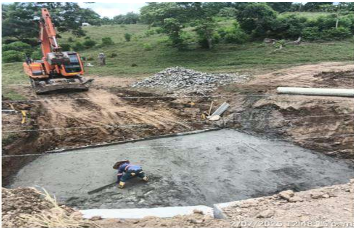
Box Culvert PR 25+730, lado derecho. Fundida de losa en concreto ciclópeo encofe.
