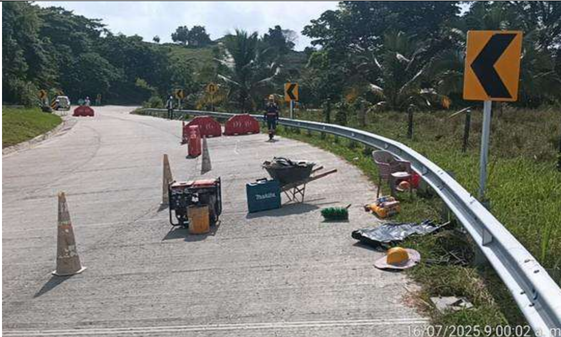
PR 10+582 a mayor, lado izquierdo. Reparación de losas en concreto MR 40 desde la losa #582 a la #590.
