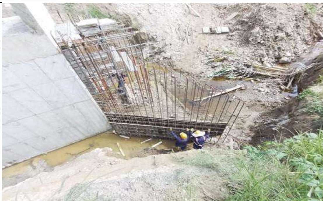
Box Culvert PR 34+658 lado derecho. Instalación de formaletas en aletas de cabezal.
