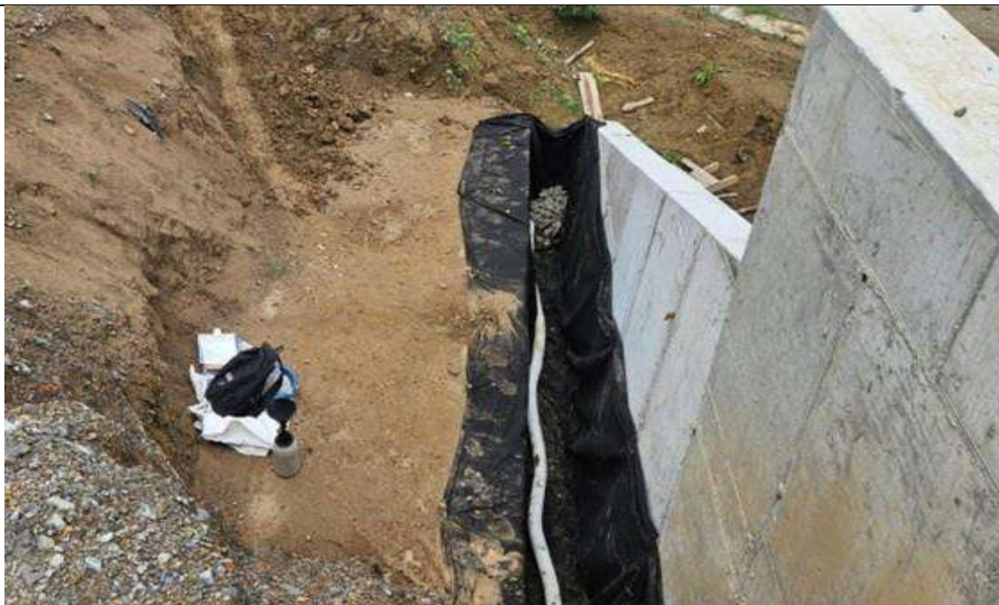
Puente PR 45+700. Instalación de formaleta y geotextil no tejido para construcción de filtro lateral en muro de acompañamiento en estribo.
