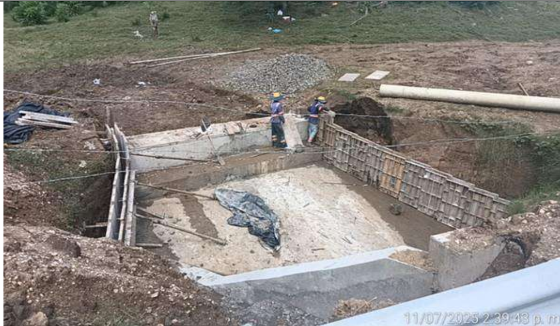
PR25+730 lado derecho. Instalación de formaletas para fundida de muros de obra de mitigación.
