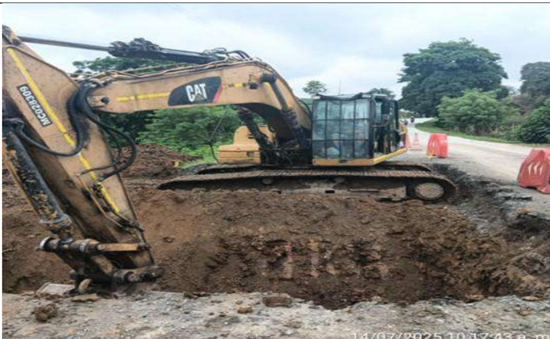
Broche PR 27+145 lado izquierdo. Excavaciones.
