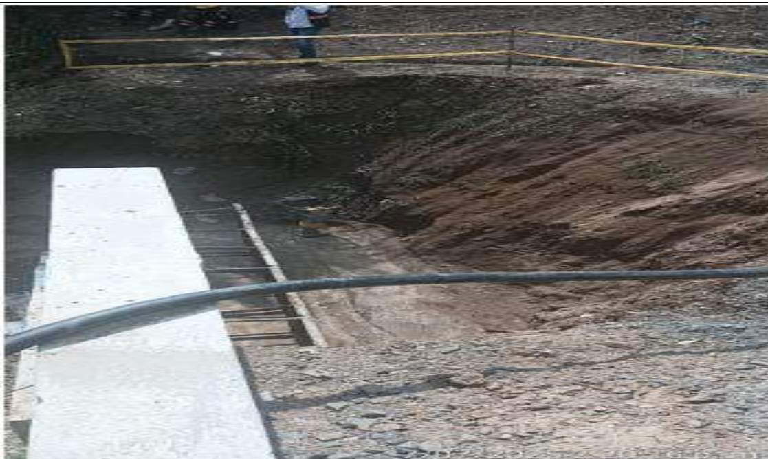
Puente PR 45+700 lado izquierdo. Lleno capa #1- estribo 2.
