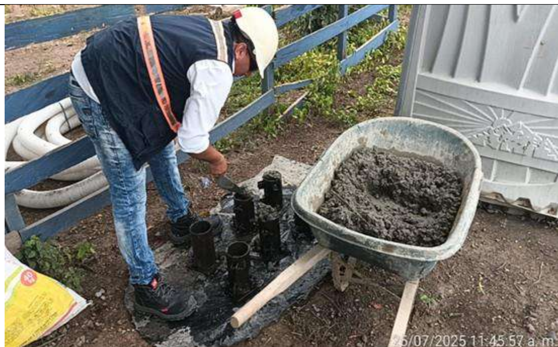
PR-34+658 lado derecho. Asentamiento y toma de muestras de concreto de 28MPA para la fundida de complemento de aleta sur.
