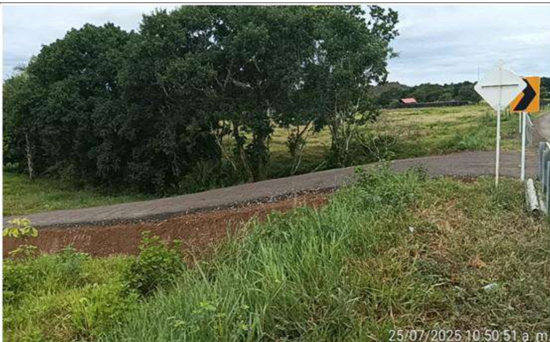
PR 34+650 lado izquierdo. Adecuación del acceso a predio.
