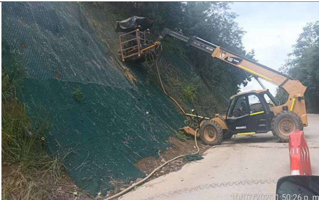
PR 14+710 a menor lado derecho. Perforaciones para instalación de pernos.
