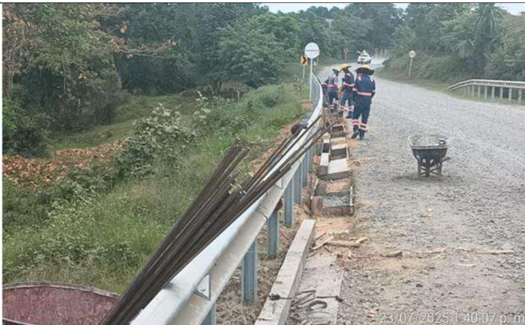
PR 34+500 a menor, lado derecho. Preparación de terreno para fundida de cunetas.
