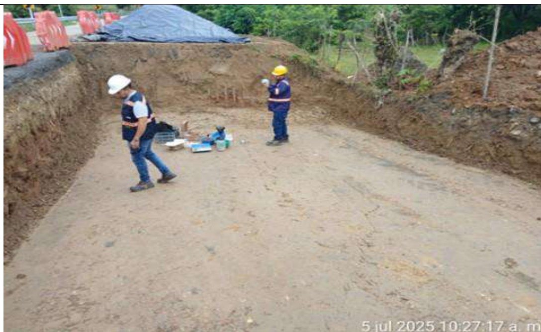
Broche PR27+138 al PR27+150 carril derecho. Toma de densidades en mejoramiento por sustitución con material de terraplén capa#1.
