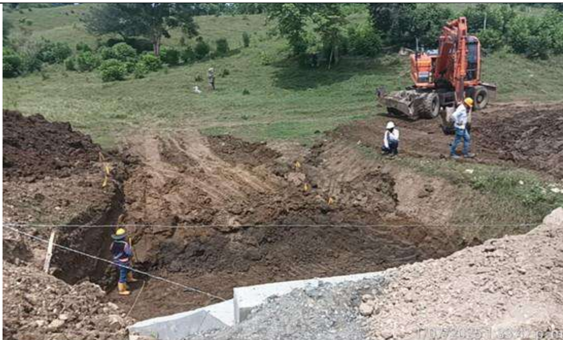
PR 25+730 lado derecho. Excavación para construcción de dissipador en encole de box culvert prefabricado.
