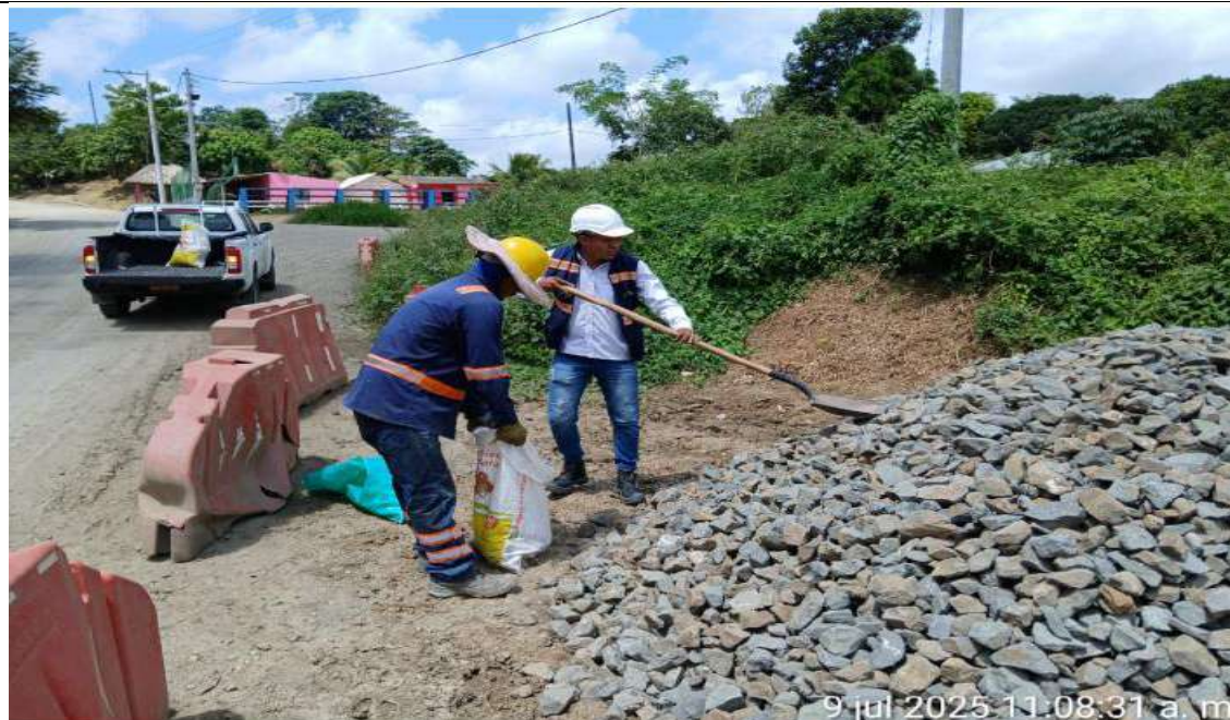
Puente PR45+700 carril izquierdo. Toma de muestras de material granular filtrante a utilizar en la construcción del filtro lateral del muro de acompañamiento estribo 2.
