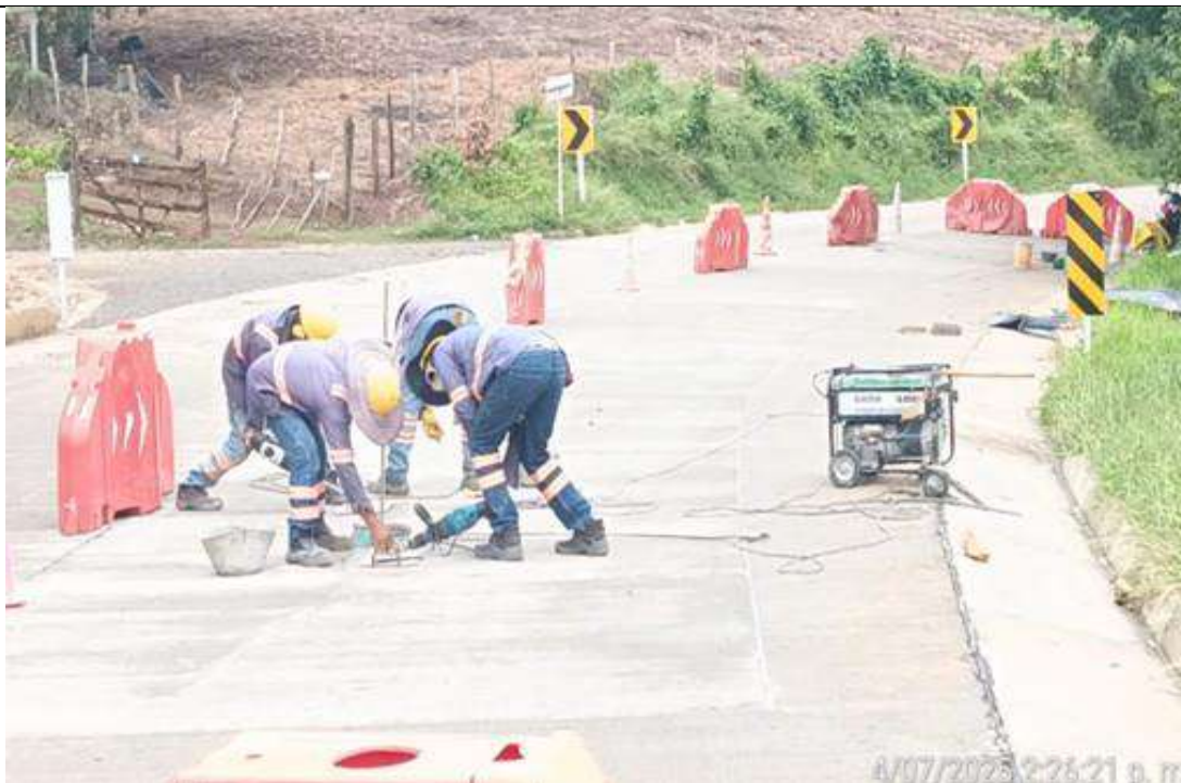
PR 10+398 carril izquierdo. Costura módulos de concreto MR40.
