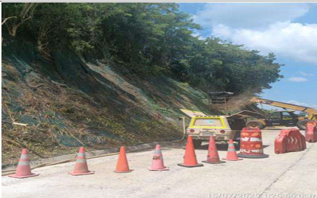
PR 14+700 lado derecho. Perforaciones para instalación de pernos.
