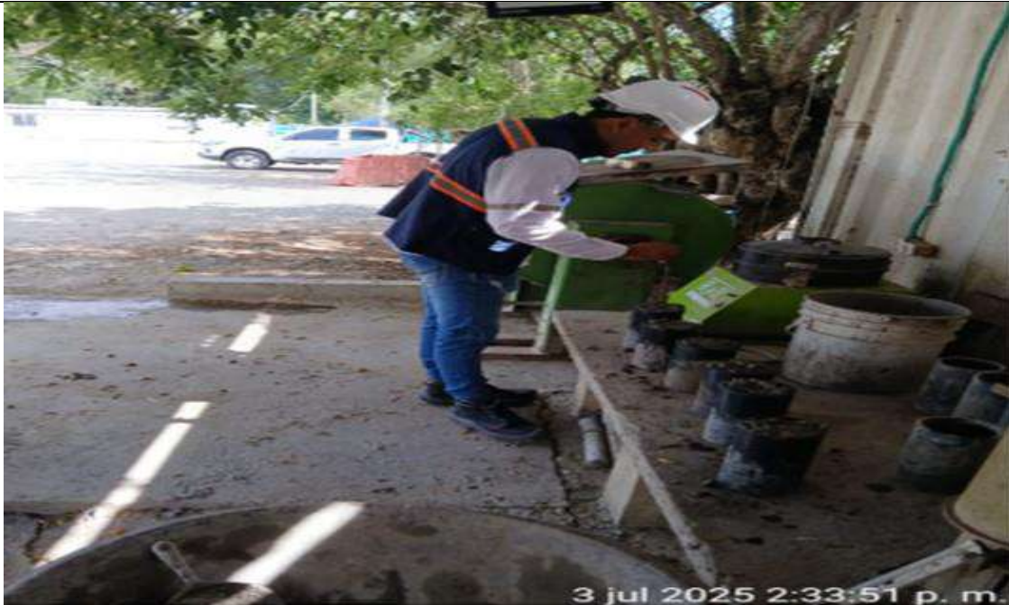
Toma de muestras concreto de 28Mpa para fundida del muro norte del box culvert PR34+658 carril derecho.
