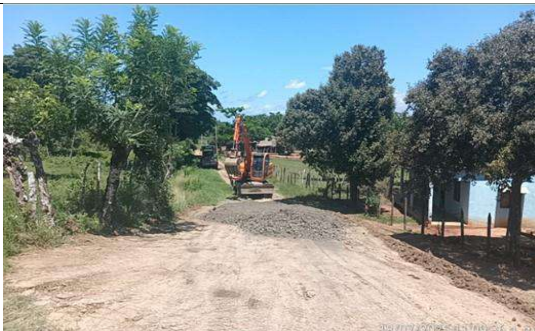
PR 27+780 lado izquierdo. Adecuación de acceso vereda Jobal.
