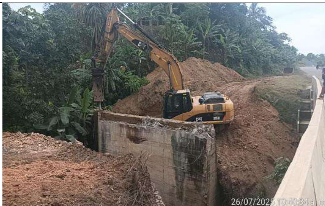
PR 45+300 lado izquierdo. Demolición de muros del box existente.
