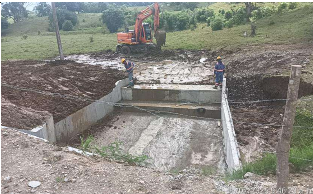
PR 25+730 lado derecho. Llenos con material de sitio en muros de obra de mitigación.
