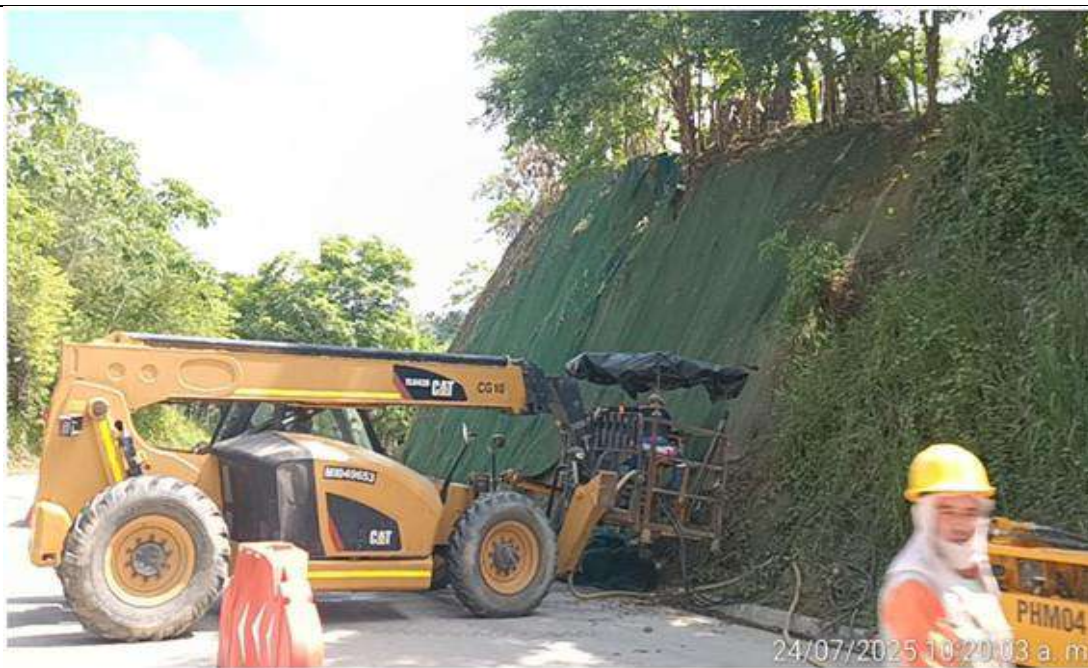
PR 13+900 lado derecho. Perforaciones en talud para la instalación de pernos.
