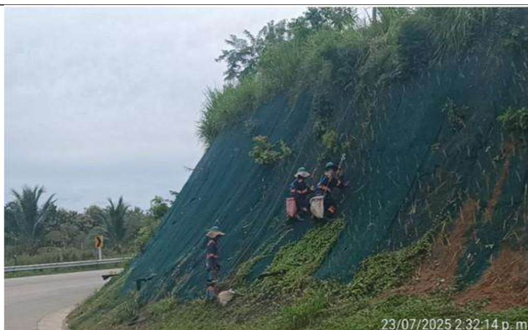
PR 10+600 lado derecho. Instalación de pasto vetiver.
