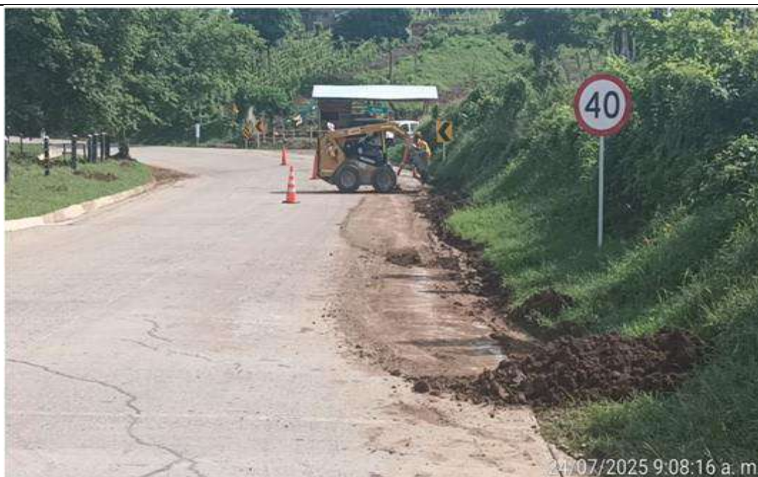
PR 10+300 a mayores de ambos lados. Limpieza de cunetas.
