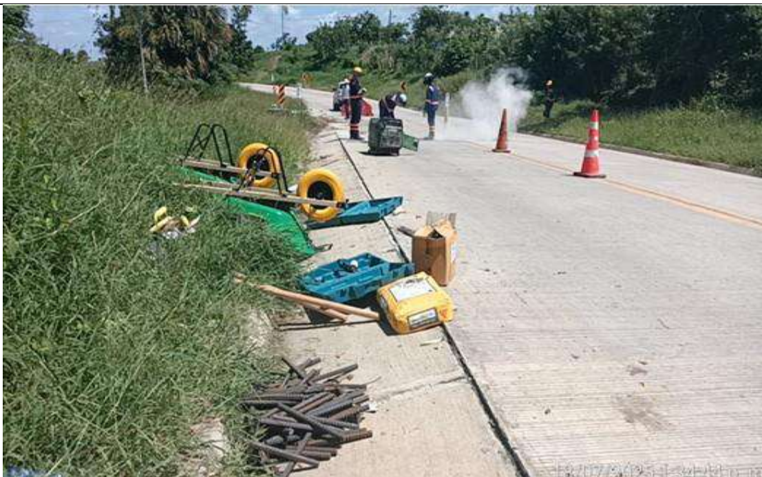
PR 8+938 lado derecho. Costura de losas en pavimento MR-40 a partir de la losa #211.
