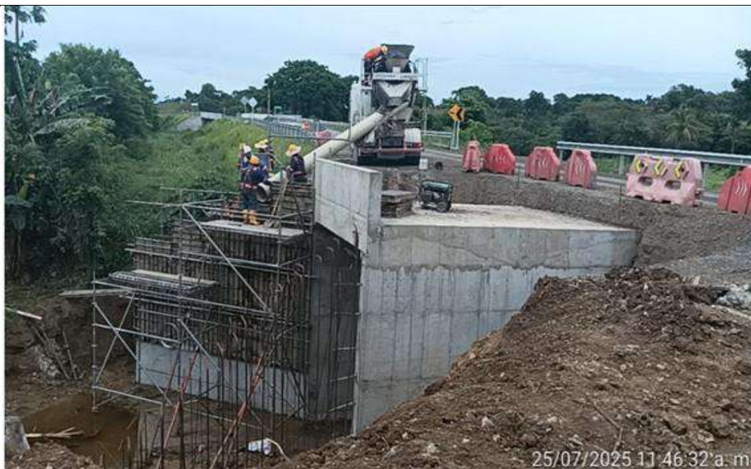
Box culvert PR 34+658 lado derecho. Fundida de complemento de aleta sur.
