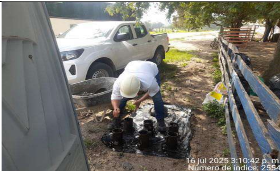
Box culvert PR 34+658, lado derecho. Toma de muestras de concreto y asentamiento en la fundida de losa superior.
