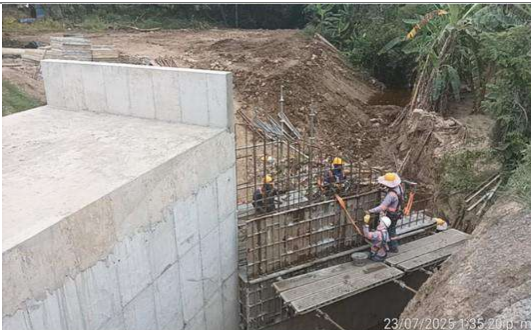
Box culvert PR 34+658 lado derecho. Instalación de formaletas para fundida de complemento de aleta sur.
