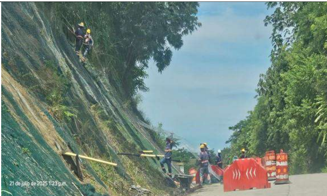
PR14+720 lado derecho. Trabajos de protección y estabilización de taludes mediante la instalación de malla triple torsión.
