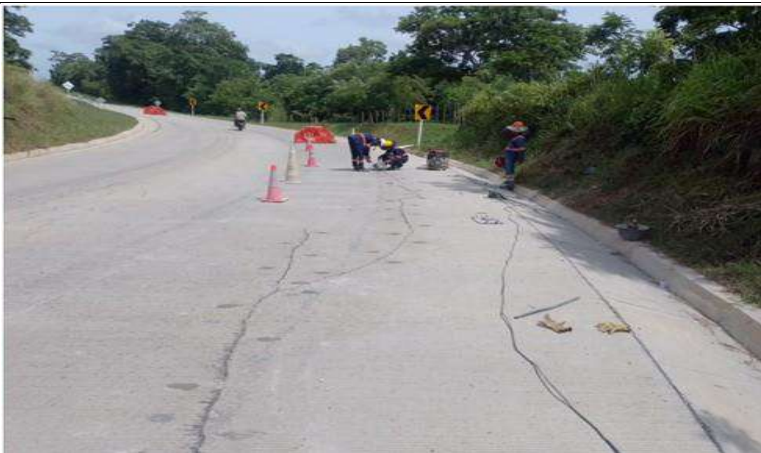
PR 10+830 a mayor, lado derecho. Reparaciones con sello y costura en módulos de concreto MR 40, módulos #635, #636, #637, #638.
