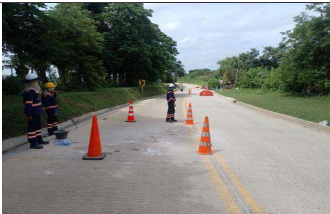
PR 9+045 a menor, lado derecho. Reparación de módulos de concreto MR 40 módulo #235.
