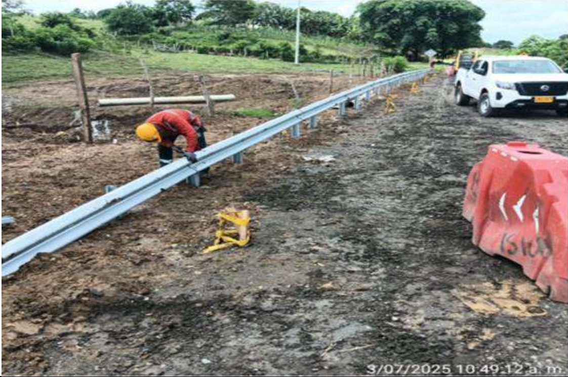
PR 25+700 a mayor lado derecho. Instalación defensas metálicas.
