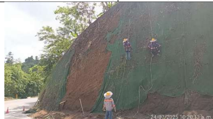
Foto 5. Instalación malla triple torsión PR 13+900 LD
