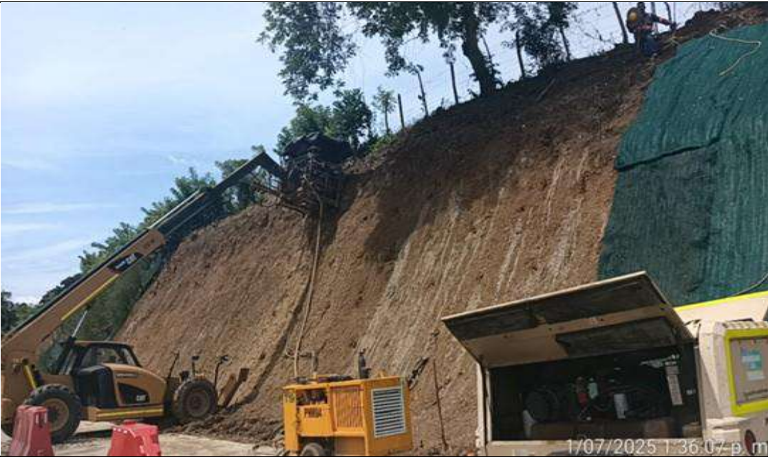
PR 26+352 a mayores, lado derecho. Perforaciones para instalación de pernos.
