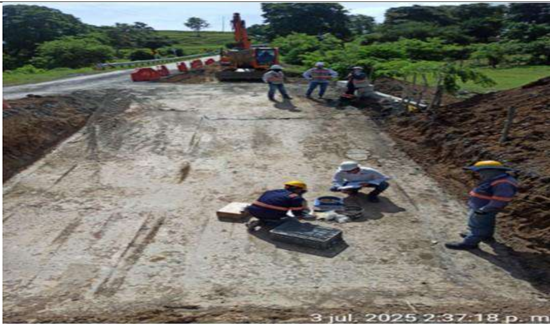
Broche PR27+120-27+130 carril derecho. Densidades a capa #1 de material de terraplén.
