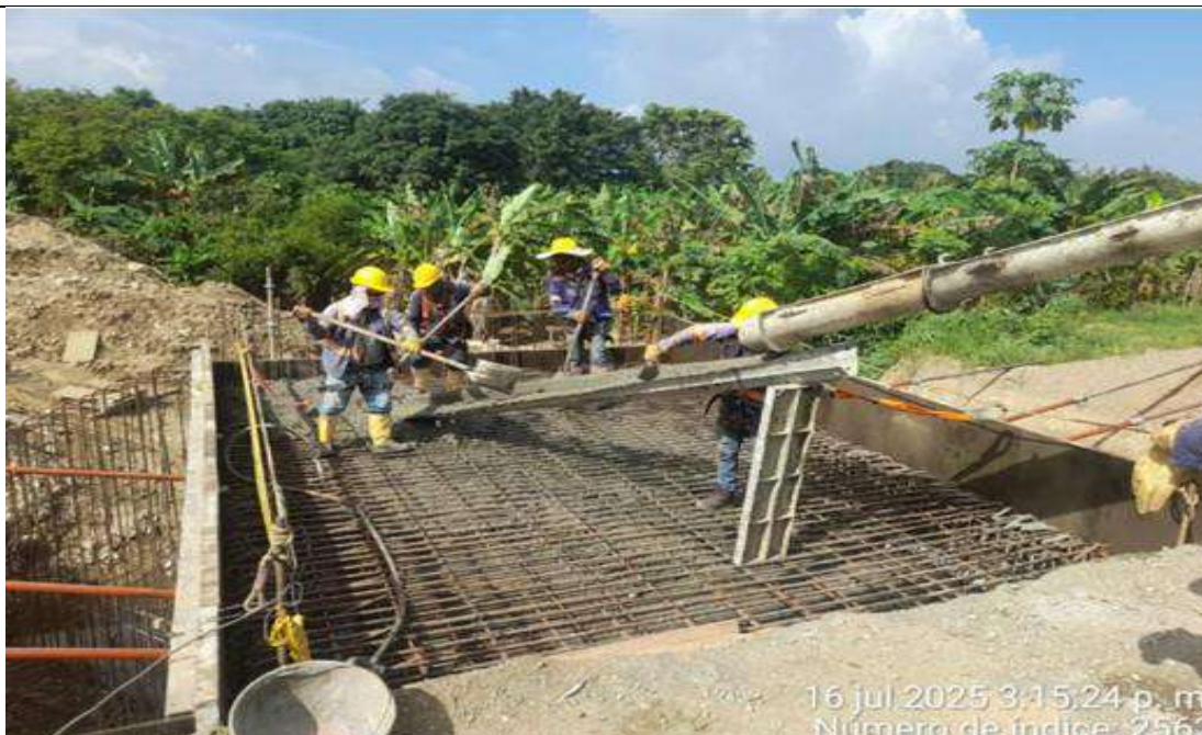
PR 34+658 lado derecho. Fundida de losa superior del box.
