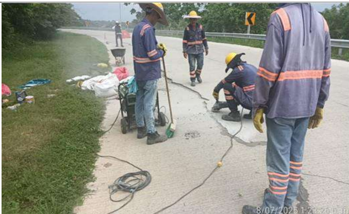
PR 28+785 lado derecho. Sello de grietas en losas de pavimento MR 40.
