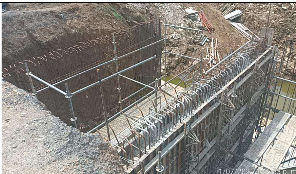
Box Culvert PR 34+658 lado derecho. Fundida muro sur.
