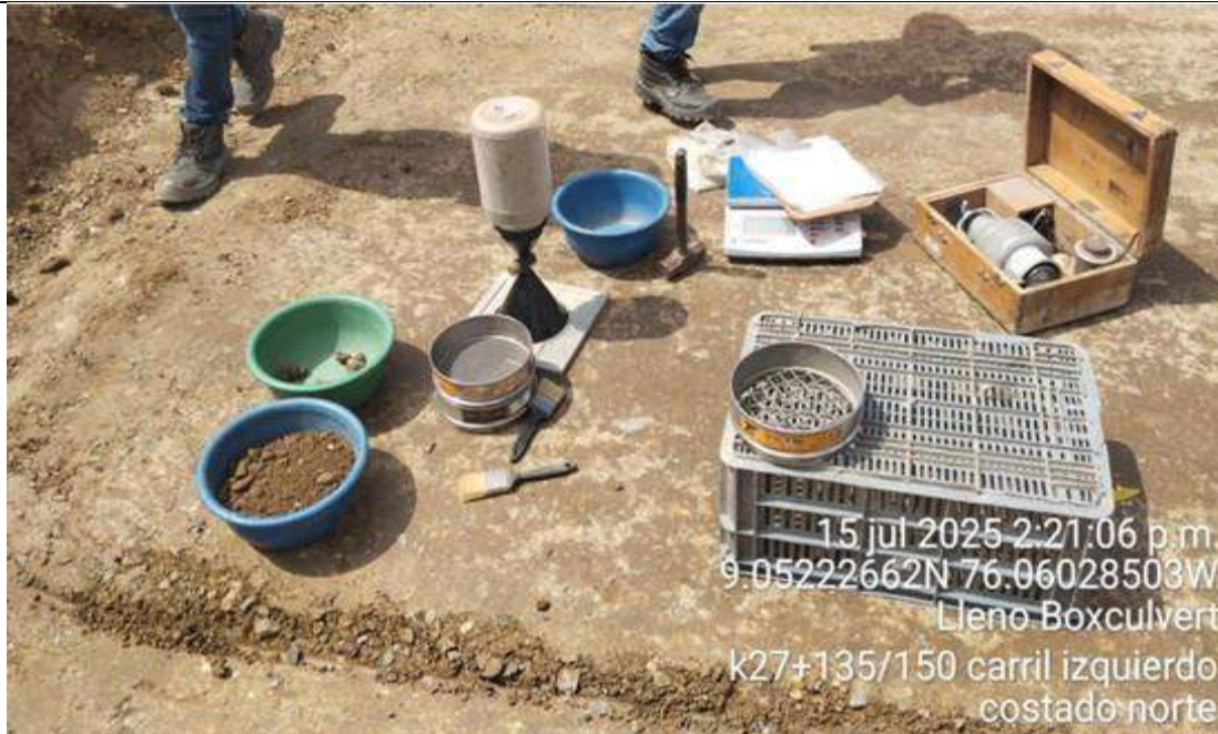
PR 27+135-27+150, lado izquierdo. Densidades en lleno BOX CULVERT sentido norte capa #2 y #3.
