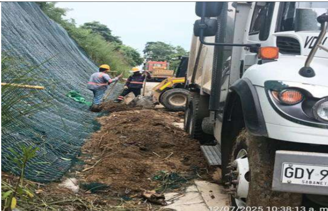
PR 26+348 a mayor lado derecho. Limpieza de cunetas colmatadas con material de talud.
