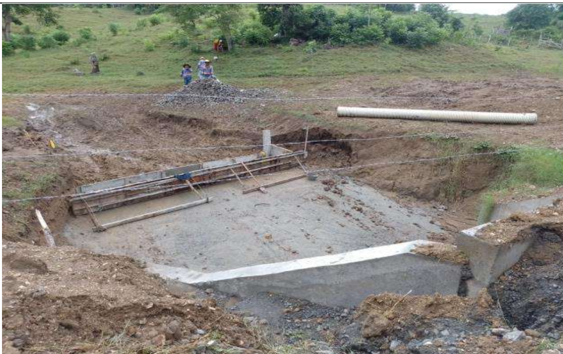
PR 25+730 lado derecho. Se realiza limpieza de encofe.
