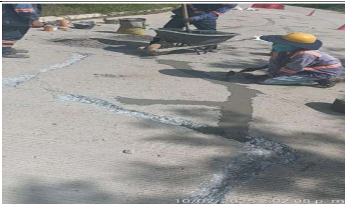
PR 13+245 losa #56 a menor carril derecho. Limpieza en losas con afectaciones severas (grietas de 6cm de ancho y desnivel), aplicación Zikadur 32 y sello con mezcla de concreto con grava de 1/4.
