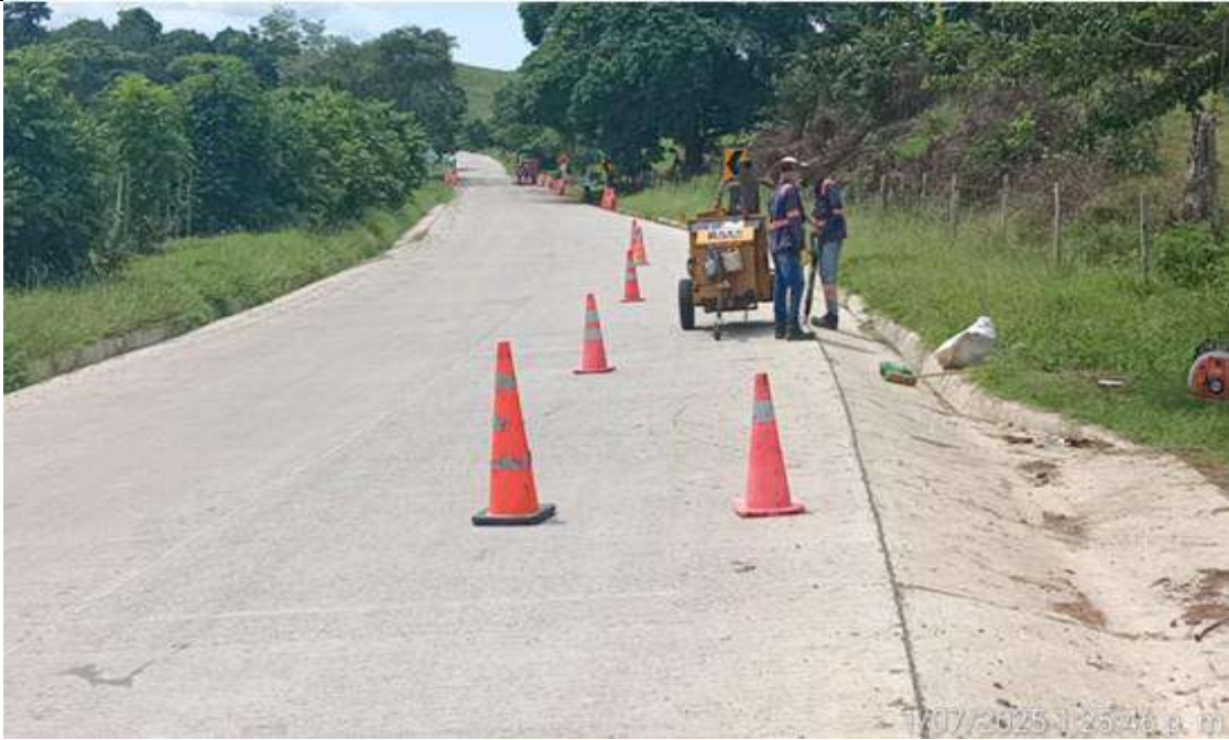
PR 25+600 lado derecho. Aplicación de Bituflex (sello de junta) entre pavimento y cunetas.
