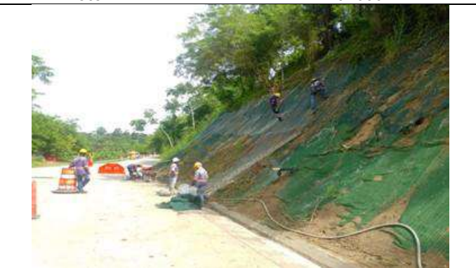
Foto 6. Instalación malla triple torsión PR 14+720 LD.
