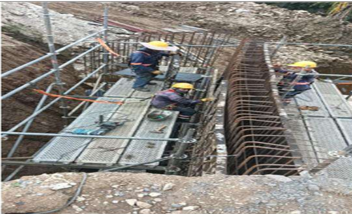
Box Culvert PR 34+658 lado derecho. Instalación de formaletas en complemento de muro norte.
