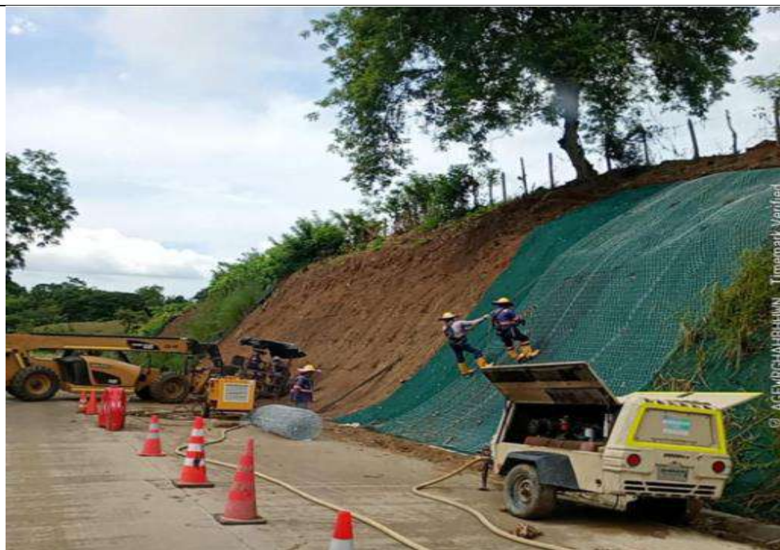
PR 26+360 lado derecho. Instalación geomanto y malla triple torsión en talud.
