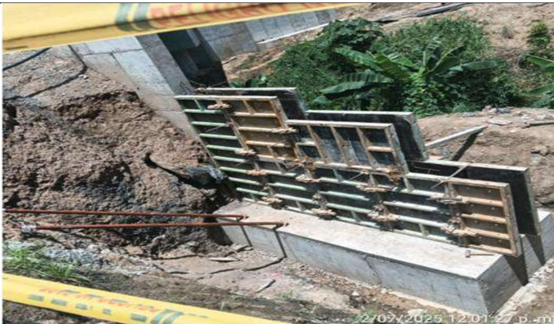
Puente PR 45+700, lado izquierdo. Encofrado muro de acompañamiento sentido norte.
