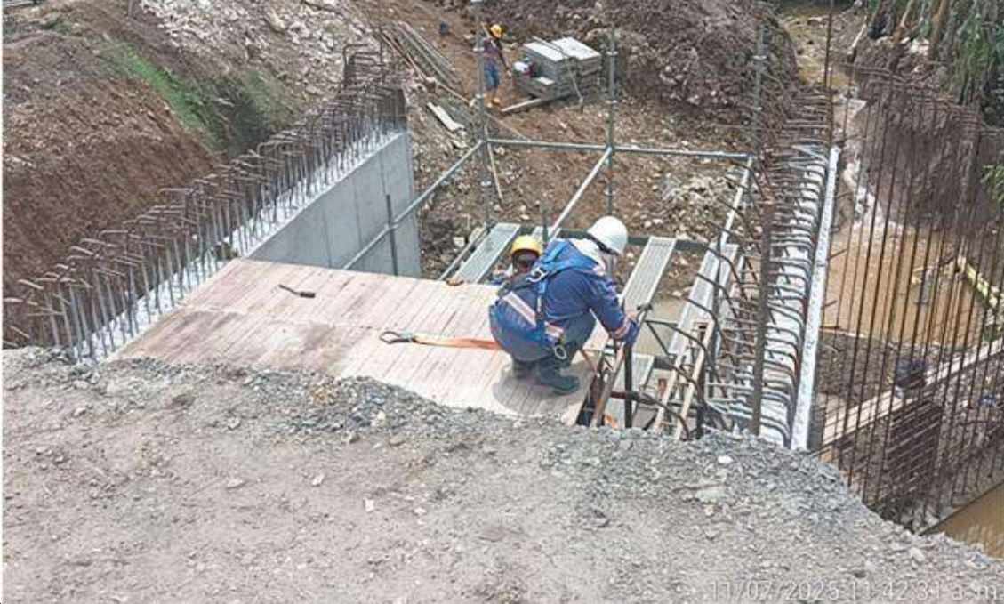
Box Culvert PR 34+658 lado izquierdo. Instalación obra falsa, soporte de losa superior.
