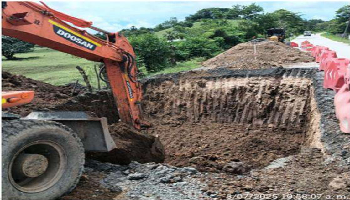
Broche PR 27+140 lado derecho. Excavación en carril derecho.
