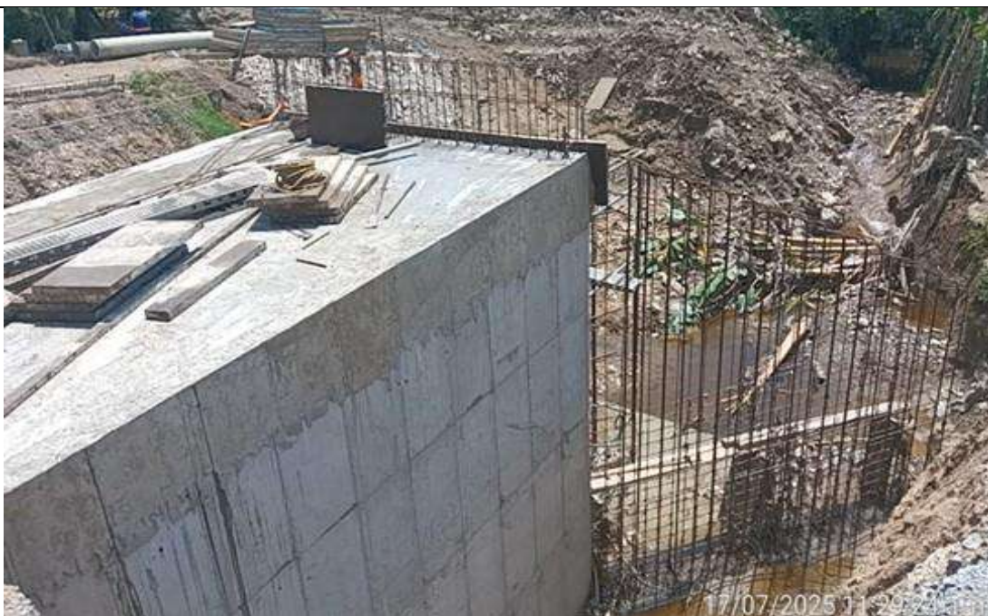
Box Culvert PR 34+658 lado derecho. Desencofre de losa superior e instalación acero de refuerzo de muro guarda ruedas.
