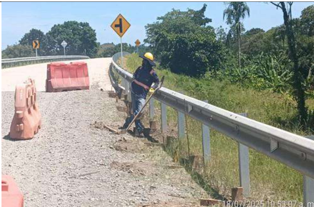
PR 34+500 lado derecho a menor. Adecuación de terreno e instalación de formaletas para construcción de cunetas.
