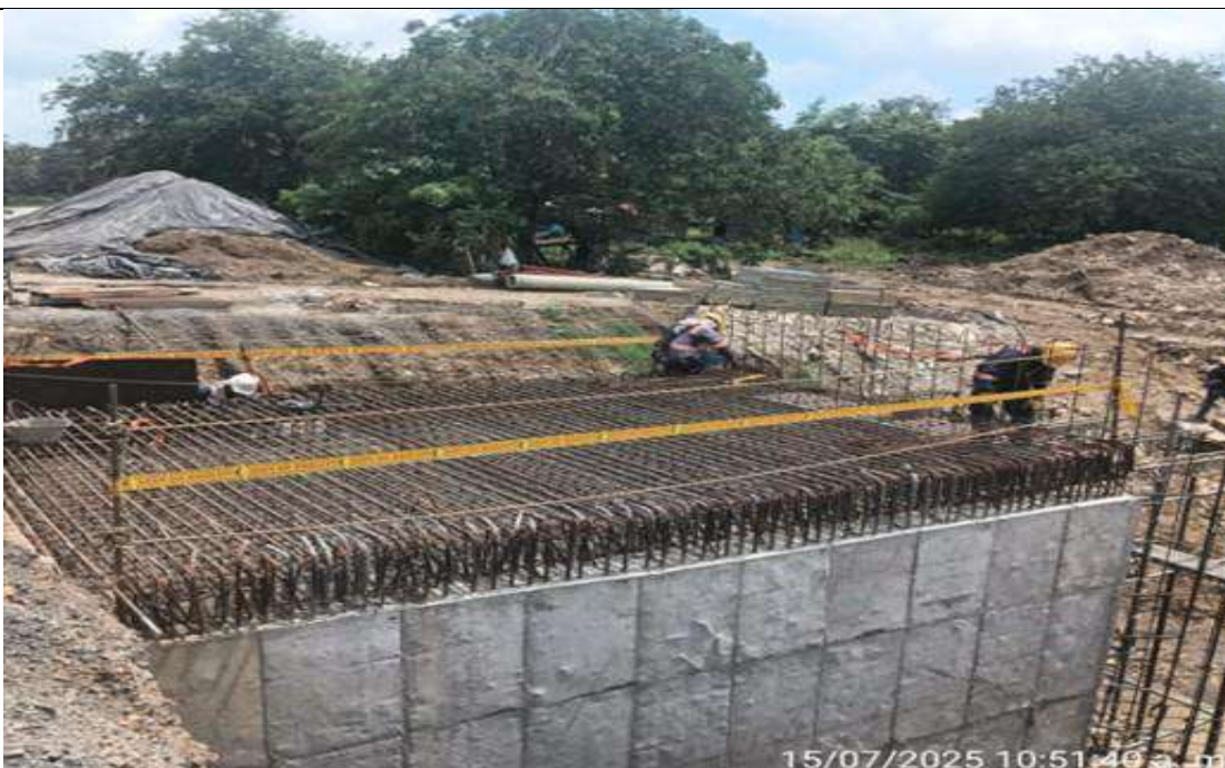
Box Culvert PR 34+658 lado derecho. Instalación acero de refuerzo losa superior.
