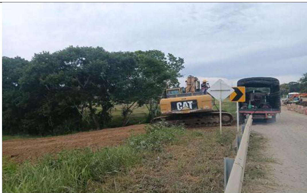
PR 34+650 lado izquierdo. Adecuación de acceso a predio con material de sitio.
