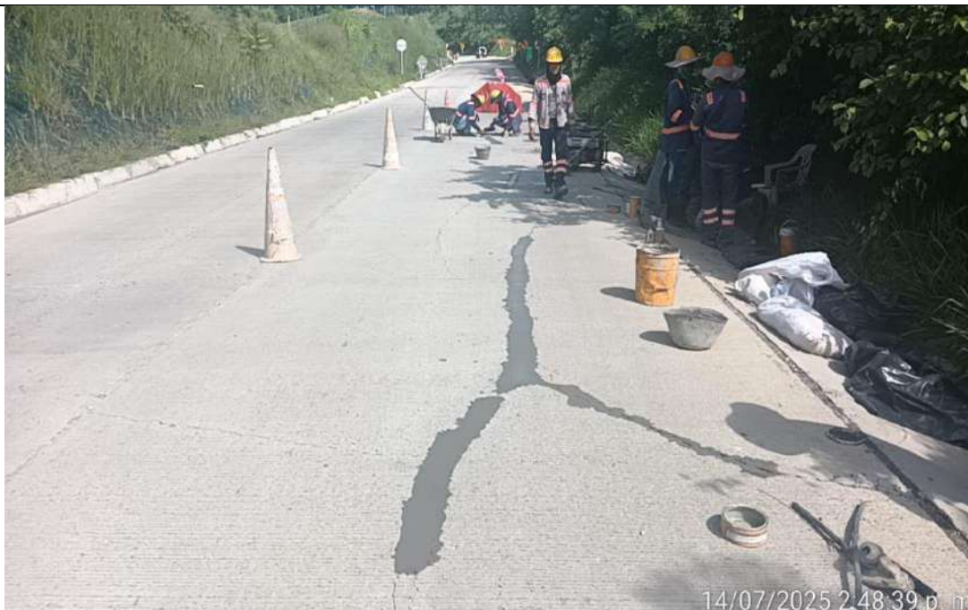
PR13+075 carril izquierdo entre las losas #14 a la #17. Adecuación y sellado de losas en concreto MR 40 que presentan grietas y desnivel.
