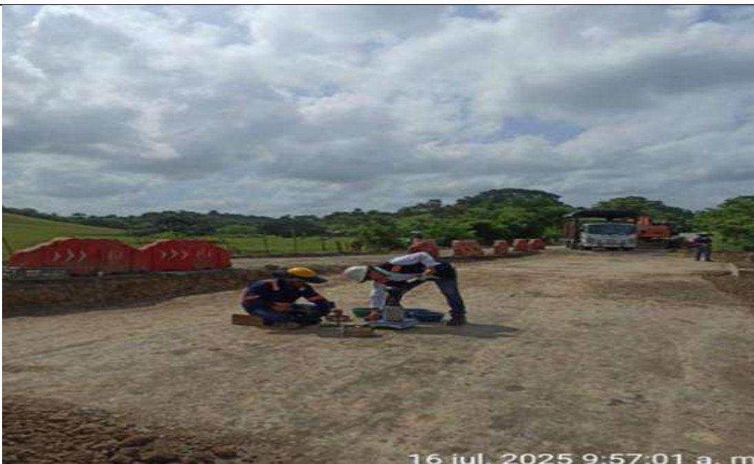
Broche PR 27+135- PR27+150, lado izquierdo sentido norte. Densidades a la capa #4 con material de terraplén.
