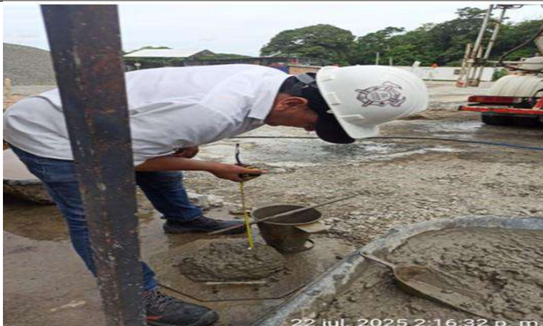
PR 34+658 lado derecho. Toma de muestras de concreto y asentamiento para la fundida de aleta cabezal box sentido sur.
