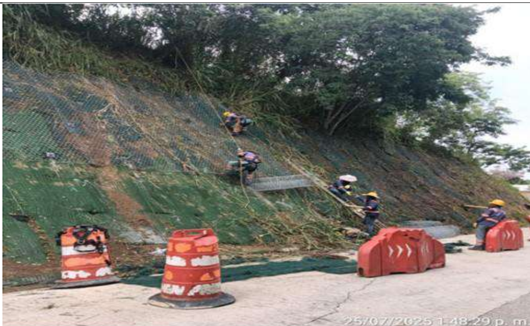
PR 14+700 lado derecho. Instalación malla triple torsión.
