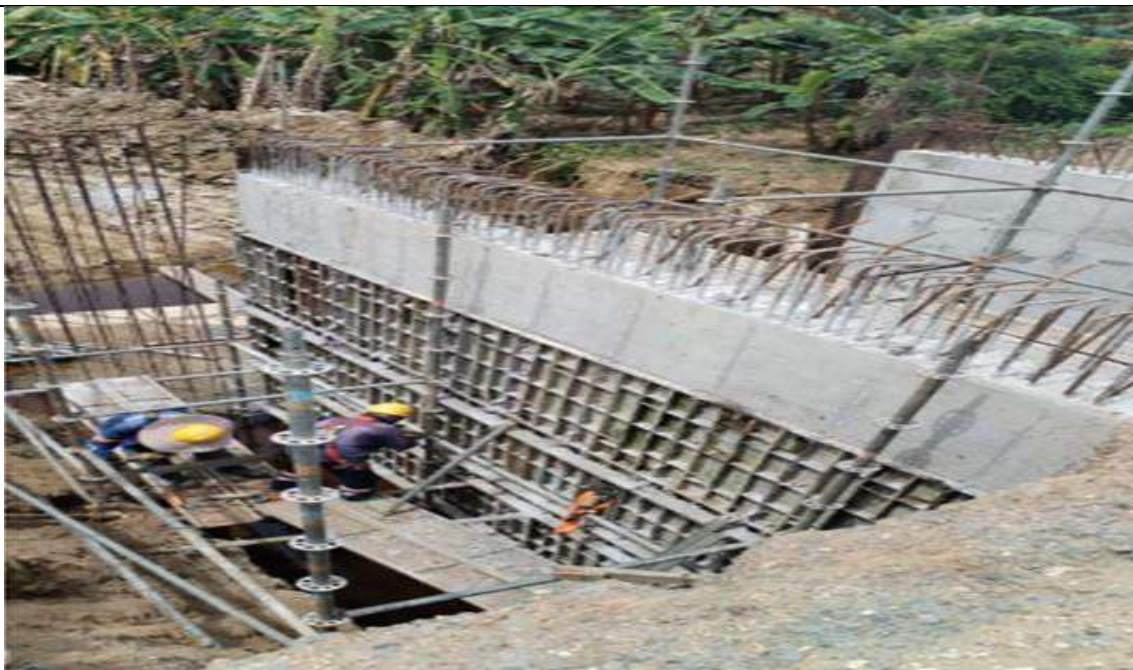
PR 34+658 lado derecho. Desenfoque muro norte.
