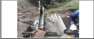
construcción de dissipador del PR 25+730, Lado izquierdo.
