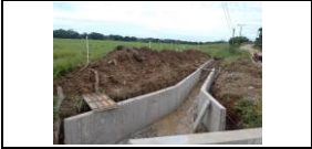
construcción de cárcamo de descole de ODT en lado izquierdo PR 35+340
