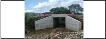
Box culvert del PR 34+658 lado derecho terminado
