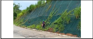
Instalación de pasto vetiver en el PR 11+600 lado derecho.
