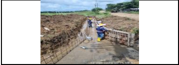
Intalación de formaletas para construcción de muros canal PR35+340
