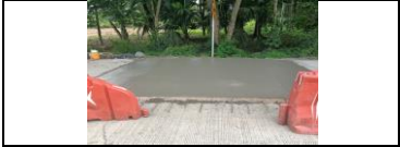
construcción de resalto Pompeyano en el PR 24+600, carril izquierdo
