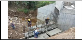
Construcción de aleta norte del box culvert del PR 34+655, lado derecho.
