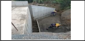
lleno en laterales del muro sur del box culvert del PR 34+658, lado derecho
