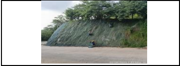
PR13+950 instalación de pasto vetiver
