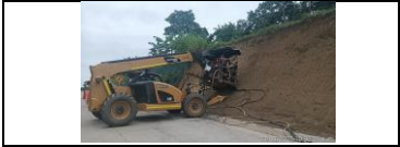
Perforaciones para instalación de pemos PR13+110 lado derecho
