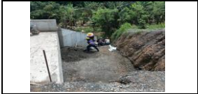
Relleno estructural laterales box culvert del PR 34+658 lado derecho
