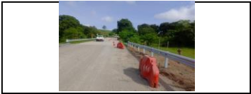
Instalación de defensa metálica en margen izquierda y derecha PR 27+130
