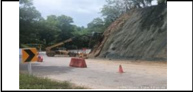
PR 13+950 Lado derecho perforaciones para instalación de pemos.
