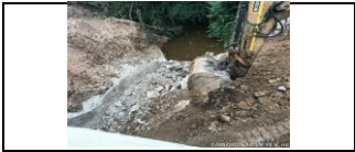
demolición de box culvert del PR 45+300 lado izquierdo.
