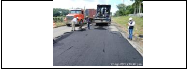
Instalación de mezcla asfáltica para parcheo PR0+070 carril derecho
