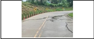
I nstalación de delineadores lado izquierdo PR 8+800 al PR 8+854
