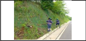
instalación de hoyos abonados en talud margen derecha PR 5+000 a menores
