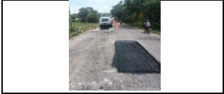
Mantenimiento de via del PR0+000 al PR2+150
