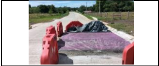
Construcción de resalto pompeyano PR28+680 carril izquierdo
