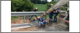
Construcción de bajante en zona de terraplén, en el PR 34+400 lado derecho
