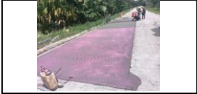
Reconstrucción de módulos en concreto MIR40 carril derecho del PR 10+069 al 10+087.
