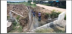
Instalación de acero de refuerzo para construcción de muros del canal PR35+340 lado izquierdo
