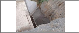
relleno con material de afirmado en laterales de box, carril derecho PR 34+658
