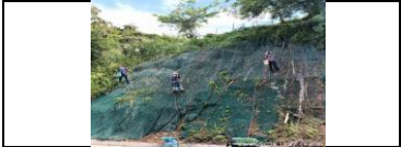
Instalación de pasto vetiver PR 14+710 lado derecho.
