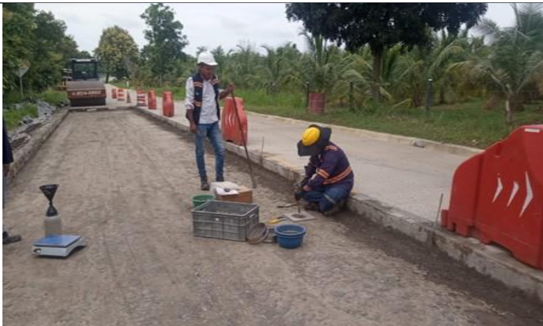
PR 10+065 -10+100 lado derecho. Densidades y espesores a subbase granular.
