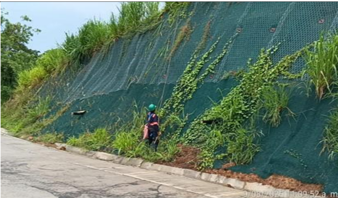
PR 11+600 lado derecho. Instalación pasto vetiver.
