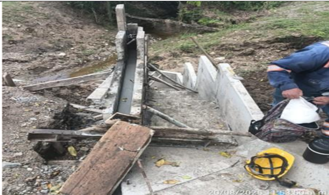
PR 25+730, lado izquierdo. Fundida de muro disipador.
