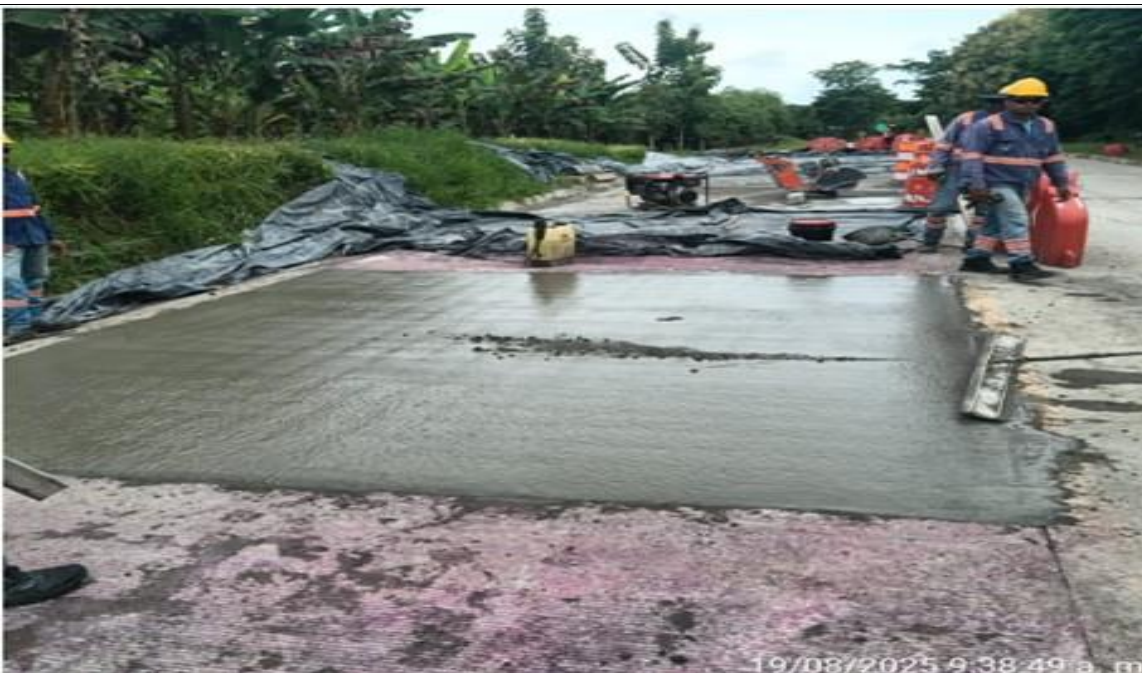
PR 9+731.5 lado derecho. Fundida del módulo 389.
