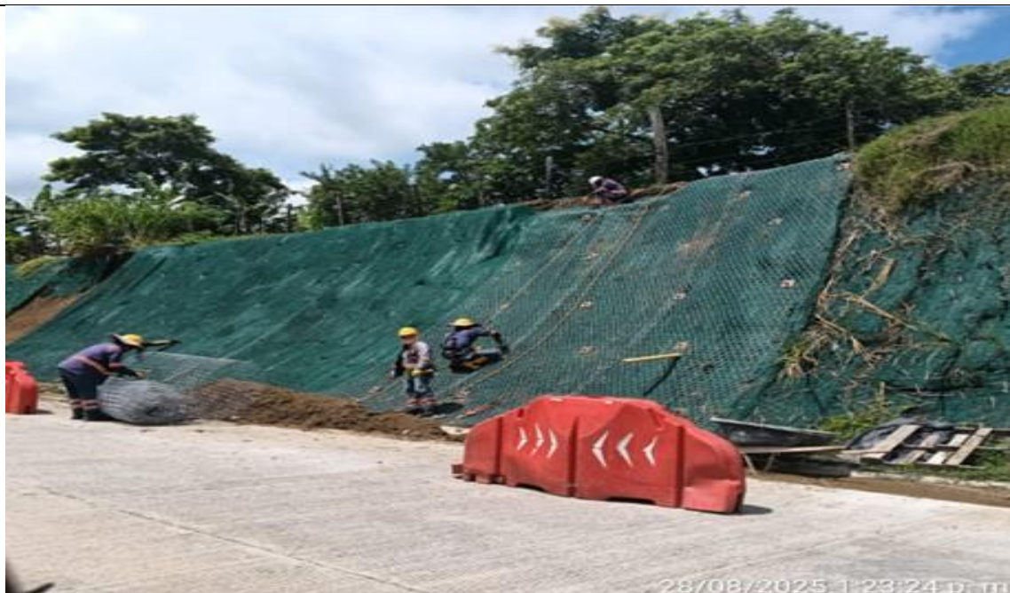
PR 13+100 lado derecho. Instalación malla triple torsión.
