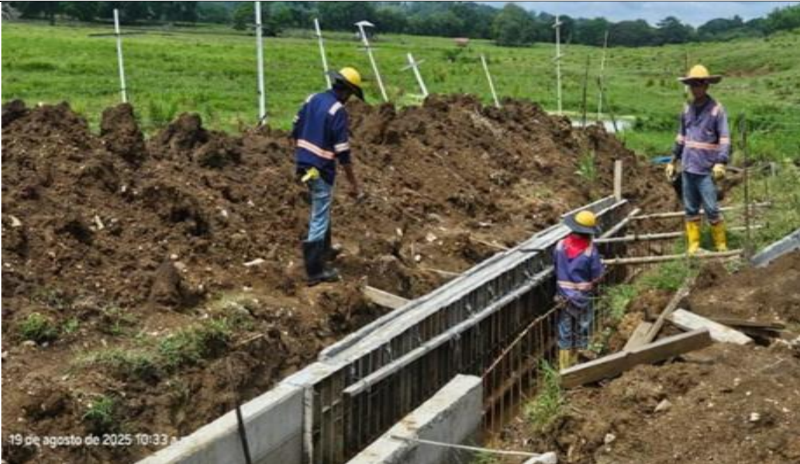
PR 35+340 lado izquierdo. Desencofrado muros del canal en descole de ODT.
