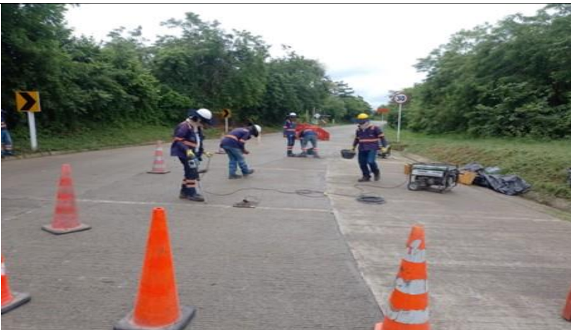
PR 11+250 lado derecho. Costura de losas en concreto MR40.
