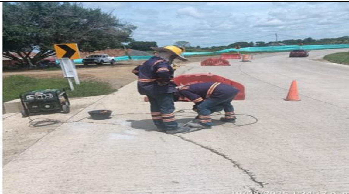
PR 13+740 lado derecho. . Costura de losas en concreto MR40.
