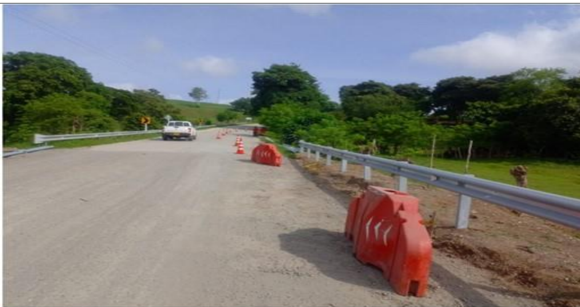
PR 27+130 lado izquierdo y derecho. Instalación de defensa metálica.
