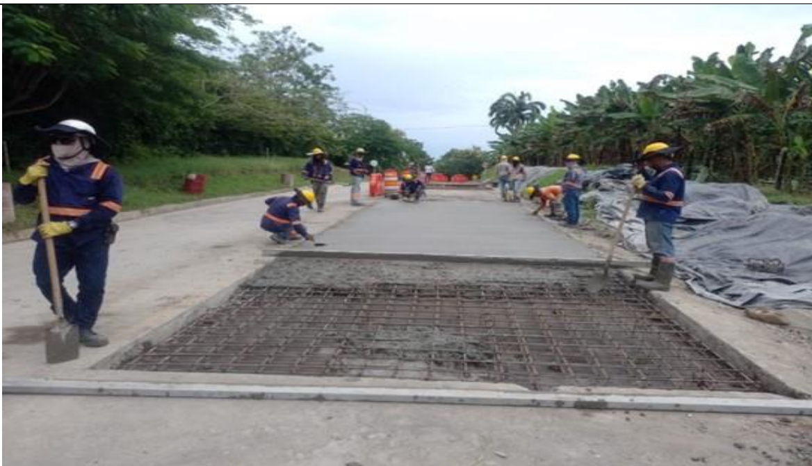
PR 9+700 al PR 9+713.5 lado derecho. Fundida de módulos de concreto reforzado MR 40.
