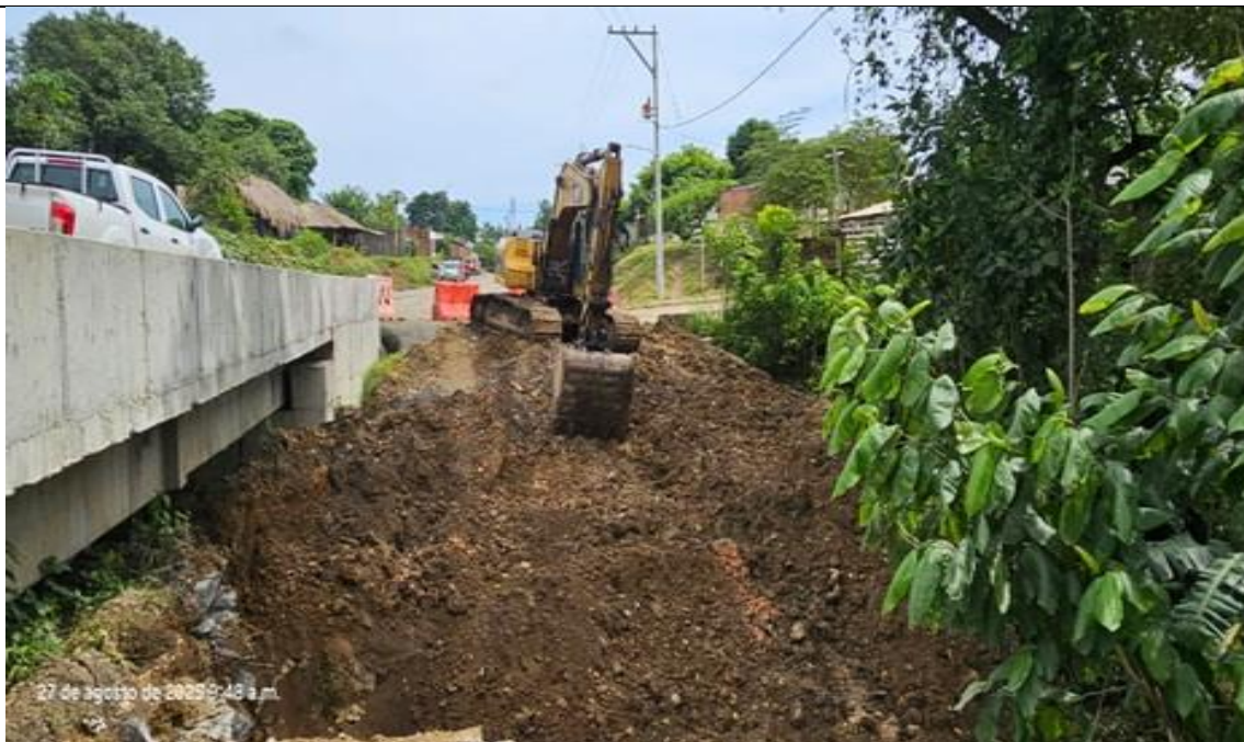
PR 45 + 700 lado derecho. Demolición pontón existente.
