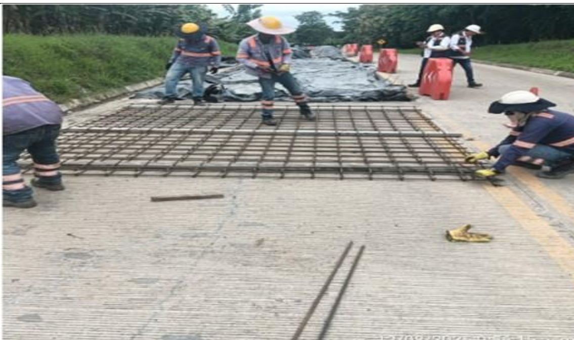
PR 9+700 a mayor. Instalación acero de refuerzo para fundida de módulos en concreto MR40.
