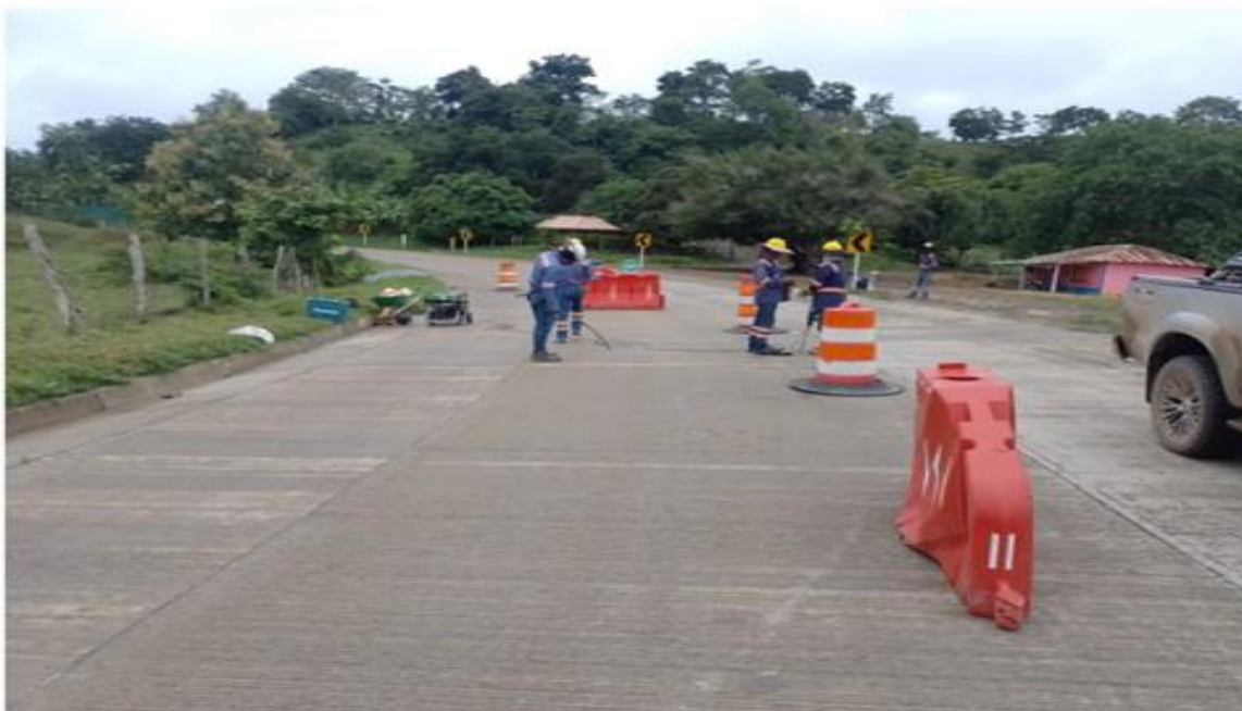
PR 13+680 lado izquierdo. Costura de losas en concreto MR40.
