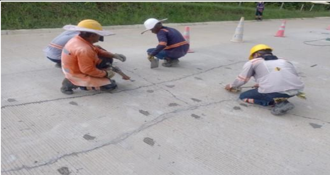
PR 11+100 a mayor carril derecho. Sello y costura de módulos de concreto MR 40.
