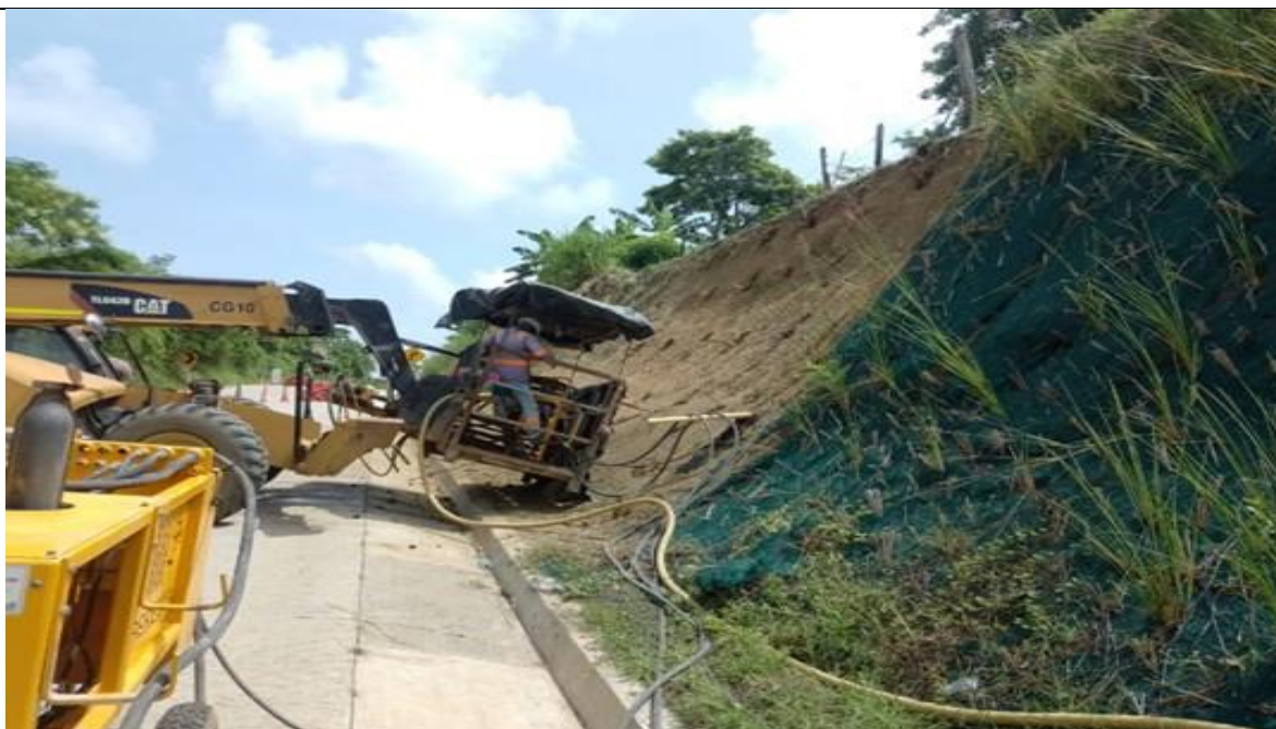
PR 13+100 a mayor, lado derecho. Perforación e instalación de pernos, para la estabilidad y protección de taludes.
