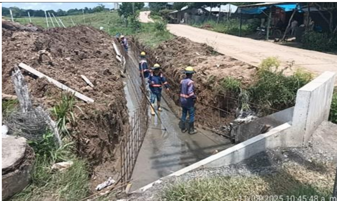
PR 35+340 lado izquierdo. Instalación acero de refuerzo muros del canal.
