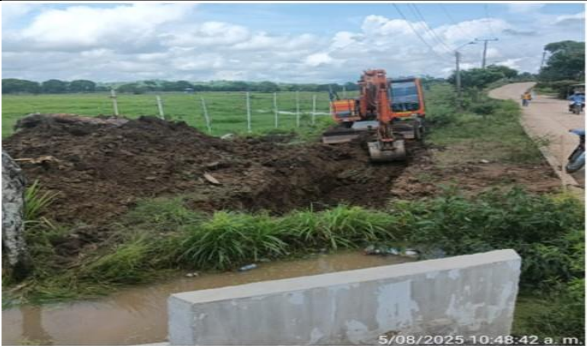
PR 35+340 lado izquierdo. Excavación para construcción de canal.
