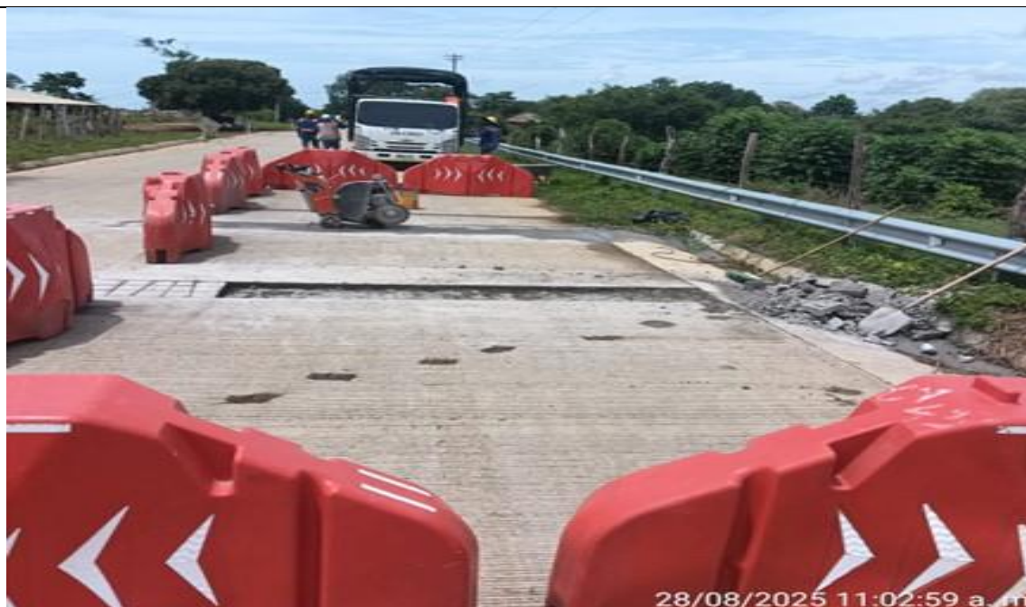
PR 29+250 carril derecho. Demolición para construir resalto tipo Pompeyano.
