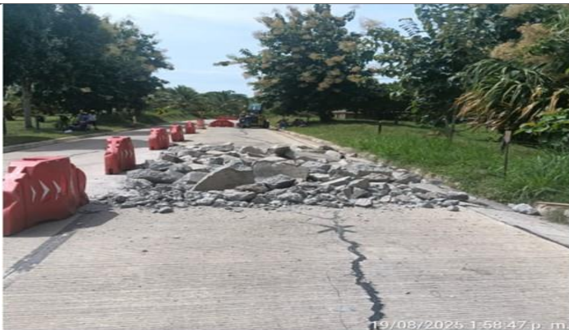
PR 10+276 lado derecho. Demolición de los módulos 465 al 472.
