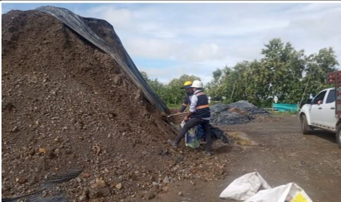
PR 13+500 lado derecho. Muestreo a material de terraplén cantera villa Carmen.
