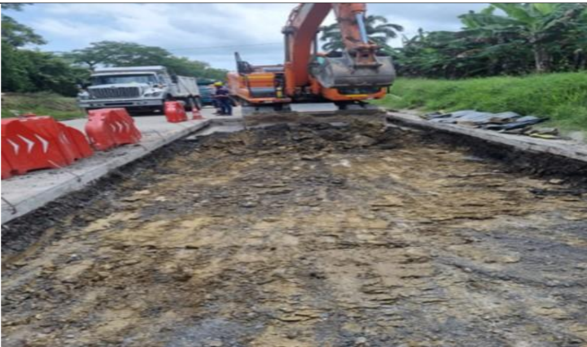
R 9+700 al PR 9+713.5 lado derecho. Excavación y retiro de SBRA.
