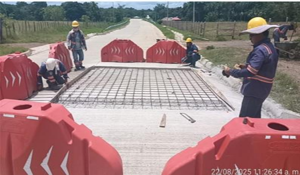
PR 28+680 carril izquierdo. Instalación de acero de refuerzo para fundida de resaltó tipo Pompeyano.
