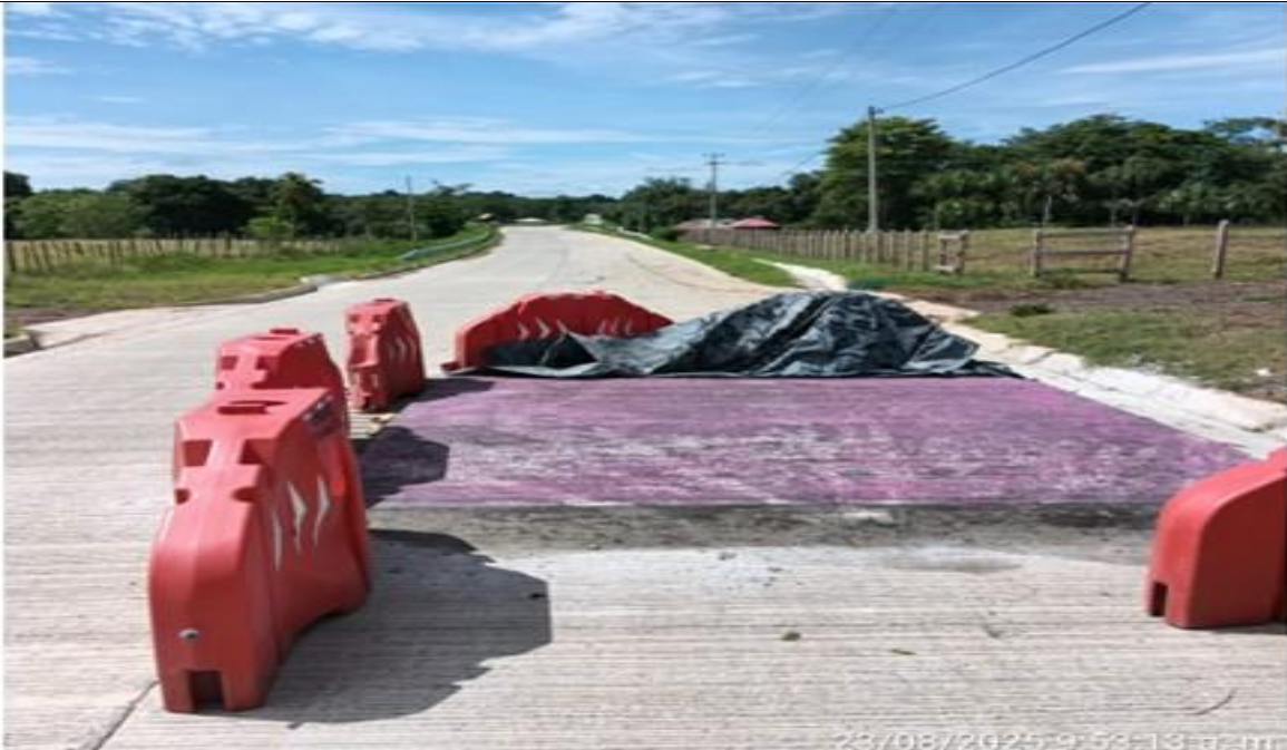
PR 28+680 carril izquierdo. Fundida de resalto tipo Pompeyano.
