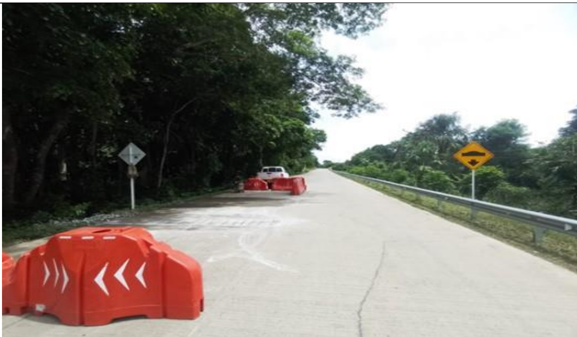
PR 24+600 carril izquierdo. Cortes para demolición de sección de anclaje para la construcción de resaltó tipo pompeyano, módulo #425.
