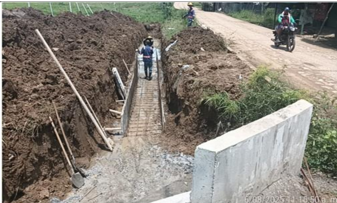
PR 35+340 lado izquierdo. Instalación de acero y formaletas para fundida de losa y muros de canal.
