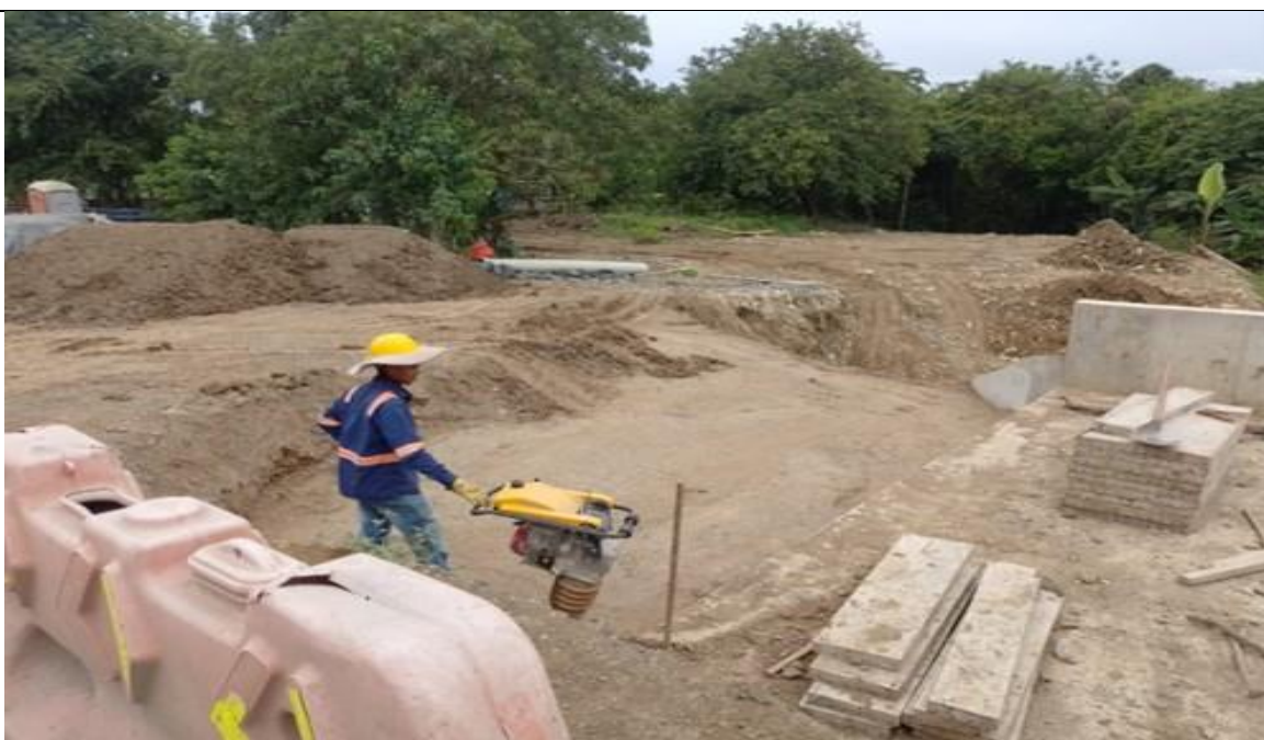
PR 34+658 lado derecho. Llenos estructurales con material de afirmado en zona lateral de ODT tipo box.
