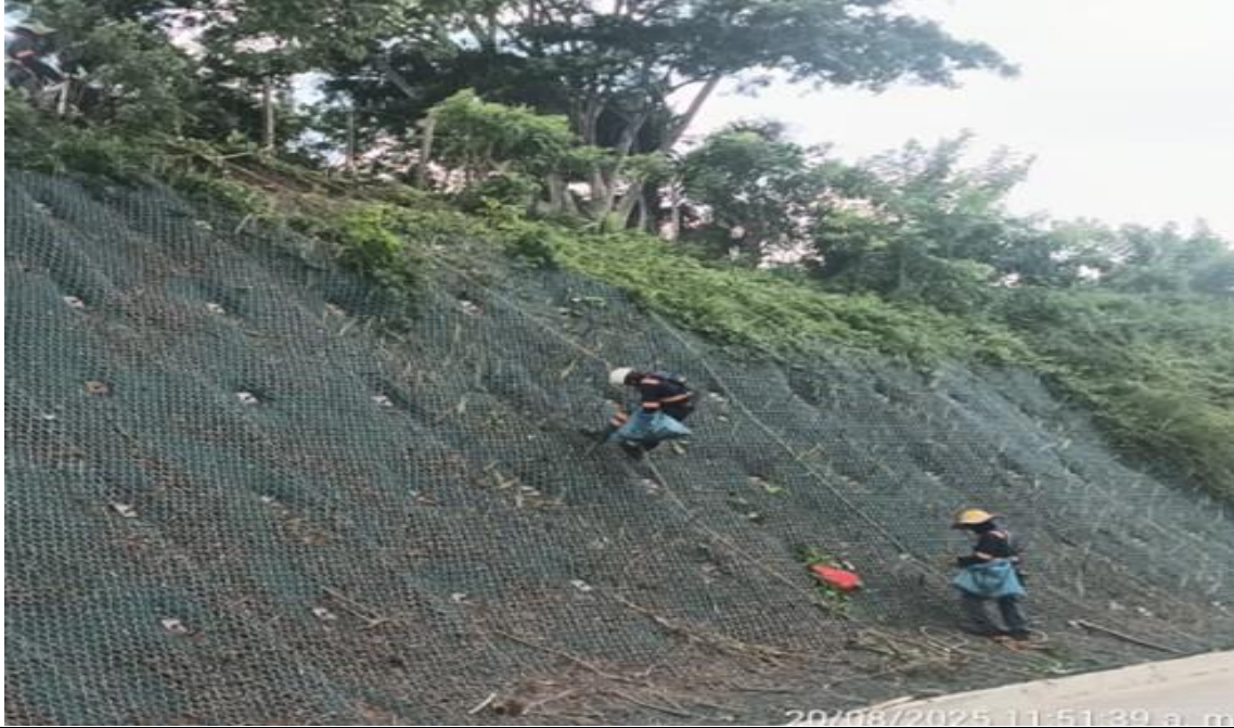
PR 26+400 lado derecho. Instalación pasto vetiver.
