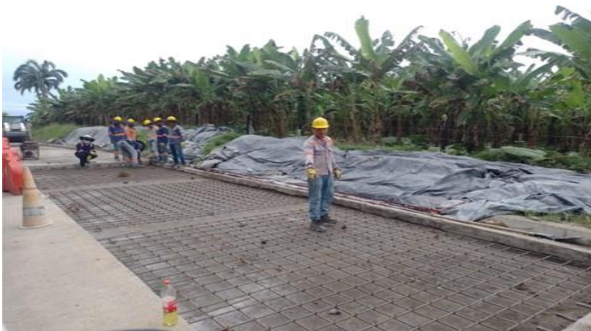
PR 7+700 al PR 9+713.5 lado derecho. Instalación de acero de refuerzo para módulos en reconstrucción.
