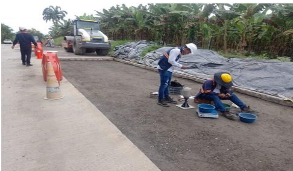
PR 7+700 al PR 9+713.5 lado derecho. Toma de densidades en material granular tipo Sub basé en zona donde se realiza reconstrucción de módulos de concreto MR 40.
