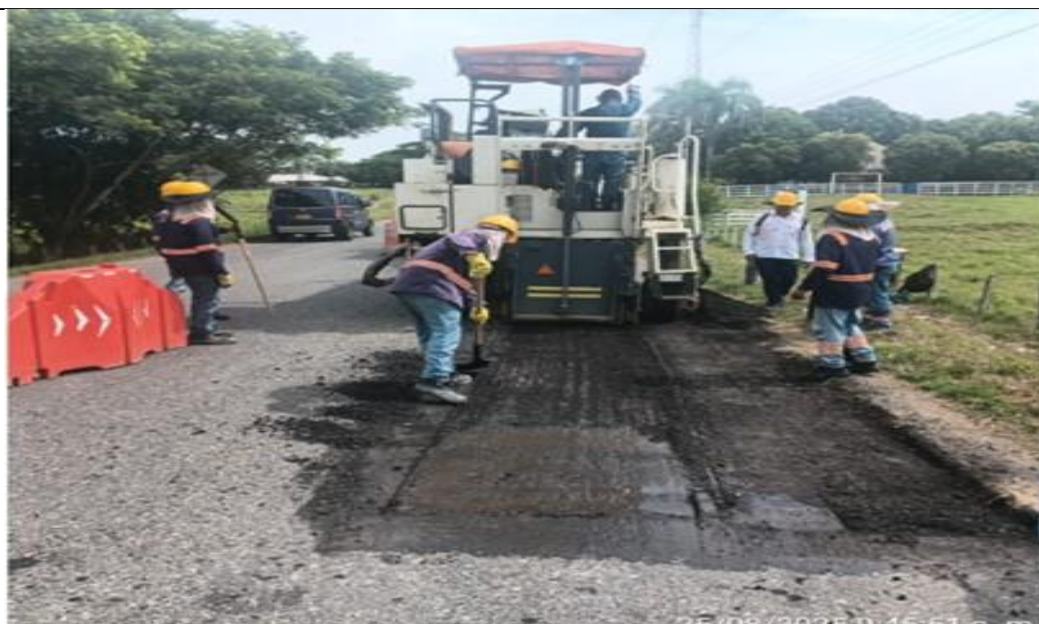
PR 0+070 carril derecho. Fresado de carpeta asfáltica para parcheo.
