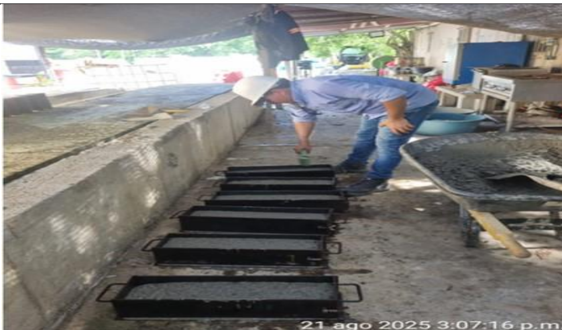
PR10+105 a menor carril derecho. Toma de muestras y asentamiento de concreto MR-40 en planta del contratista para la fundida de módulos.
