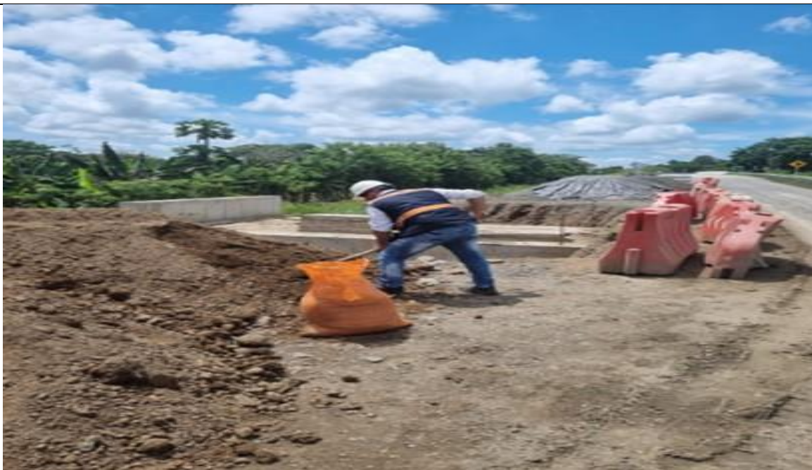
PR 34+658 lado derecho. Toma de muestras a material de terraplén.
