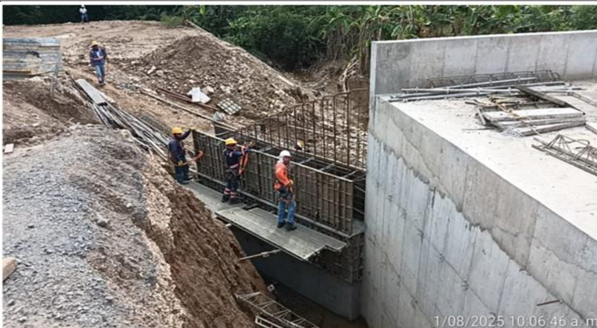
Box Culvert PR 34+658, lado derecho. Encofrado complemento de aleta norte.
