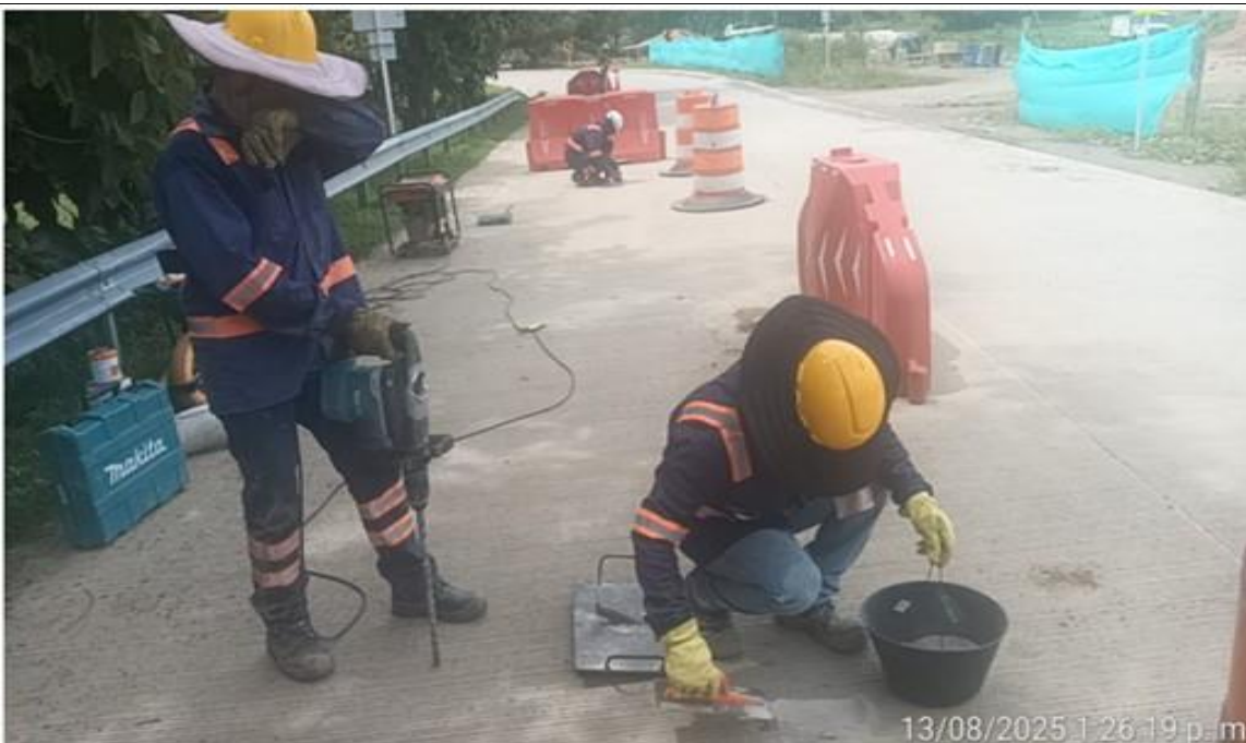
PR 13+609 a mayor lado derecho. Costura de losas en concreto MR40.
