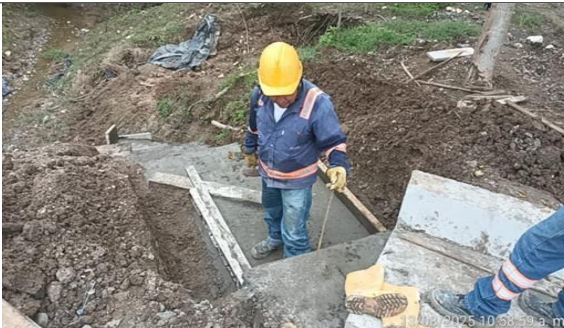
PR 25+730 lado izquierdo. Fundida solado para construcción de dissipador.
