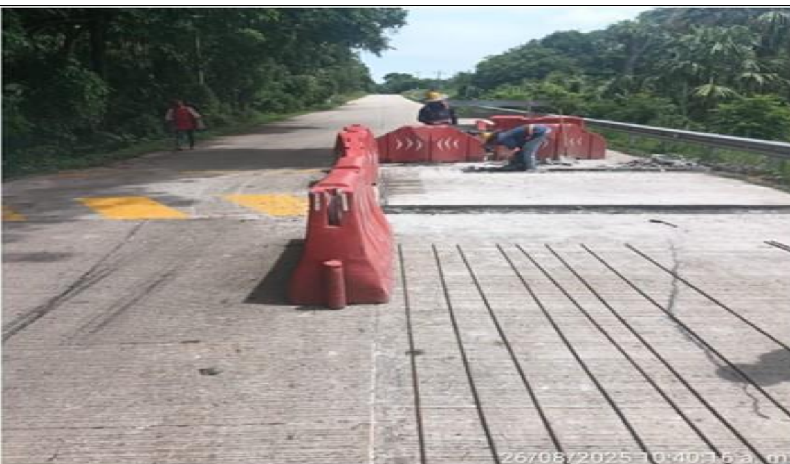
PR 24+660 carril derecho. Demolición para construir resalto tipo pompeyano.
