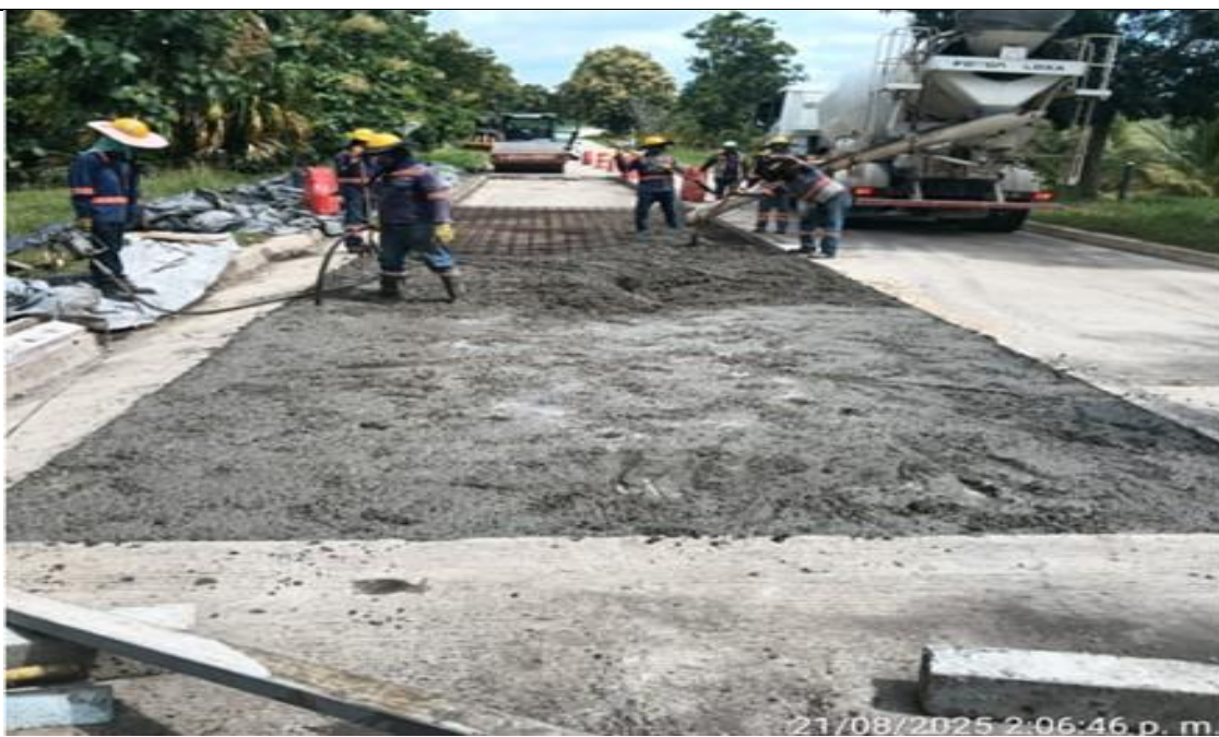
PR 10+105 a menor, carril derecho. Fundida de módulos en concreto MR40.
