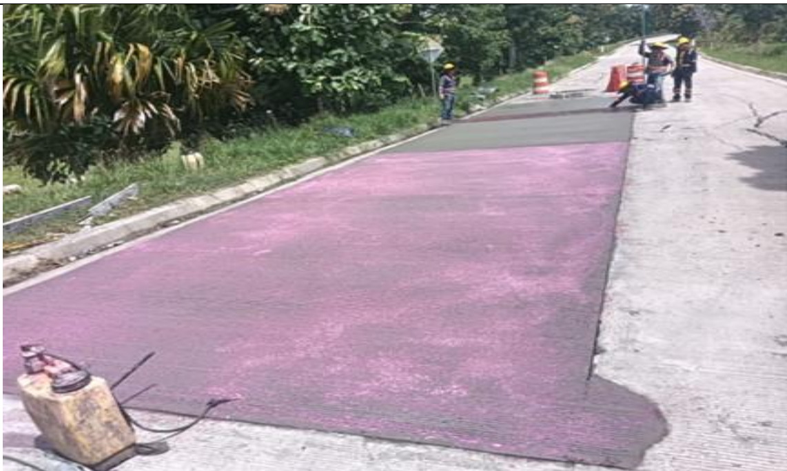
PR 10+069 lado derecho. Fundida de módulos en concreto MR40.
