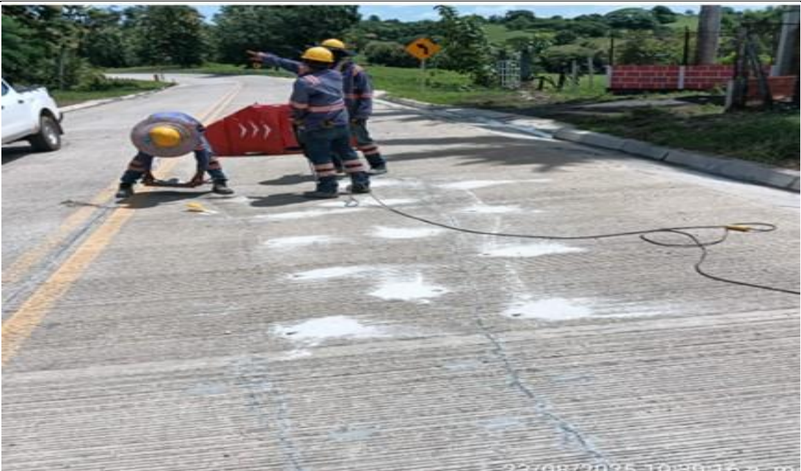
PR 9+775 carril derecho. Costura de losas en concreto MR40.
