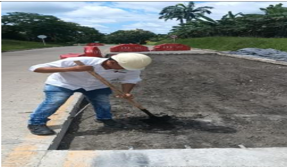
PR 9+700 A mayor lado derecho. Inspección a la SBG.
