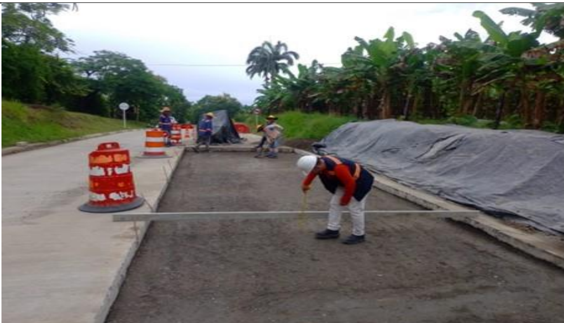
PR 7+700 al PR 9+713.5 lado derecho. Verificación de espesores en reconstrucción de módulos de concreto MR 40.
