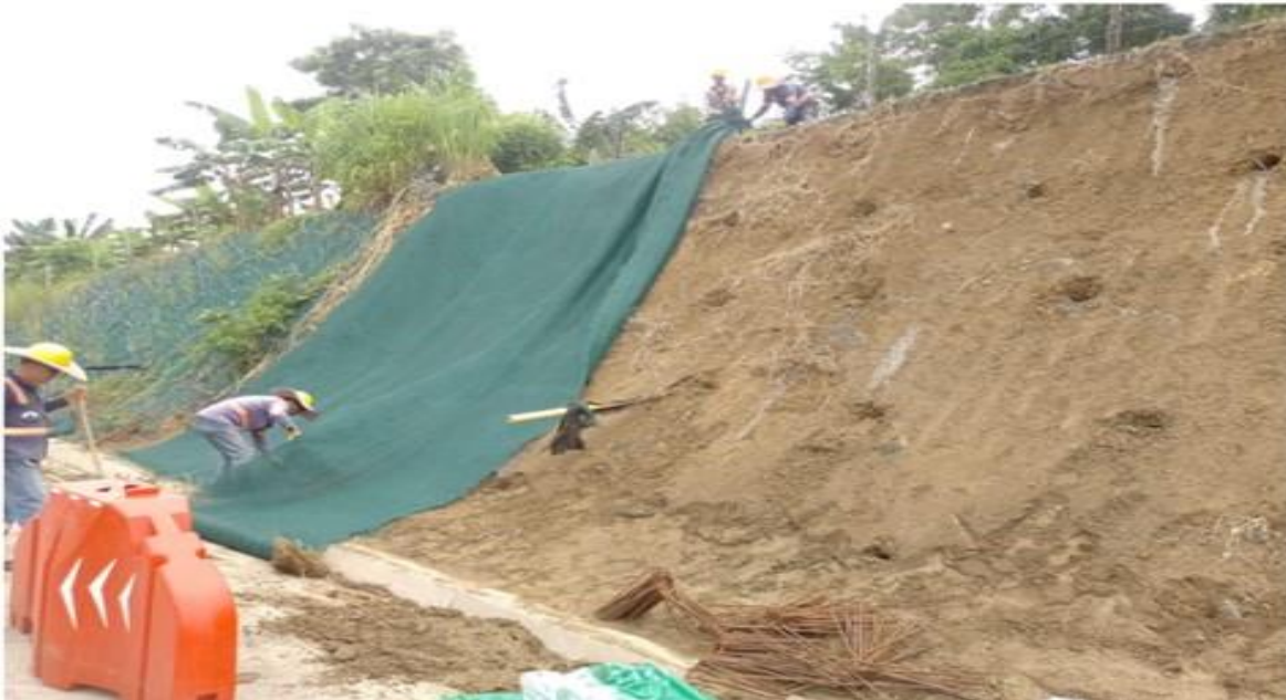
PR 13+100 margen derecha. Reposición de geomanto en talud.
