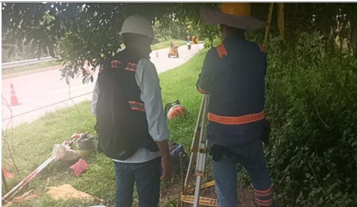
PR 8+800 al 10+000. Levantamiento de poligonales.
