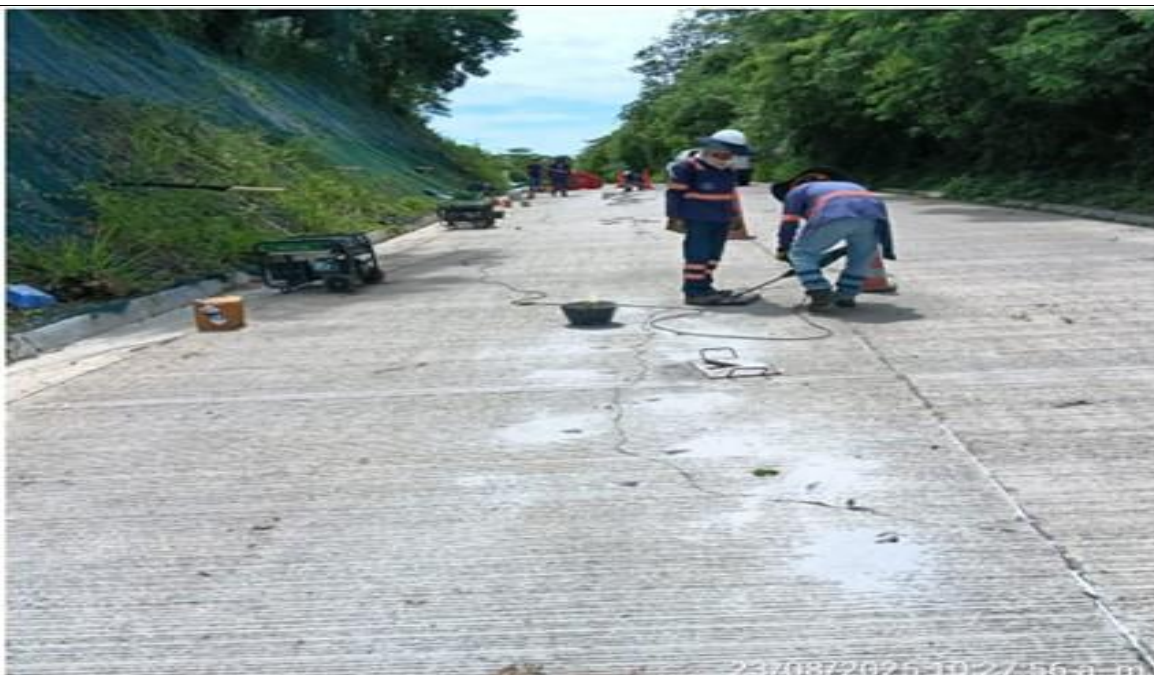
PR 14+700 a menor lado derecho. Costura de losas en concreto MR40.
