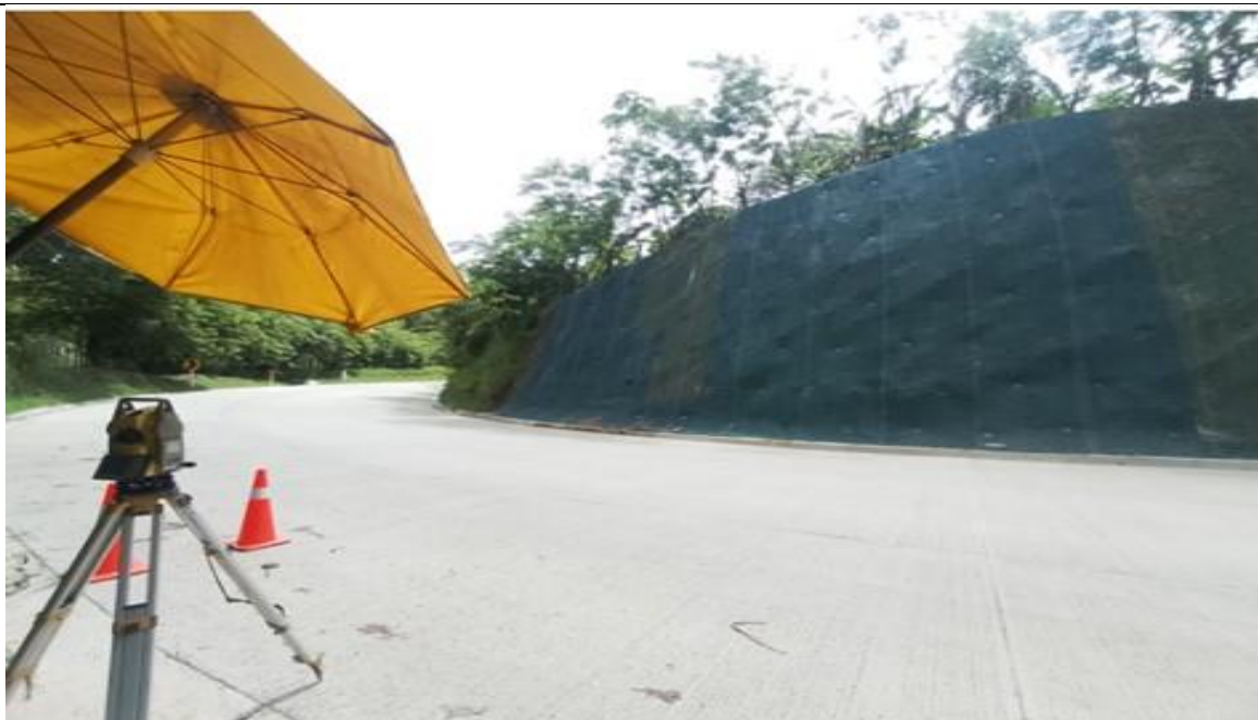
PR 13+950 a menor lado derecho. Levantamiento topográfico a pernos y maya triple torsión instalado en talud.
