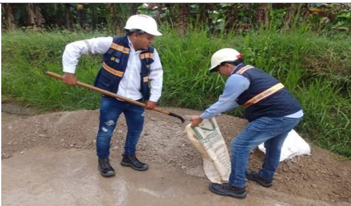
PR 9+722.5. Toma de muestras de material utilizado en el remplazo de la estabilización con cal a nivel de SBRA.
