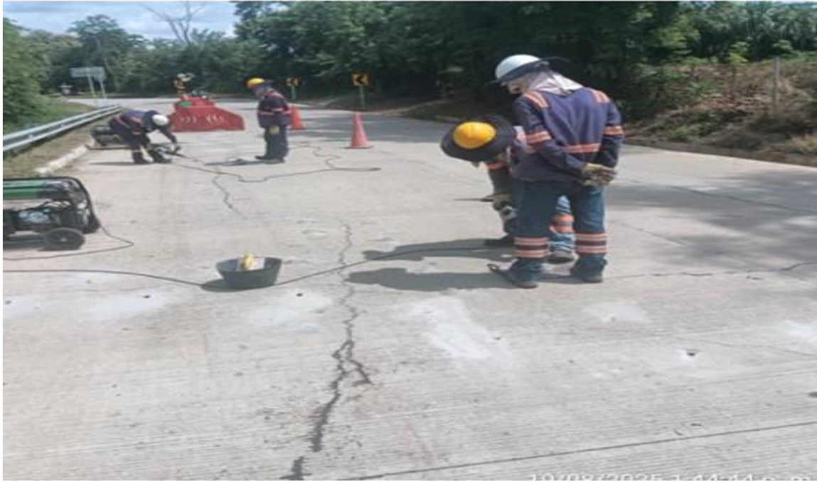
PR 11+300 lado derecho. Costura de losas en concreto MR40.
