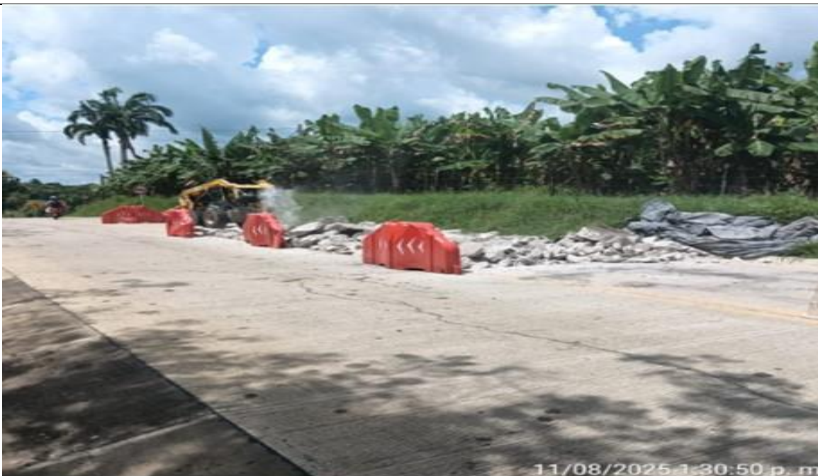
PR 9+700 lado derecho. Demolición de las losas pavimento MR-40.
