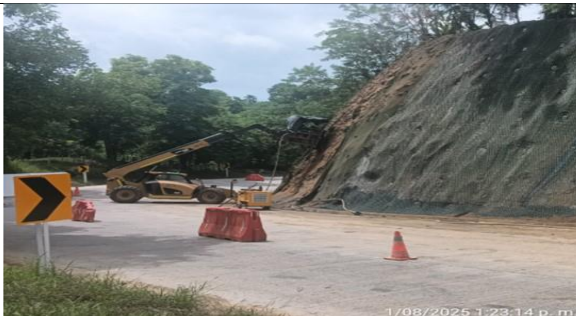
PR 13+950 lado derecho. Perforaciones para instalación de pernos.
