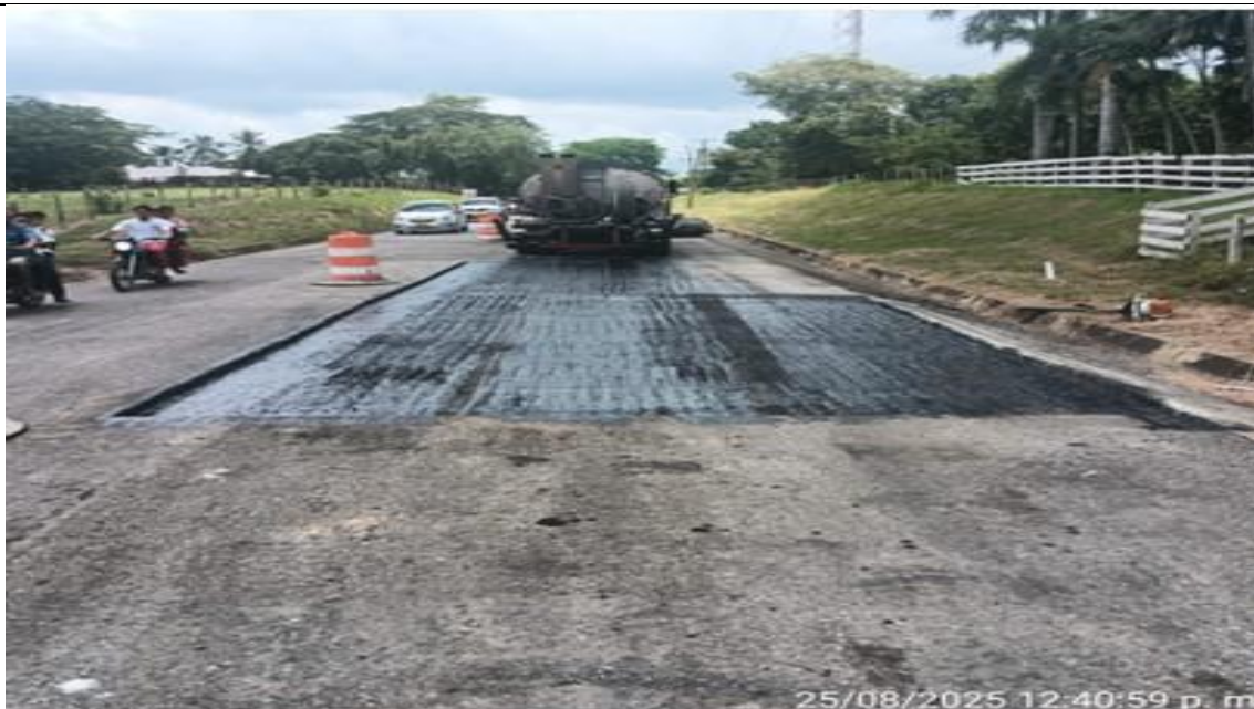
PR 0+000 al 0+140 carril derecho. Imprimación en cajas para parcheo.
