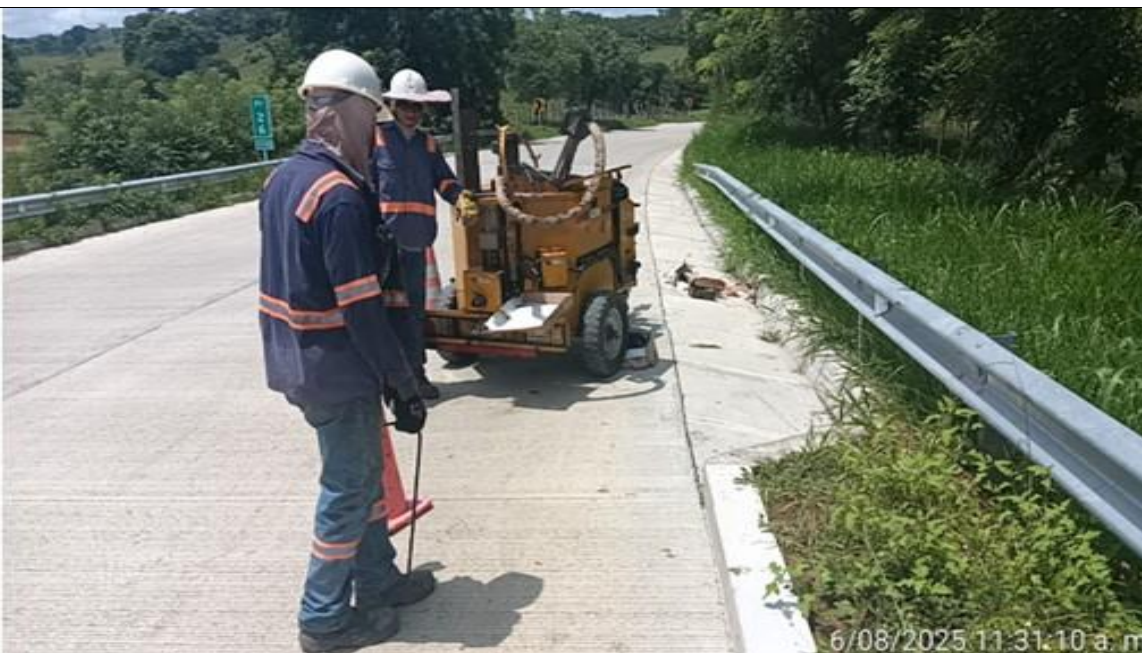
PR 26+010 lado izquierdo. Instalación sello Bituflex entre junta de cuneta y pavimento.
