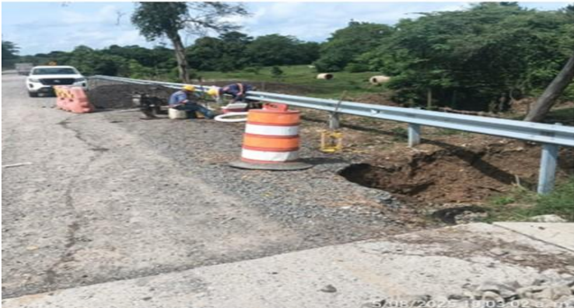
PR 25+730 lado izquierdo. Actividades para continuidad de cuneta.
