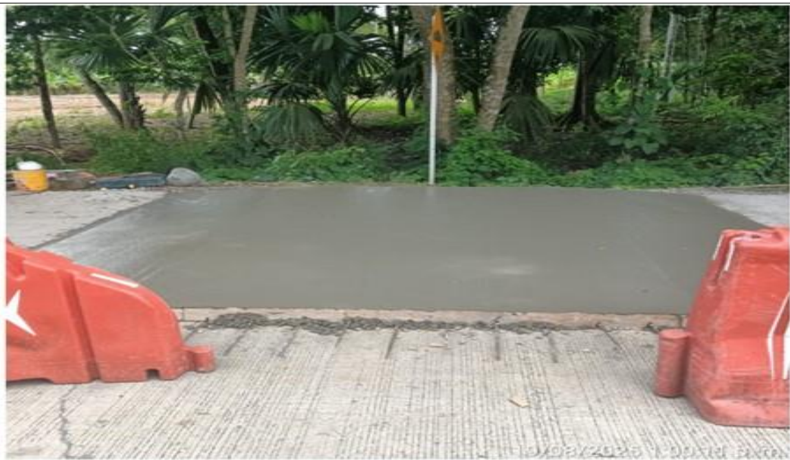
PR 24+600 lado izquierdo. Fundida resalto pompeyano.
