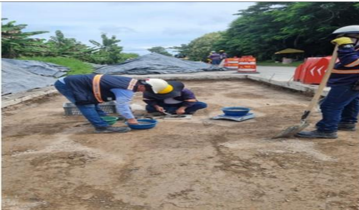
PR 9+700-9+736 carril derecho. Densidades a material terraplén estabilizado con cal.
