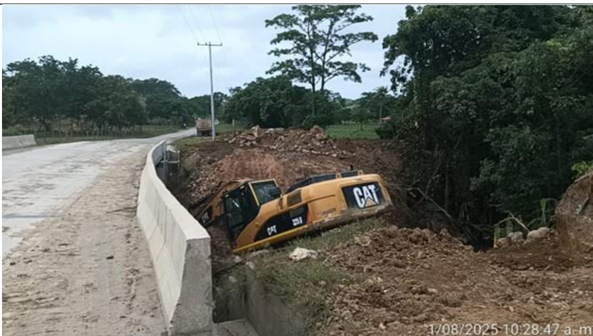
PR 45+300 lado izquierdo. Demolición de box culvert existente.
