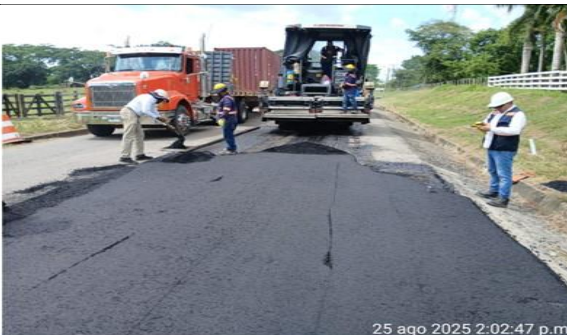
PR0+070 carril derecho hacia mayor. Toma de muestras MDC19 para ensayos de laboratorio de la mezcla para parcheo.
