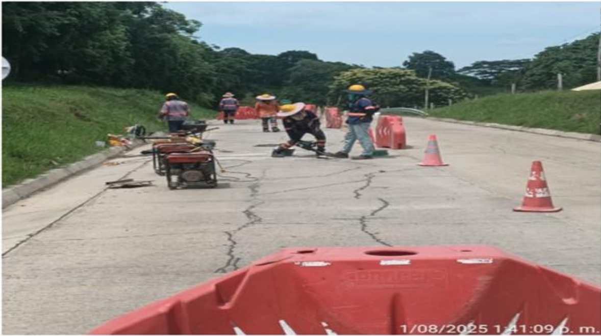
PR 11+100 carril derecho. Costuras a losas en concreto MR40.
