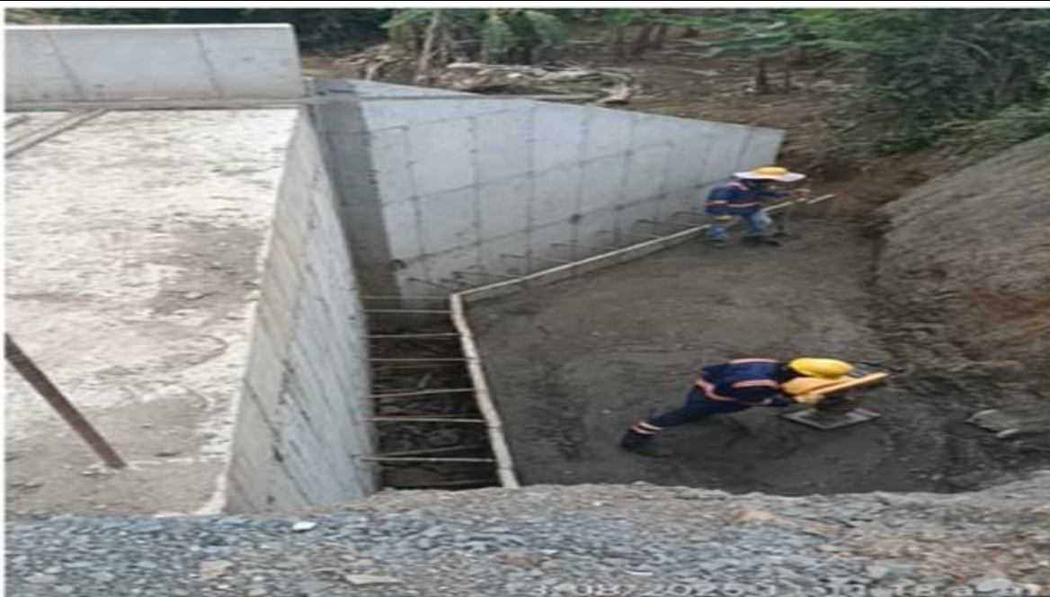
PR 34+658, lado derecho. Compactación por capas lleno muro sur.
