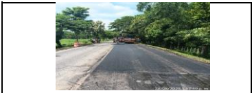
Instalación de MDC 19 del PR 0+840 a mayores, carril derecho
