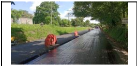
imprimación del PR 0+117 a mayores carril izquierdo
