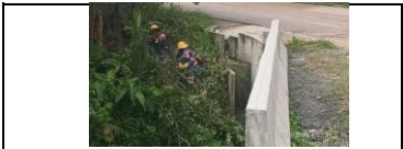
PR 46+520 lado izquierdo instalación de cercas nuevas.
