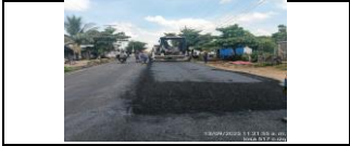
Instalación de MDC19 -Sobrecarpeta del PR1+453 al PR1+525 carril derecho.
