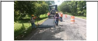
Instalación de MDC 19 en el PR 0+530 carril izquierdo
