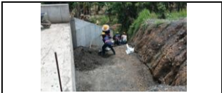
Lleno estructural box culvert del PR 34+658 lado derecho
