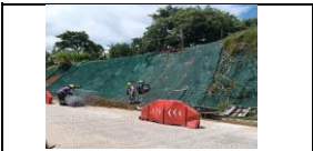
Instalación de malla triple torsión PR 13+100 lado derecho
