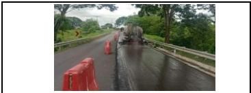
imprimación carril izquierdo del PR 3+510 a mayores
