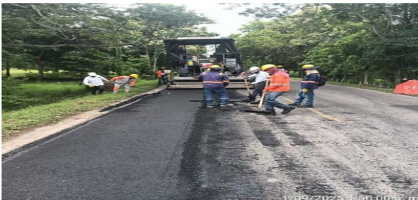
PR 0+700 carril izquierdo. Instalación MDC19 en cajas para bacheo.
