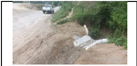
Adecuación y descole con piedra pegada en el PR 41+950.
