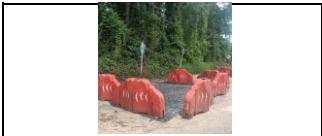
PR 47+485 construcción de resalto pompeyano en el carril izquierdo.
