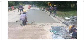
Reconstrucción de losas MR40 del PR 9+087 a mayores, carril derecho.
