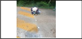
instalación de tachas en resalto del PR24+600
