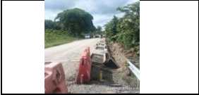
Construcción de cunetas en el PR 25+700 a menores margen izquierda.
