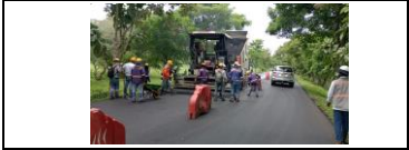
Instalación de MDC 19 DEL PR 0+770 al 0+870 carril izquierdo
