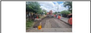
Demolición de carpeta asfáltica PR1+745,30 al PR1+776,80.
