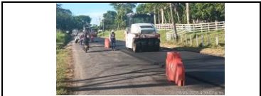
Instalación capa de rodadura- mantenimiento del PR 0+110 a mayores carril derecho.
