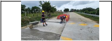
PR25+250 lado derecho demolición parcial de losa para construcción resalto Pompeyano
