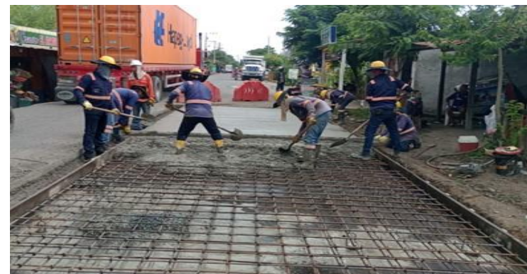
PR 1+745 carril izquierdo. Fundida módulos en concreto MR40.
