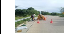
PR 26+500 lado derecho instalación de sello en junta de cunetas y pavimento
