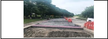
Reconstrucción MR40 del PR9+060 al PR9+082.5 en el carril derecho
