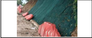
Instalación de geomanto PR 9+150 a mayores del lado derecho
