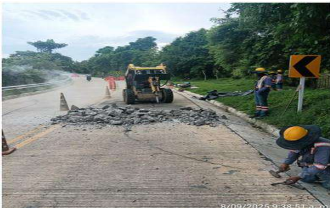
PR 9+060 carril derecho. Demolición del módulo #238.
