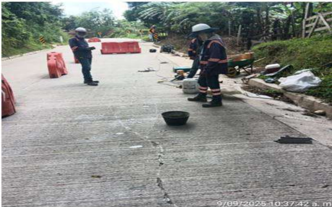
PR 14+270 a mayor, carril derecho. Costura de losas en concreto MR 40.
