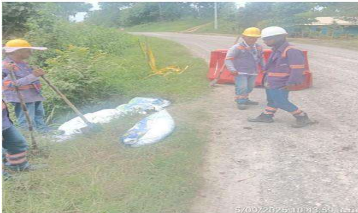
PR 28+900 lado derecho. Instalación de costales con material para controlar erosión.
