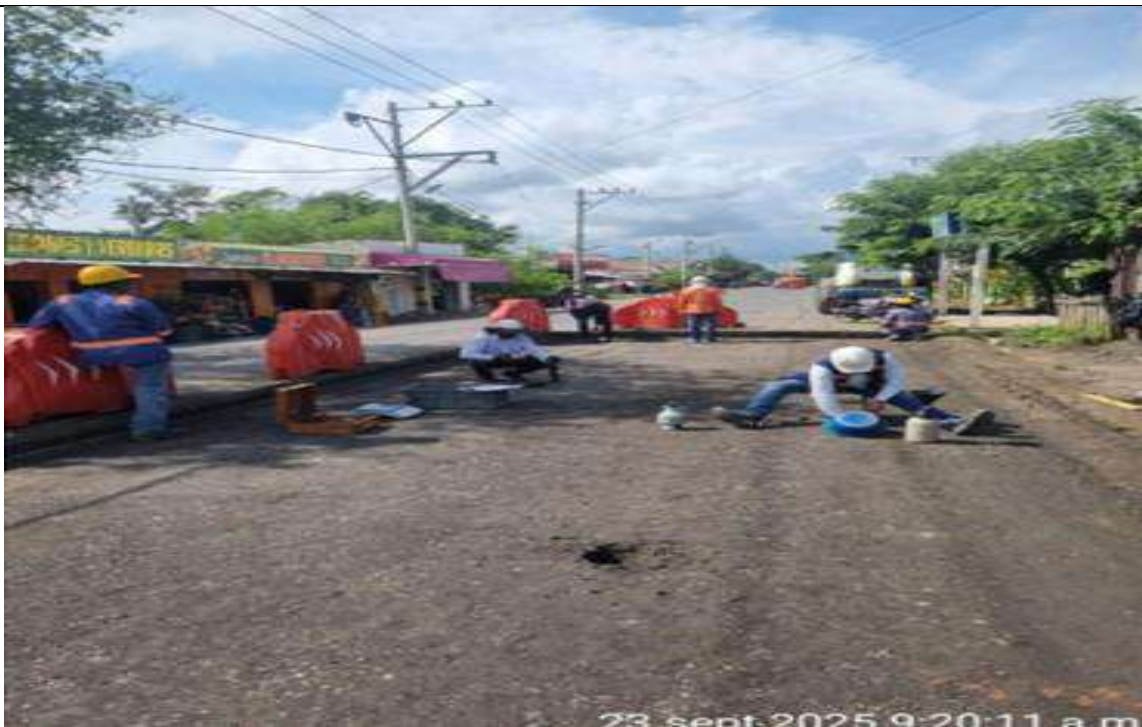
PR 1+745 carril izquierdo. Toma de densidades y humedades en SBG centro poblado Santa Lucía.
