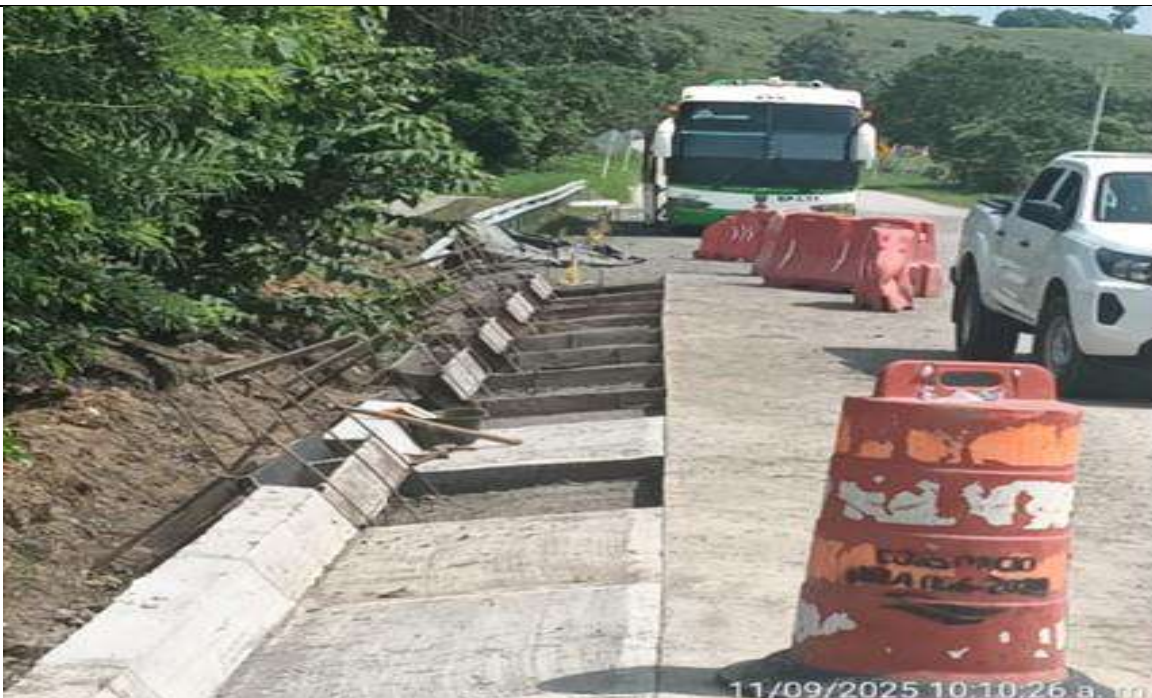
PR 25+700 a menor, lado izquierdo. Instalación de formaletas para fundida de cunetas.
