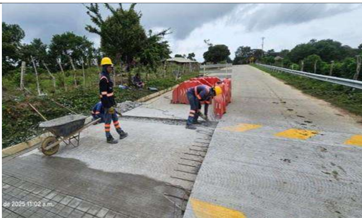
PR 29+250 Carril derecho. Demolición de losa para anclar resalto tipo Pompeyano.
