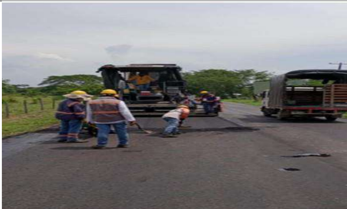
PR 0+345-380 carril izquierdo. Instalación de mezcla MDC 19 - Sobre carpeta.
