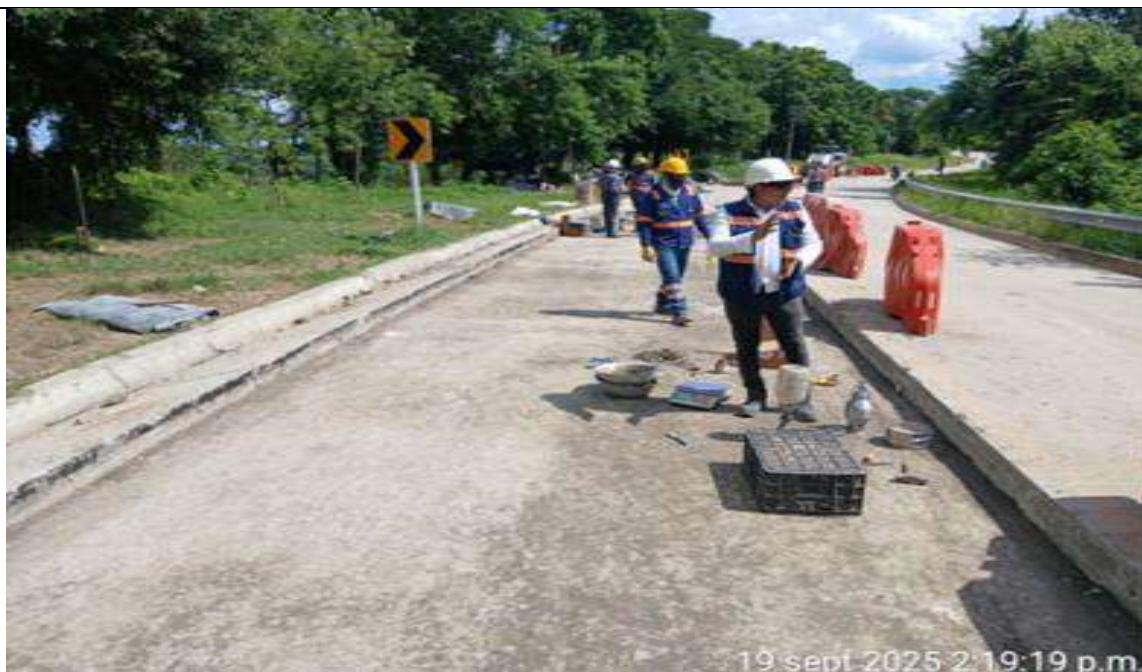
PR 9+087 lado derecho. Tomas de densidades en la SBG.
