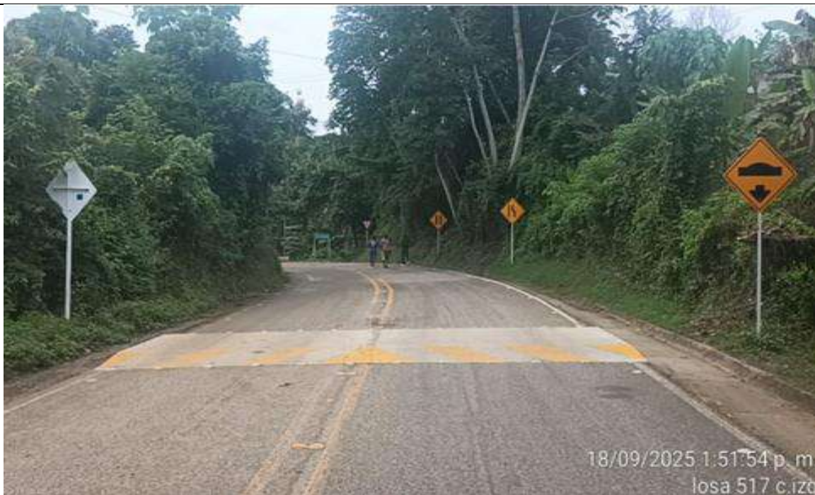
PR 47+485 y 47+685. Resaltos Pompeyanos construidos.
