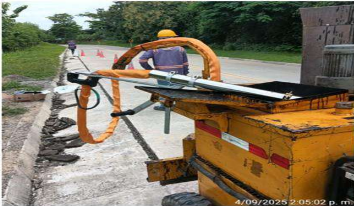
PR 9+700 lado derecho. Sello de junta entre cuneta y pavimento con Bituflex.
