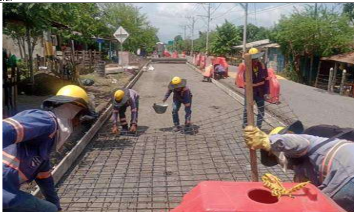
PR 1+745 carril izquierdo. Instalación acero para fundida de módulos en concreto MR40.
