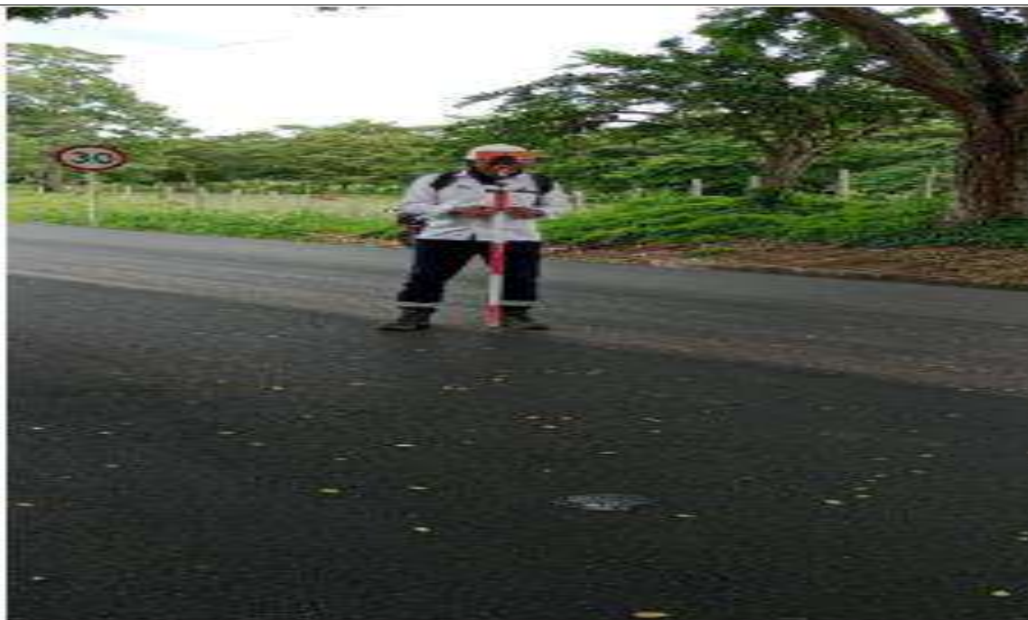
PR 0+110 calzada completa. Levantamiento topográfico.
