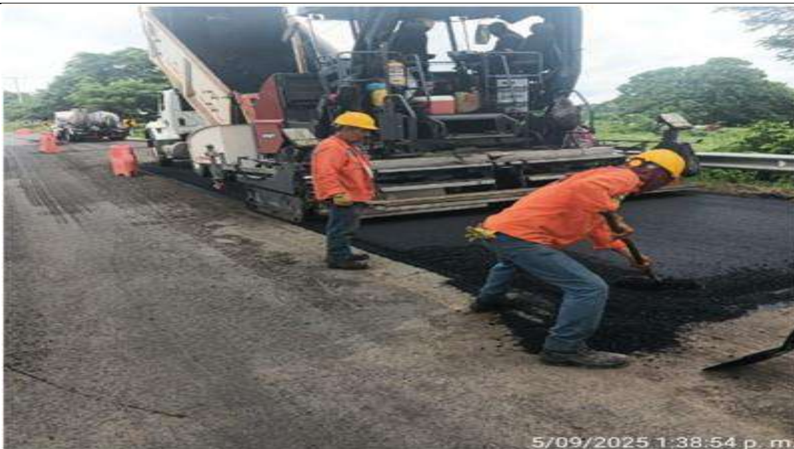
PR 3+580 a mayor. Instalación de mezcla MDC 19.
