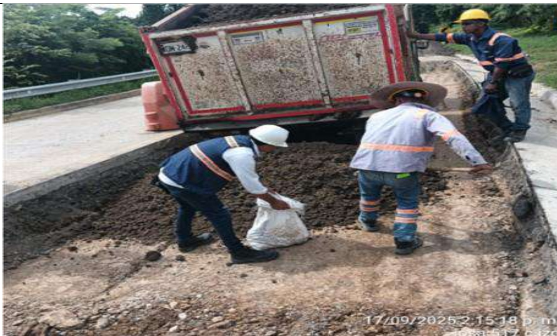
PR 9+087 carril derecho. Toma de muestras para ensayos de laboratorio.
