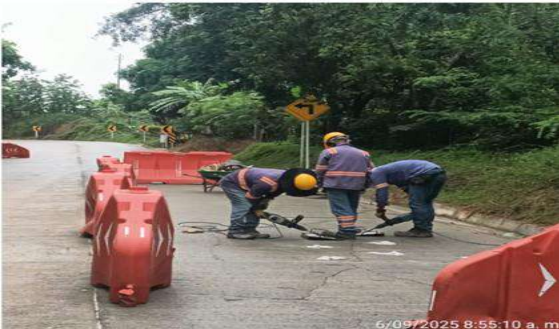
PR 14+200 carril derecho- 13+600 carril izquierdo. Costura de módulos en concreto MR 40.
