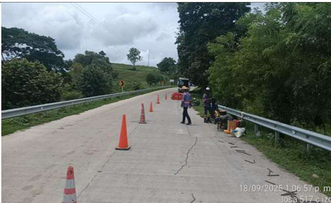
PR 27+150 carril derecho. Adecuación de módulos en concreto MR40 por método de costura cruzada.
