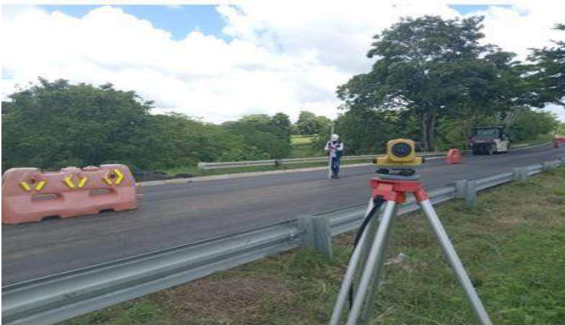
PR 3+520 hasta 3+620. Revisión de niveles rasante.
