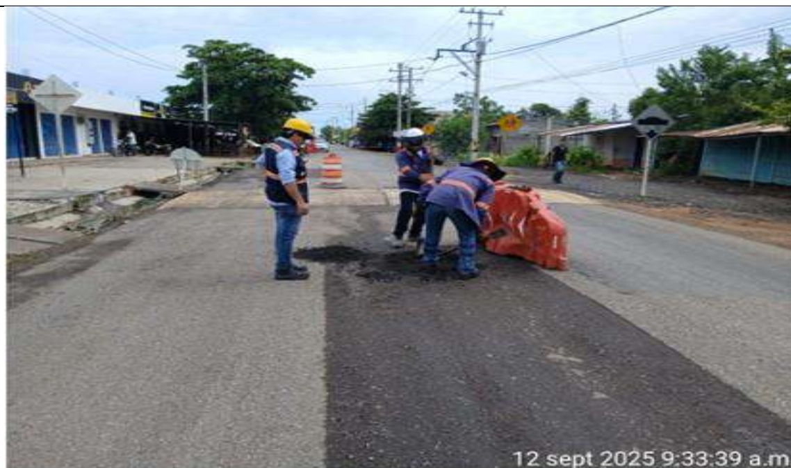
PR1+530 carril izquierdo. Toma de muestras y verificación de espesores vía existente.
