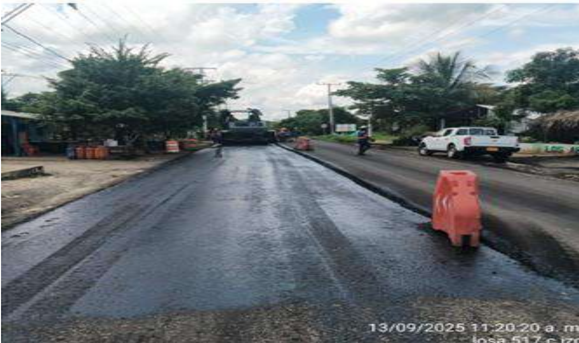
PR 1+453 al PR1+525 carril derecho. Instalación de mezcla MDC19 -sobre carpeta.
