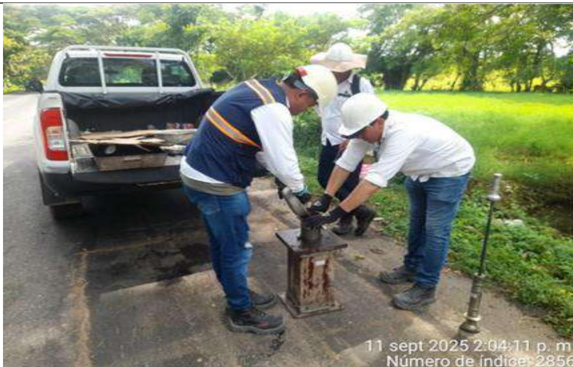
PR 0+760 hacia mayor, carril izquierdo. Toma de muestra mezcla MDC19 - sobre carpeta.
