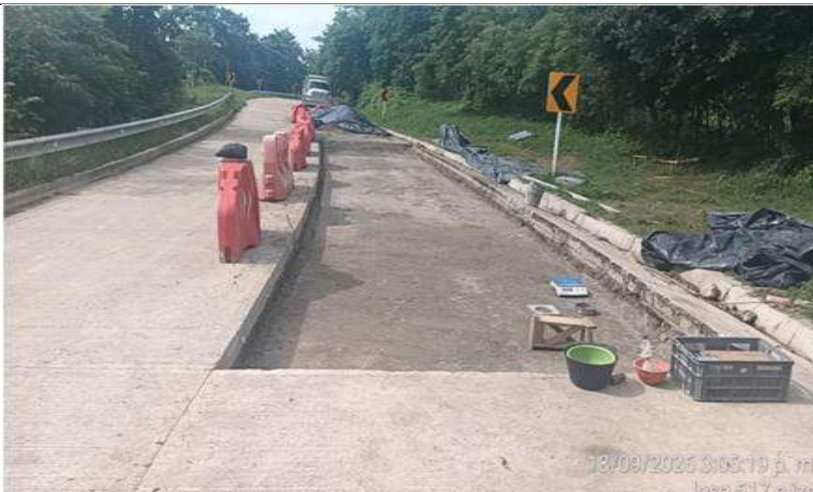
PR 9+087 a mayor, carril derecho. Instalación material de terraplén.
