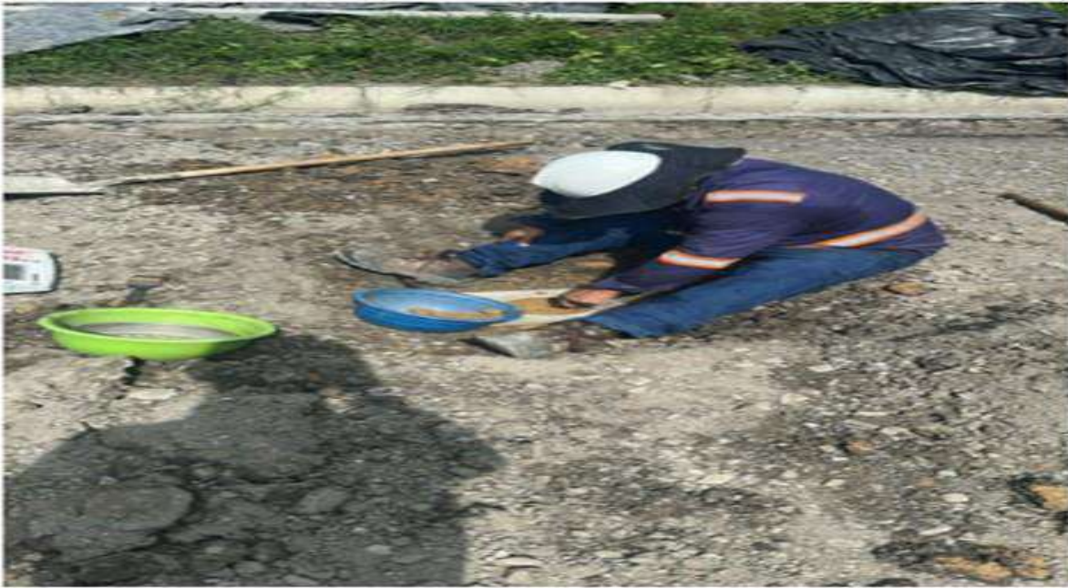
PR9+087 carril derecho. Toma de densidades.
