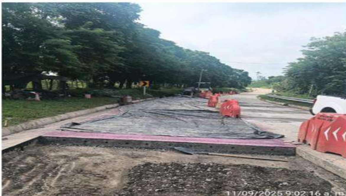
PR 9+060 al PR 9+082.5 carril derecho. Fundida de 5 módulos en concreto MR40.
