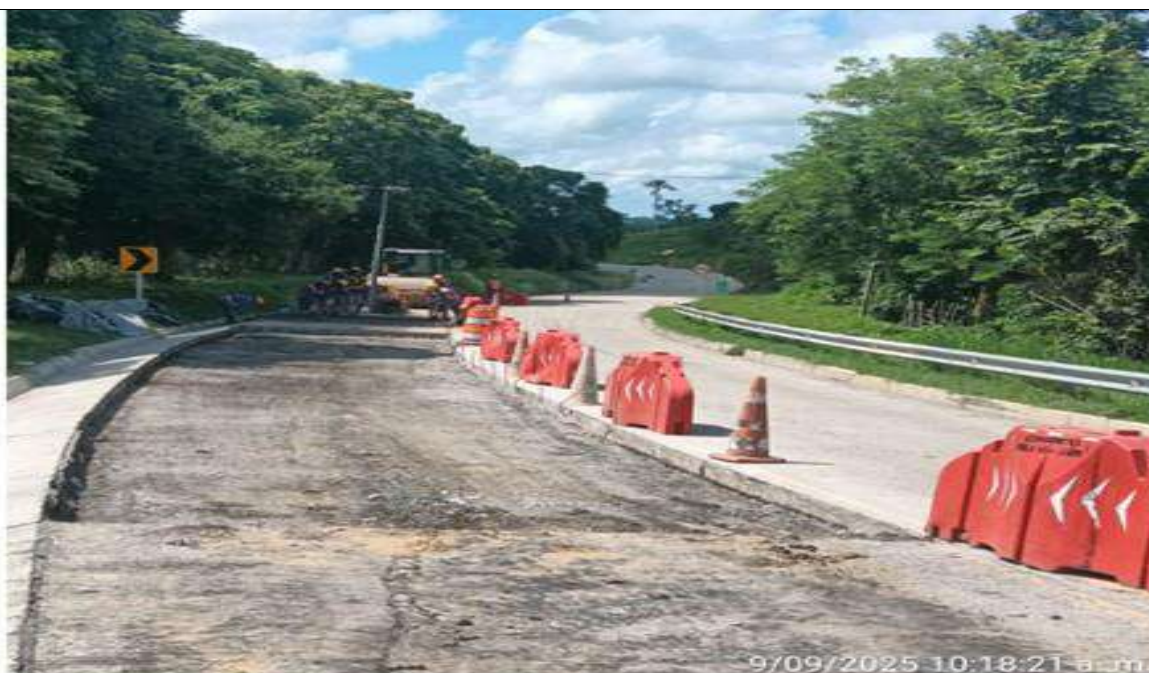
PR 9+060 al 9+087 carril derecho. Demolición de los módulos en concreto MR40.
