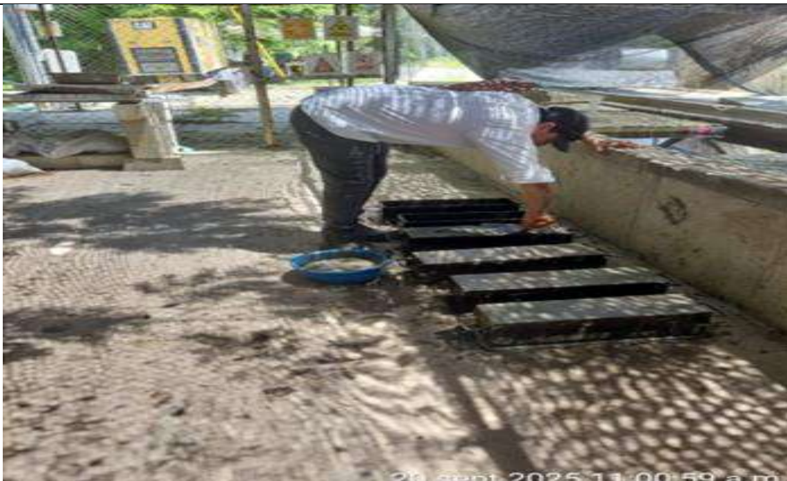
PR 4+700. Toma de muestras y asentamiento concreto MR-40.
