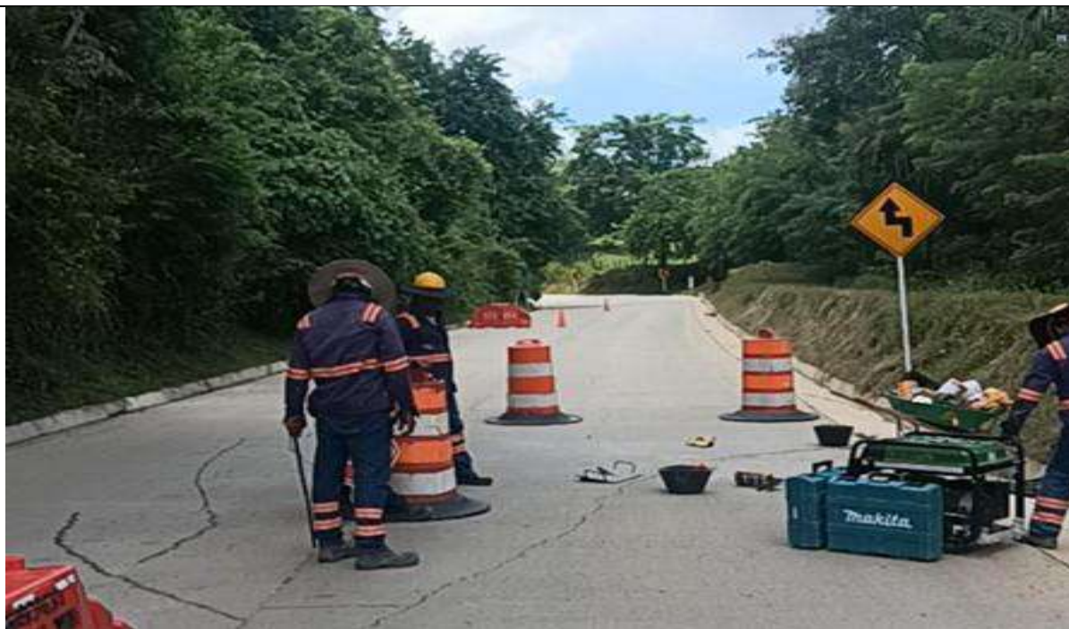
PR 14+080 carril izquierdo. Costura de módulos en concreto MR40.
