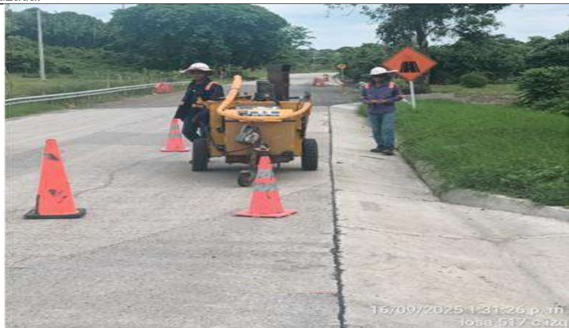
PR 25+760 a mayor, lado izquierdo. Sello lateral de cunetas con polibit.
