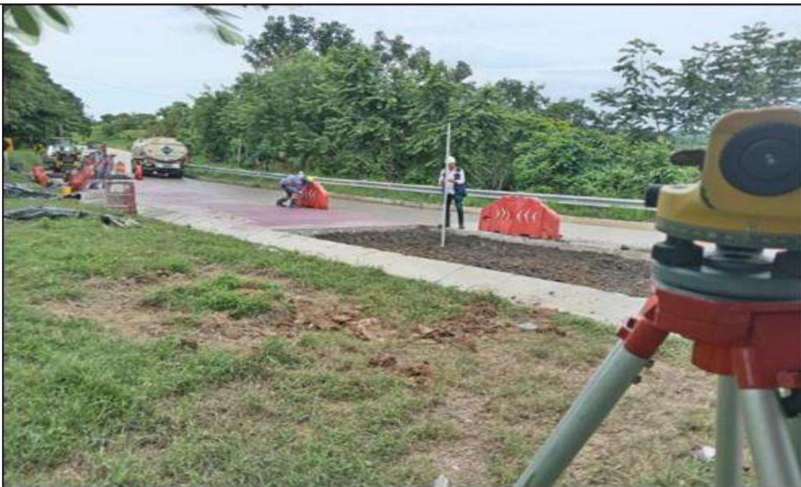
PR 9+085 lado derecho. Control topográfico a cajeo.
