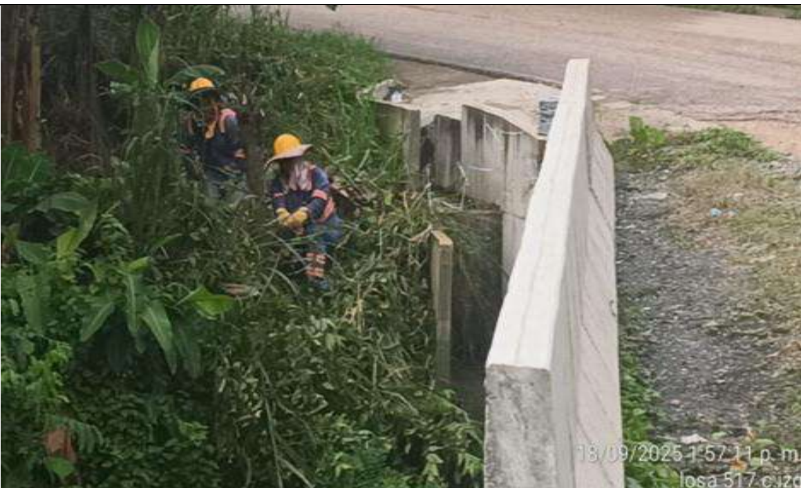
PR 46+520 lado izquierdo. Instalación de cercas nuevas.
