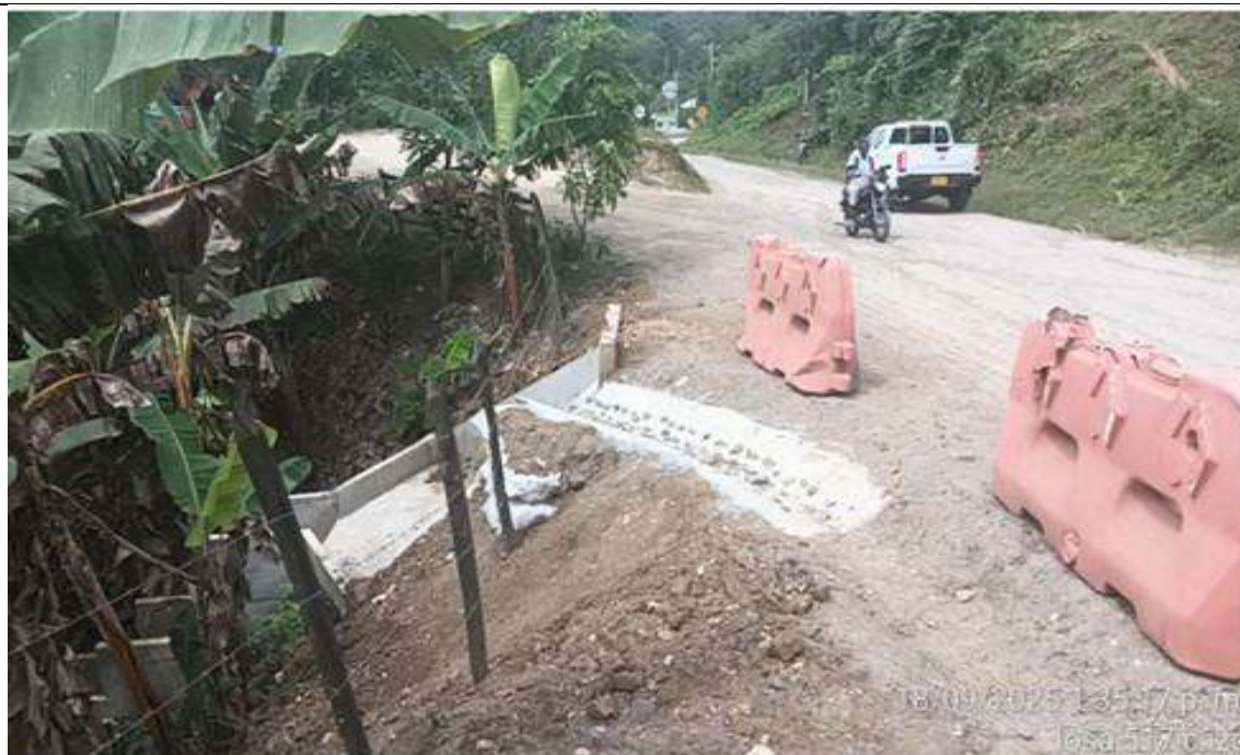
PR 41+950 ambos carriles. Llenos, adecuación y descole con piedra pegada.
