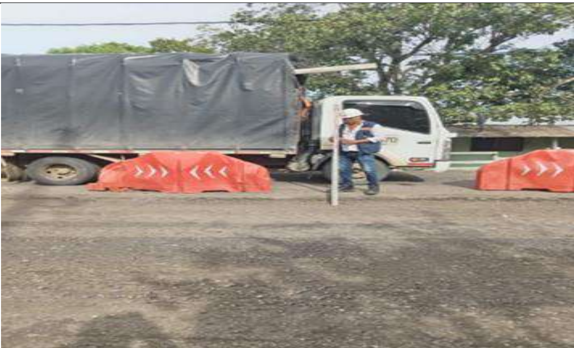
PR 1+745 carril izquierdo. Revisión de niveles de base.
