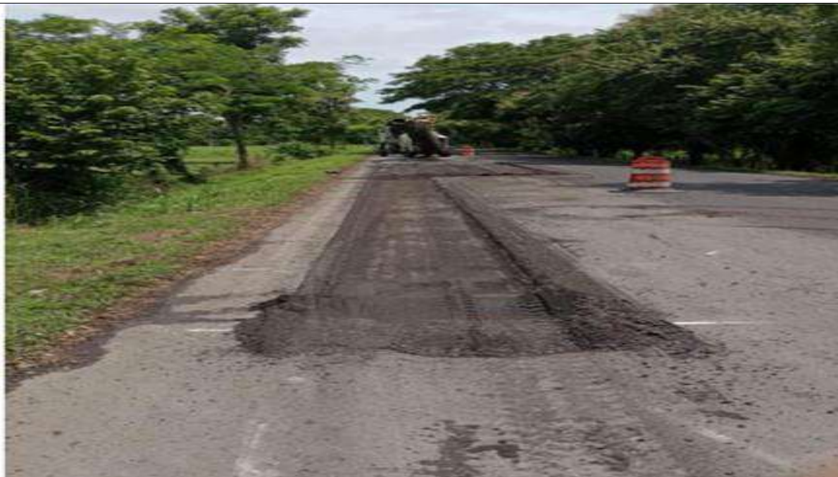
PR 0+700 carril derecho. Fresado para instalar de mezcla MDC19.
