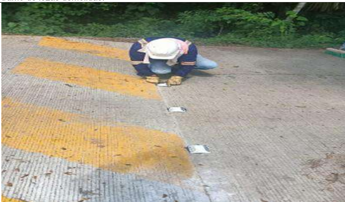
PR 24+600 carril izquierdo. Instalación de tachas en resalto.
