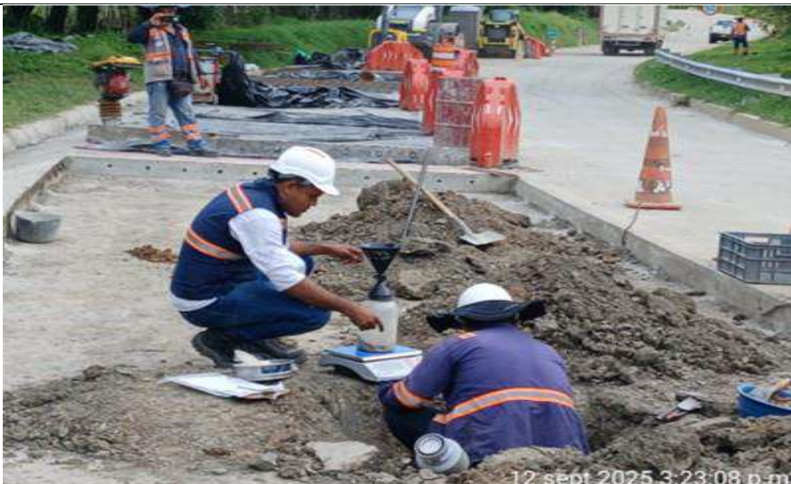
PR 9+087 al PR 9+100 carril derecho. Toma de densidades a subrasante estabilizada con cal en tramo de lozas demolidas.
