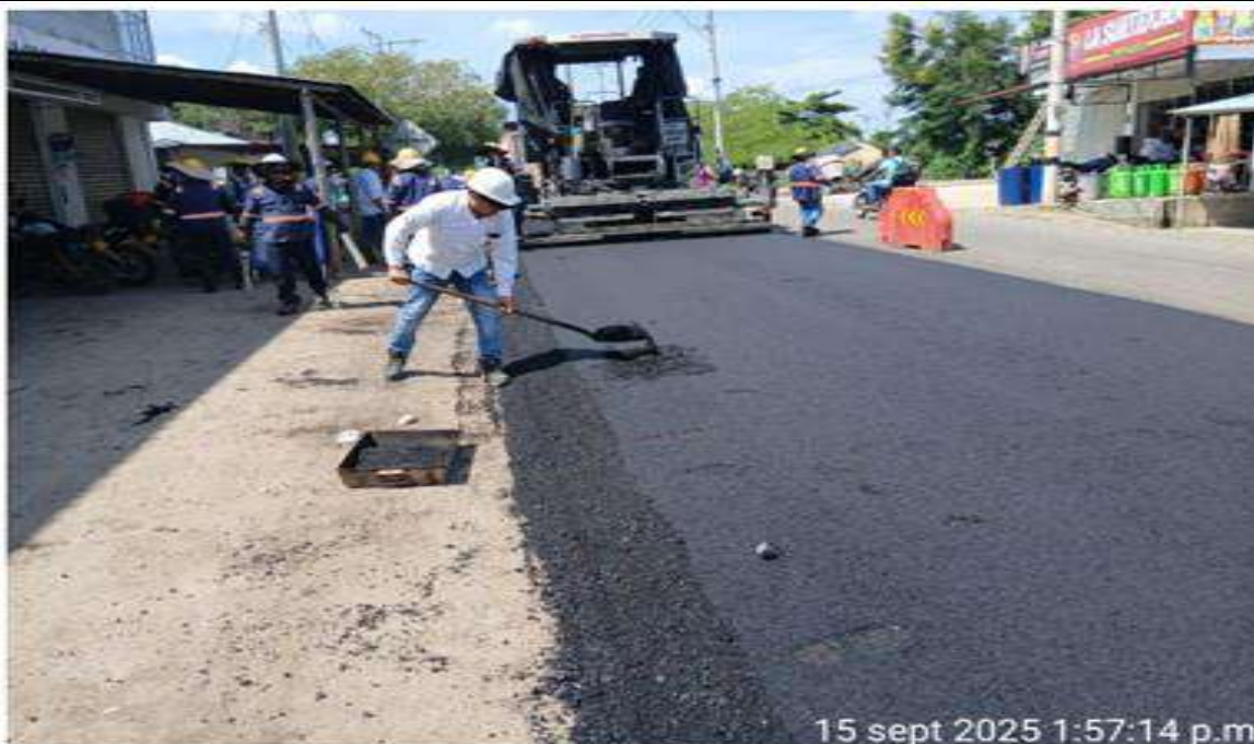
PR1+670 carril izquierdo. Toma de muestras, temperatura y compactación de briquetas de la sobre carpeta asfáltica MDC19.
