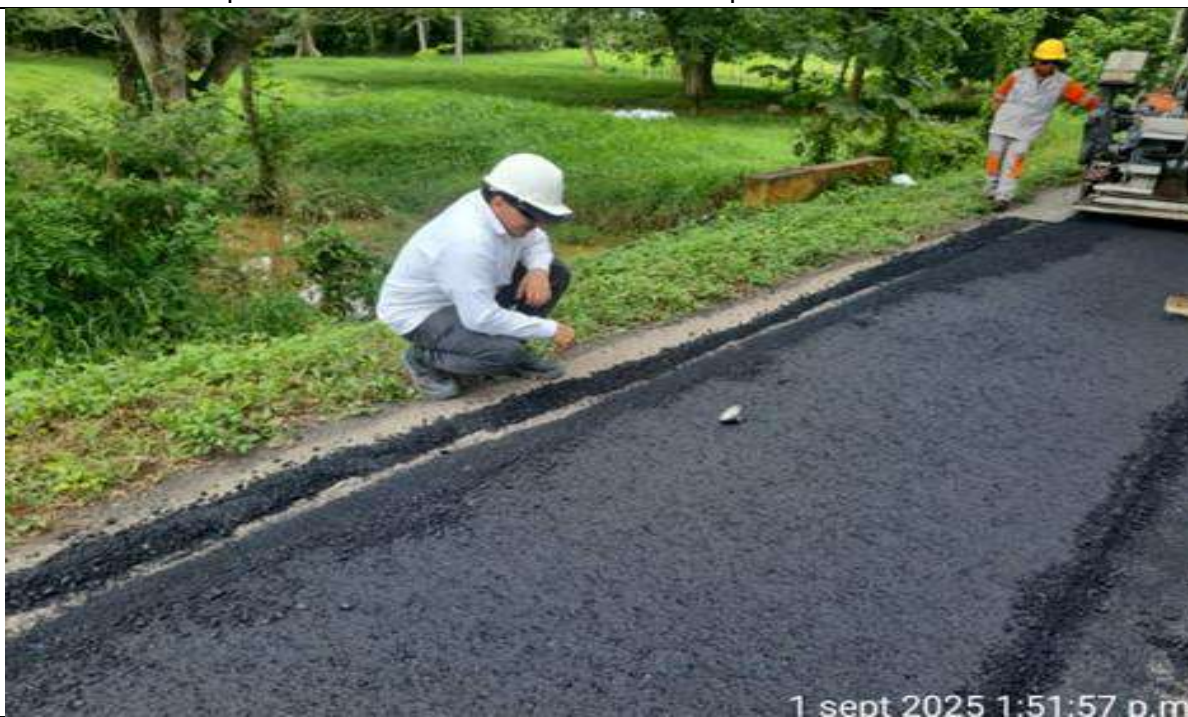
PR 0+700 a mayor carril izquierdo. Toma de muestras y temperatura a la mezcla MDC19.
