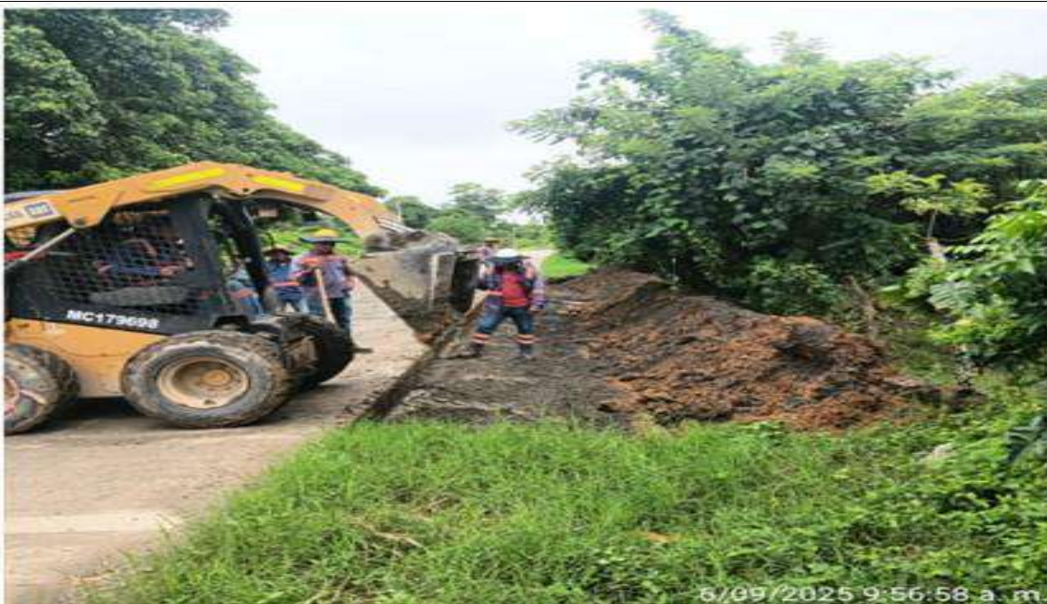
PR 25+700 a menor carril izquierdo. Descapote y adecuación de terreno para construcción de cunetas típicas.
