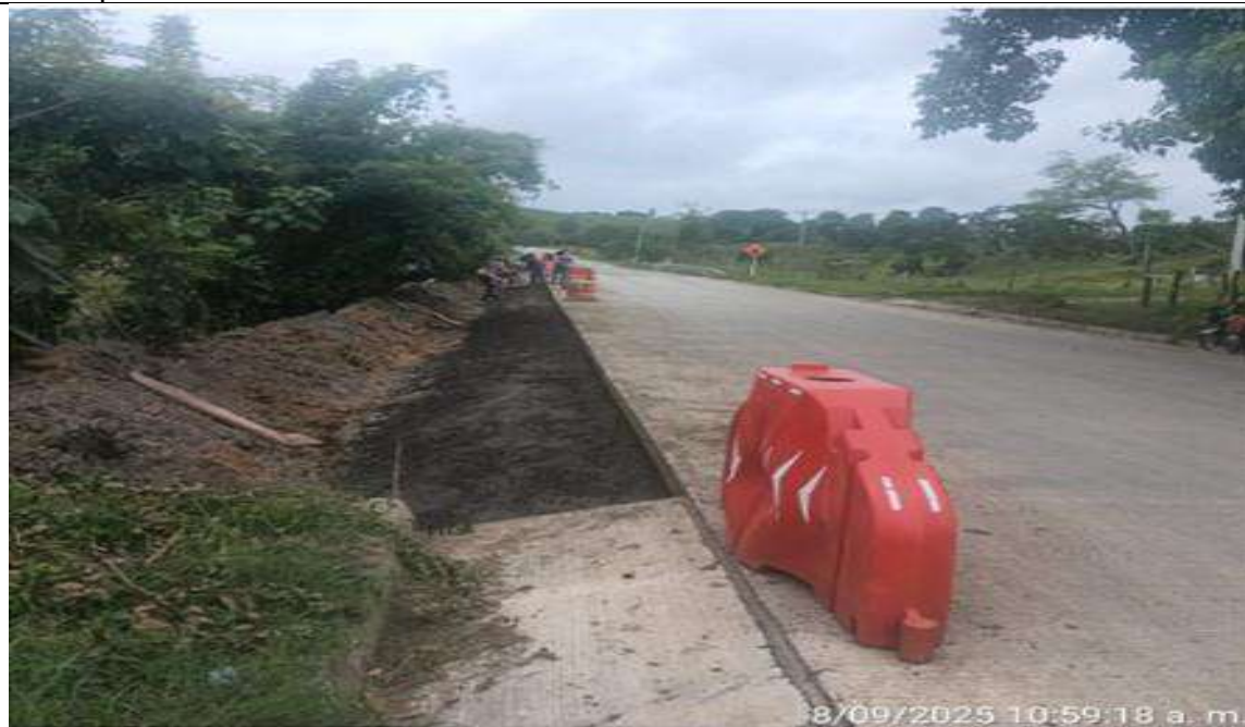
PR 25+650 margen. Instalación de SBG para soporte de cunetas típicas.
