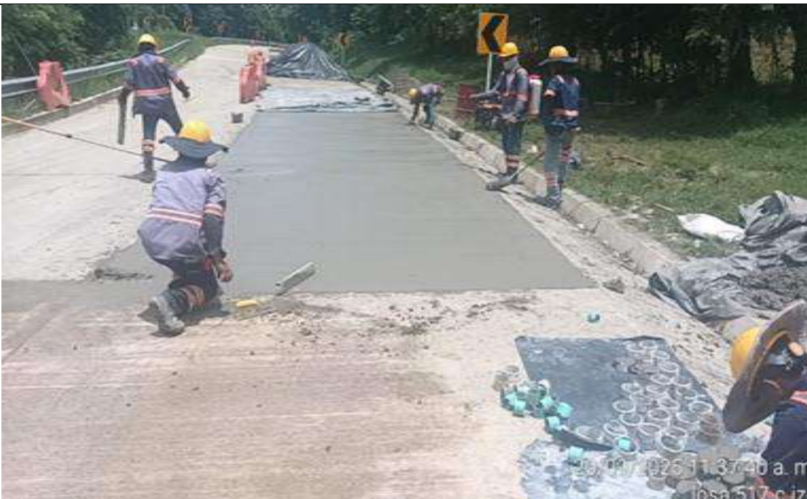
PR 9+087 a mayor, carril derecho. Fundida de módulos en concreto MR-40.
