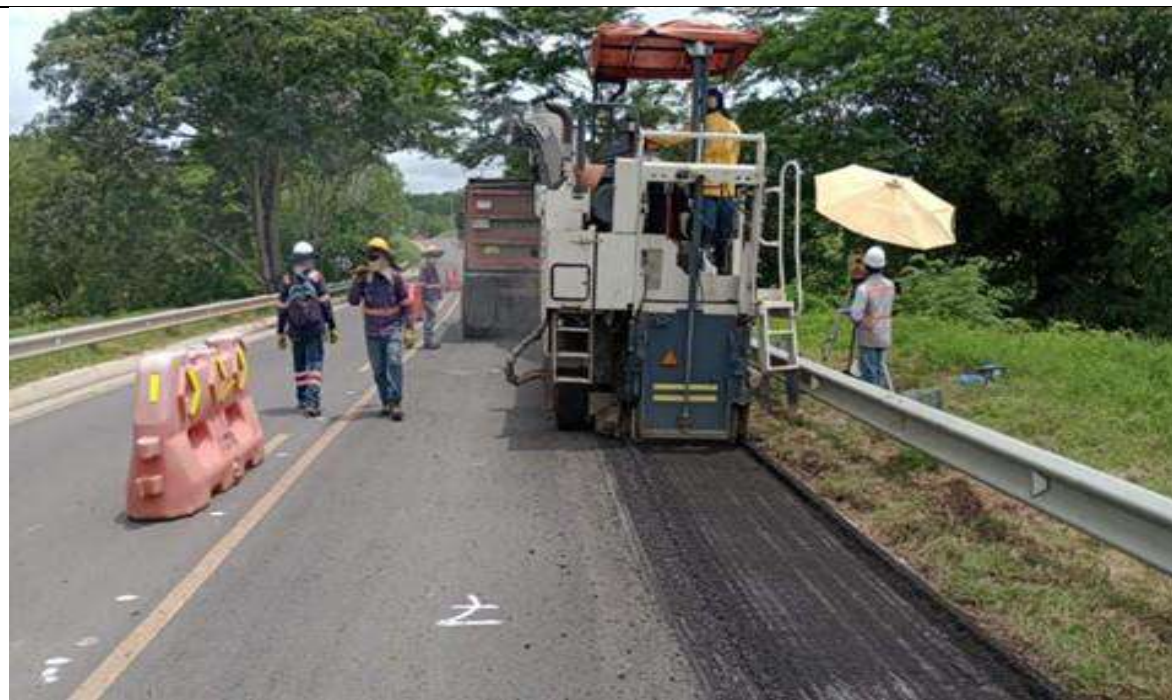
PR 3+510 lado derecho. Fresado.
