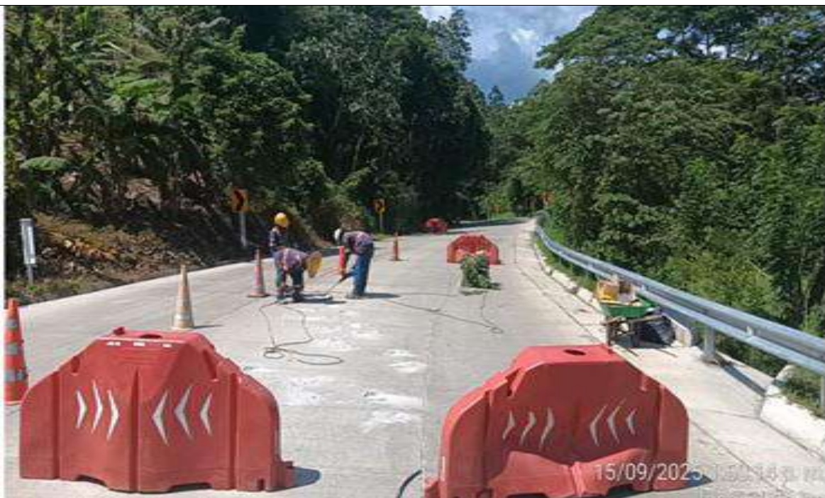
PR13+400 carril derecho. Adecuación de módulos en concreto MR40 por método de costura cruzada.
