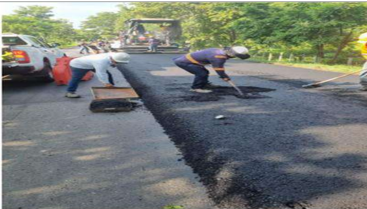
PR 0+760 hacia mayor, carril derecho. Toma de muestras y temperaturas de mezcla MDC19 - sobre carpeta.
