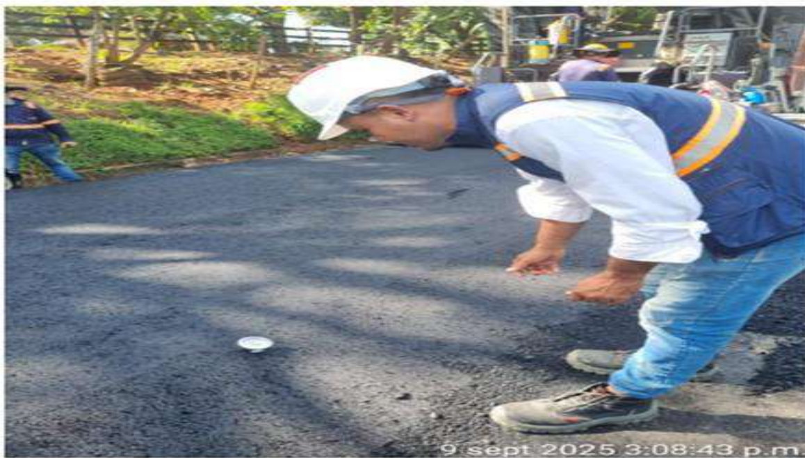
PR 0+217 carril derecho a mayor. Toma de muestras y temperaturas mezcla MDC 19.
