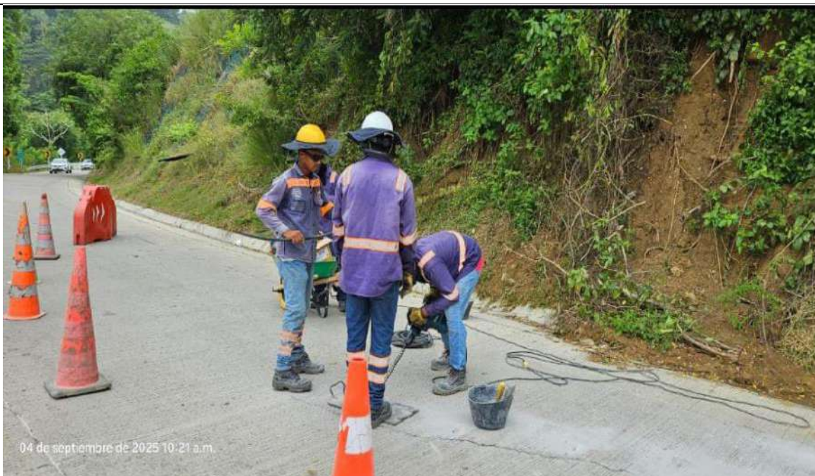
PR 13+100 carril derecho. Costura de losas.
