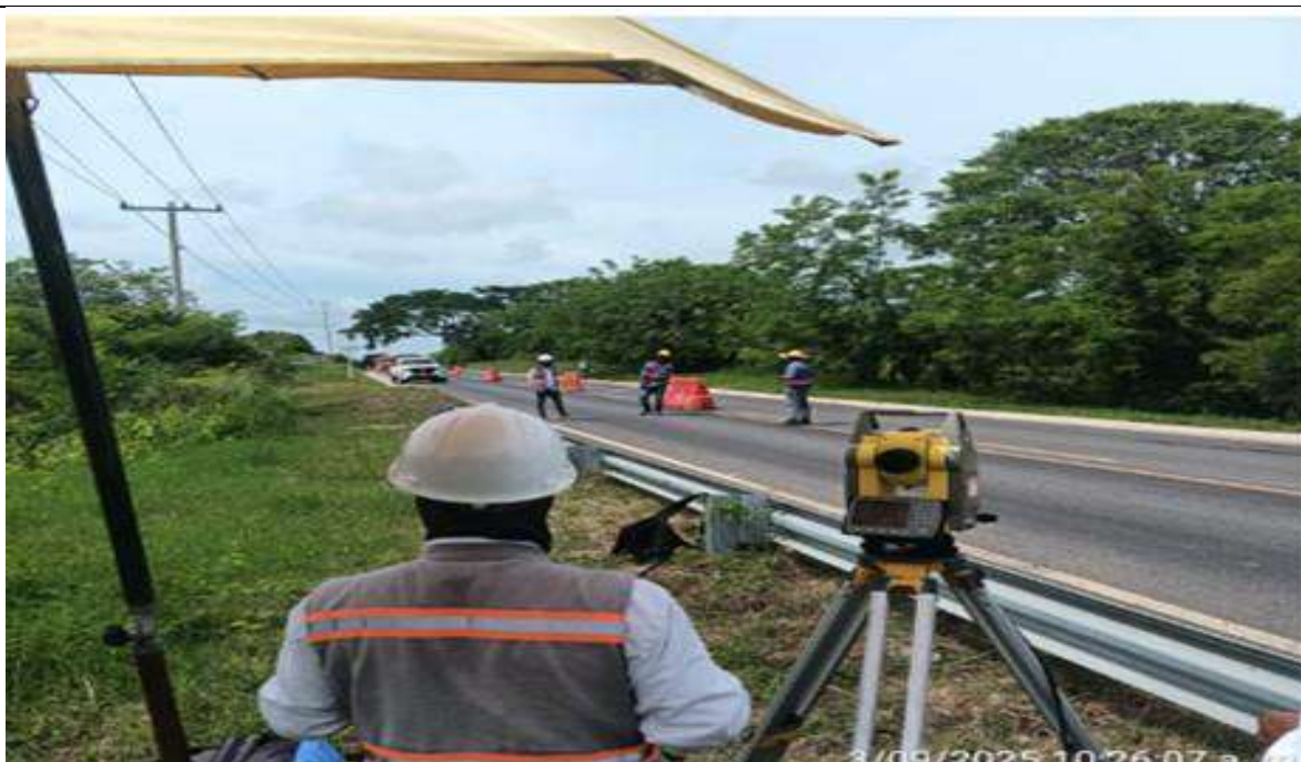
PR 3+510 al 3+640 calzada. Replanteo y marca de bordes de rasante y cortes.
