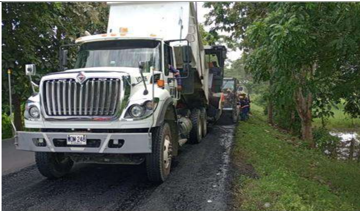
PR 0+770 al 0+870 carril izquierdo. Instalación de mezcla MDC 19.
