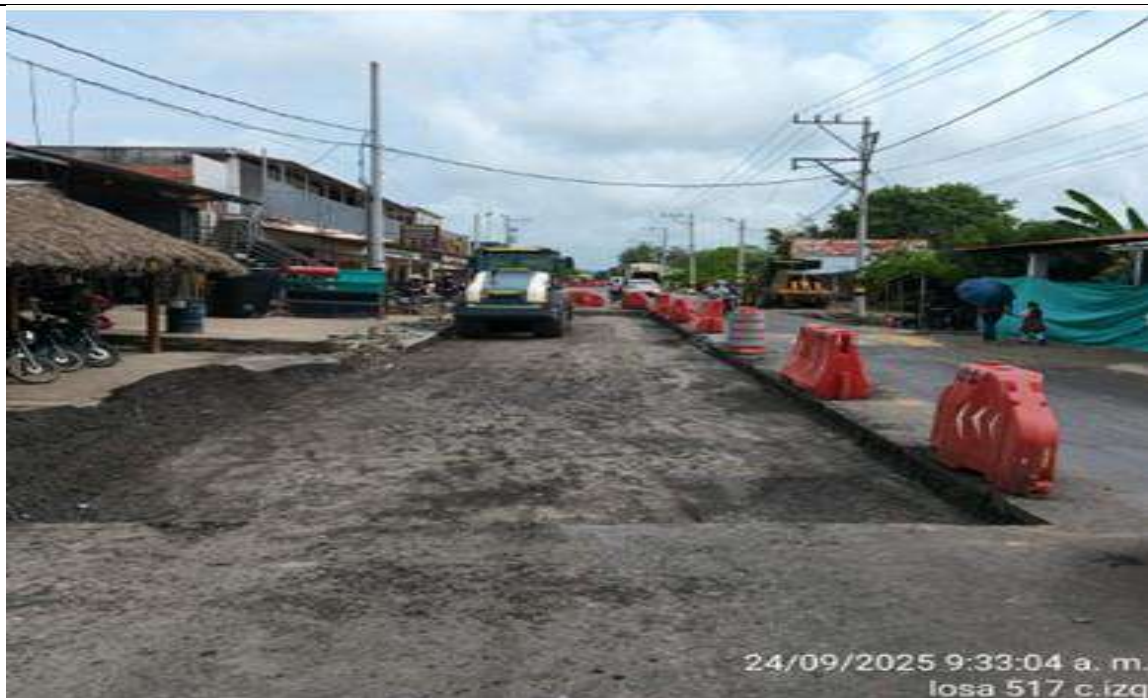
PR 1+623 al 1+655 carril izquierdo. Compactación de Base granular.
