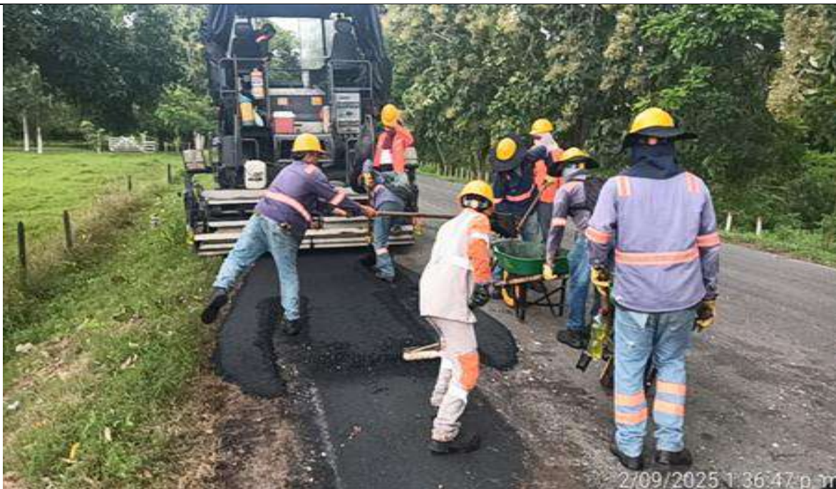
PR 1+000 carril izquierdo. Instalación de mezcla MDC 19 para bacheo.
