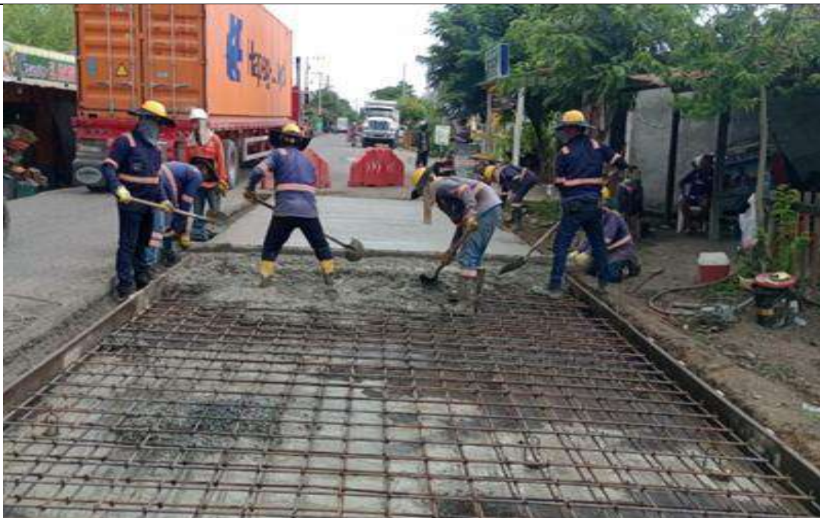
PR 1+745 a mayor, en el carril izquierdo. Fundida de módulos en concreto MR40.
