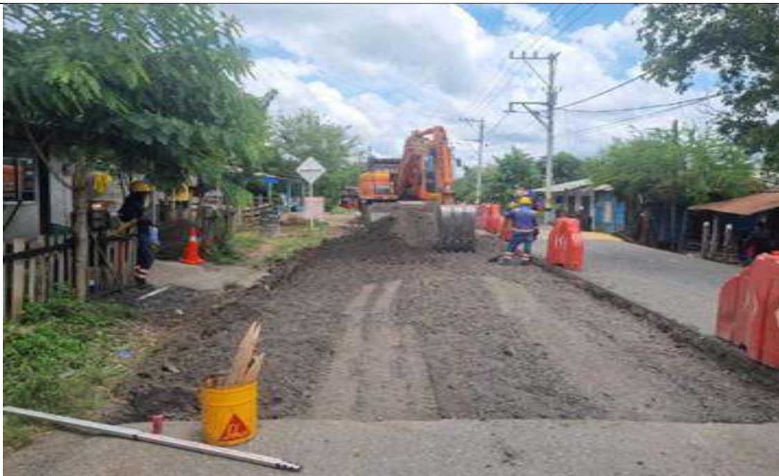
PR 1+745 carril izquierdo. Demolición de carpeta asfáltica y nivelación de base en centro poblado (corregimiento Santa Lucía).
