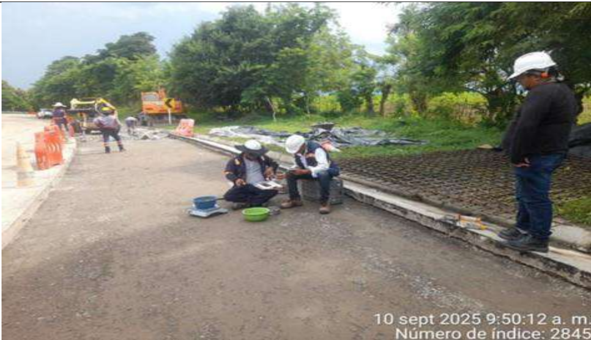
Pr 9+060-087 carril derecho. Toma de densidades a tramo con SBG.
