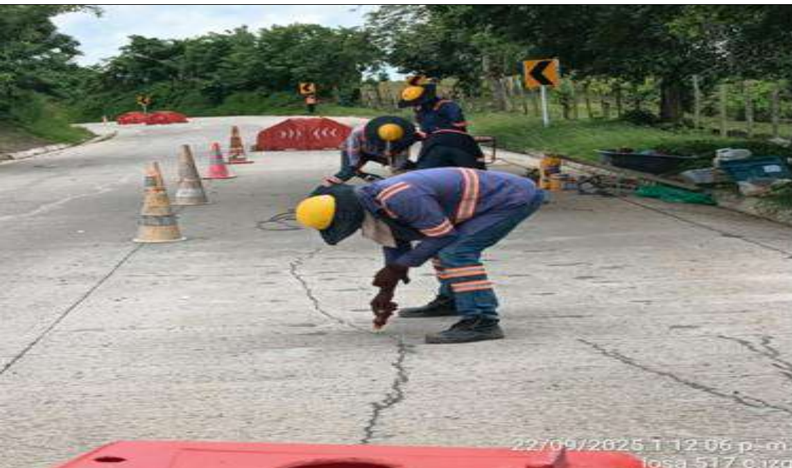
PR 13+340 carril izquierdo. Adecuación de módulos en concreto MR40 por método de costura cruzada.
