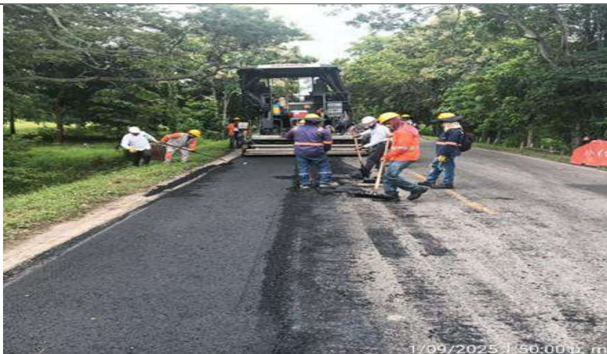
PR 0+700 carril izquierdo. Instalación de mezcla MDC19 para bacheo.
