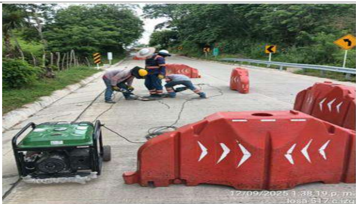
PR 15+020 a mayor, carril derecho. Adecuación de módulos en concreto MR40 por método de costura cruzada.
