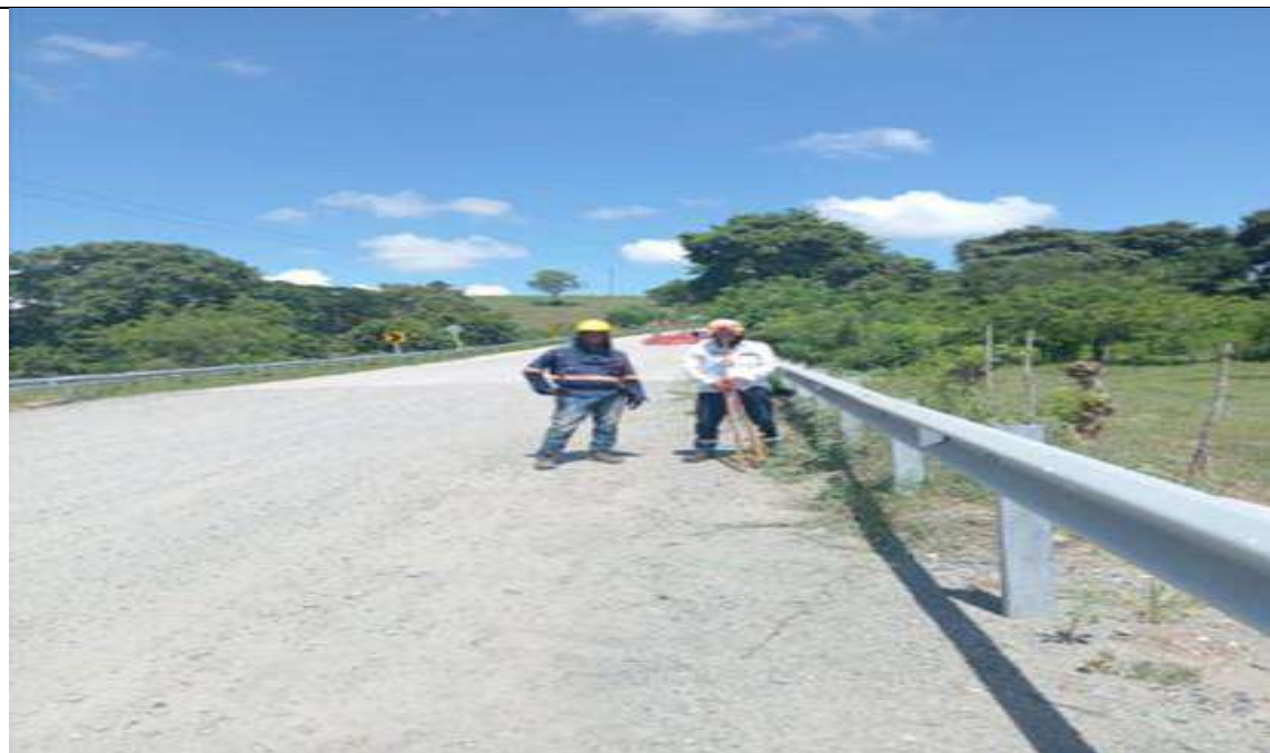
Pr 25+700. Control de asentamientos en broches.
