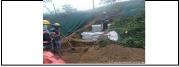
excavación manual para construcción de dissipador PR27+260
