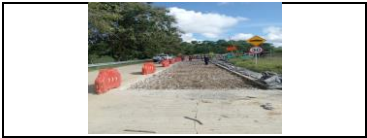
demolición de losas en el PR 13+620
