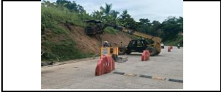
perforaciones de talud para instalación de malla triple torsión en el PR 15+400 margen izquierda.
