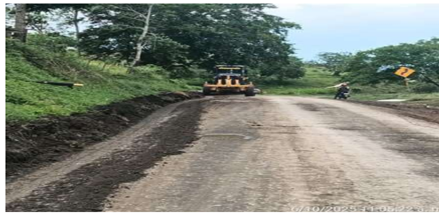
PR 31+350 a mayor. Mantenimiento de vía.
