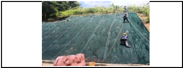
Instalación de Malla triple torsión en talud del PR 15+380 lado izquierdo..
