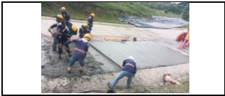
construcción de módulos en concreto MR 40 en el PR10+850 carril derecho
