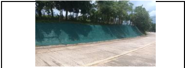
geomanto instalado del lado derecho del PR 9+150 a mayores
