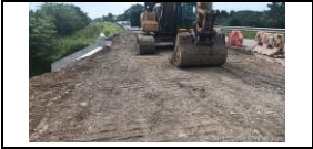
instalación de terraplén sobre losa superior del box culvert del PR 34+658, carril derecho.
