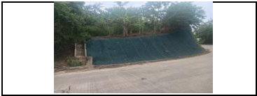
Estabilización de talud con malla triple torsión PR13+950
