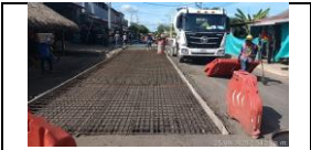
construcción de módulos en concreto MR40 del PR1+623.9 al PR1655.4 carril izquierdo
