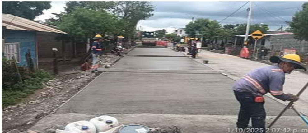
PR 1+776 a menores. Fundida de módulos en concreto MR40 por el carril derecho.
