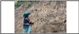
Instalación de semilla de voleo en talud del PR 15+415 a mayores, lado izquierdo
