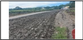
conformación de calzada del Pr 33+180 a mayores.
