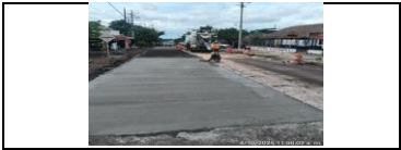
Construcción de losas MR40 del PR 1+522,9 al PR 1+554.9 carril derecho.
