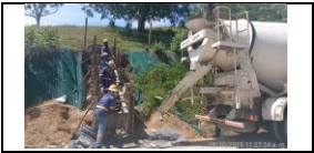
Construcción de dissipador PR27+320 lado izquierdo
