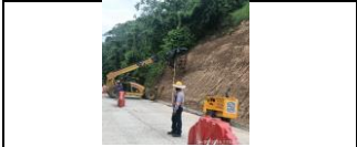
perforaciones para instalación de pernos y malla en talud del PR 15+400 margen izquierda.
