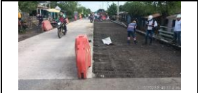
Instalación de acero de refuerzo carril derecho del PR 1+745.3 al PR1+776.8
