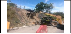
Perforaciones para instalación de pernos PR4+600
