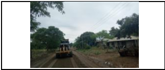
Mantenimiento de calzada PR34+800
