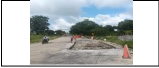
Demolición de losas en el PR10+850 carril derecho
