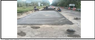
PR 13+620 carril derecho reconstrucción de módulos en concreto MR40
