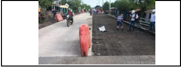
Instalación acero de refuerzo carril derecho del PR 1+745,3
