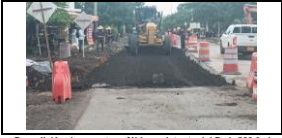
Demolición de carpeta asfáltica existente del Pr 1+522.9 al 1+554.9 carril derecho
