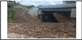
Adecuación laterales de puente 45+700.
