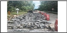
demoliciones de módulos en concreto MR40 del PR 13+560 a menores carril derecho.
