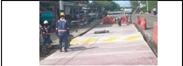
Aplicación de pintura de tráfico en resalto PR1+624 en el carril izquierdo.
