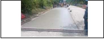
Reconstrucción de módulos MR40 PR13+477 carril derecho
