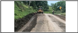
conformación de calzada PR 31+950 a mayores
