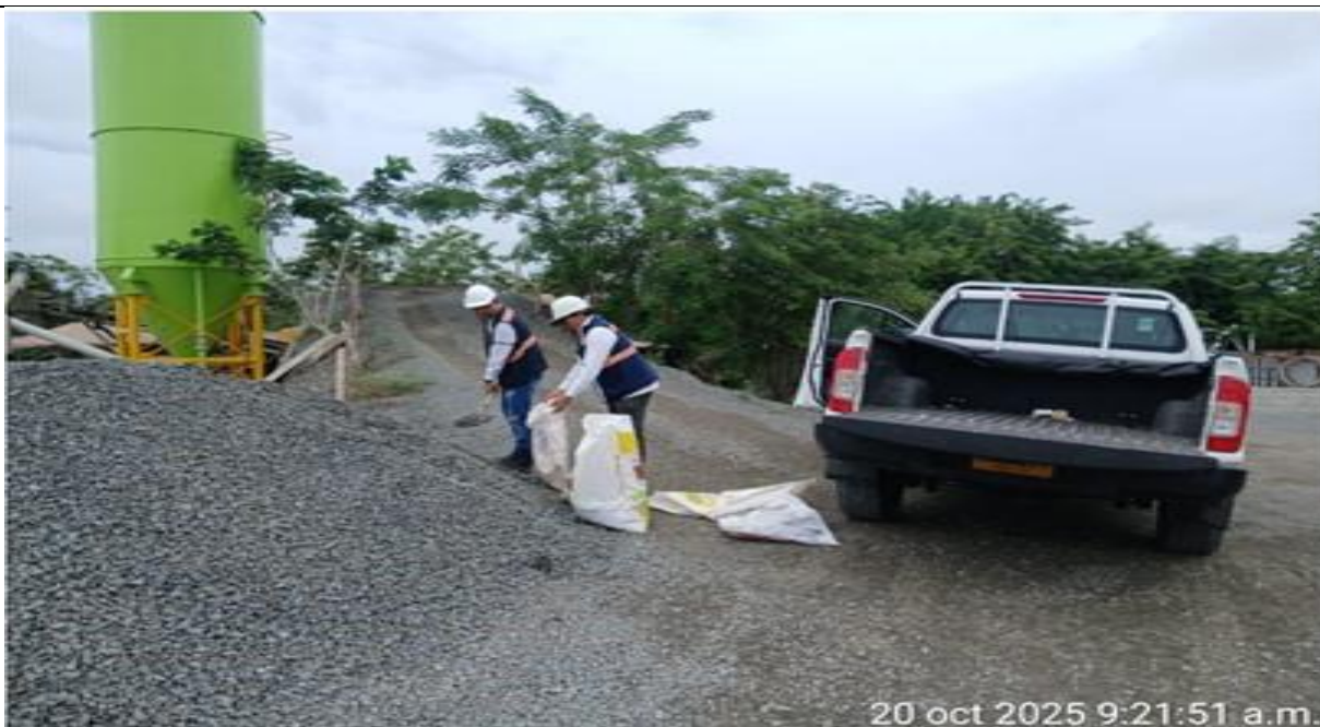
PR4+400 lado derecho. Toma de muestras agregados de concreto para ensayos de laboratorio.
