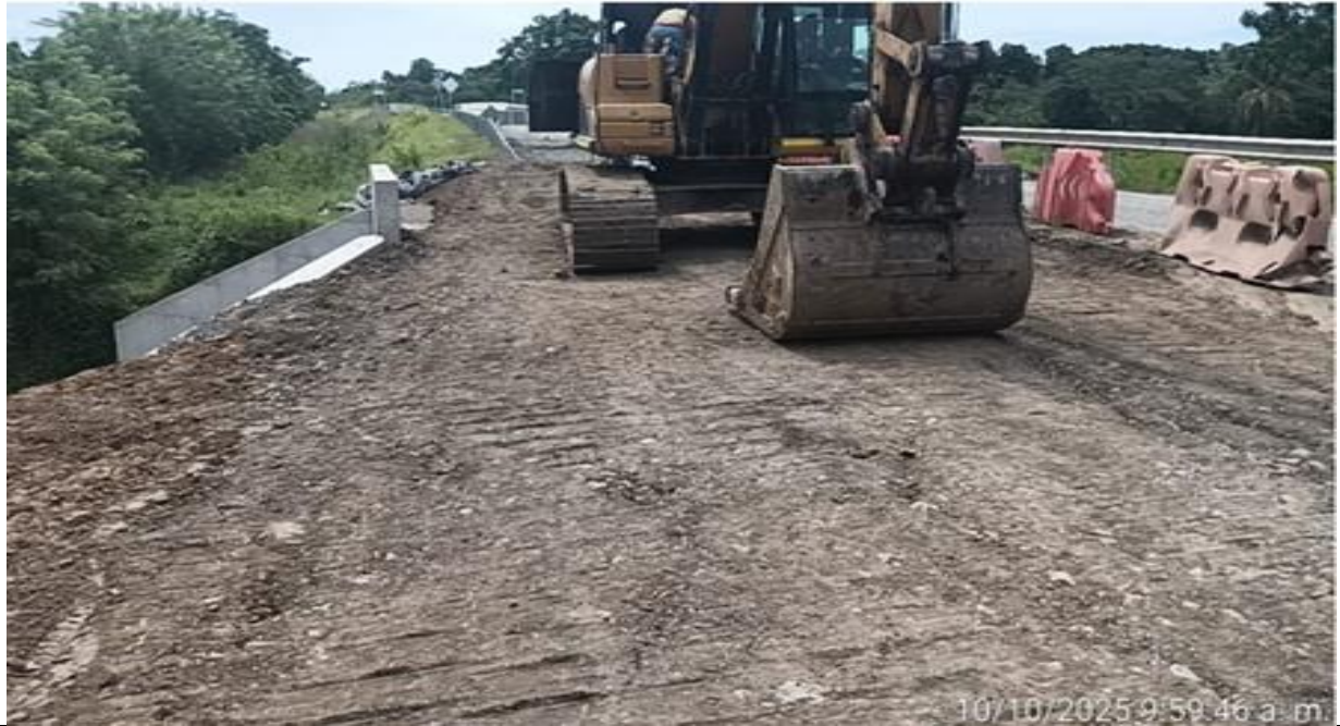
PR 34+658 carril derecho. Instalación de material de terraplén sobre losa superior del box culvert.
