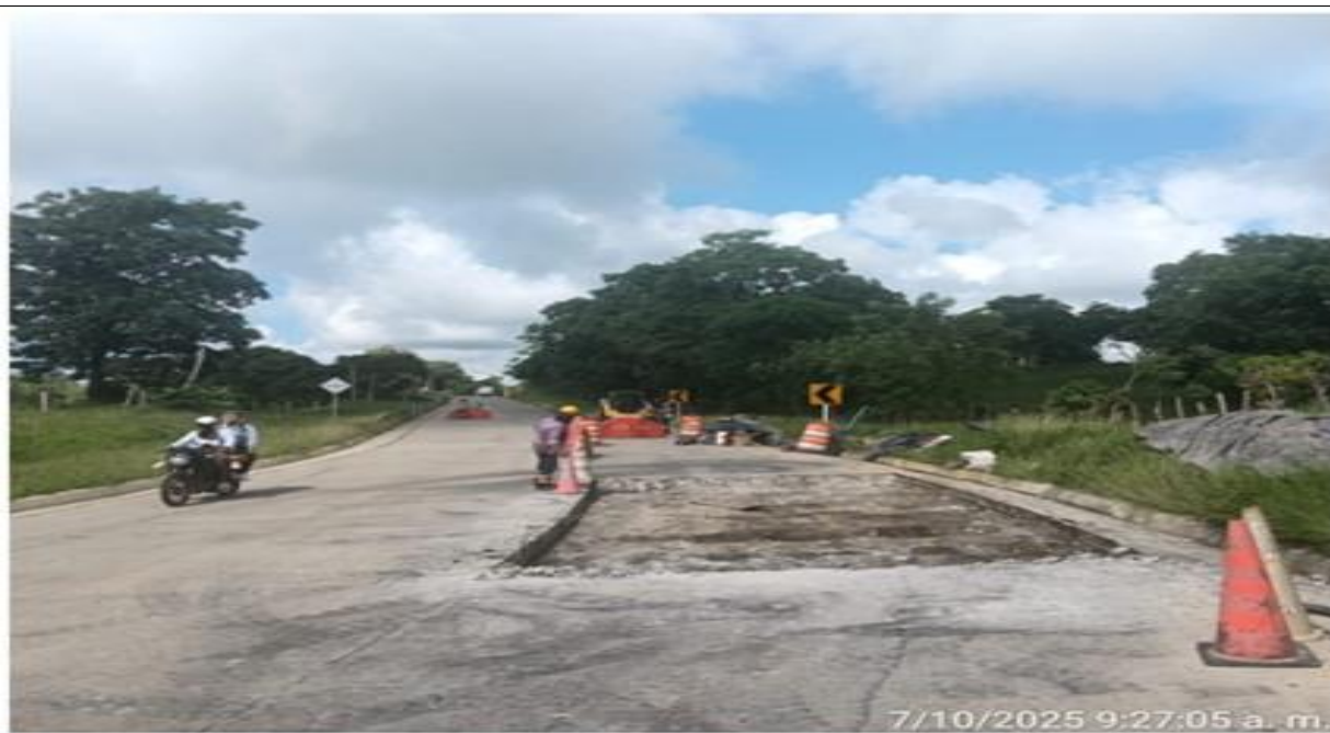
PR 10+850 carril derecho. Demolición de losas.
