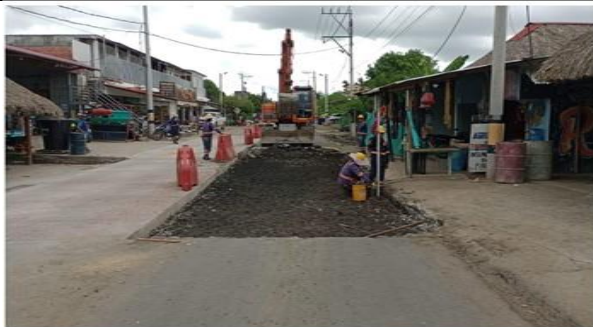
PR 1+623 carril derecho. Demolición de carpeta asfáltica.
