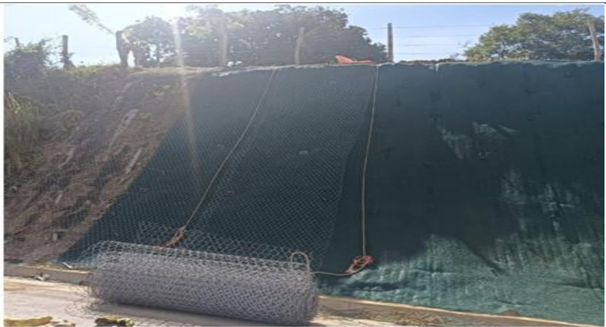
PR 4+630 lado izquierdo. Instalación de malla triple torsión.
