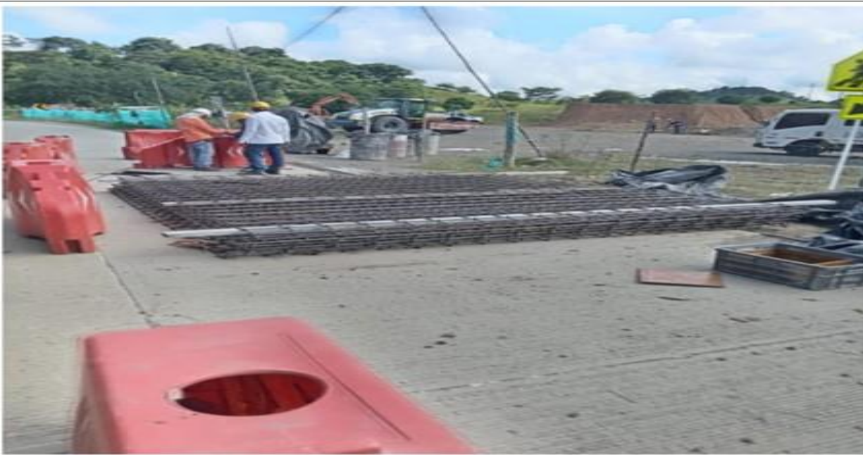
PR 13+600 margen derecha. Armado de acero para losas.
