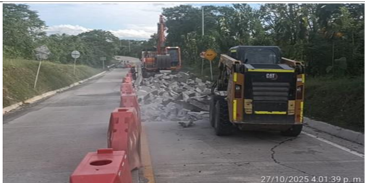
PR 8+532 carril izquierdo. Demolición de losas.
