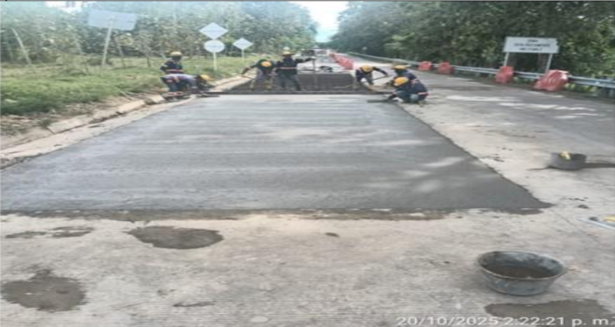
PR 13+620 carril derecho. Fundida de módulos en concreto MR40.
