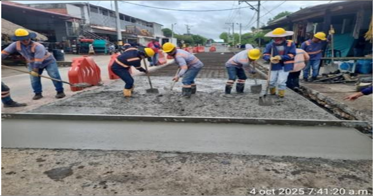
PR 1+623 a mayor. Fundida de losas en concreto MR 40 por el carril derecho.
