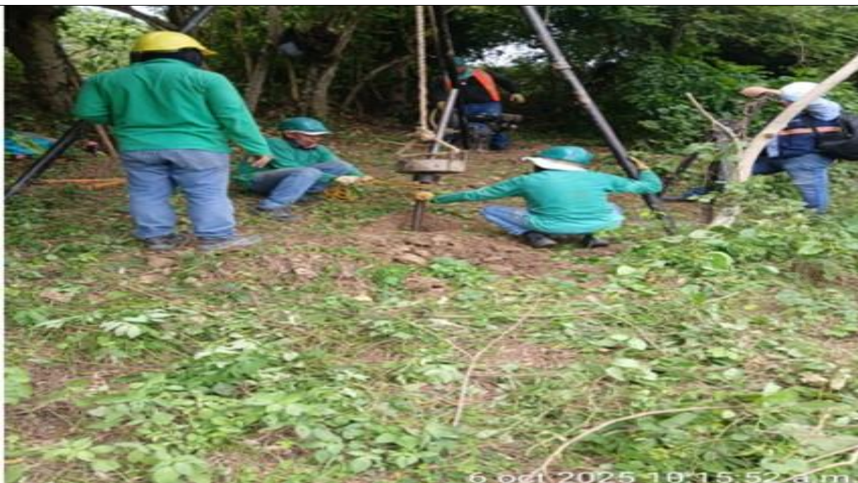
PR8+400 lado izquierdo. Sondeo SPT para muro de contención.
