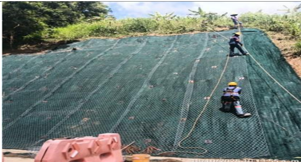
PR 15+380 / 400 lado izquierdo. Instalación de malla triple torsión.
