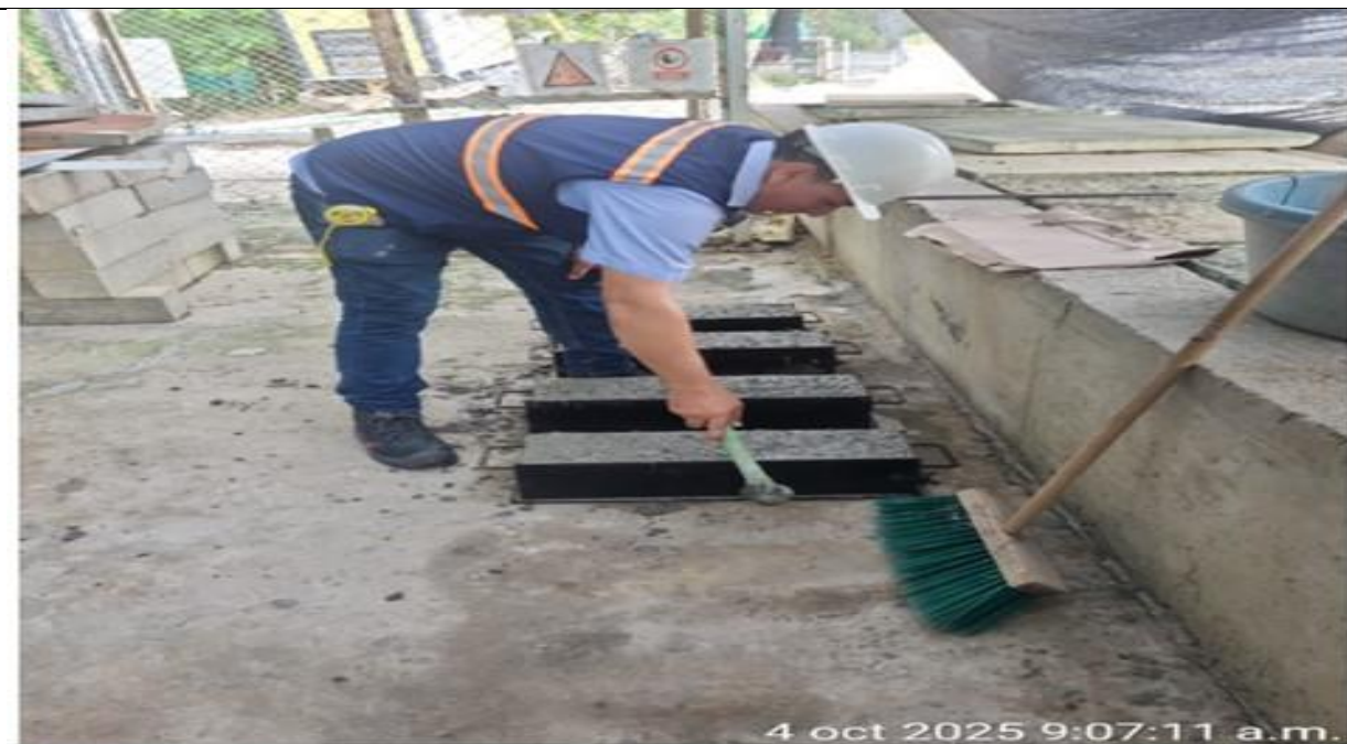
PR 4+400. Toma de muestras al concreto MR 40 para ensayos de laboratorio.
