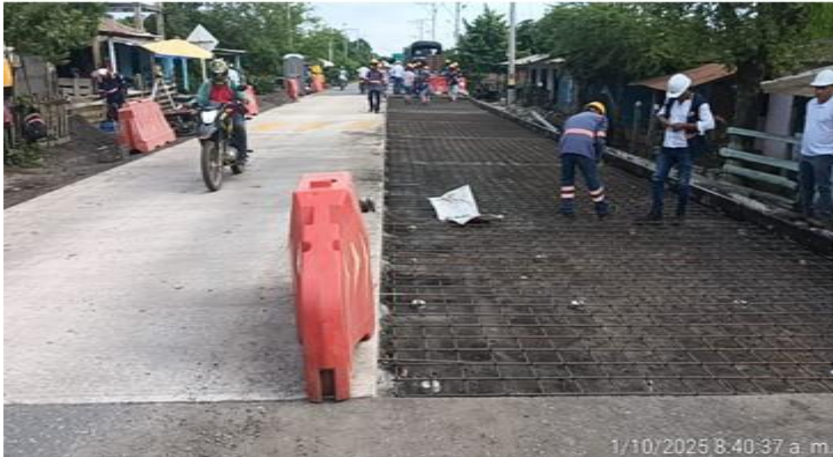
PR 1+745,3 al 1+776.8 carril derecho. Instalación acero de refuerzo.
