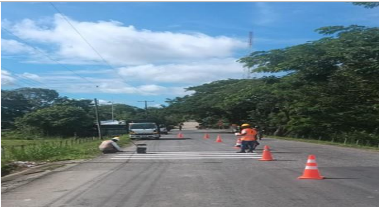
PR 0+105. Aplicación de pintura de tráfico.
