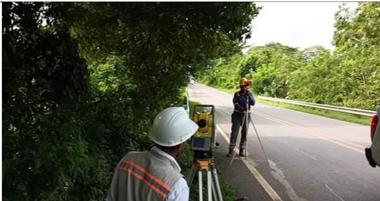
PR 6+100. Monitoreo topográfico para control de asentamiento.
