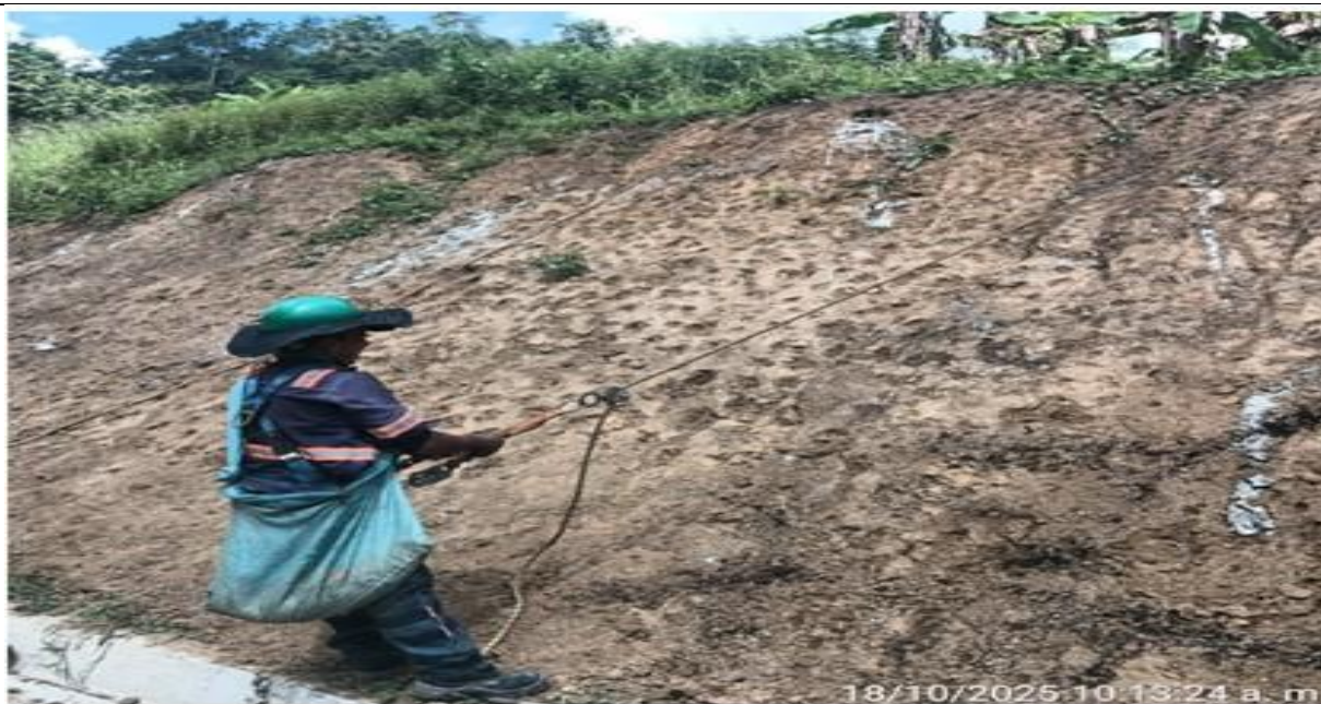
PR 15+415 lado izquierdo. Instalación de semilla en talud.
