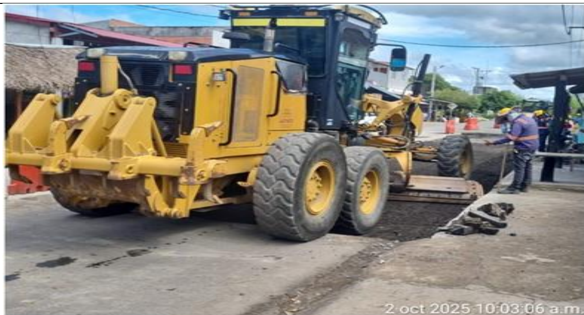
PR 1+623 carril derecho. Cereo a subbase granular.
