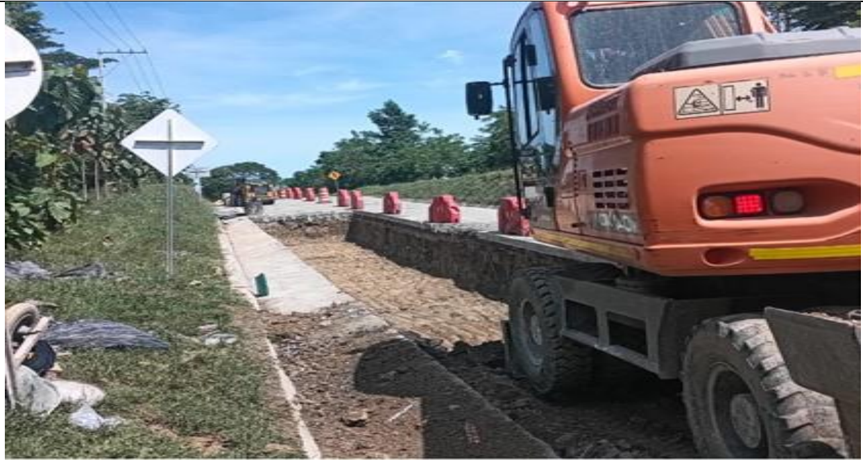
Pr 8+506 al 8+542 carril izquierdo. Se realizan actividades de cajeo.
