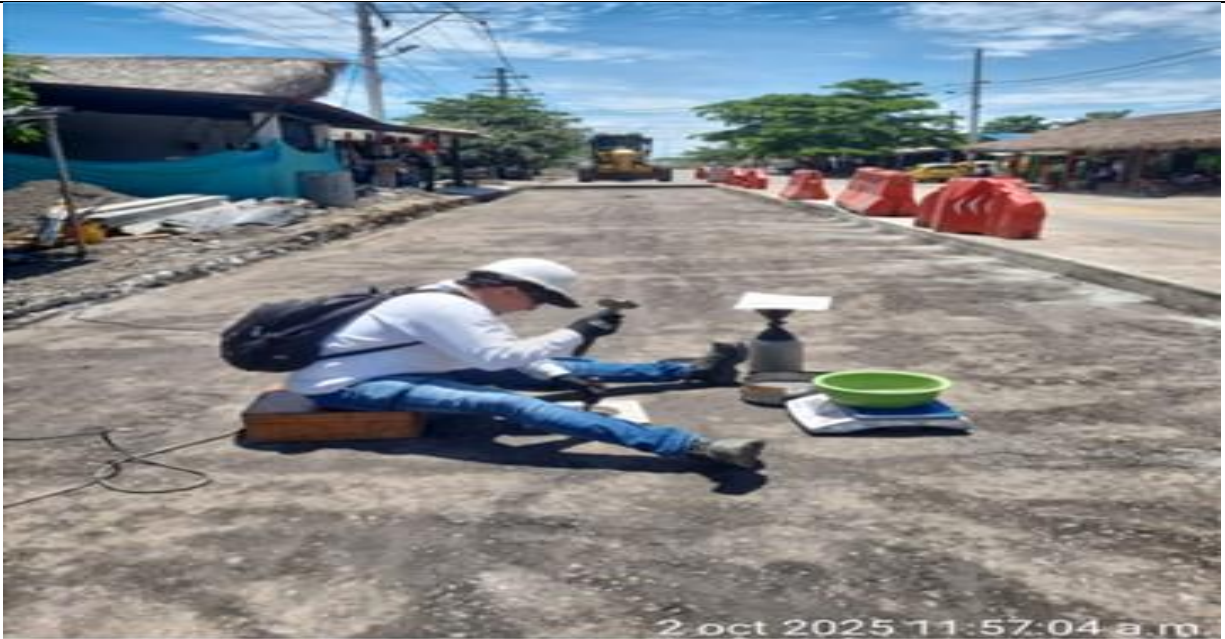
PR 1+522 al 1+554 carril derecho. Toma de densidades.
