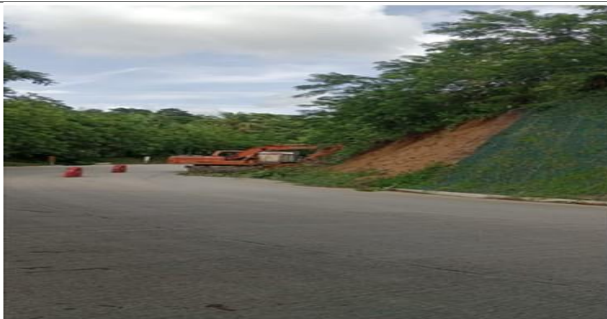
PR 13+950 lado derecho. Perfilación de talud.
