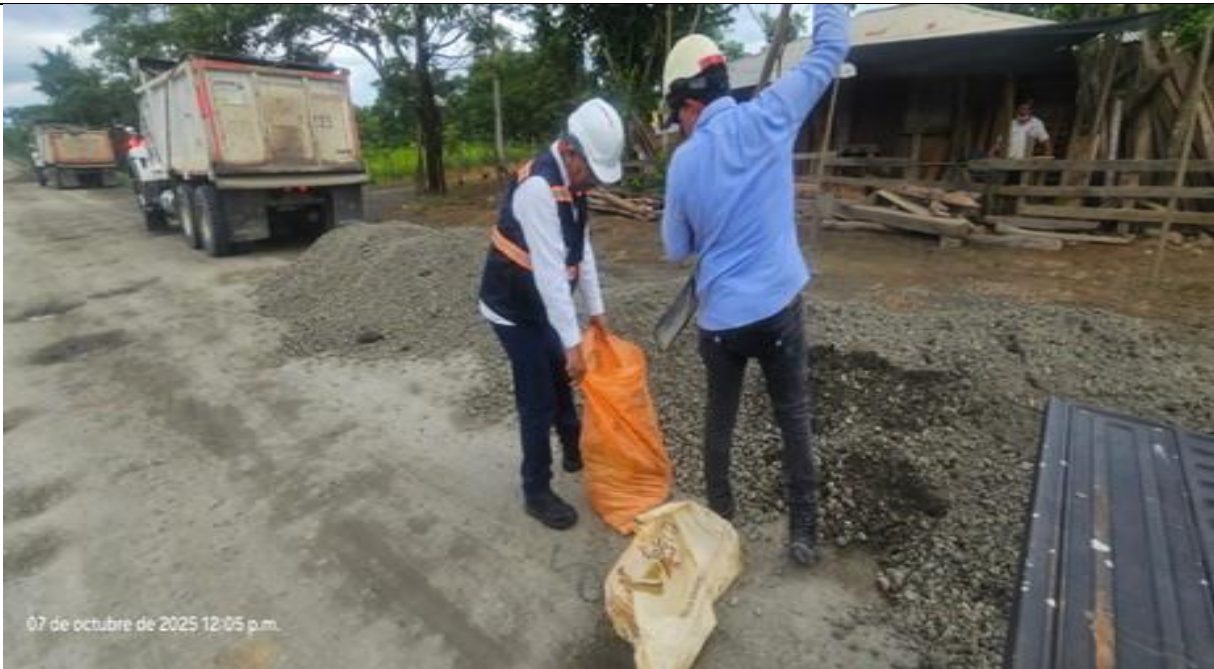
PR 32+700 calzada completa. Toma de muestras material de afirmado.
