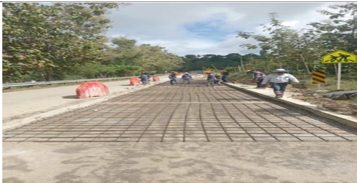
PR13+510 lado derecho. Instalación de acero para losas reforzadas.
