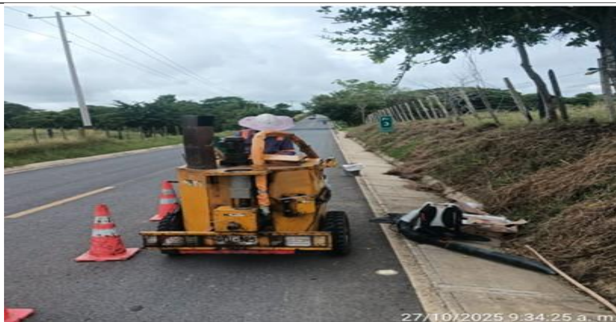
PR 2+000. Sello de grietas en MDC 19.
