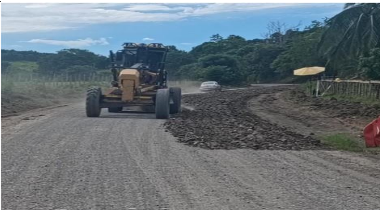
PR 33+180 a mayor. Conformación de vía existente.
