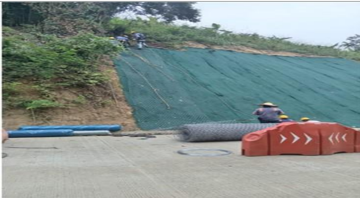
PR 15+380 a mayor margen izquierda. Instalación manto TRM 500 y malla triple torsión.
