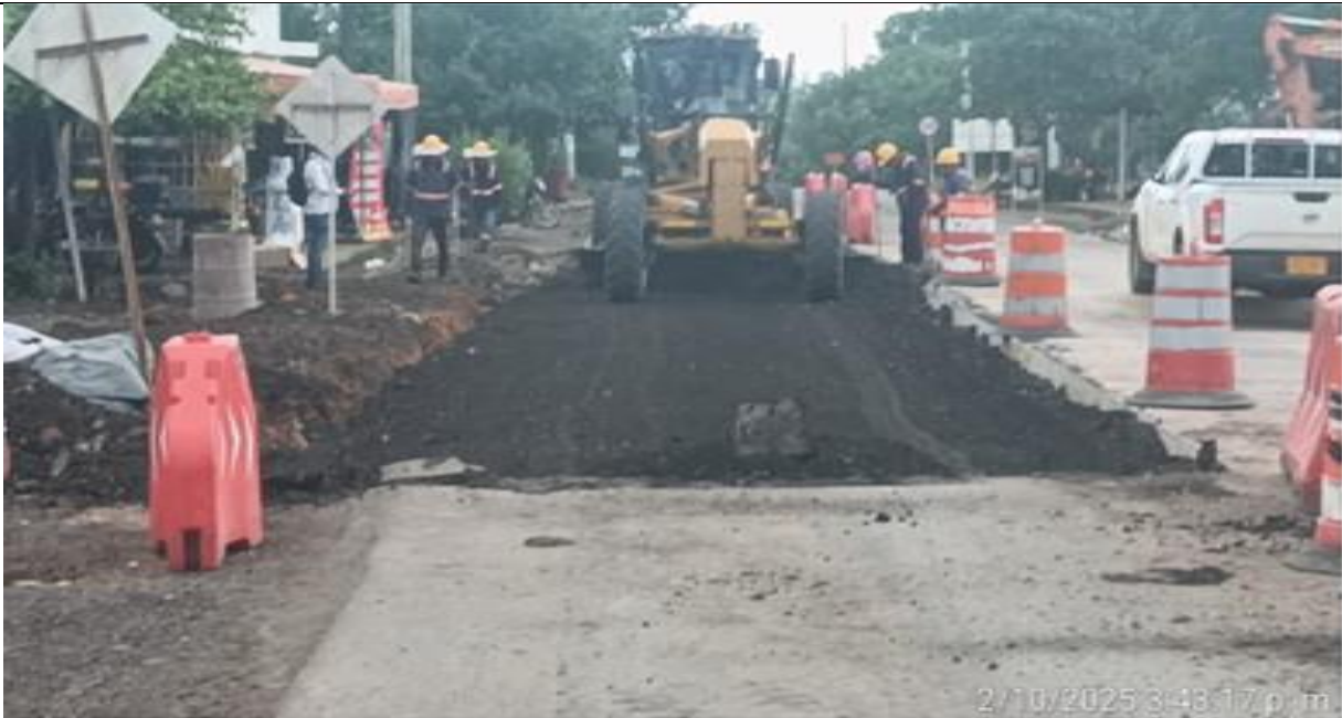
PR 1+522 al 1+554 carril derecho. Demolición de carpeta asfáltica.
