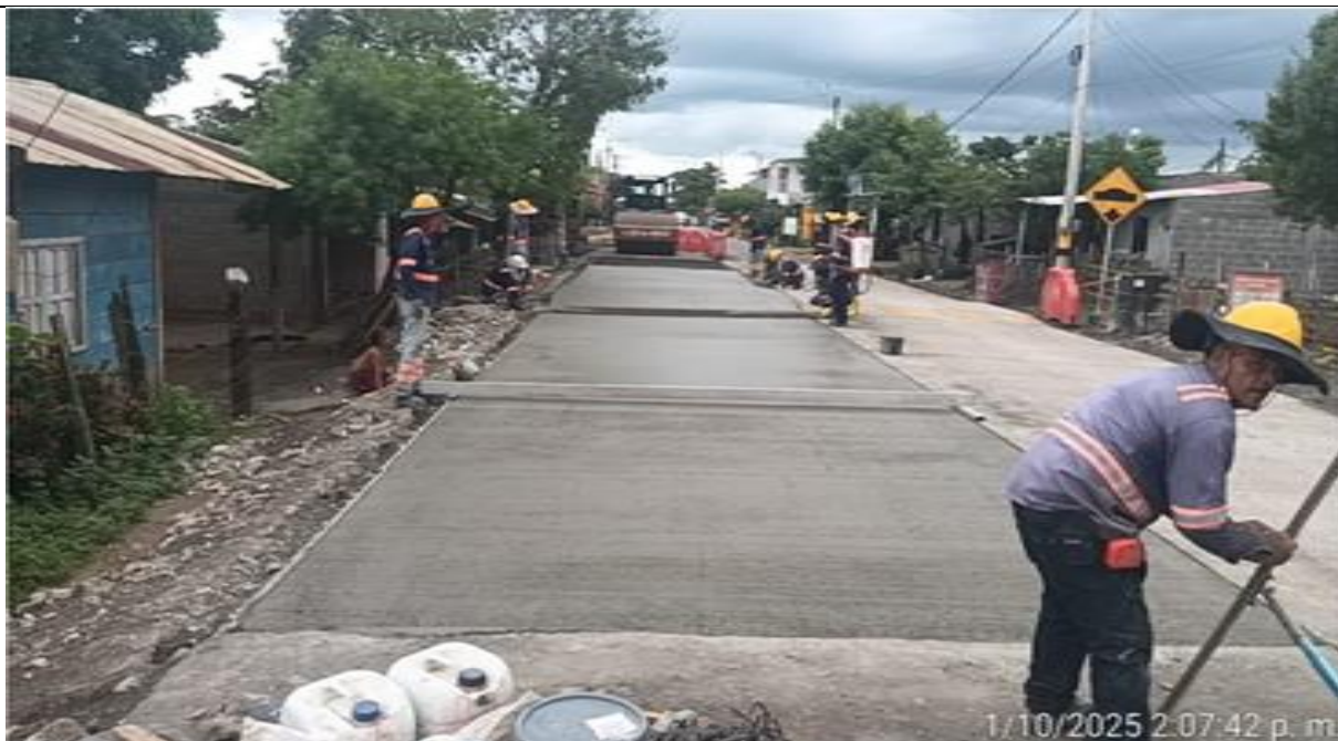
PR 1+776 a menores. Fundida de módulos en concreto MR40 por el carril derecho.
