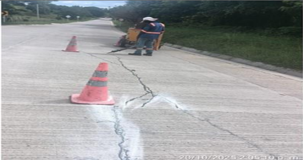
PR 25+910 carril izquierdo. Aplicación polibit para sellar grietas losas con 2 y 3 cm de ancho aprox.
