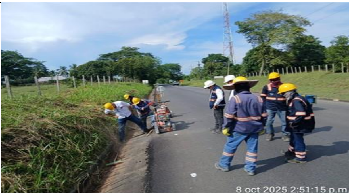
PR 0+110 carril izquierdo. Extracción de muestras en conjunto con el contratista para ensayos de laboratorio.
