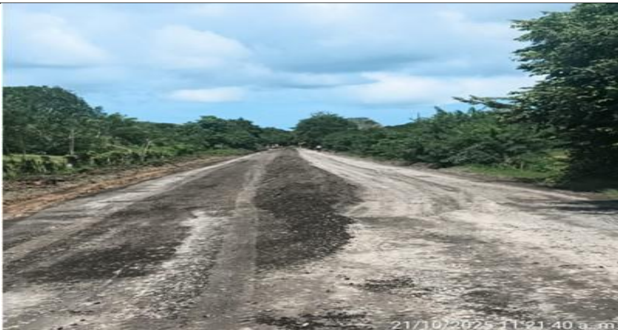
PR 33+880 a mayor. Mantenimiento vía existente.
