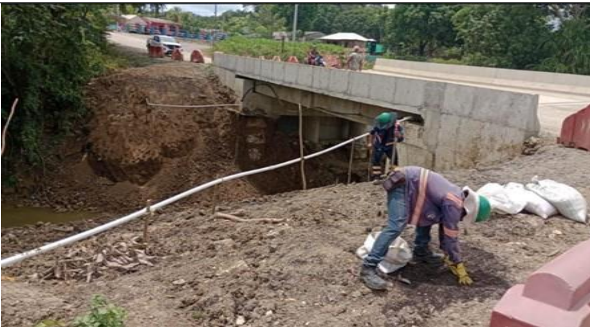
PR 45+700 margen derecha. Instalación de semilla al voleo.
