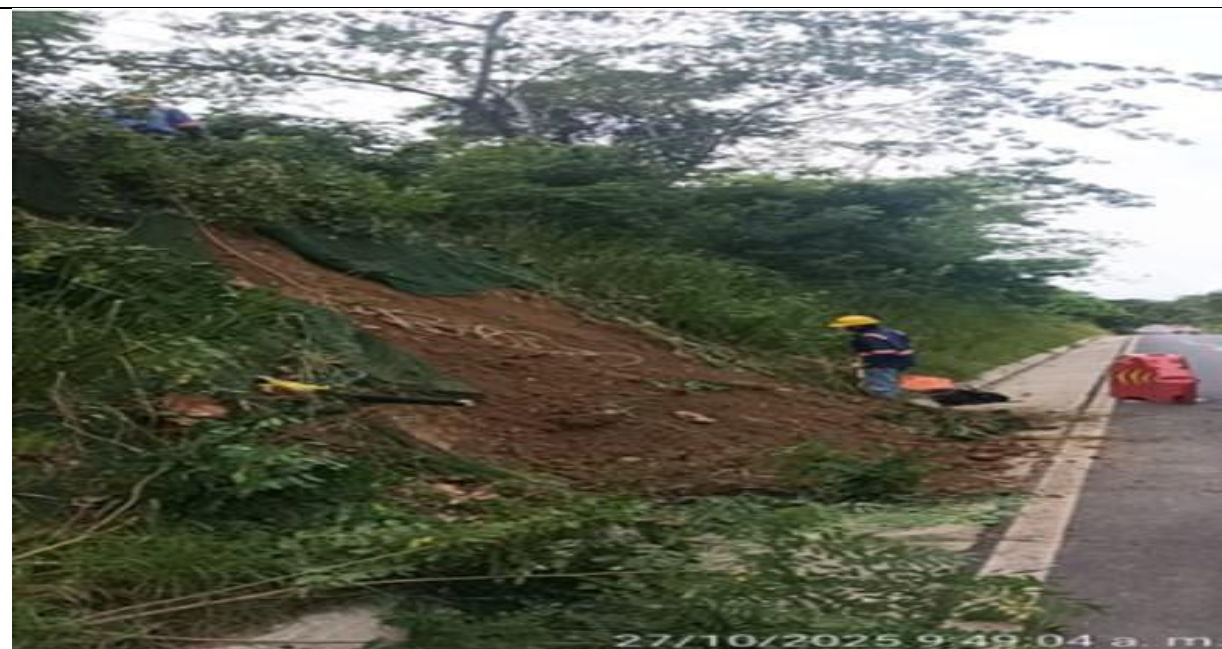
PR 5+004. Limpieza de talud.
