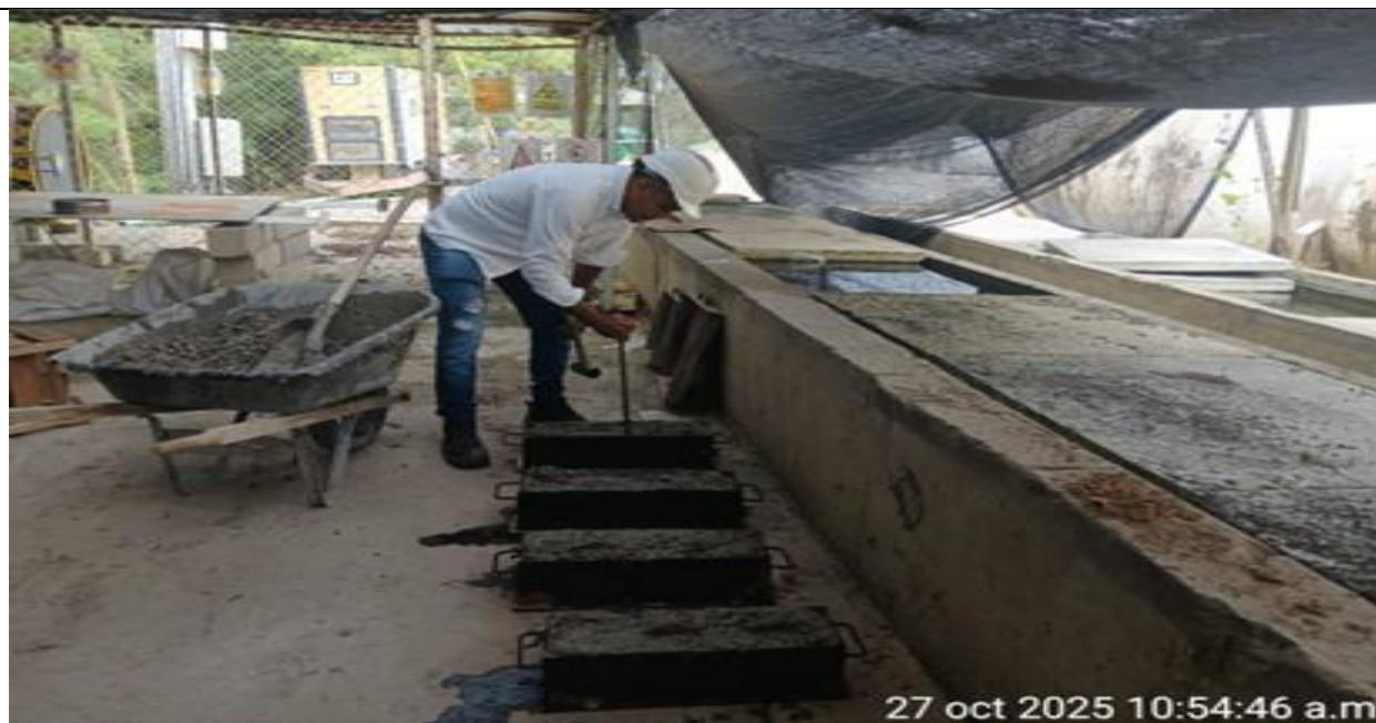
PR 4+400. Toma de muestras de concreto MR40 para ensayos.
