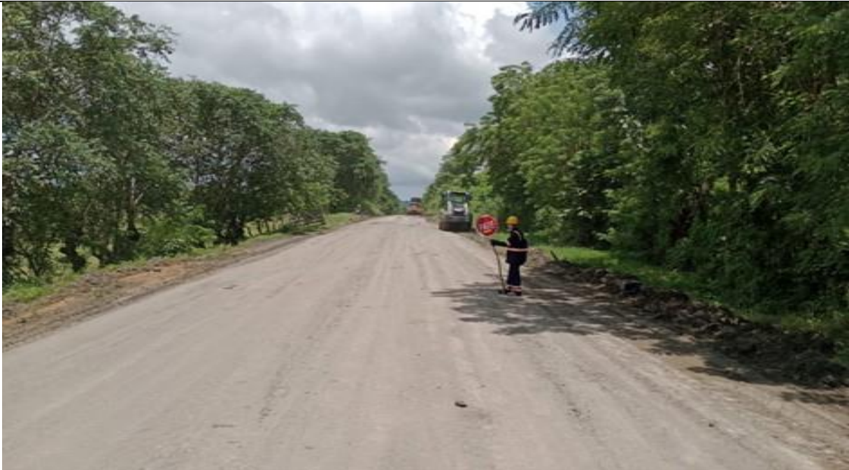
PR 31+950 a mayor. Trabajos de conformación de vía existente.
