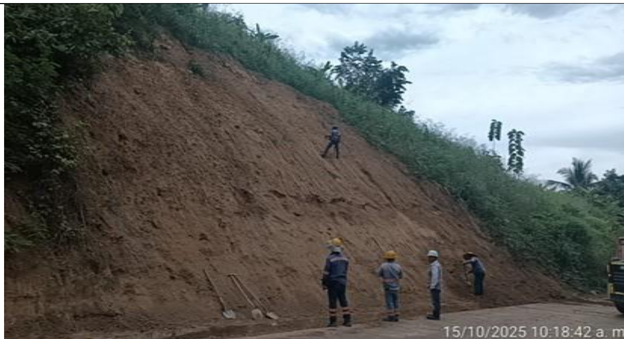
Talud PR 15+400 margen izquierda. Instalación de semillas.
