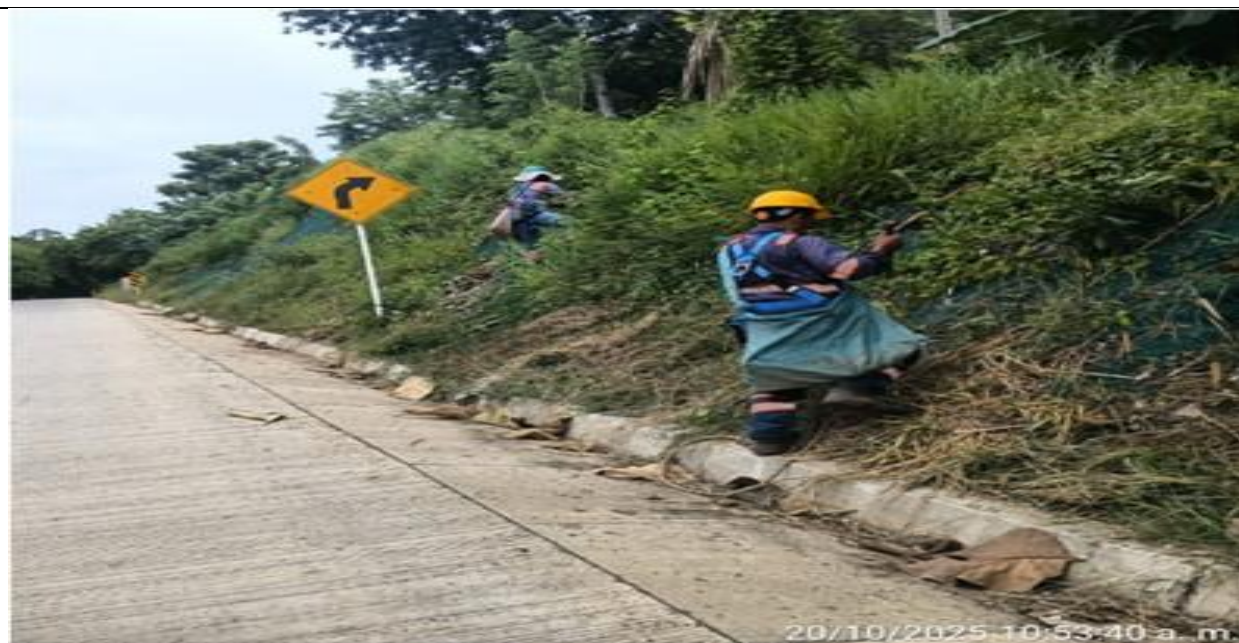
13+760 Lado derecho. Instalación de pasto vetiver.
