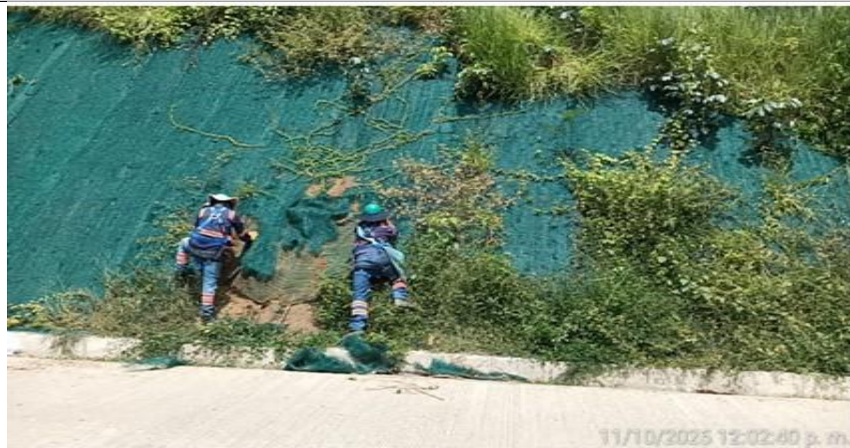
PR 13+920 margen derecha. Limpieza y organización de geomanto desprendido en el talud.
