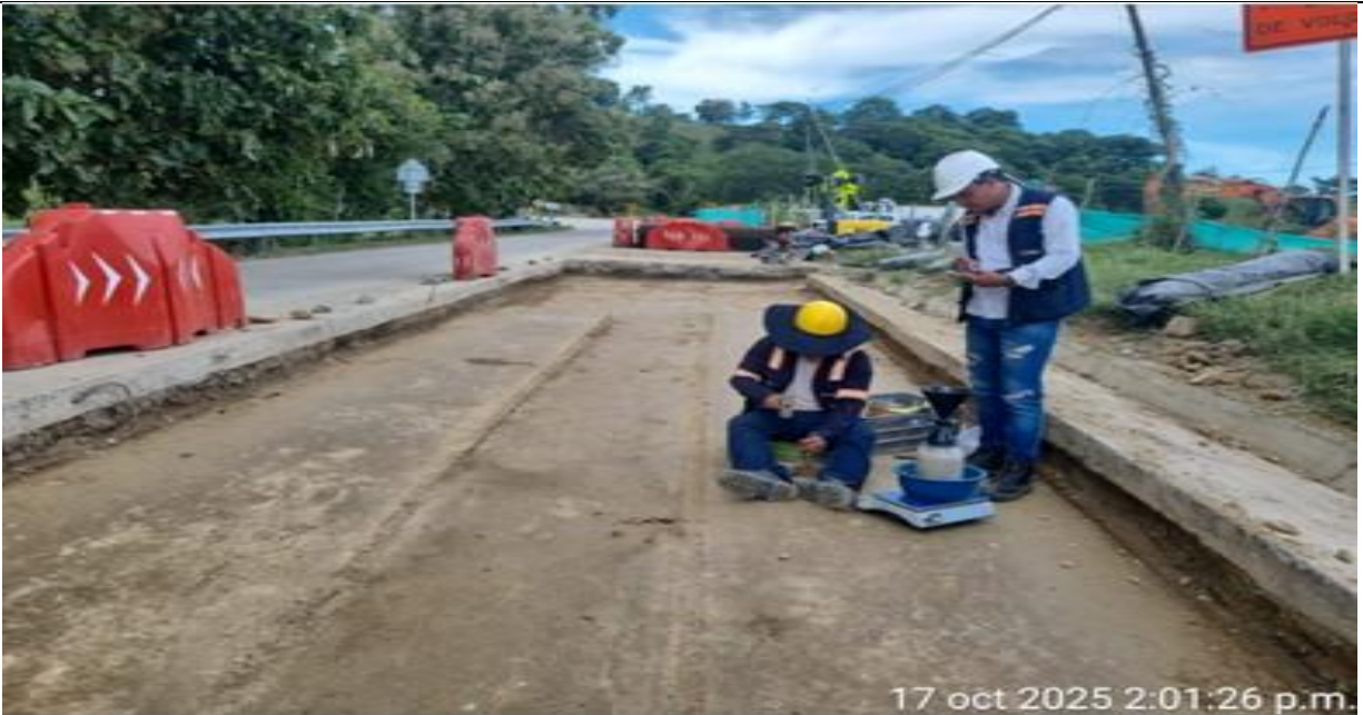
PR 13+430 lado derecho. Toma de densidades en la subrasante estabilizada.
