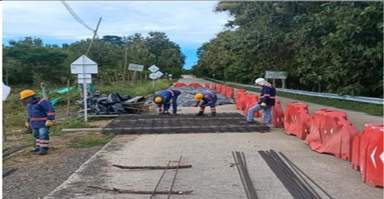
PR 13+620 carril derecho. Instalación acero de refuerzo para losas en concreto MR40.
