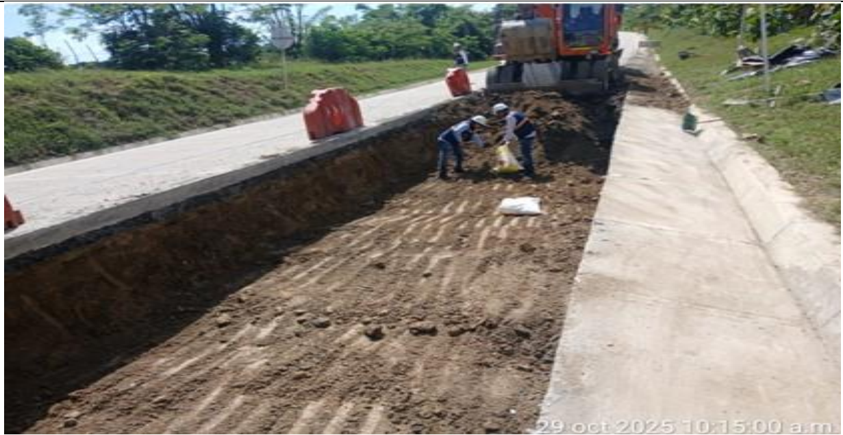
PR8+506 al PR8+542 carril izquierdo. Toma de muestras del suelo natural del cajeo realizado.
