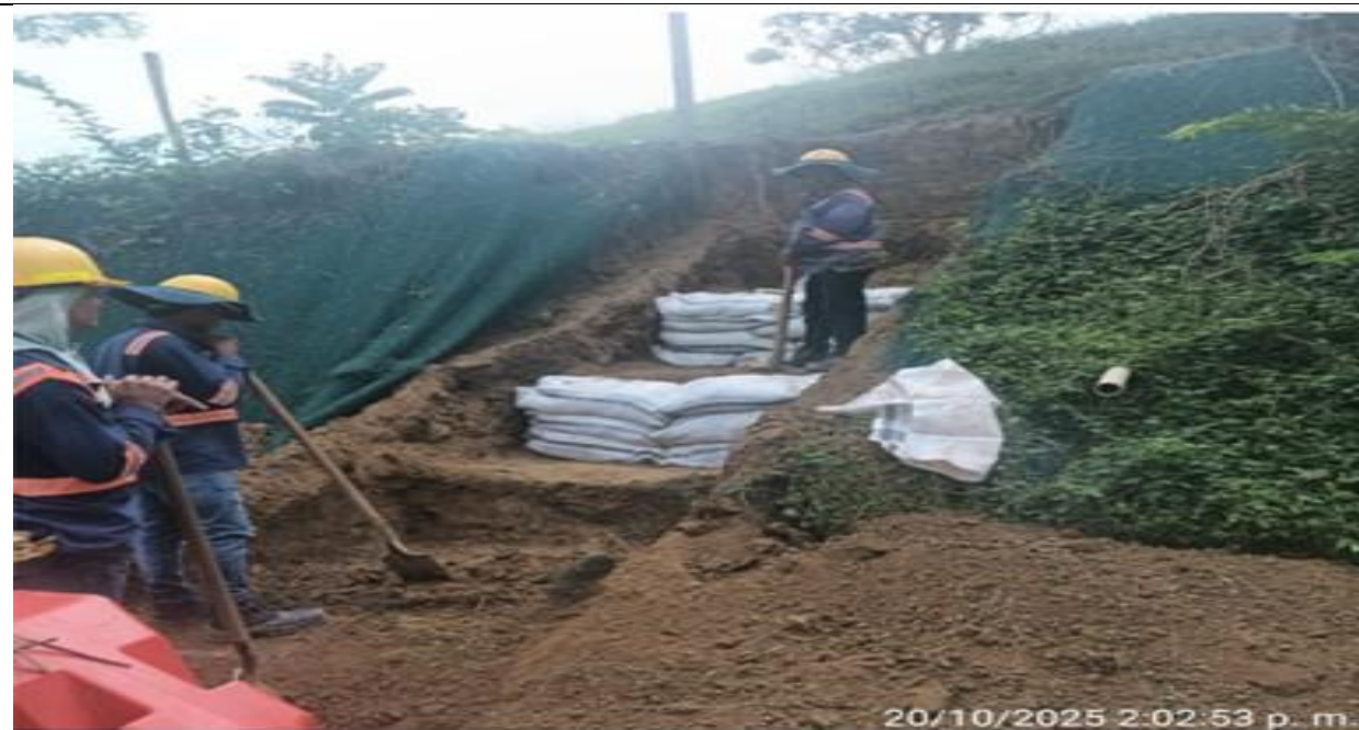
PR 27+260 lado izquierdo. Excavación manual para construcción de disipador.
