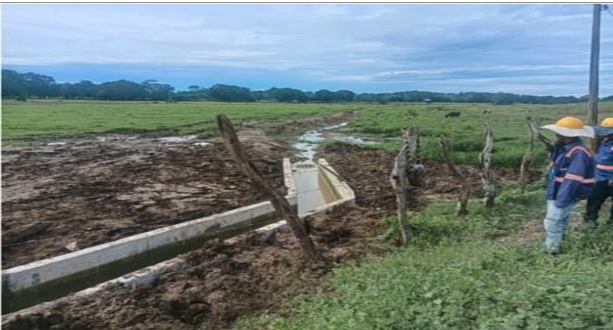
R 35+340 lado izquierdo. Excavación y conformación de descole.
