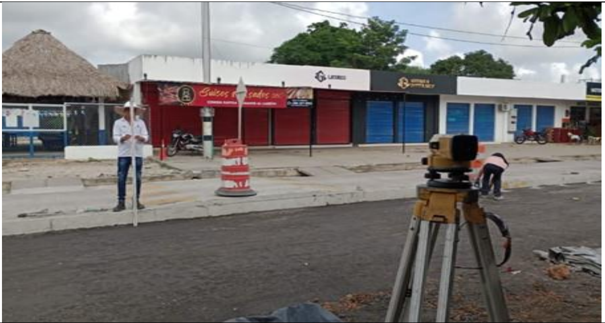
PR 1+ 522.9 al PR 1+554.9 carril derecho. Revisión de niveles de base granular.
