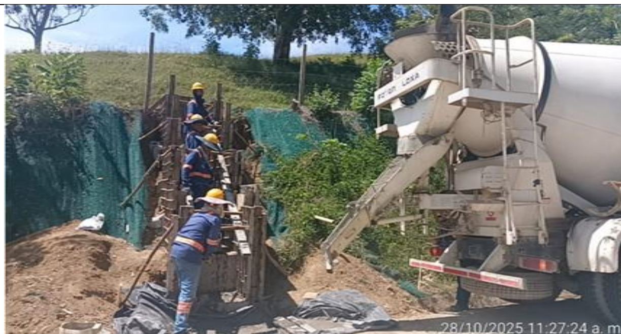
PR 27+320 lado izquierdo. Fundida de muro de dissipador.
