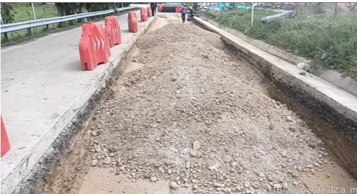
PR 13+430 lado derecho. Cajeo en instalación de material de terraplén mezclado con cal viva.
