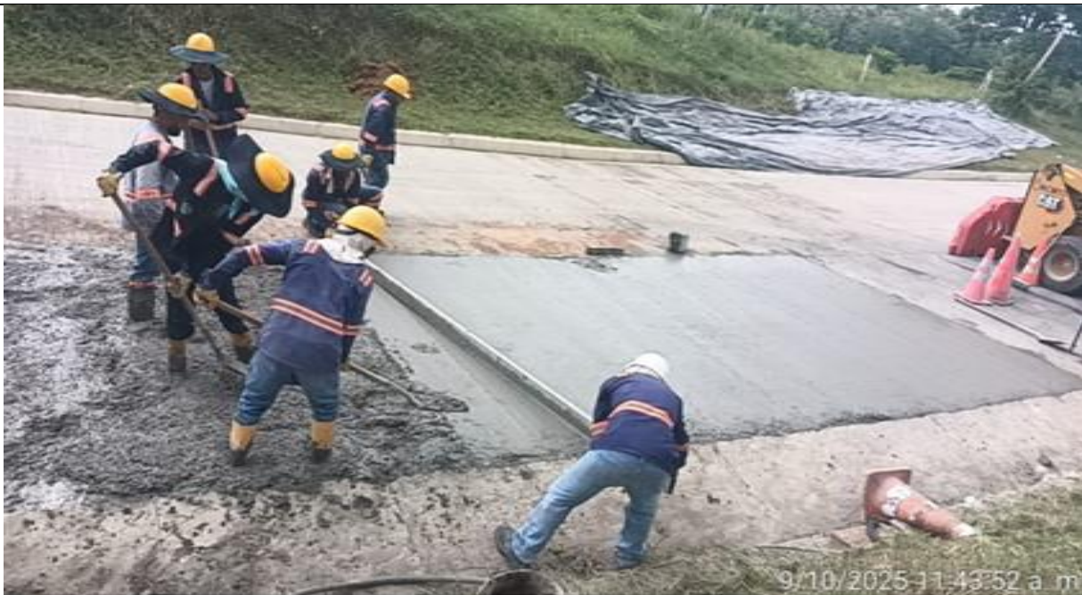
PR 10+850 carril derecho. Fundida de módulos en concreto MR 40.
