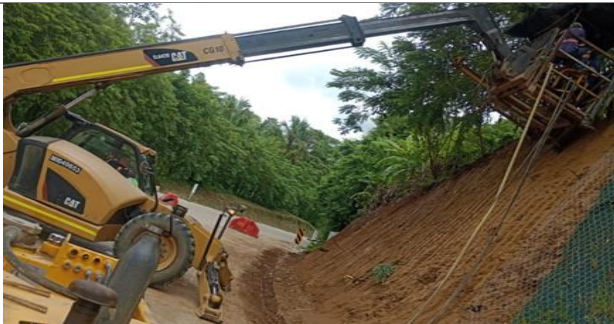
PR 13+950 lado derecho. Perforaciones en talud.
