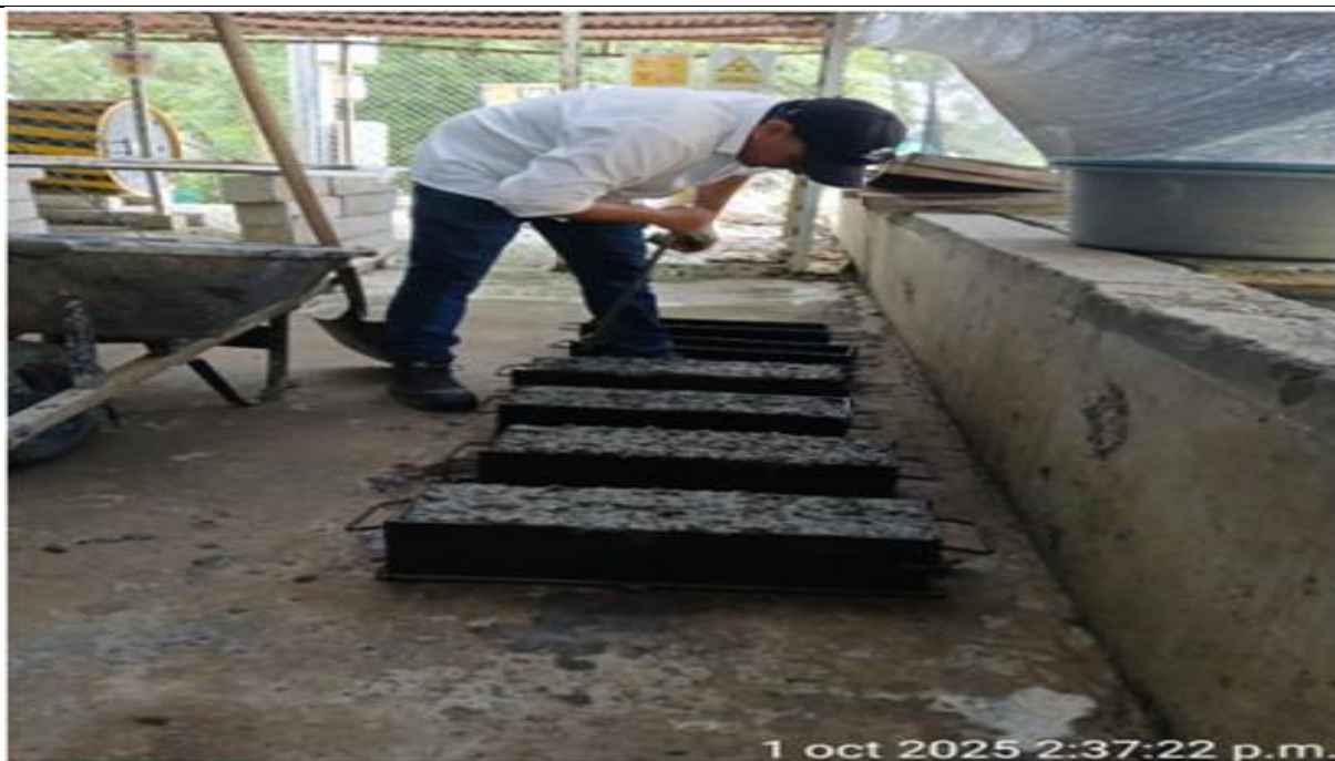
PR 1+745 al PR 1+776 carril derecho. Toma de muestras MR40 para ensayos de laboratorio.
