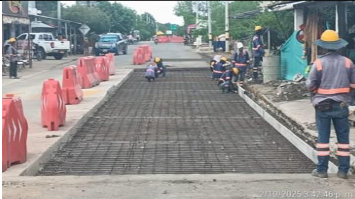
PR 1+623 al 1+655 carril derecho. Instalación acero de refuerzo para losas reforzadas.
