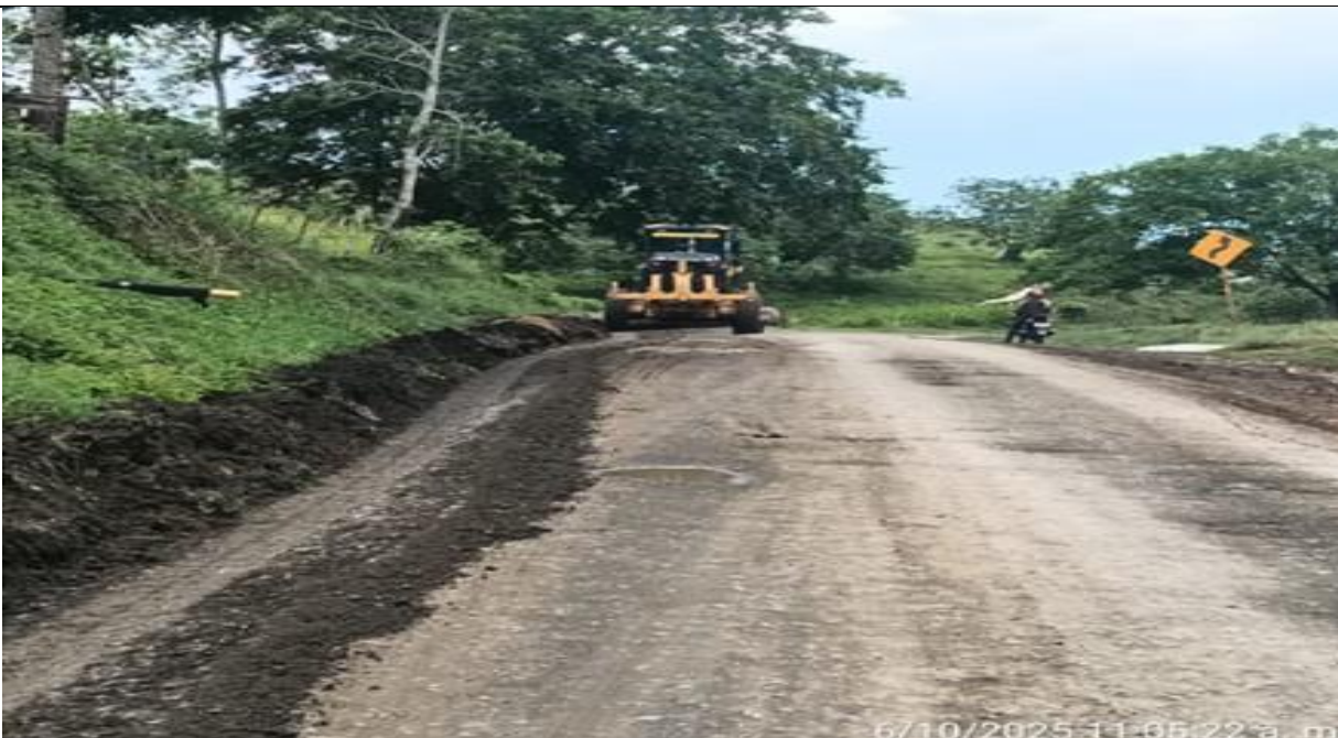
PR 31+350 a mayor. Mantenimiento de vía.
