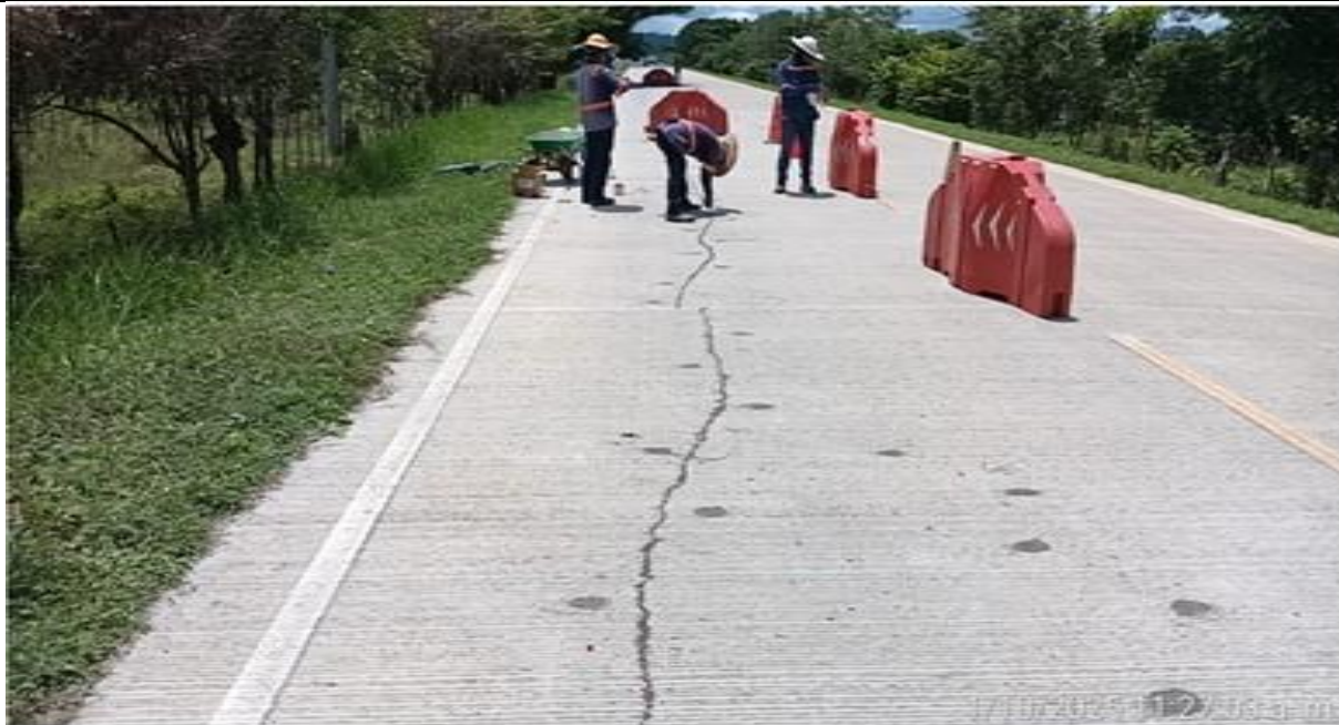
PR 19+900 carril derecho. Costuras de módulos en concreto MR40.
