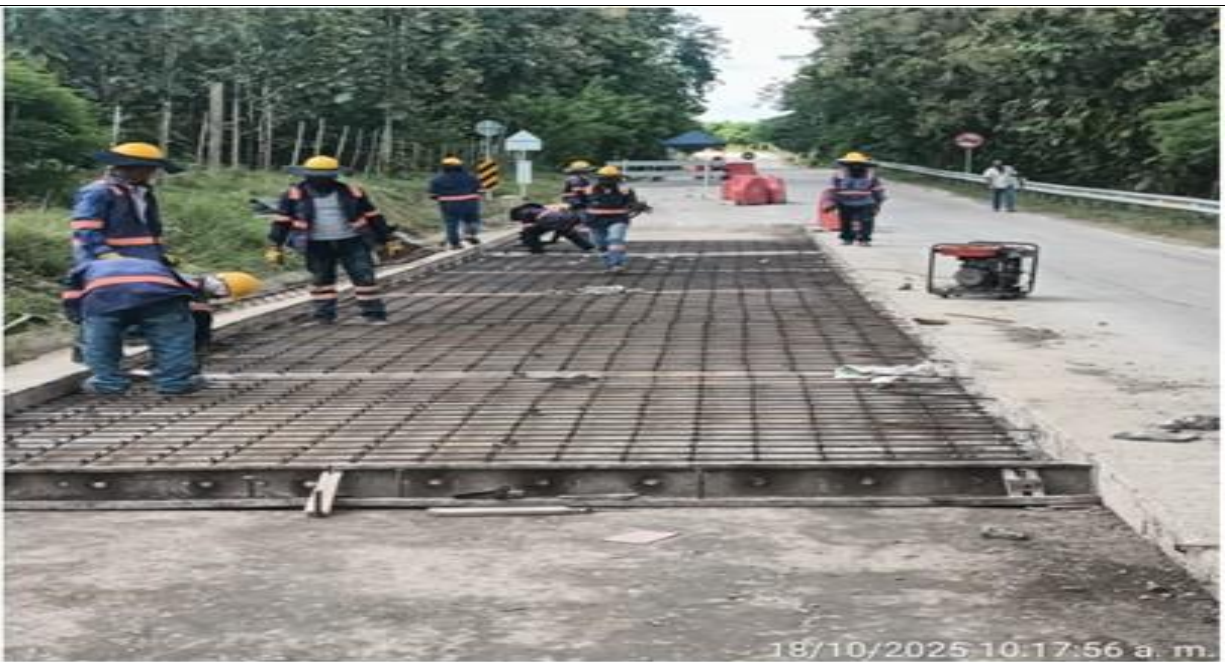
PR 13+430 lado derecho. Instalación de acero para losas reforzadas.
