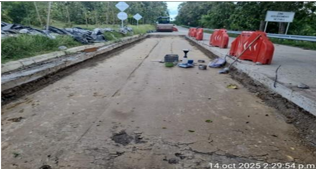
PR 13+600 margen derecha. Toma de muestras para ensayos de laboratorio.
