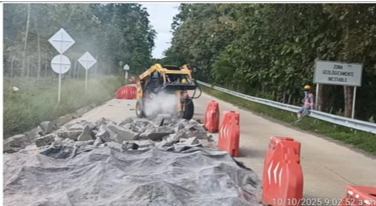
PR 13+620 carril derecho. Demolición de módulos en concreto MR40.
