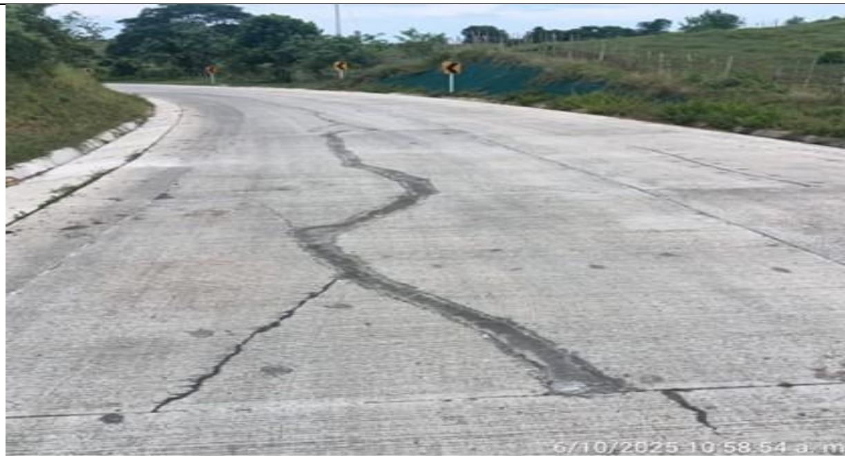
PR 30+045 carril izquierdo. Sello de grietas.
