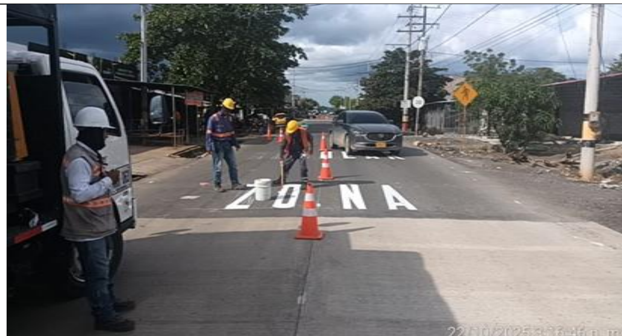
PR 1+800. Imprimación en resaltos.
