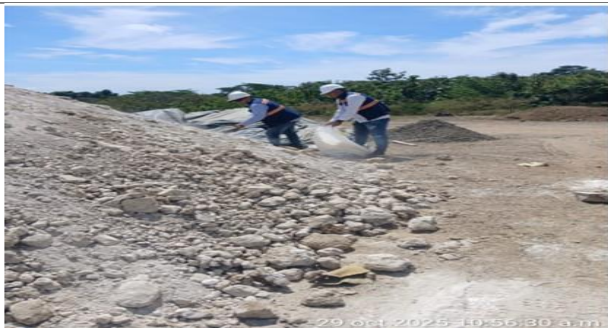
PR13+500 (acopio) lado derecho. Toma de subrasante estabilizada con cal para ensayos de laboratorio.
