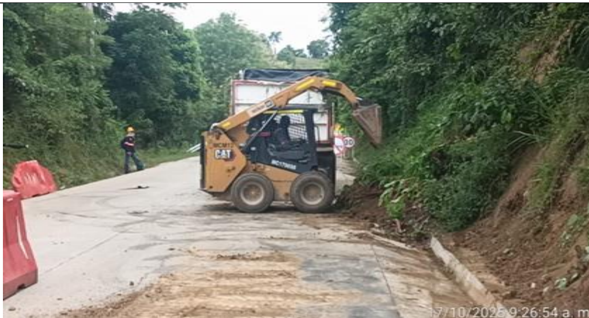
PR 13+430 lado derecho. Limpieza de material deslizado de talud.
