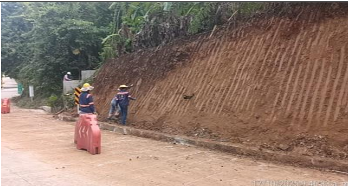
PR 13+950 margen derecha. Instalación de pernos para control de erosión.
