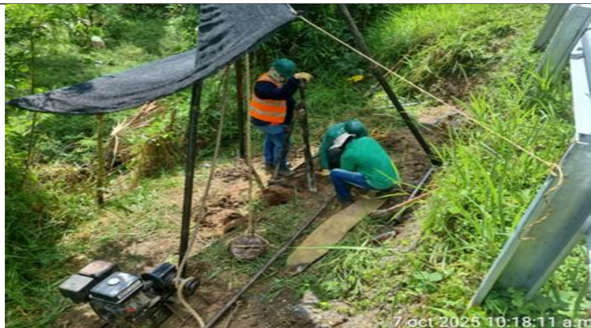
PR 24+600 lado derecho. Sondeo SPT para muro de contención.
