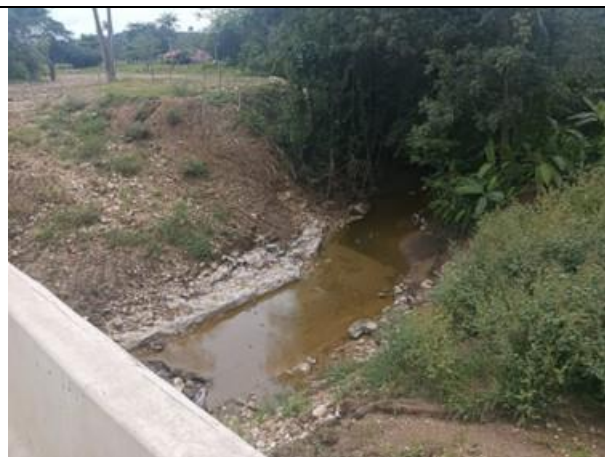
Foto 2. Seguimiento siembra accesos puente PR 45+300
