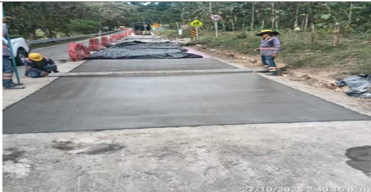
PR 13+510 lado derecho. Fundida de módulos en concreto MR 40.
