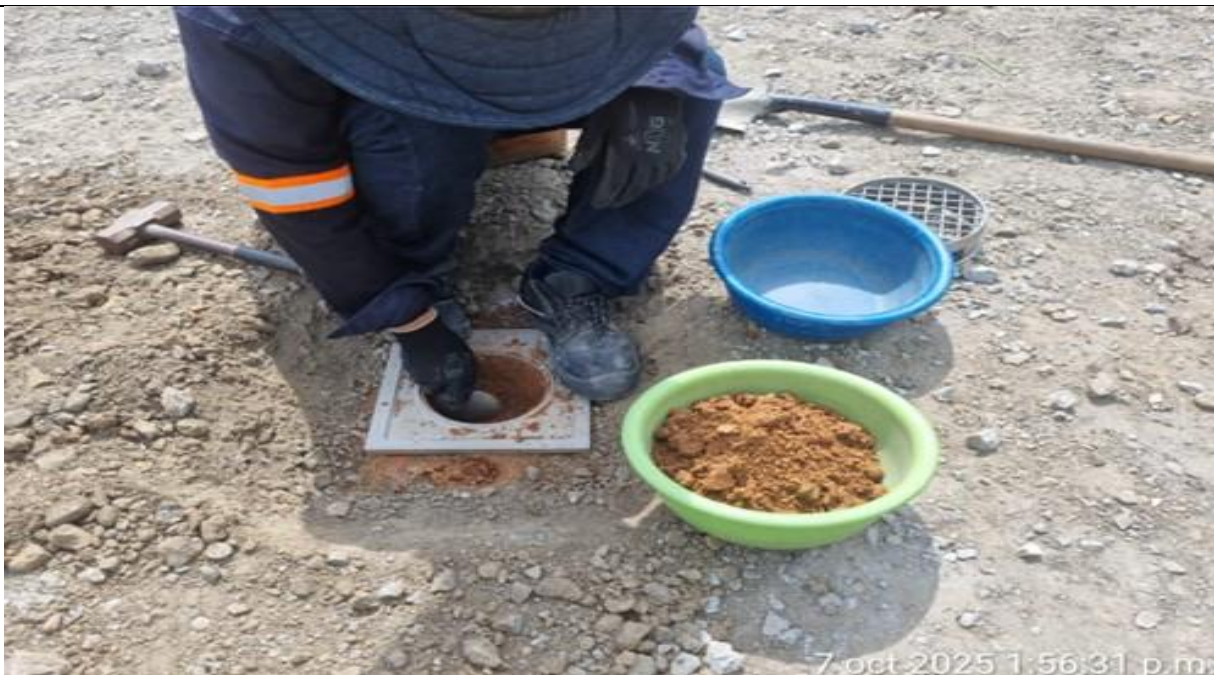
PR 10+850 carril derecho. Toma de humedades y densidades en módulos # 41 y # 42.
