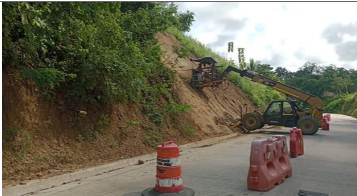
PR 15+400 margen izquierda. Perforación de talud.
