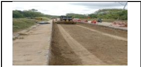
Instalación de subrasante estabilizada con cal en el PR 8+590 a menores
