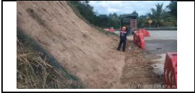
Inyección a pernos y limpieza en talud del PR 10+600 lado derecho
