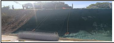
Instalación de malla triple torsión en talud del PR4+630
