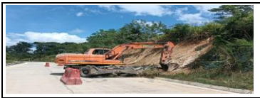
Perfilado talud PR10+600 L. Der
