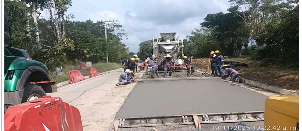
PR 8+595 a mayores (C.Der). Fundida de módulos en concreto MR-40 (tramo de prueba- severidad crítica)
