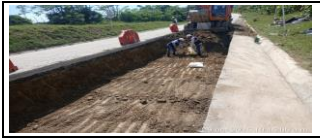
Cajeo losas demolidas del PR8+506 al PR8+542 C.lzq
