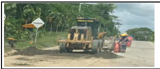
Instalación de subbase granular PR8+506 a mayores C.lzq
