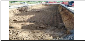
Excavacion y cajeo para reconstrucción de losas del PR 8+590 carril derecho
