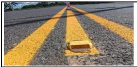
Demarcación vial e instalación de tachas del PR0+000 al PR2+000
