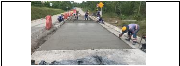
reconstrucción de módulos en concreto MR40 del PR 8+529 a menores, carril izquierdo.
