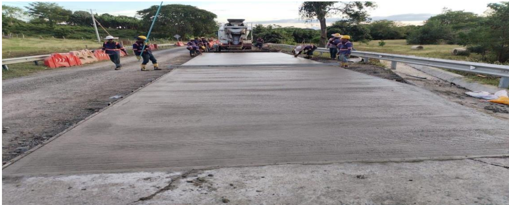
PR 25+700/750 C.lzq. Fundida de módulos en concreto MR-40 para cierre de broche.
