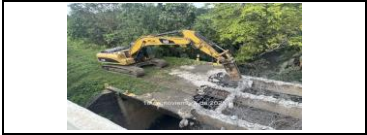
Demolición de losa superior antiguo puente regino PR34+500
