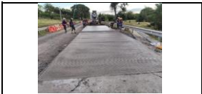
Construcción de módulos del PR25+700 al PR25+750 carril izquierdo
