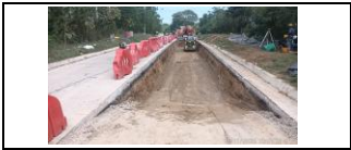
Instalación de subrasante estabilizada con cal PR 8+590 a 8+640 carril derecho
