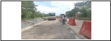
Instalación de Subbase PR 8+590 A 8+640 carril deerecho
