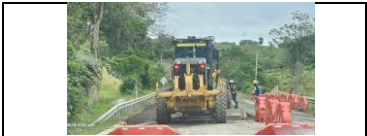
Cereo de subbase granular del PR 25+700 al PR25+750 calzada completa.
