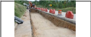
Excavación del PR8+506 al PR8+590 carril derecho.
