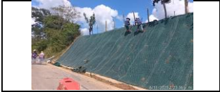
instalación de malla triple torsión en talud del PR5+730 del lado izquierdo y derecho.
