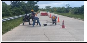
Costura de losas en el PR29+800 C. Der
