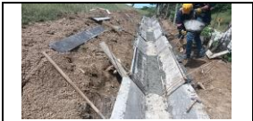
construcción de zanjas de coronación del PR26+340 a mayores, lado izquierdo.
