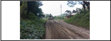
mantenimiento de calzada del PR 43+400 a mayores.
