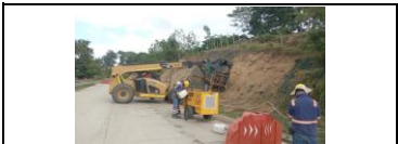
Perforaciones e instalación de pernos en el talud en PR 10+682
