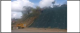
Instalación de malla triple torsión PR 10+620 lado derecho
