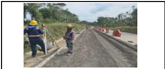
Instalación de subbase en PR8+506 al PR8+589 carril derecho
