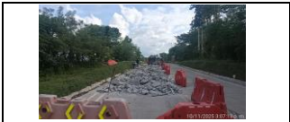
demolición de módulos en concreto MR40 en el carril derecho del PR8+640 a menores
