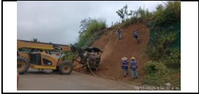
limpieza en talud de la margen derecha en el PR10+600
