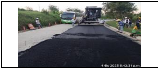
Instalación de mezcla asfáltica MDC10 PR8+800 carril derecho
