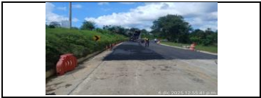
Instalación mezcla asfáltica MDC10 carril izquierdo PR8+795 carril izquierdo
