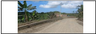
Defensa metálica instalada PR41+800 carril izquierdo
