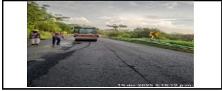
instalación de mezcla asfáltica MSC19 granocaucho PR8+795 carril izquierdo
