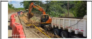
Excavación y retiro de material para construcción de muro PR40+200
