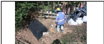
construcción de gavion en la carril izquierda del PR28+200
