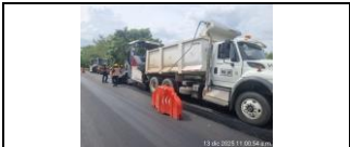
Instalación de MDC10 capa de nivelación PR9+304 carril izquierdo
