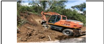
perfilamiento de talud del PR 12+560 lado izquierdo.
