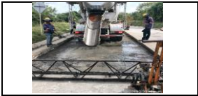
Construcción pavimento MR40 tramo de prueba PR 8+589 a menores
