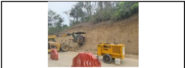
Perforaciones e intalación de pernos PR 12+800
