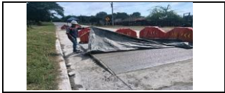
construcción de resalto pompeyano PR 27+870, carril derecho
