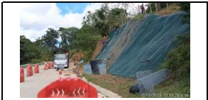
Instalación de malla triple torsión en el PR 10+650 lado derecho.
