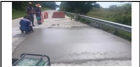
Construcción de resalto Pompeyano del PR 27+590 carril izquierdo.
