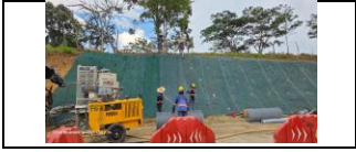
Instalación de malla triple torsión PR10+790
