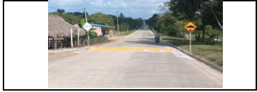
Aplicación de pintura en resalto pompeyano PR27+870
