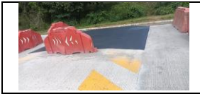
aplicación de imprimante para pintura en resalto pompeyano PR27+577 carril derecho.
