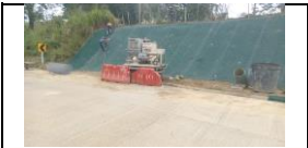
Instalación de malla triple torsión en PR 10+790
