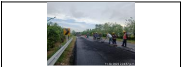
Instalación de MDC10 del PR9+225 al PR9+268 carril izquierdo
