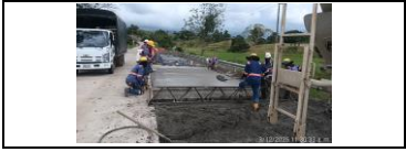
Construcción de pavimento MR40 del PR 25+700 a mayores, carril derecho
