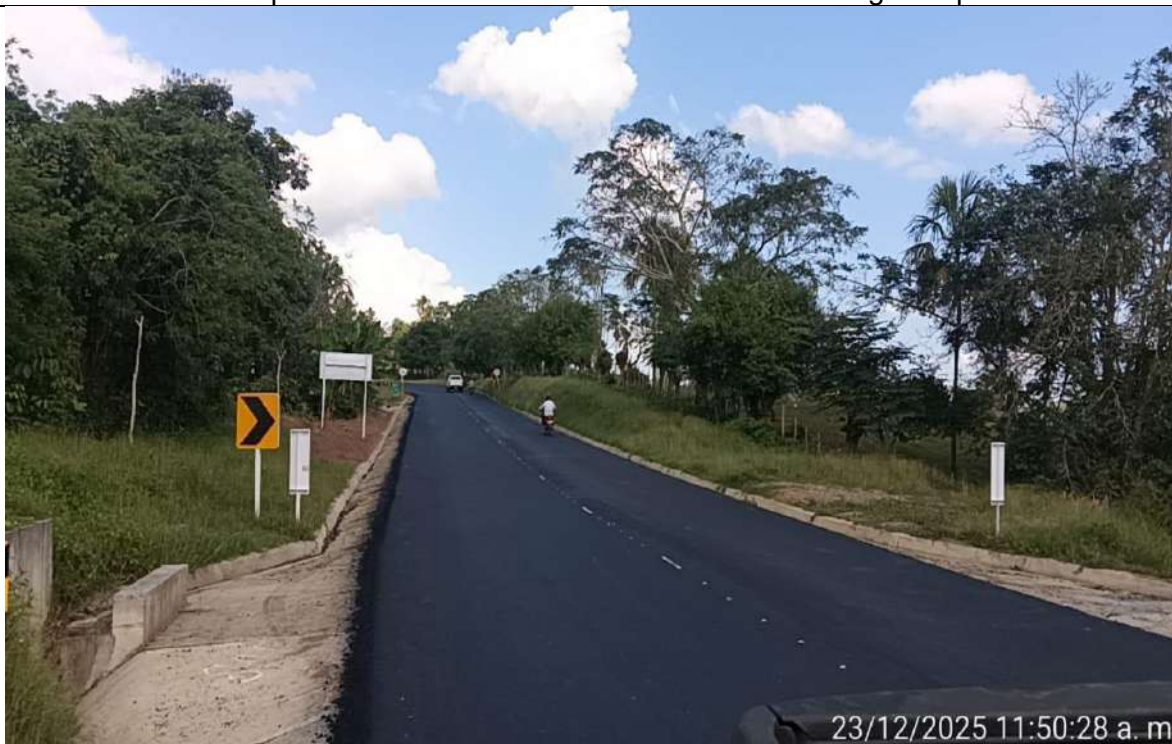
Mezcla asfáltica MSC19 GCR del PR9+058 al PR9+221
