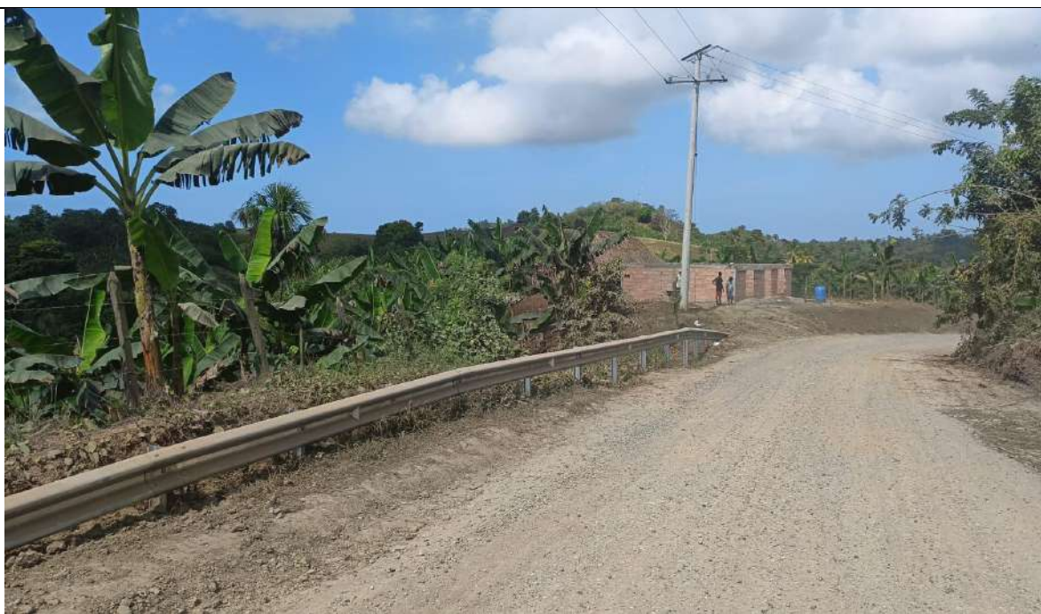
Instalación de Defensa metálica PR 41+800
