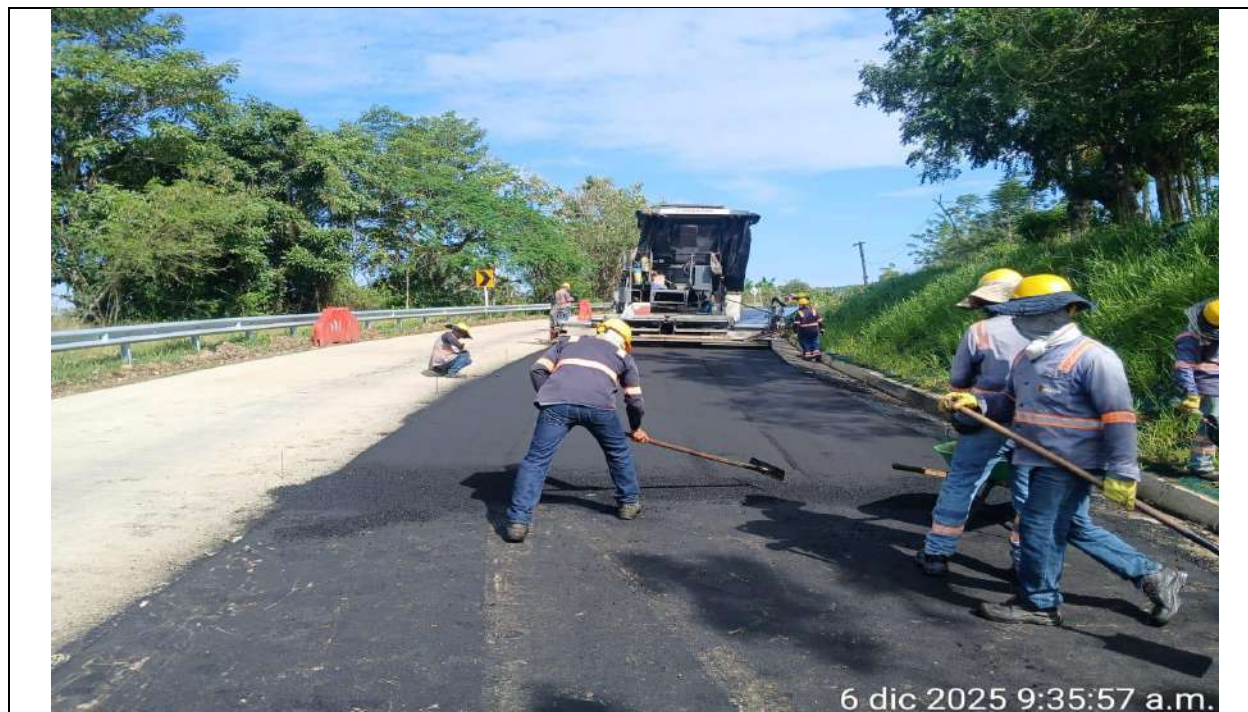
Instalación capa de nivelación MDC10 PR 9+169 carril derecho
