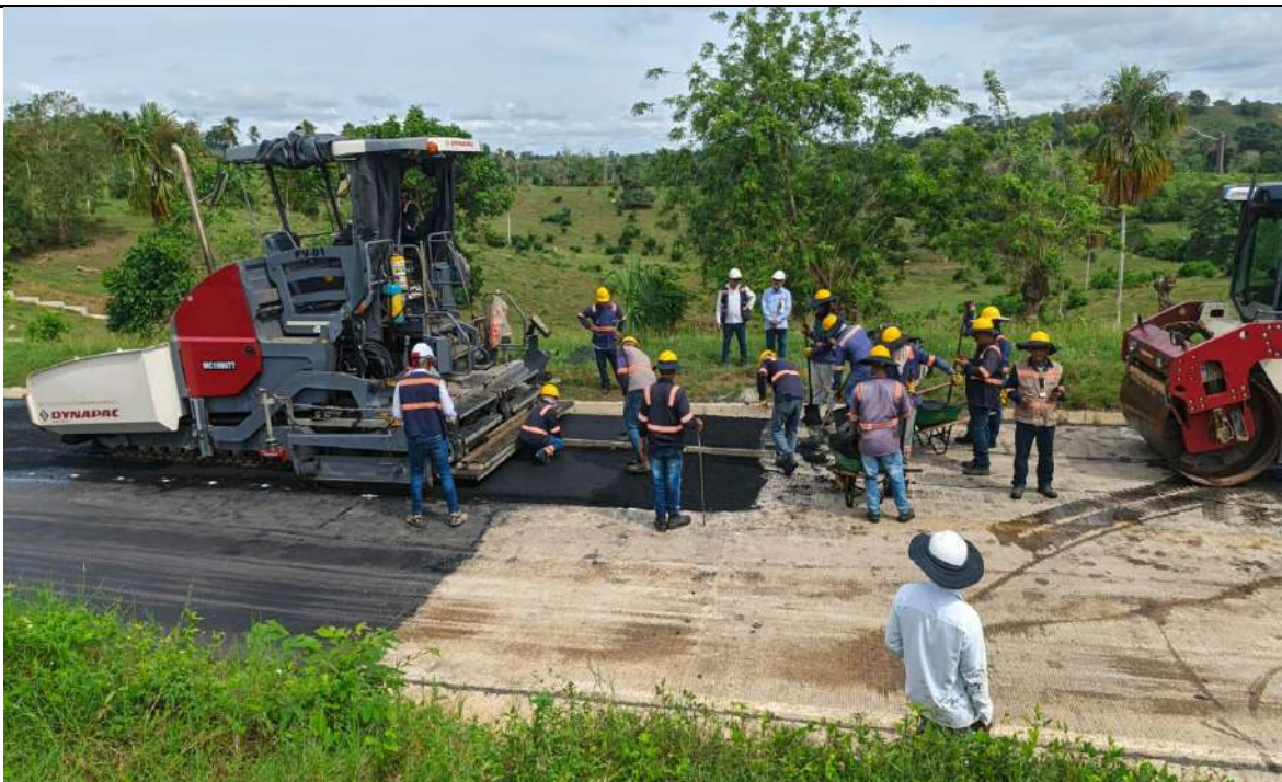
Extendida MDC 19 modificada con GCR PR 8+700 carril derecho
