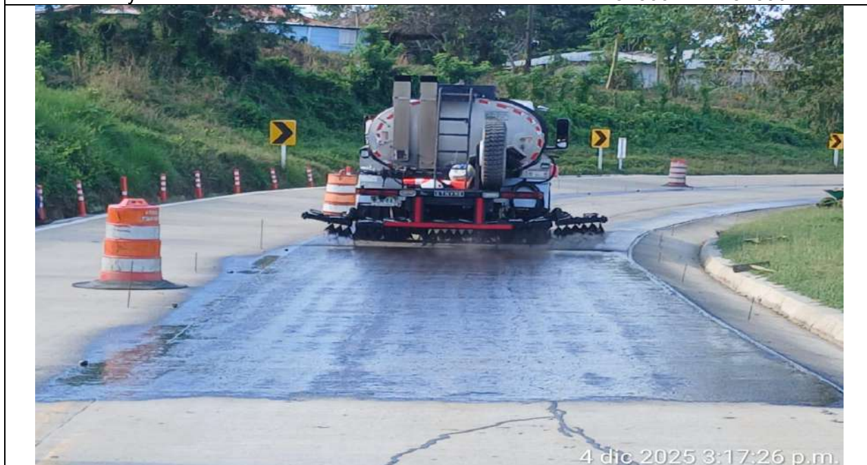
Imprimación PR 8+800 hacia mayores carril derecho
