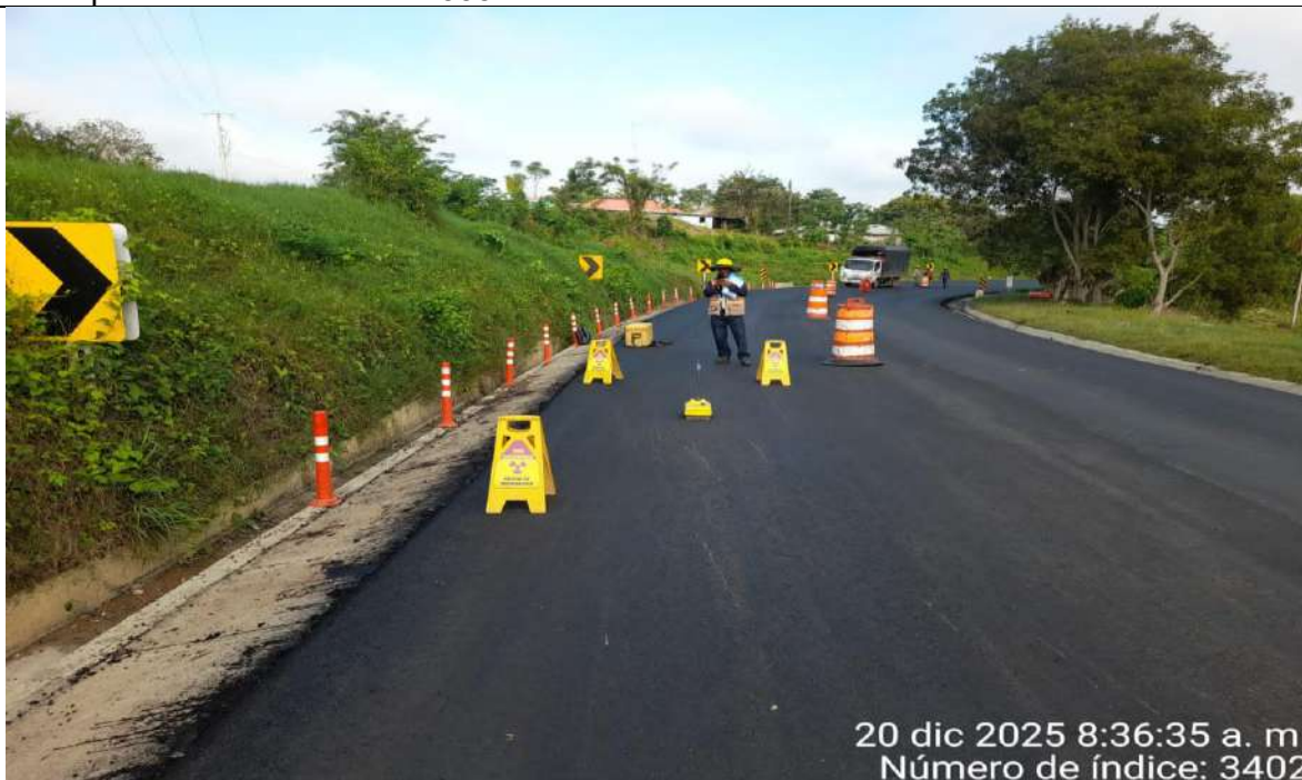
Toma de densidades a la segunda capa de la mezcla asfáltica MSC19 con densímetro nuclear del PR 8+795 al PR 9+150 carril izquierdo
