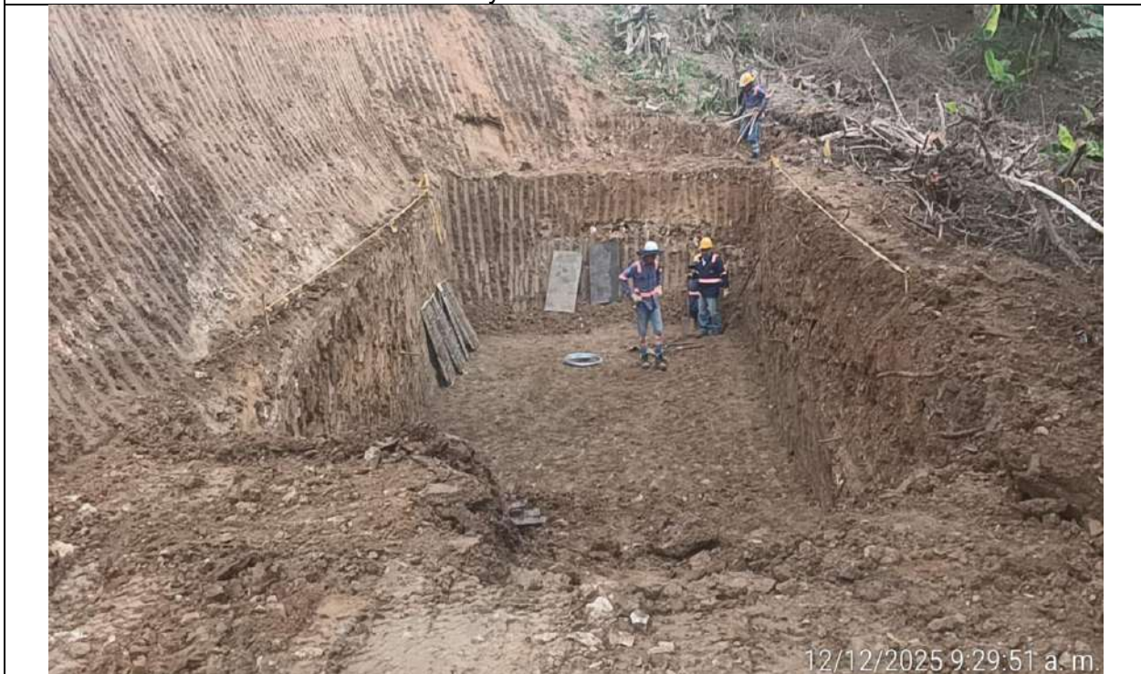
Preparación terrena para fundida de concreto ciclópeo del tercer módulo del muro del PR 40+200 lado derecho.
