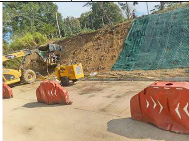
Foto 4. Instalación de malla triple torsión PR 10+700 CD
