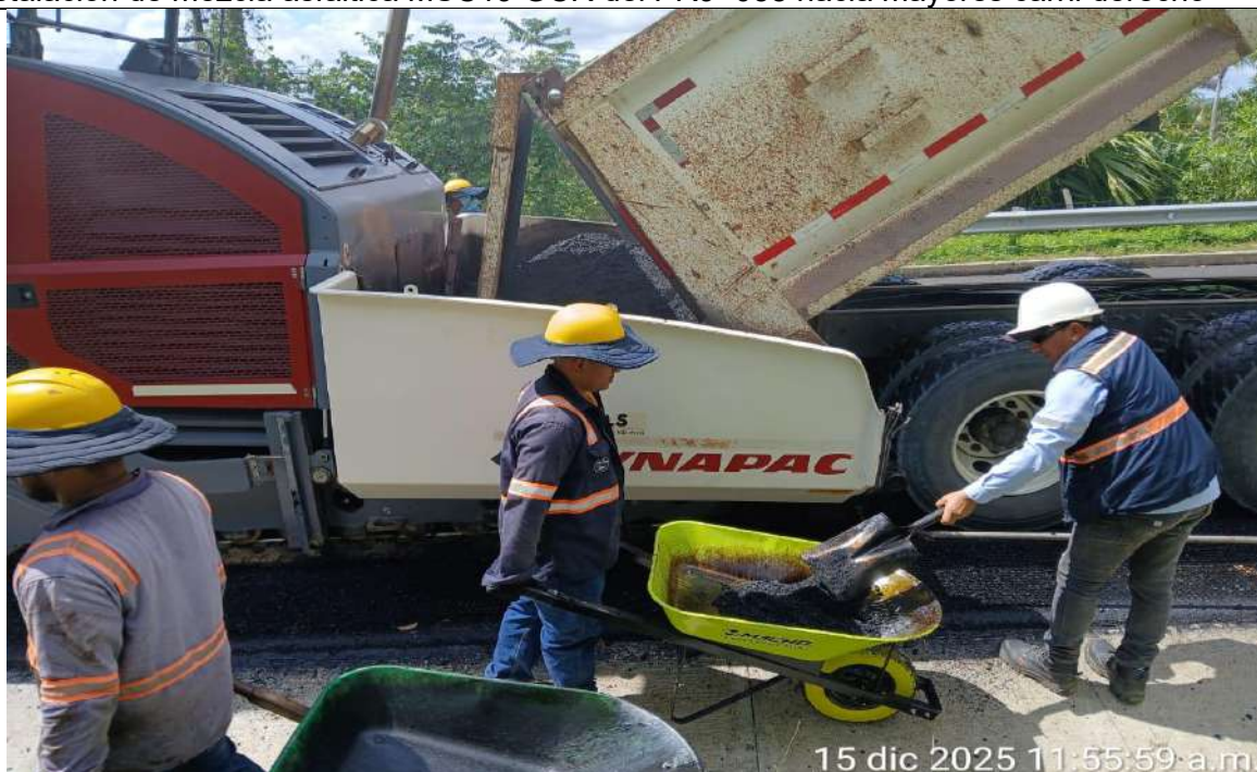
Toma de muestras asfáltica MSC19 GCR para ensayos de laboratorio del PR 9+085 hacia mayores carril derecho
