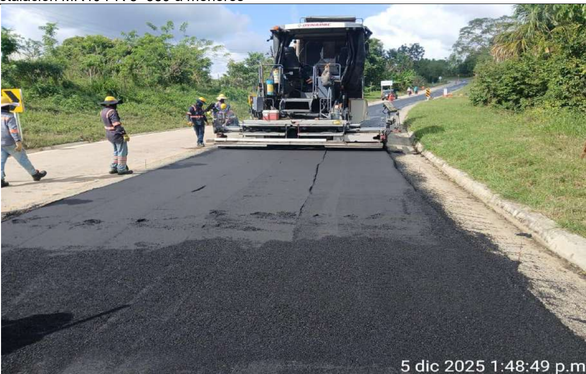
Instalación de carpeta de nivelación asfáltica MDC10 PR 8+868 hacia mayores carril derecho
