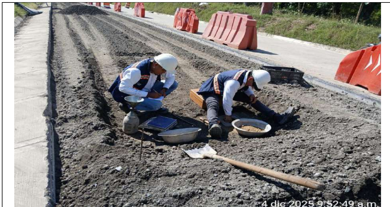
Densidades y humedades a la subrasante estabilizada con cal PR 8+506 al PR 8+590 der
