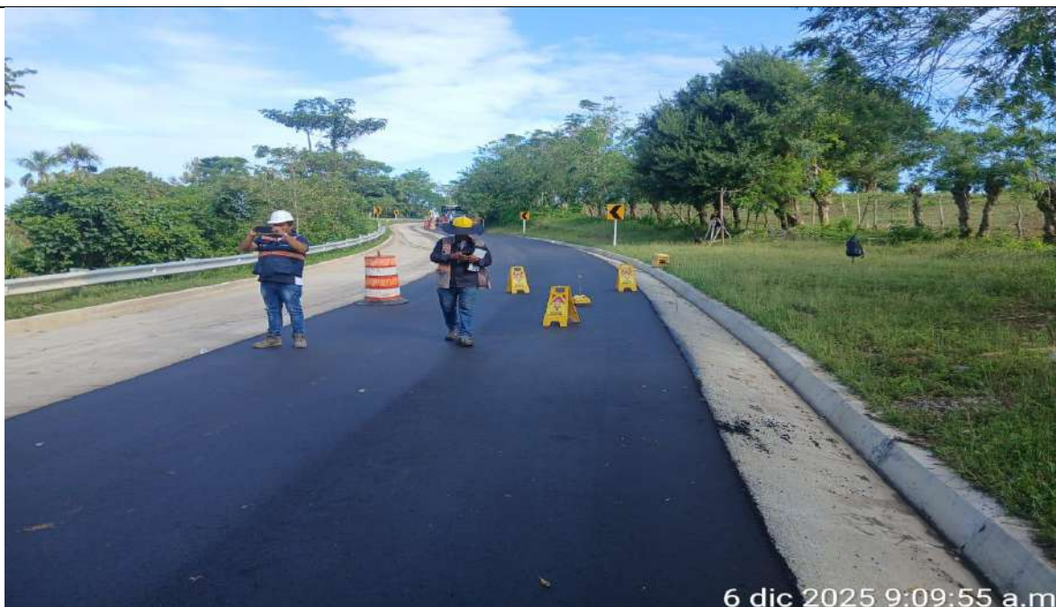
Toma de densidades a la capa de nivelación MDC10 con densímetro nuclear
