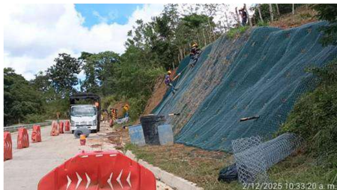
Foto 3. Instalación de malla triple torsión PR 10+700 CD
