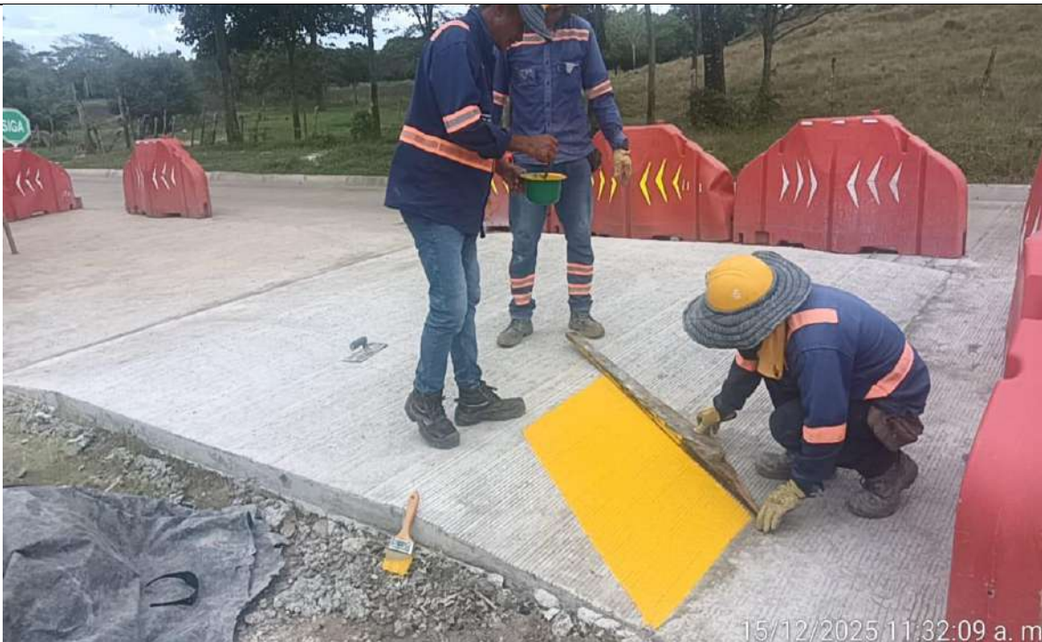
Pintura resalto tipo Pompeyano del PR 27+870 carril izquierdo.
