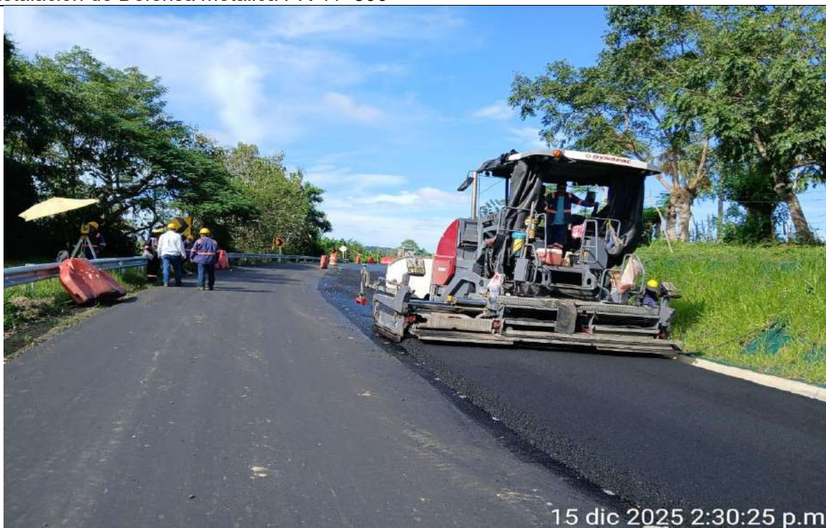
Instalación de mezcla asfáltica MSC19 GCR del PR 9+058 al PR 9+221 carril derecho
