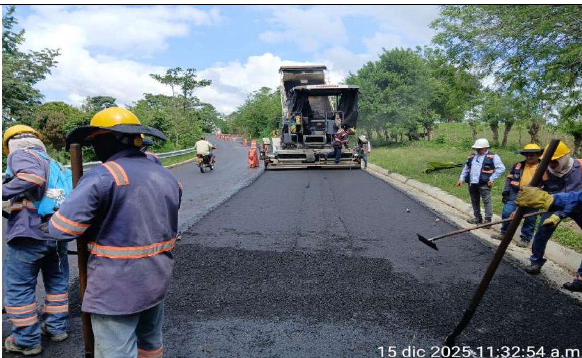
Instalación de mezcla asfáltica MSC19 GCR del PR9+058 hacia mayores carril derecho
