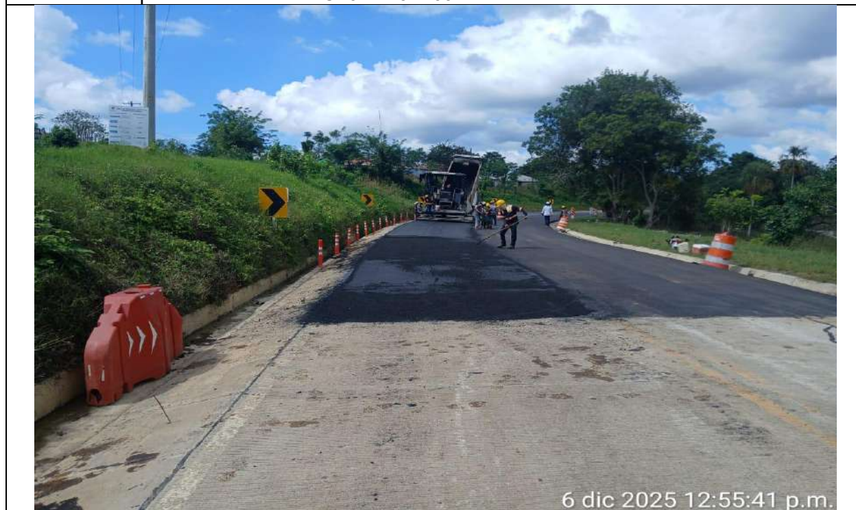
Instalación mezcla asfáltica MDC10 carril izquierdo PR 8+795 carril izquierdo
