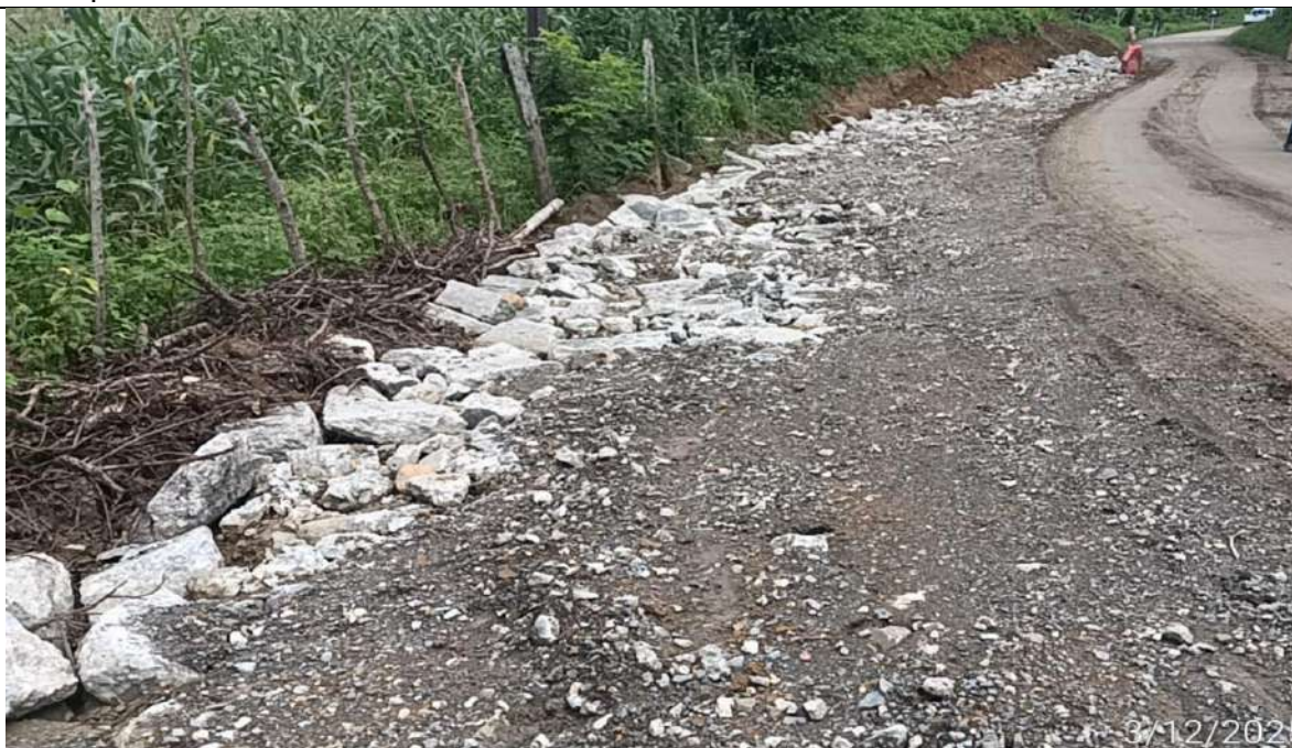
Ampliación en carril izquierdo del PR 40+200 con residuos de demolición de losas de concreto.
