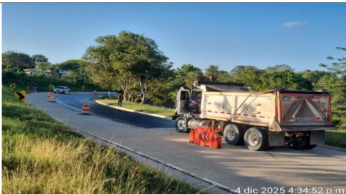
Instalación de mezcla asfáltica MDC10 PR 8+800 carril derecho
