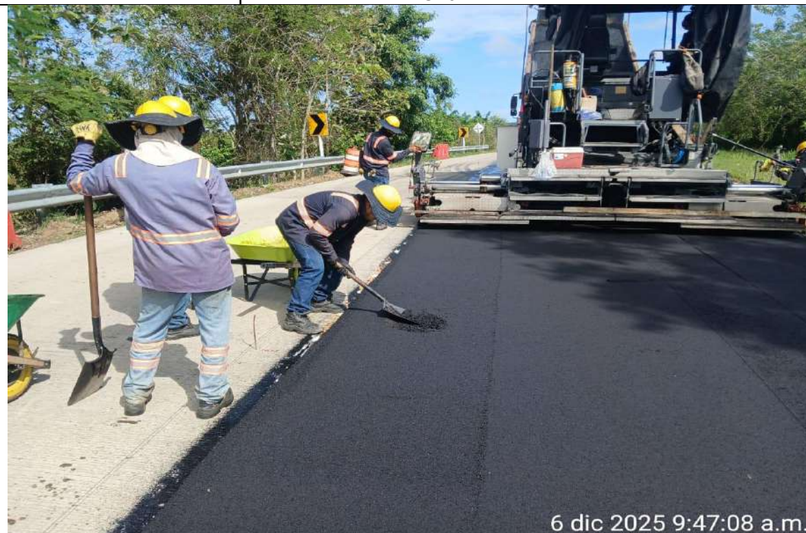
Toma de muestras de mezcla asfáltica MDC10 para ensayos de laboratorio PR 9+169 hacia mayores carril derecho
