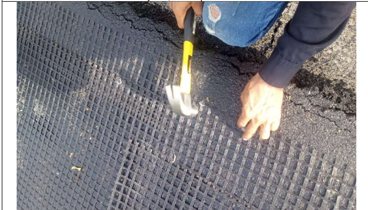
Instalación Geomalla Pavimentos Asfálticos anclada con grapas aceradas.
