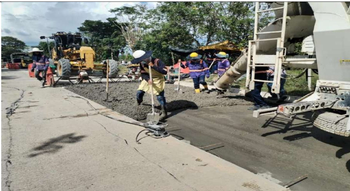
Instalación MR40 PR 8+589 a menores
