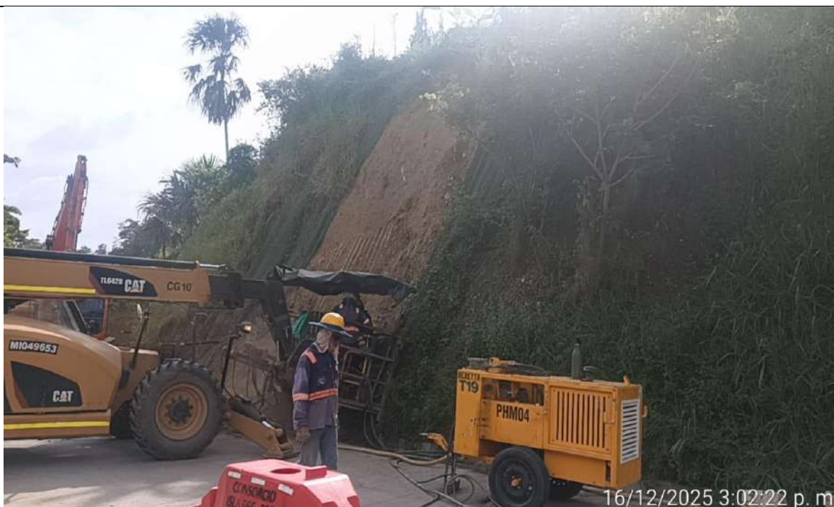
Perforaciones en el PR 12+680 al PR 12+710 margen izquierda.
