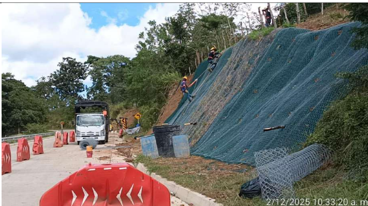
Malla triple torsión en el PR 10+650 lado derecho.
