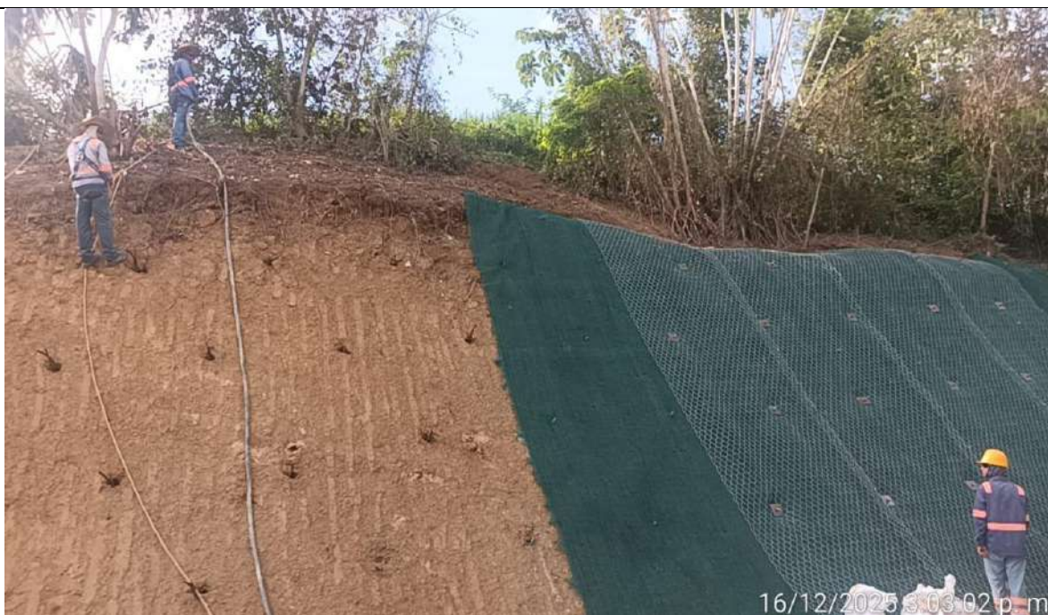
Instalación de malla triple torsión en el talud del PR 12+530/550 margen izquierda.
