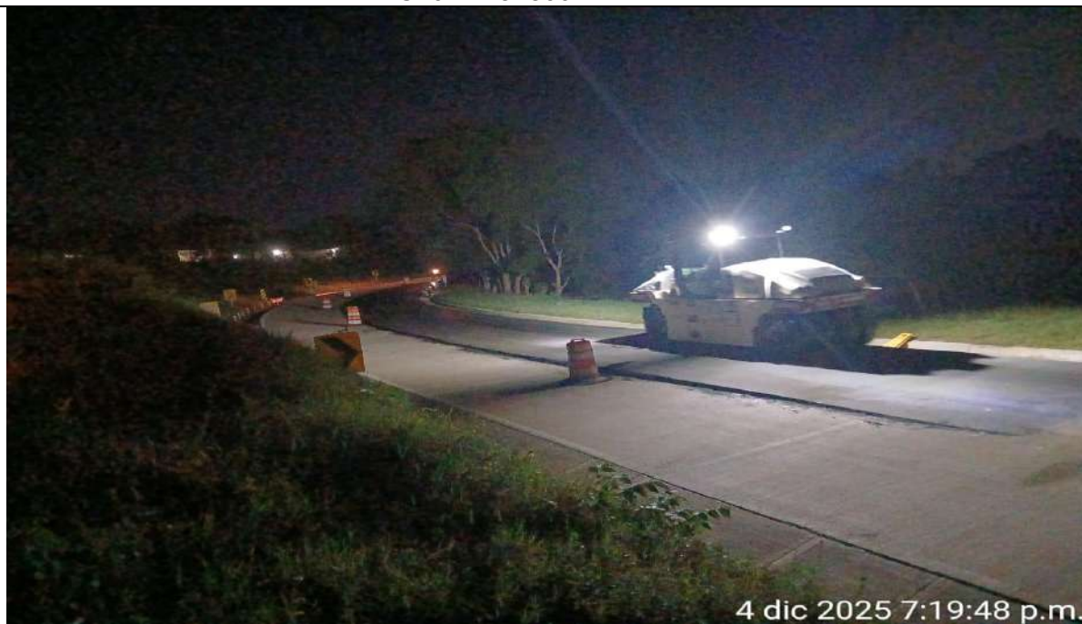
Instalación de mezcla asfáltica MDC 10 del PR 8+800 al PR 8+868-carril derecho
