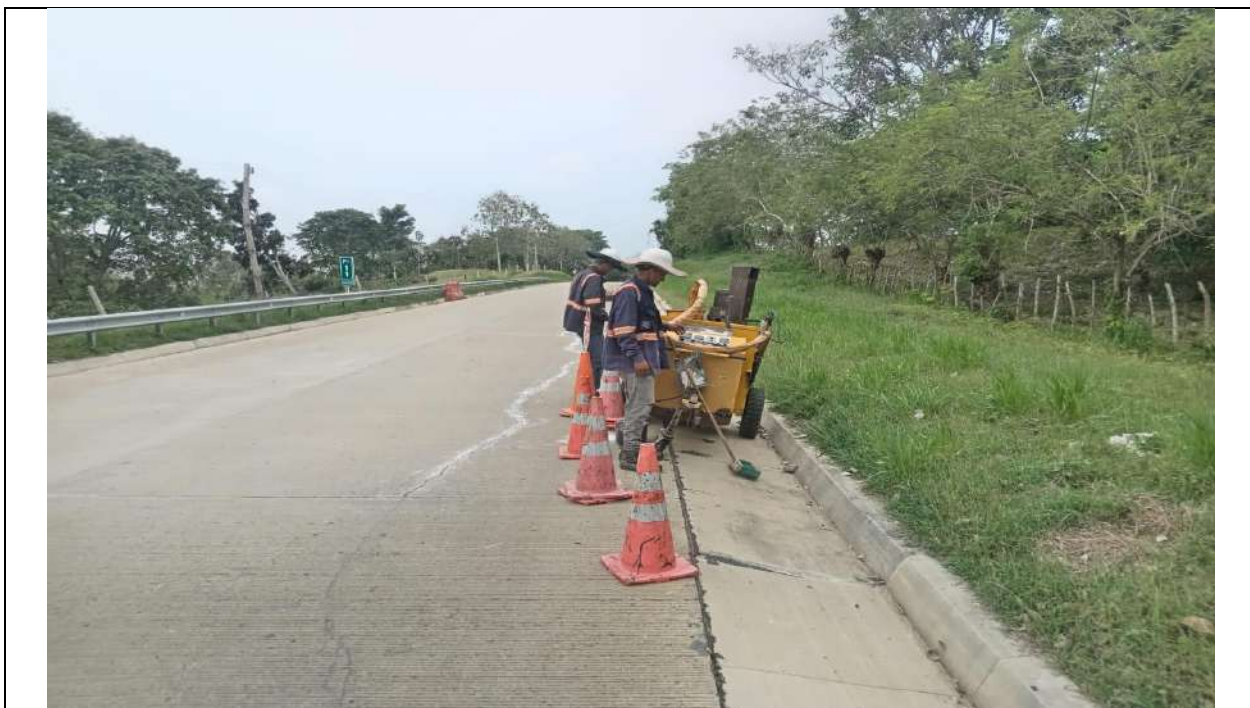
Instalación de Bituflex PR 11+000 a mayores
