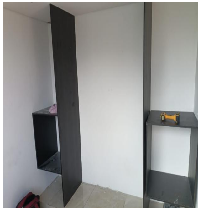
INSTALACIÓN DE CLOSET EN APTOS
