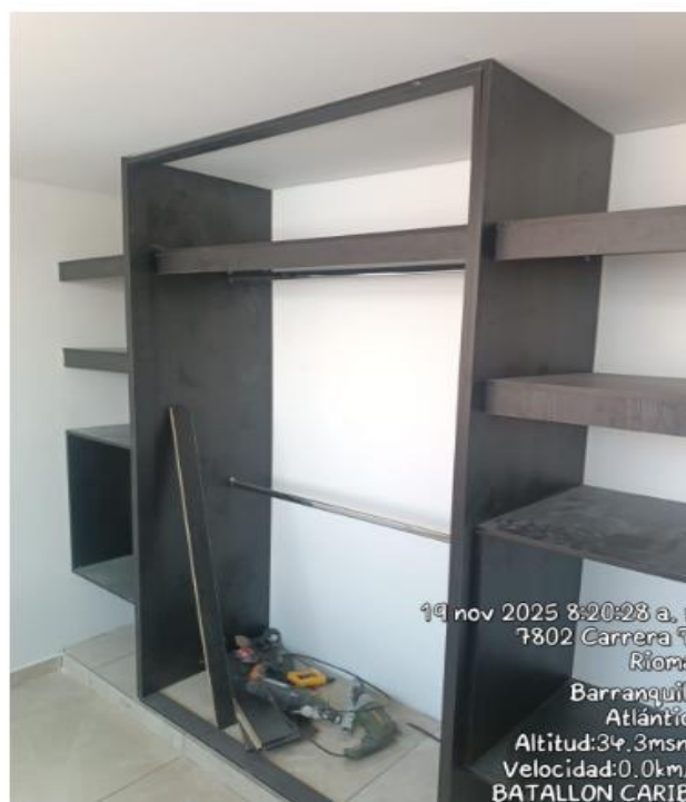
INSTALACIÓN DE CLOSET EN APTOS
