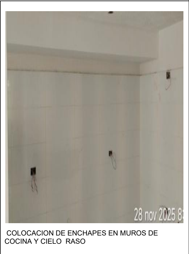
COLOCACION DE ENCHAPES EN MUROS DE COCINA Y CIELO RASO
