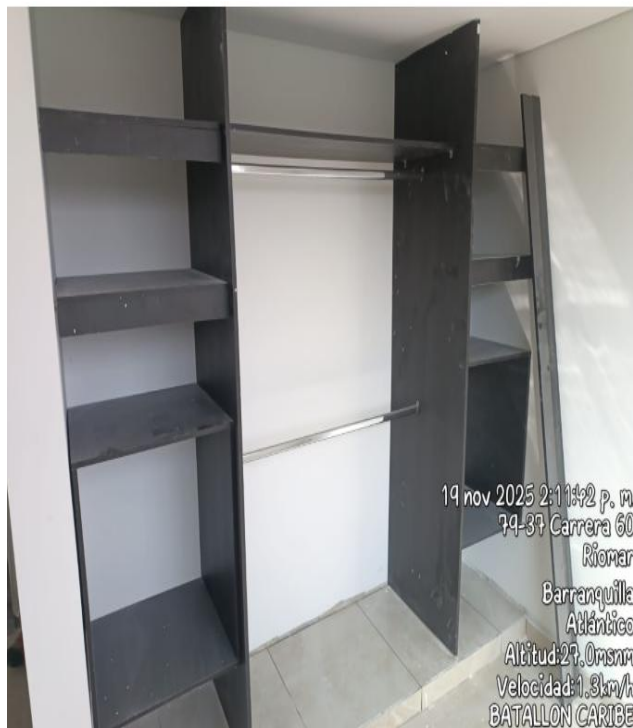
INSTALACIÓN DE CLOSET EN APTOS
