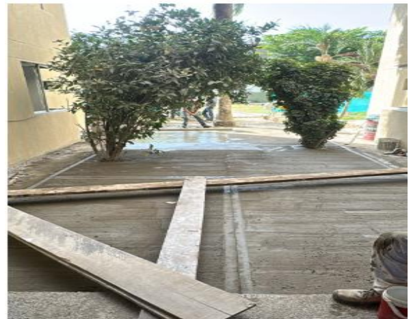
LOSA EN CONCRETO AREA DE ENTRADA PRINCIPAL
