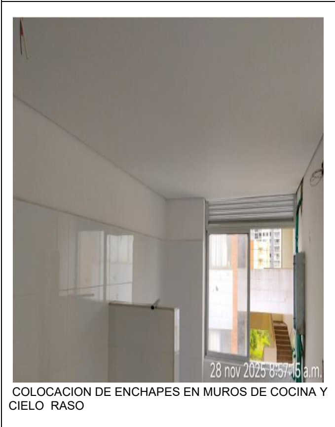
COLOCACION DE ENCHAPES EN MUROS DE COCINA Y CIELO RASO
