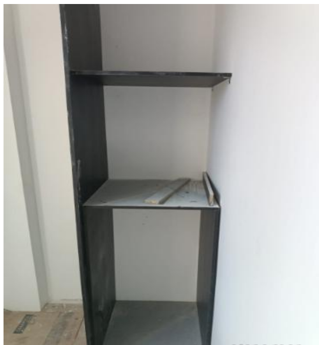
INSTALACIÓN DE CLOSET EN APTOS
