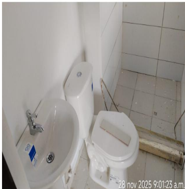
COLOCACION DE APARATOS SANITARIOS EN APTOS
