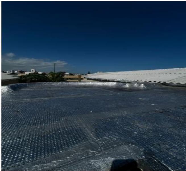
IMPERMEABILIZACION DE LOSA DE CUBIERTA
