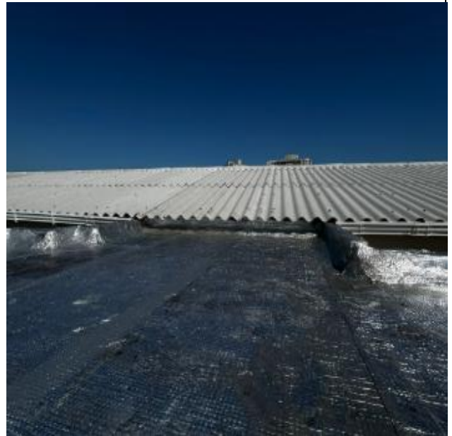
IMPERMEABILIZACION DE LOSA DE CUBIERTA
