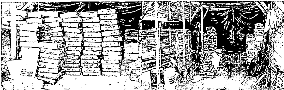
Foto 5 Almacenamiento de materiales
