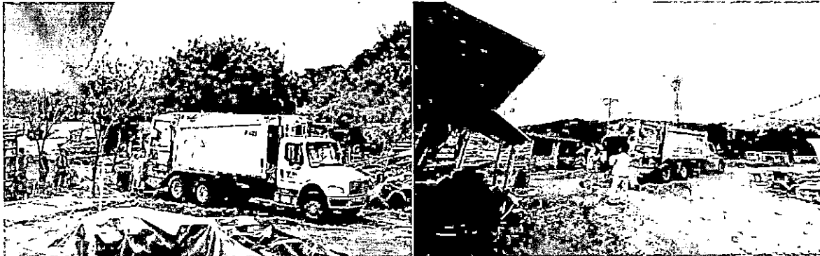
Foto 1 Retiro de material solido de la obra.
