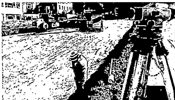
Foto 16. Sub rasante en vía.
