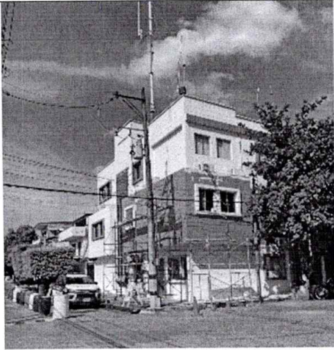
SEGUIMIENTO CONTRATO 369 DE 2025 "ADECUACIÓN ESTACIÓN DE POLICIA"
