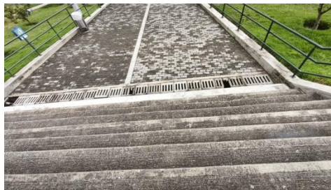
Fotos # 1,2, 3, mantenimiento de rejillas escaleras
