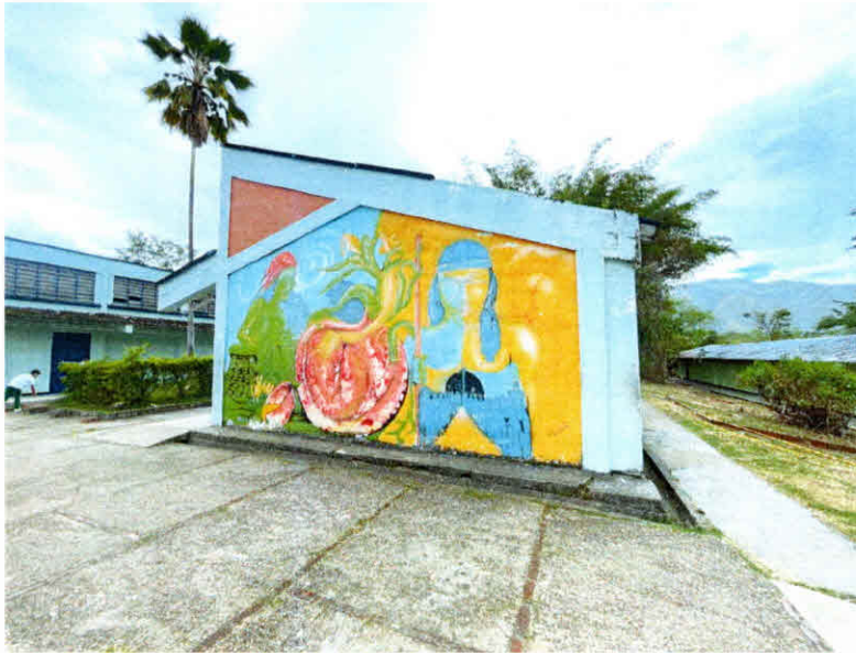
Estado inicial fachada lateral salones 702 - 803
