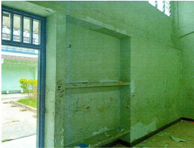
Estado inicial pintura de muros internos de salón de clase
