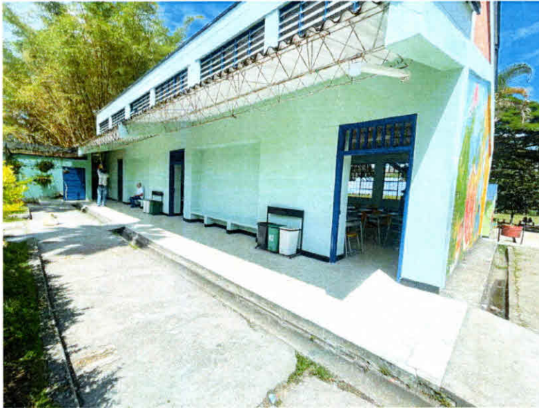
Terminación de pintura de esmalte y vinilo para la fachada de salones 702 - 803
