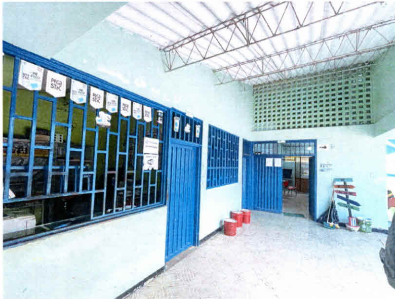
Estado inicial entrada a la Biblioteca
