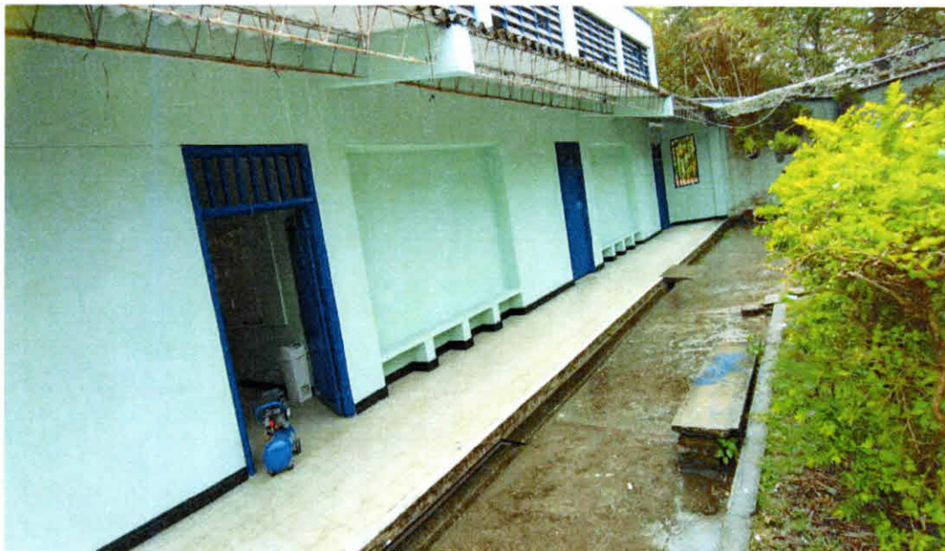
Se observa la terminación de la fachada con pintura de esmalte y vinilo.
