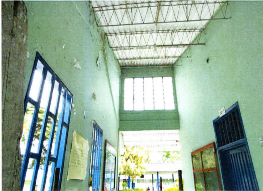
Estado inicial pasillo biblioteca
