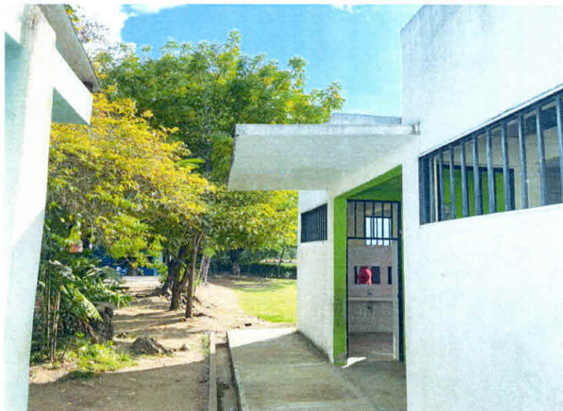
Placa aérea existente, entrada a la batería sanitaria, de la sede Agustín codazzi.
