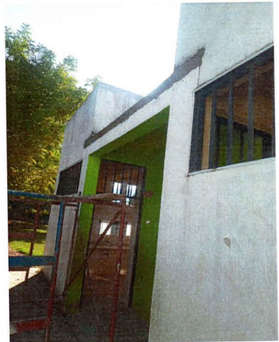
Se observa la construcción de resane
