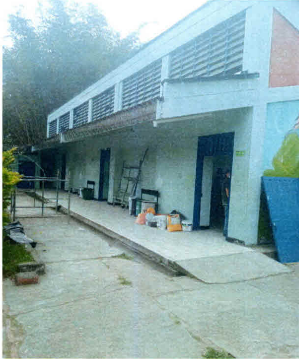
Estado inicial fachada salones 702 -803
