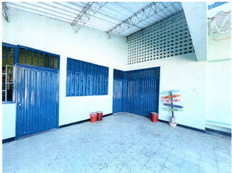
Se observa la terminación de pintura para puertas y ventanas, del pasillo de la biblioteca
