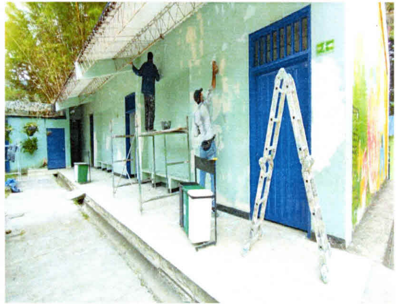
Reparo fachada salones 702 - 803
