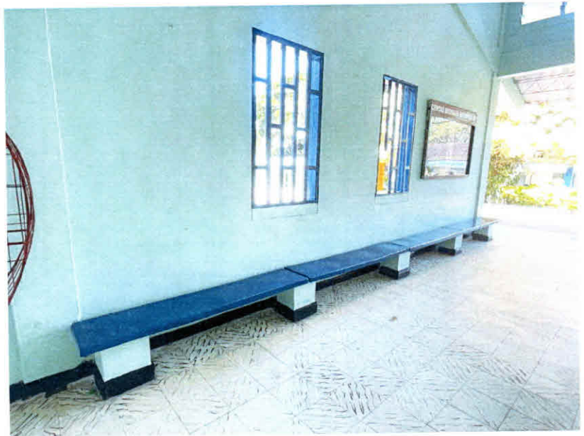
Estado final de pintura en vinilo y esmalte pasillo bibliotca
