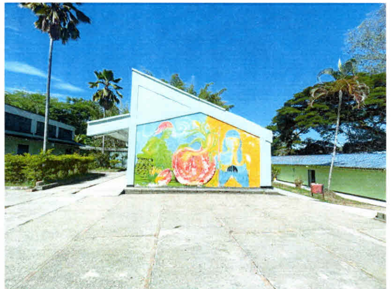
Estado final fachada lateral salones 702 - 803
