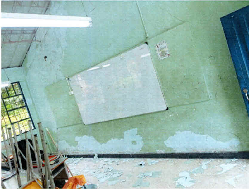
Se observa el estado inicial de la parte frontal del salón de clase
