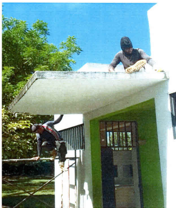
Placa aérea existente, entrada a la batería Sanitaria sede Agustín codazzi.
