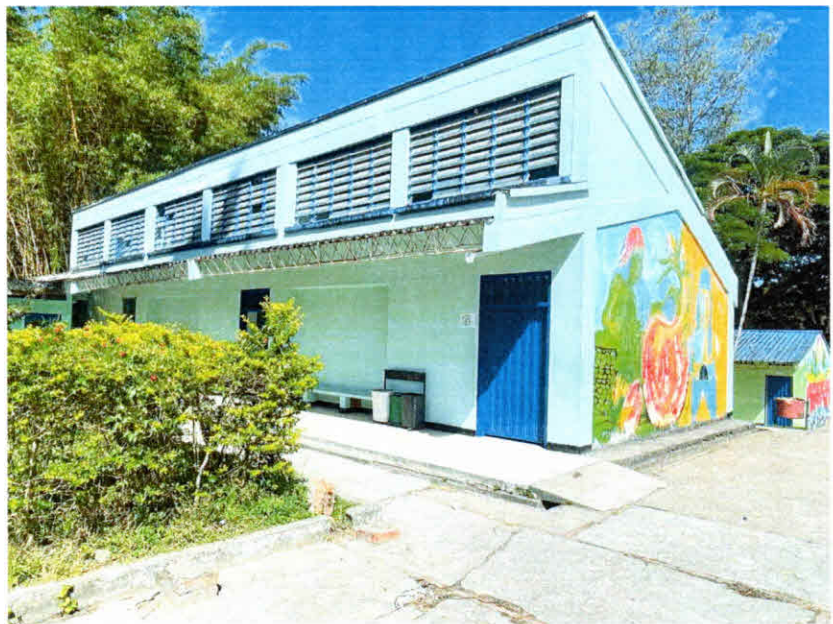
Terminación de pintura de esmalte y vinilo para la fachada frontal y lateral de salones 702 - 803
