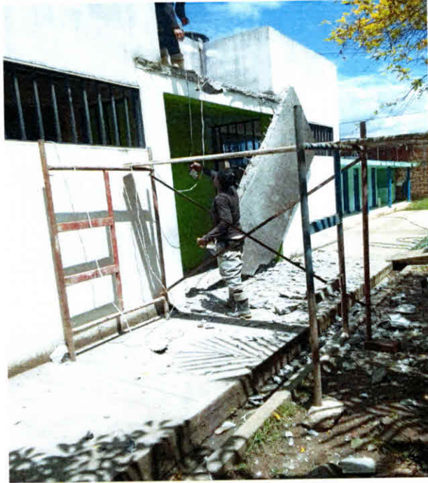
Demolición de placa aérea y retiro de escombros.
