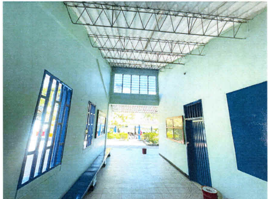
Estado final Pasillo biblioteca
