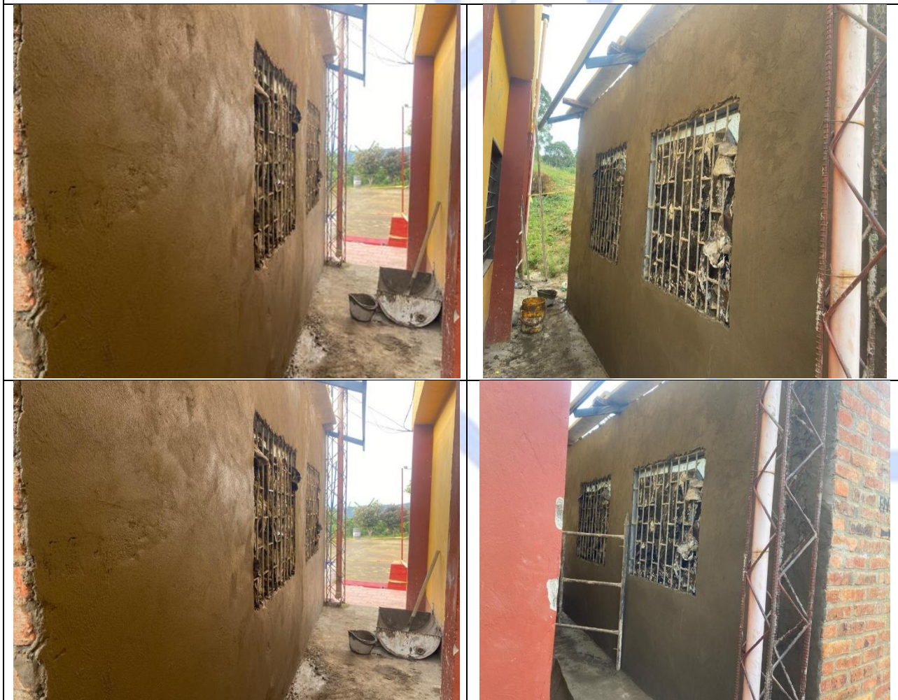
Item 2.01 Pañete en muros
