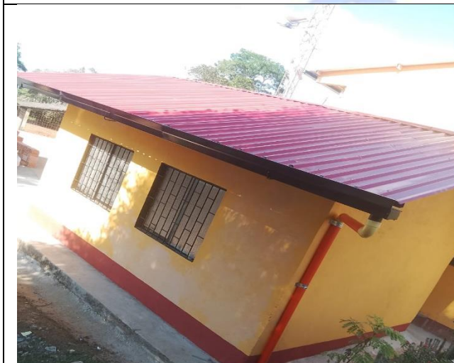
Item 1.05 Canal metálico cal 22 para recolección aguas lluvias
