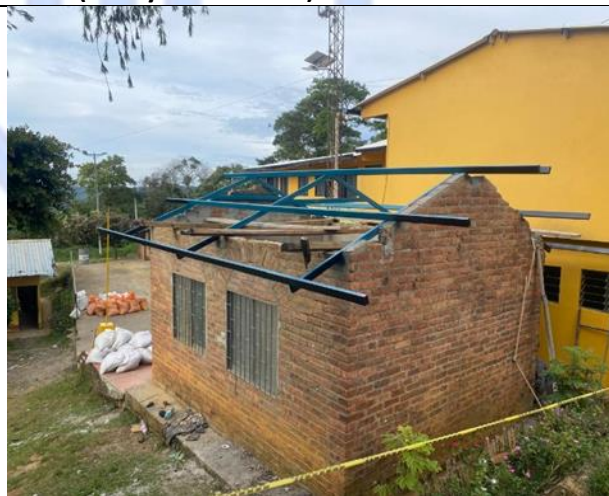
Item 1.03 Cubierta en teja mastermil (Incluye estructura)
