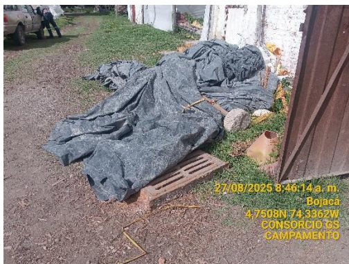
Entrada al campamento pendiente de retiro de materiales resultantes de la obra
