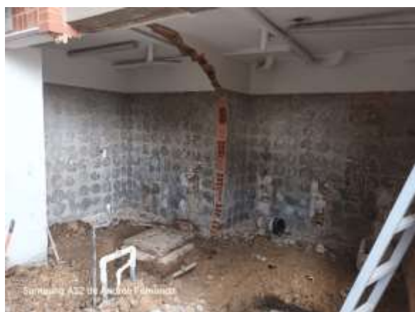
DEMOLICION DE MUROS
