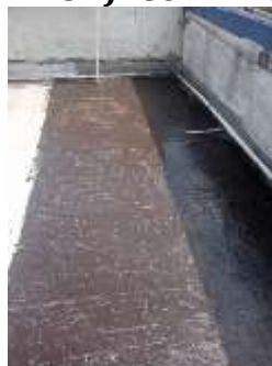
Aplicación de emulsion y manto asfaltico
