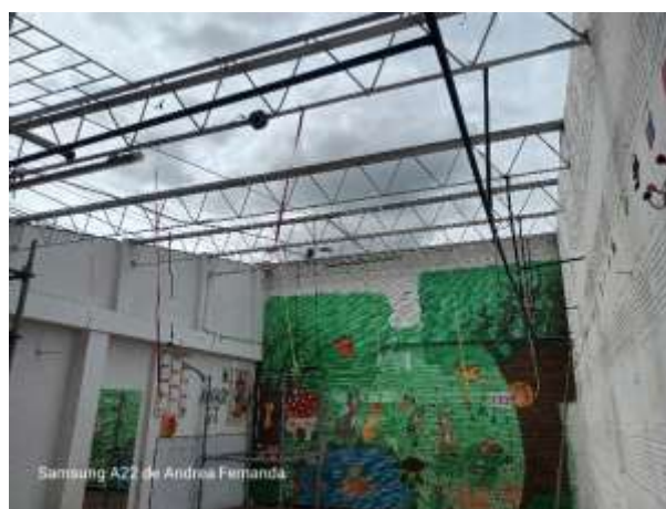
DESMONTE DE CUBIERTA
