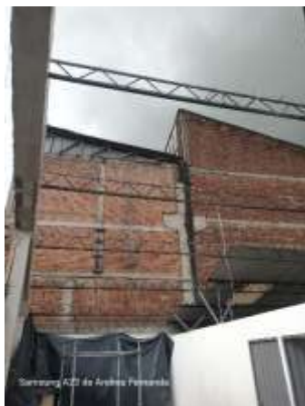
DESMONTE DE CUBIERTA
