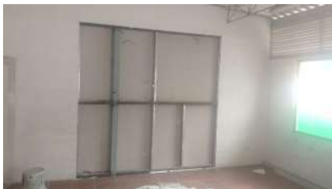
DESMONTE E INTALACIONDE LAMINAS DE SUPERBOARD
