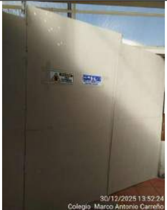
Fotografía 23. Instalaciones señalización de restricción
