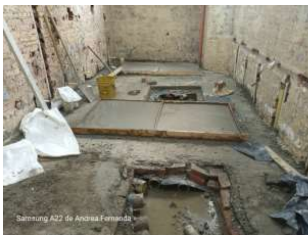
LOSA DE ENTREPISO
