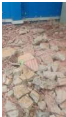
DEMOLICION DE ALISTADO
