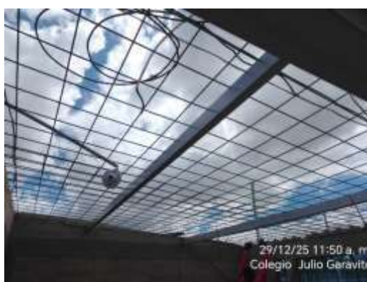
Desmonte de cubierta coordinación
