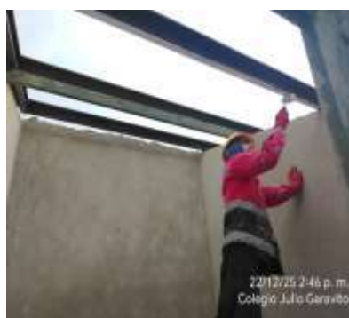
Instalacion y pintura Estructura
