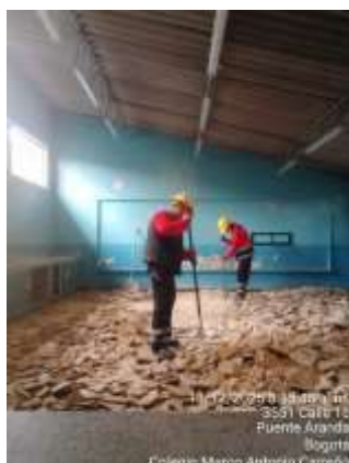
Demolición de cerámica y alistado
