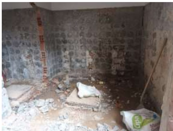
DEMOLICION DE LOSA
