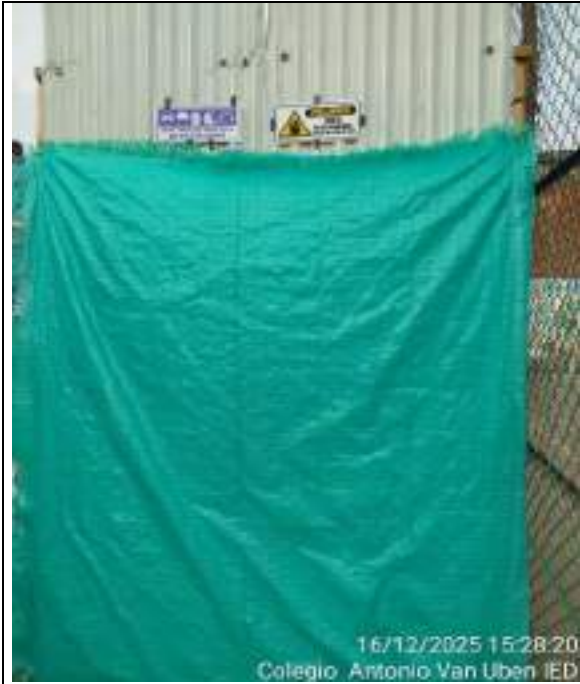
Fotografía 22. Instalaciones de cerramientos
