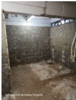
DEMOLICION DE ENCHAPE
