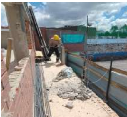
Demolición de columnas
