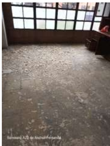
DEMOLICION DE PISO PVC
