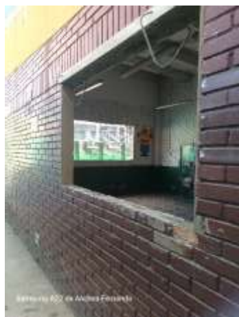
DESMONTE DE VENTANERIA
