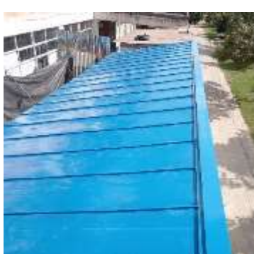
instalacion de cubierta
