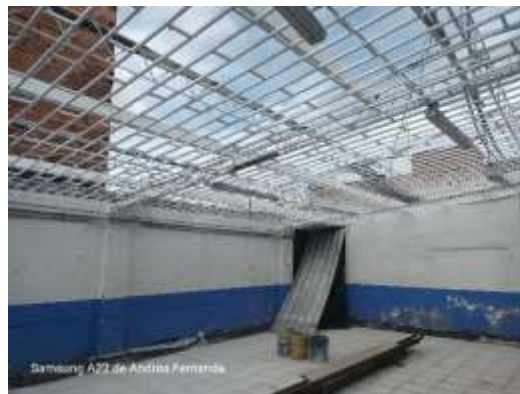
DESMONTE DE CUBIERTA
