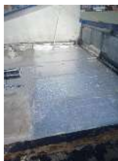
Aplicación de emulsion y manto asfaltico
