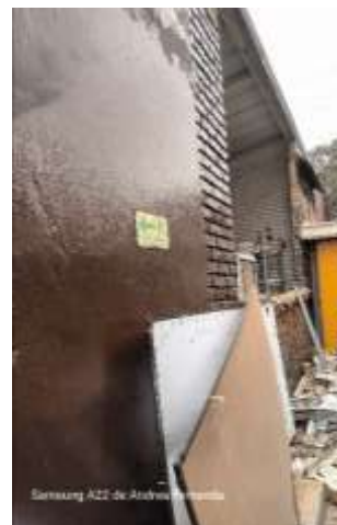
DESMONTE DE VENTANAS
