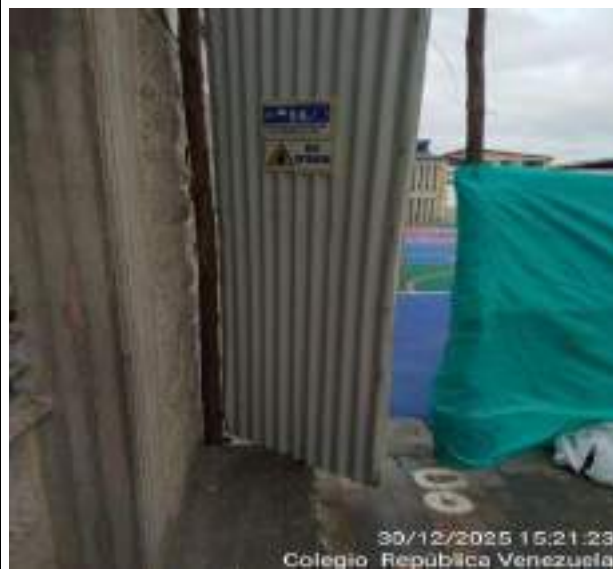
Fotografía 11. Señalización Prohibido el ingreso
