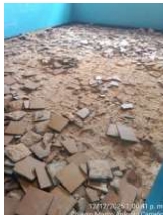
Demolición de cerámica y alistado
