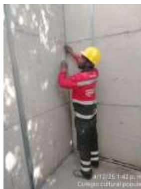
Instalación de malla de gallinero
