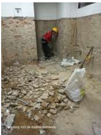
DEMOLICION DE LOSA
