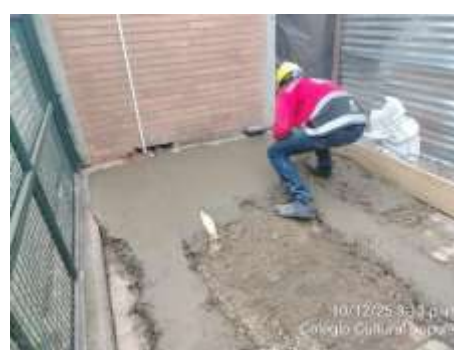
fundida de placa de contrapiso
