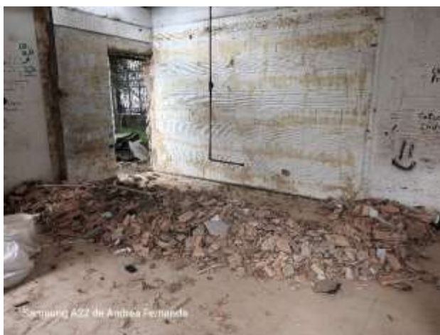
DEMOLICION DE MAMPOSTERIA
