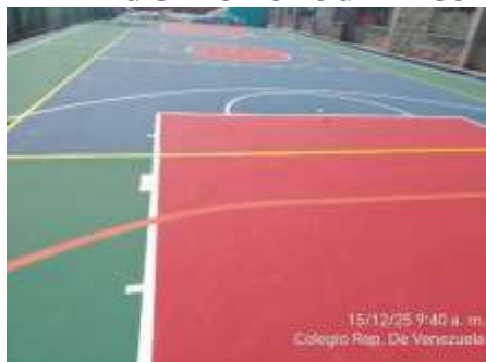
Pintura y demarcacion de cancha
