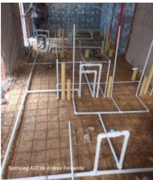
TUBERIA HIDRAULICA - MALLA
