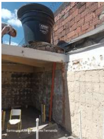
RETIRO DE CUBIERTA
