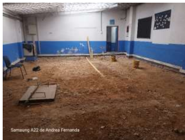
RELLENO -NIVELACION DE PISO
