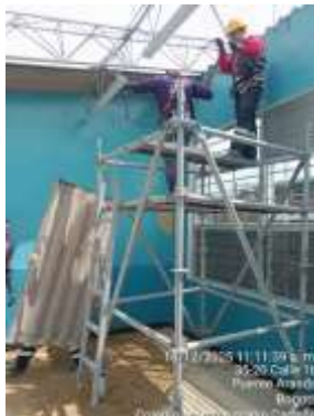
Desmante de cubierta - tramo 1
