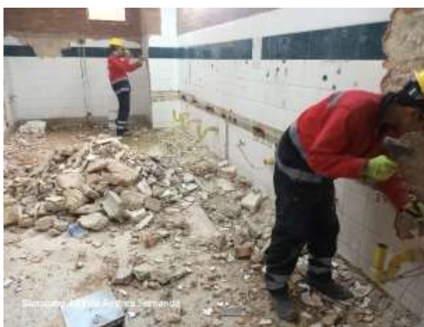
DEMOLICION DE ENCHAPE
