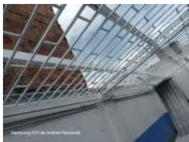
ESTRUCTURA DE CUBIERTA
