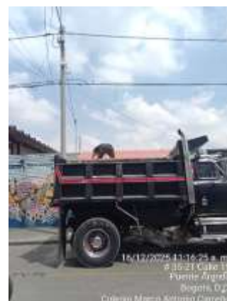
Retiro de material (RCD)
