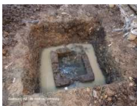
DEMOLICION DE CAJAS DE INSPECCION
