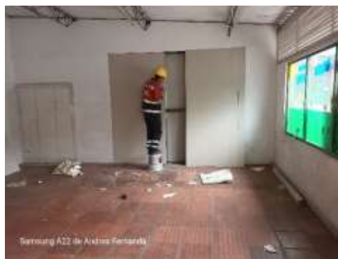
DESMONTE E INTALACIONDE LAMINAS DE SUPERBOARD
