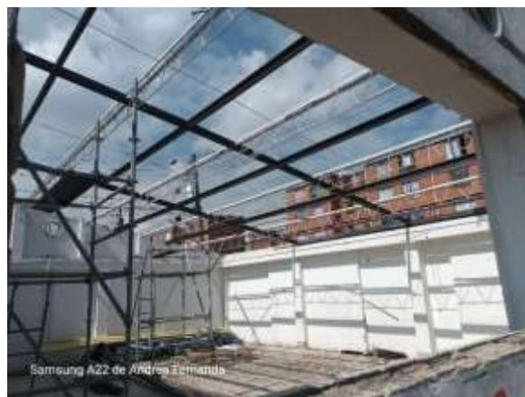
ESTRUCTURA DE CUBIERTA
