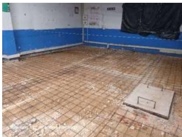
INSTALACION DE MALLA
