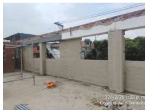
Desmonte de ventanas de fachada
