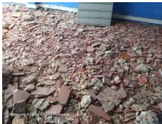
DEMOLICION DE BALDOSA
