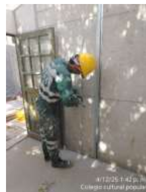
Instalación de malla de gallinero
