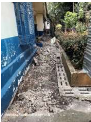
DEMOLICION DE LOSA
