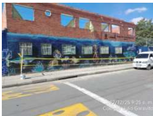
Desmonte de ventanas de fachada
