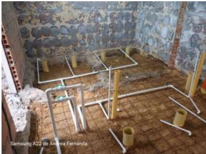
TUBERIA HIDRAULICA
