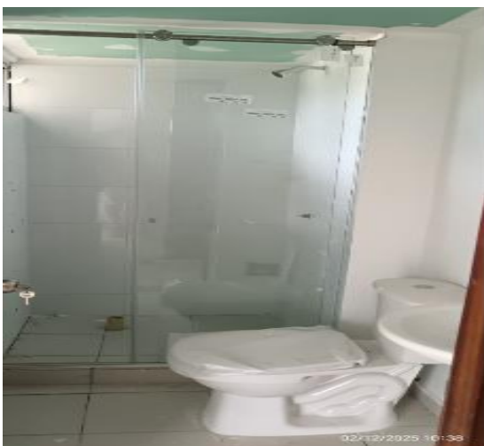
COLOCACION DE LAS DIVISIONES DE VIDRIOS
