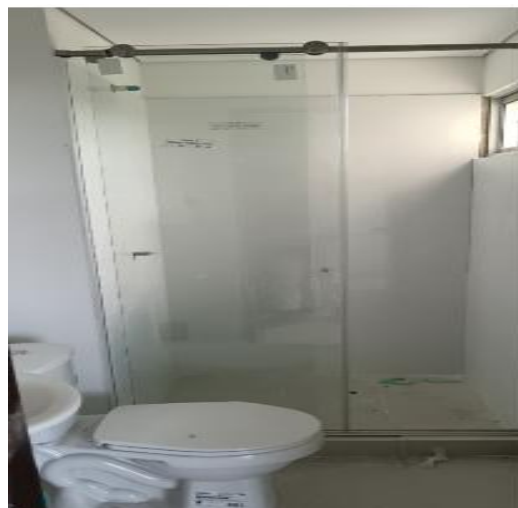
COLOCACION DE LAS DIVISIONES DE VIDRIOS
