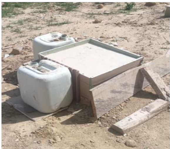
CONSTRUCCION DE PEDESTALES EN CONCRETO PARA POSTES DE LUCES
