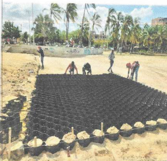
Fotografía 8. Relleno de geocelda 150 mm.
