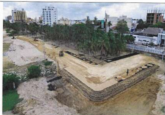
Fotografía 12. Relleno en zona 1
