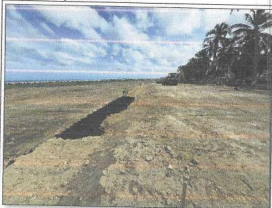
Fotografía 3. Relleno de geocelda 200 mm.
