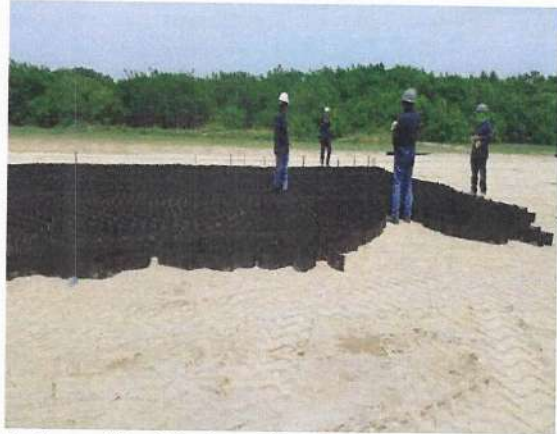
Fotografía 20. Instalación de geocelda de 150 mm.
