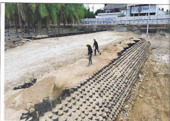
Fotografía 11. Instalación de geocelda de 200 mm para muro.
