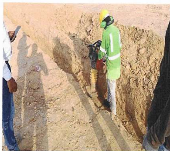
Fotografía 24. Copactación de zanja.
