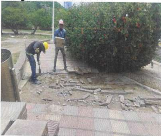
Fotografía 17. Retiro de losetas.
