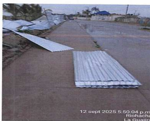
Fotografia 6. Cerramiento provisional de obra.
