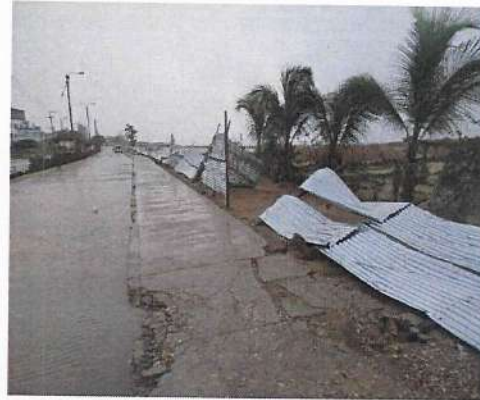
Fotografía 8. Cerramiento provisional de obra.
