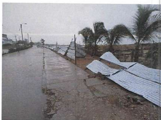
Fotografia 5. Cerramiento provisional de obra.
