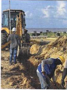
Relleno de geocelda 150 mm.
