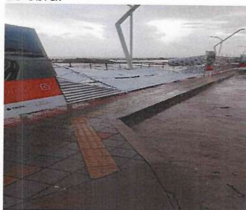
Fotografia 4. Cerramiento provisional de obra.
