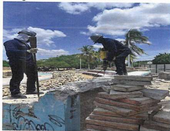
Fotografía 18. Demolición de muros.
