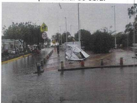
Fotografia 3. Cerramiento provisional de obra.
