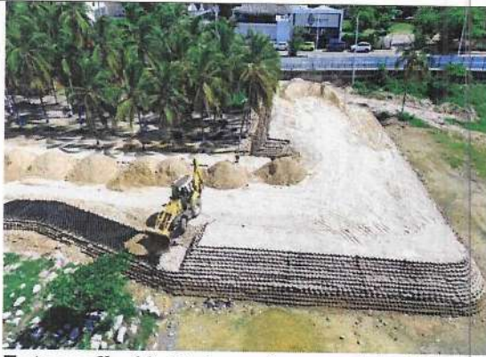
Fotografía 13. Relleno de geocelda 200 mm.
