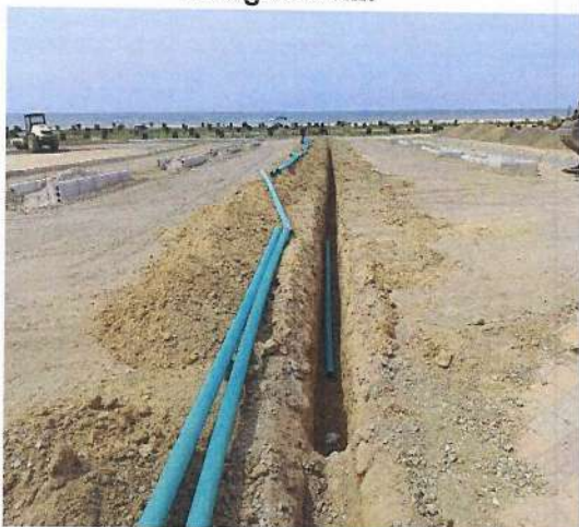
Fotografía 23. Instalación de tubería eléctrica.
