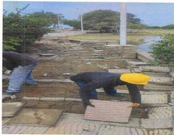
Fotografía 16. Retiro de losetas.
