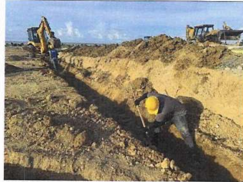
Relleno de geocelda 150 mm.
