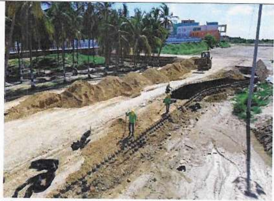
Fotografía 14. Relleno de geocelda 200 mm.
