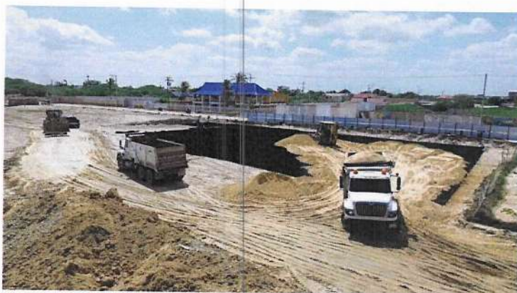
Fotografía 26. Relleno en Recebo e instalación de geocelda de 150.
