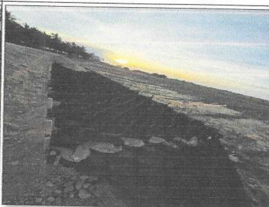
Fotografía 4. Relleno de geocelda 200 mm.
