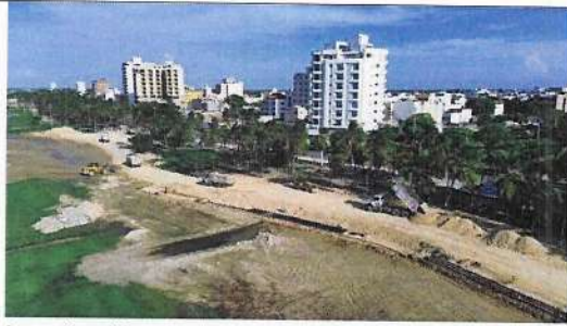
Instalación de geocelda de 200 mm para muro.
