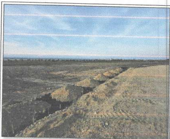
Fotografía 1. Instalación de geocelda de 200 mm para muro.
