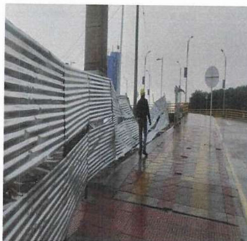
Fotografia 2. Cerramiento provisional de obra.
