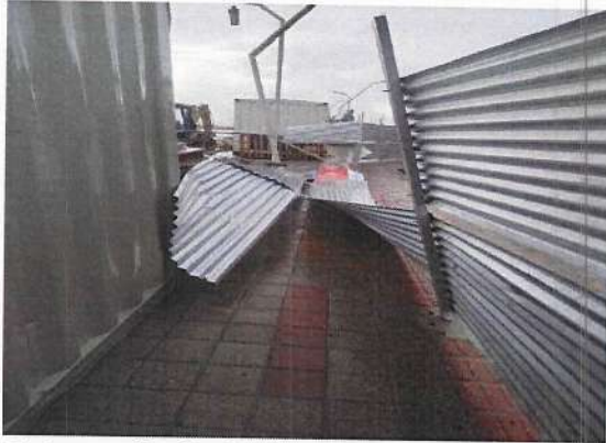
Fotografía 7. Cerramiento provisional de obra.
