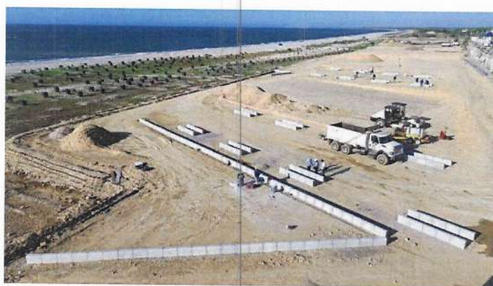
Fotografía 25. Instalación de bordillos.
