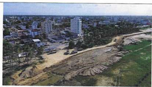
Relleno en zona 1
